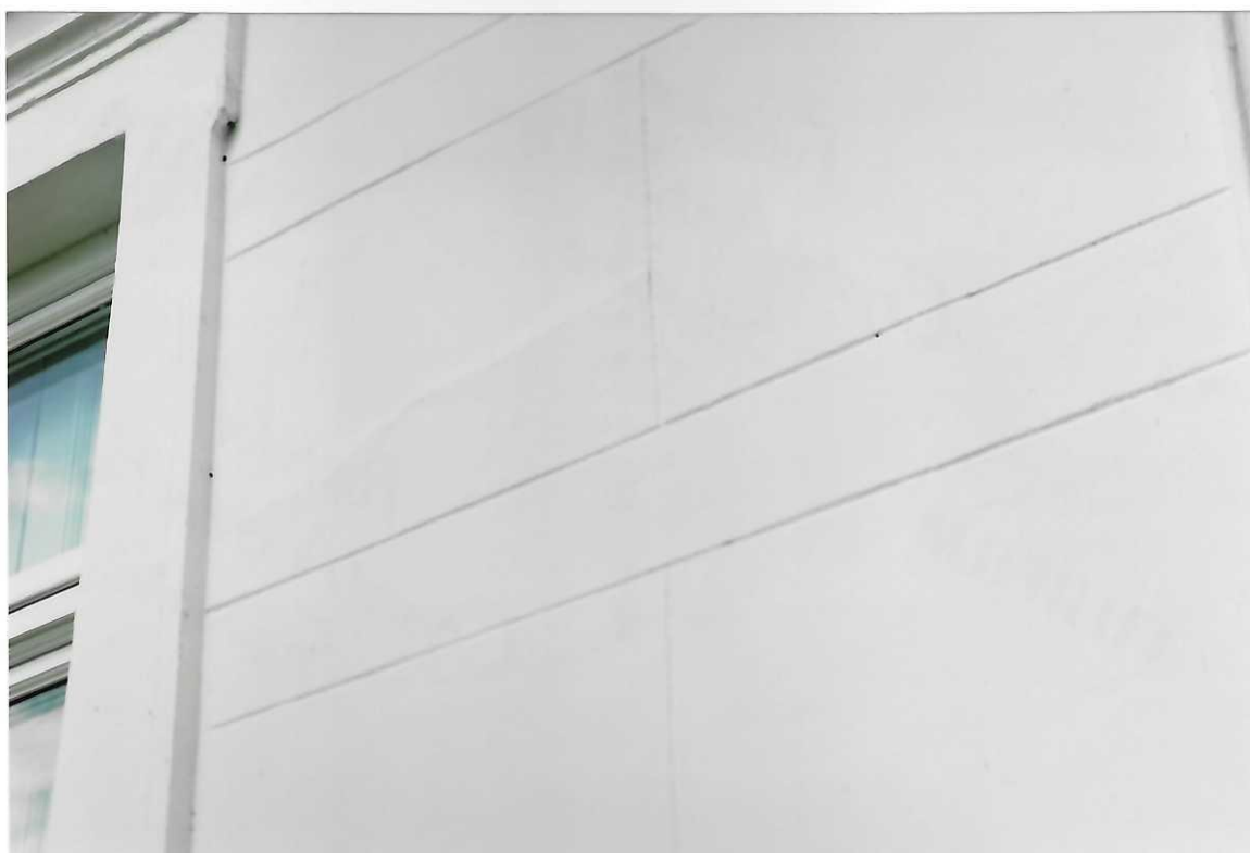
Fot. nr. 5 Kock, ul. Tadeusza Kościuszki 1, Pałac Jabłonowski. Elewacja Południowa. Widoczne spęcherzenia tynku. Wyk. M. Podgórska-Makal, 2012
