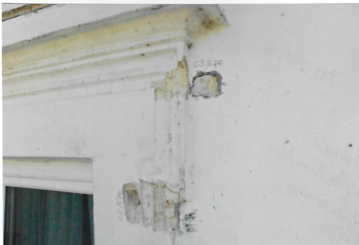
Fot. nr. 26 Kock, ul. Tadeusza Kościuszki 1, Pałac Jabłonowskich. Elewacja Północna – fragment. Widoczne miejsca wykonania sond badawczych. Wyk. M. Podgórska-Makał. 2012.
