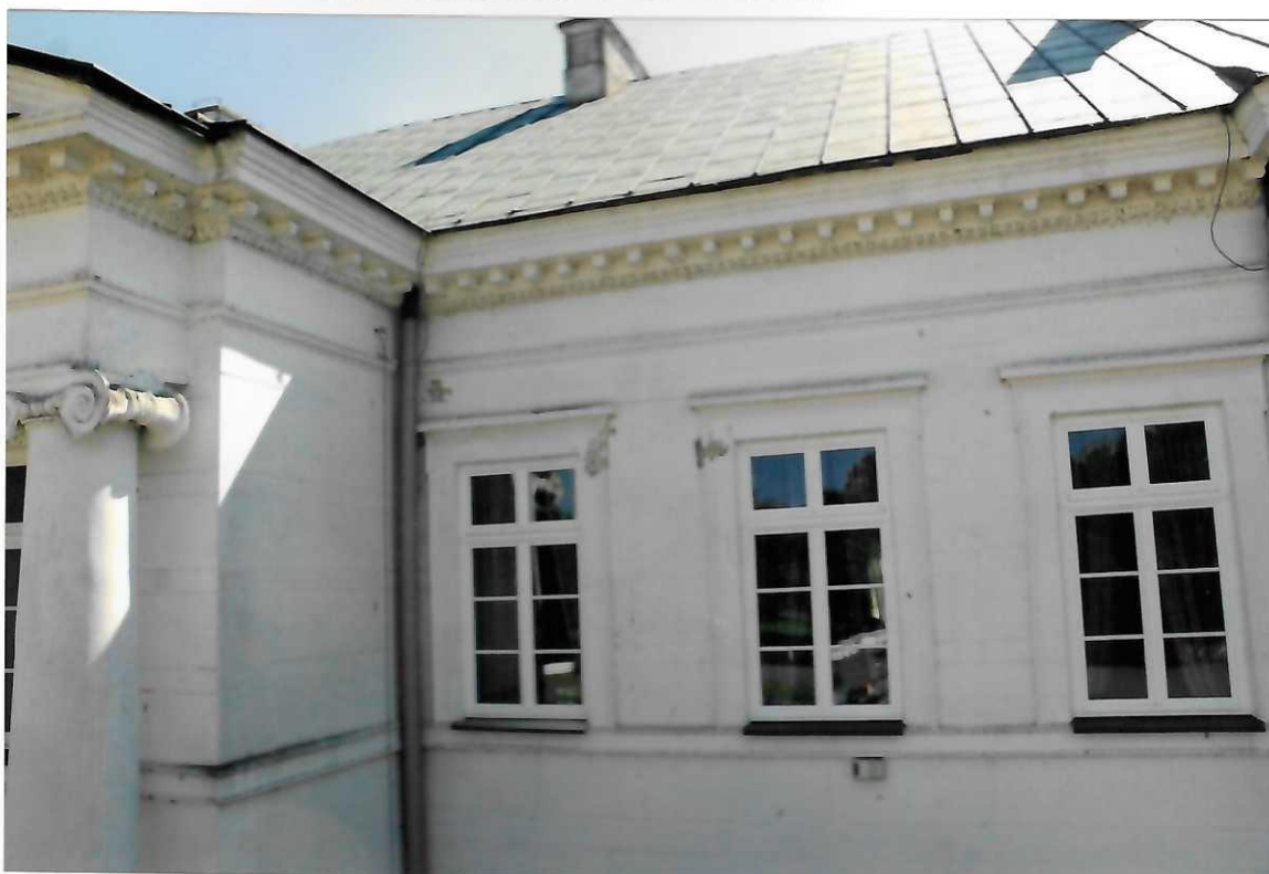
Fot. nr. 23 Kock, ul. Tadeusza Kościuszki 1, Pałac Jabłonowski. Elewacja Północna – fragment. Widoczne miejsca wykonania sond badawczych. Wyk. M. Podgórska-Makal. 2012.
