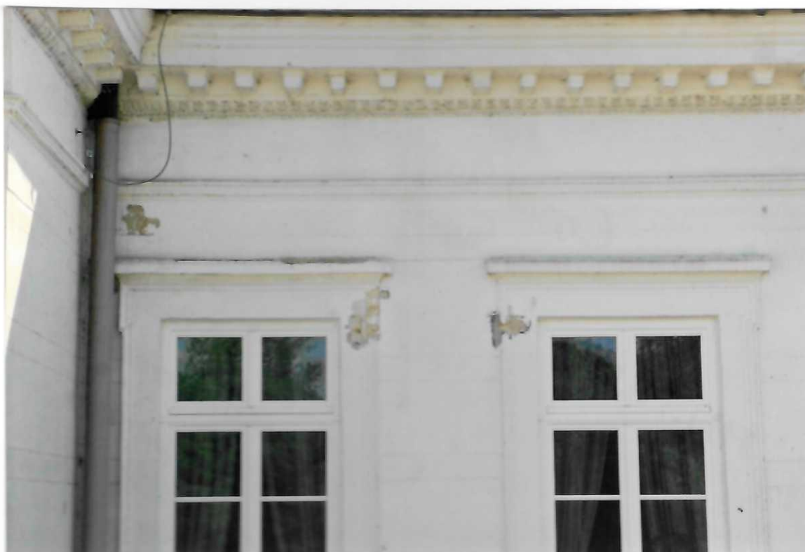
Fot. nr. 24 Kock, ul. Tadeusza Kościuszki 1, Pałac Jabłonowski. Elewacja Północna – fragment. Widoczne miejsca wykonania sond badawczych. Wyk. M. Podgórska-Makal. 2012.
