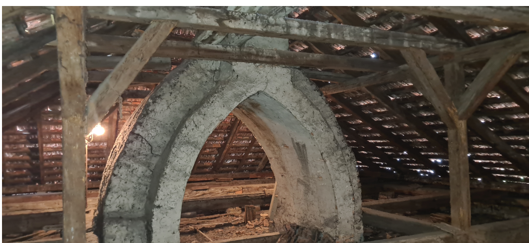
Fot.16 - Więźba dachowa – ostrołukowe połączenie kominów. Widoczne nieszczelności pokrycia dachowego.
