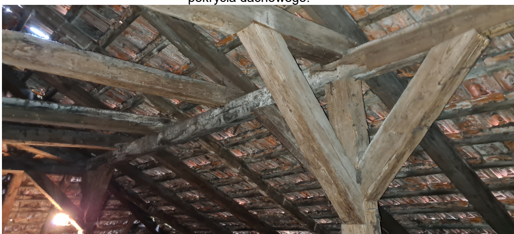
Fot.17 - Więźba dachowa – widoczne różne elementy konstrukcyjne więźby. Widoczne nieszczelności pokrycia dachowego.
