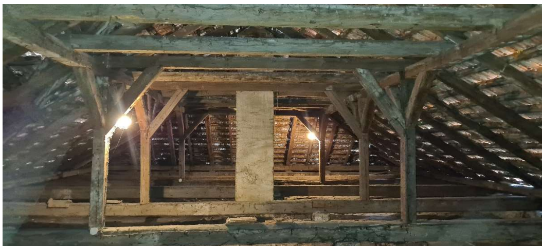
Fot.15 - Więźba dachowa – widok na główne wiązary. Widoczne nieszczelności pokrycia dachowego.
