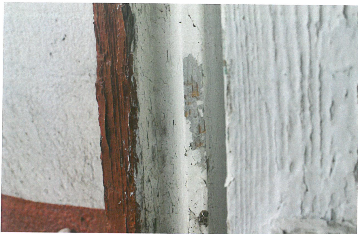
ZDJ. 17 ELK. BUDYNEK D. MAGAZYNU KOLEJOWEGO. OKNO CZĘŚCI MIESZKALNEJ MAGAZYNU – WIDOCZNA PIERWOTNA WARSTWA SZARO NIEBIESKIEJ FARBY
