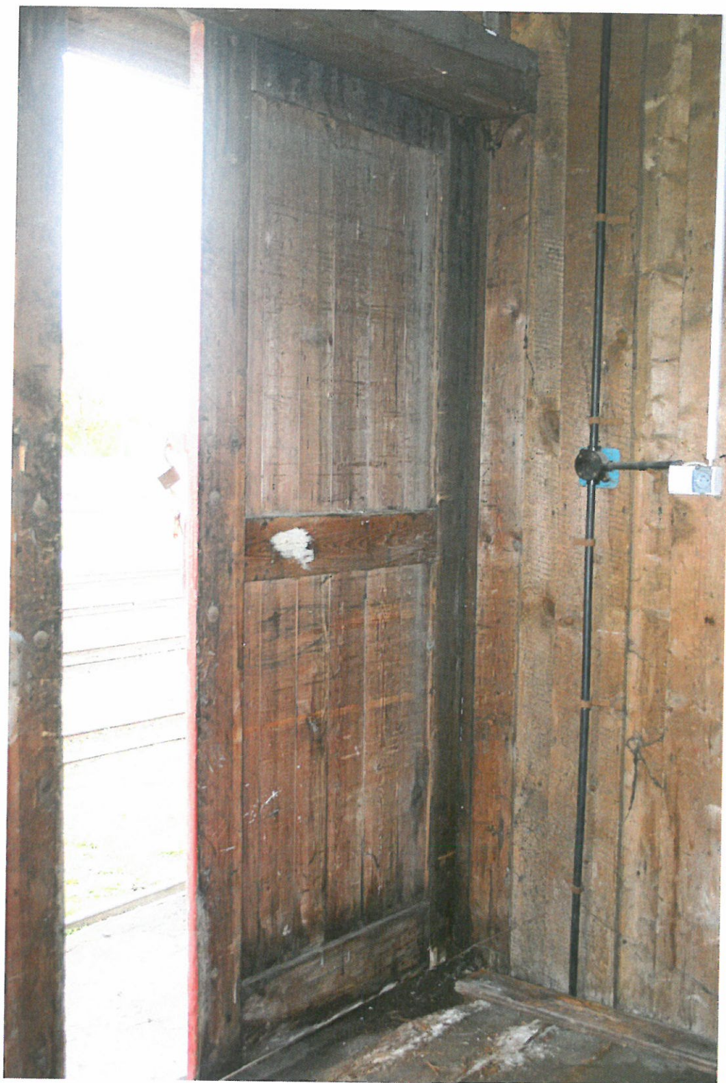
ZDJ. 19 ELK. BUDYNEK D. MAGAZYNU KOLEJOWEGO. DRZWI CZĘŚCI DREWNIANEJ MAGAZYNU. WIDOCZNE SKUTKI ZAMAKANIA
