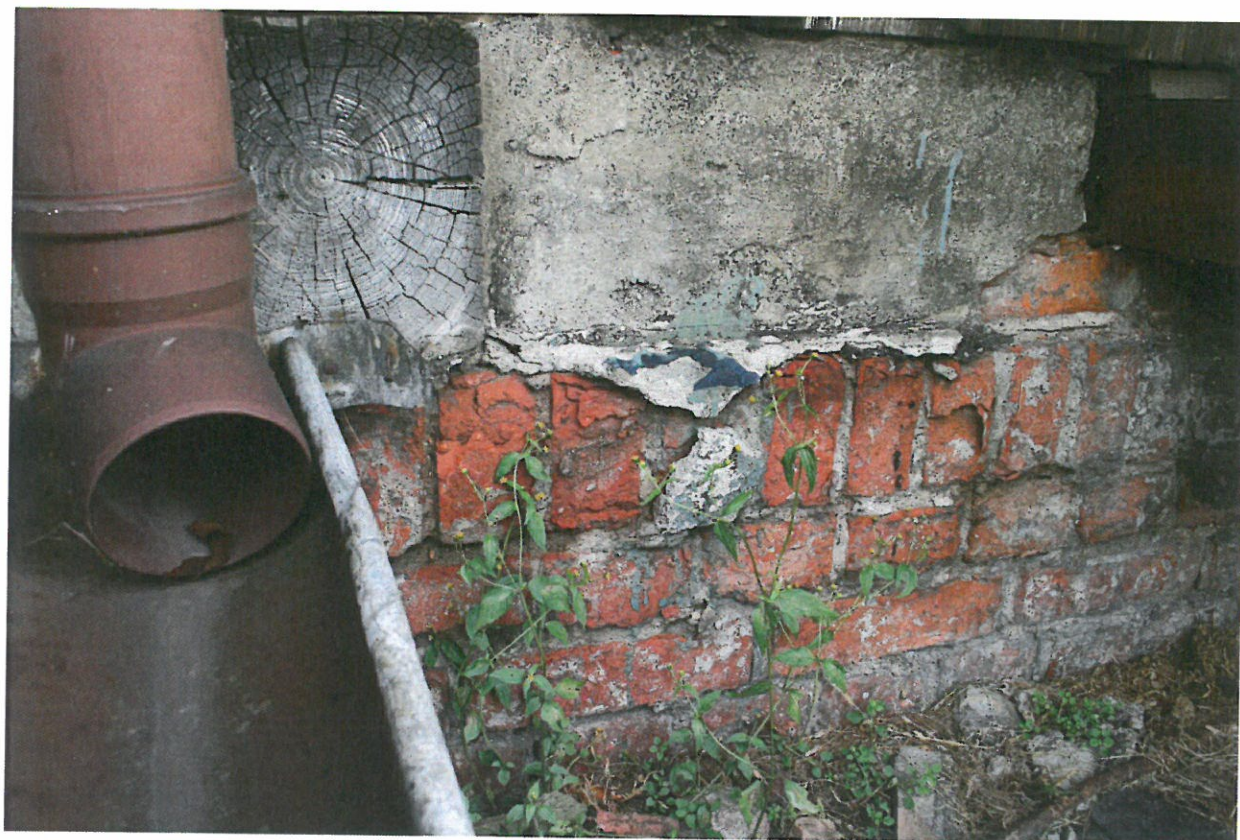
ZDJ. 8 ELK. BUDYNEK D. MAGAZYNU KOLEJOWEGO. ZALEWANIE FUNDAMENTÓW PROWADZI DO DESTRUKCJI CEGIEŁ PODMURÓWKI I TYNKÓW
