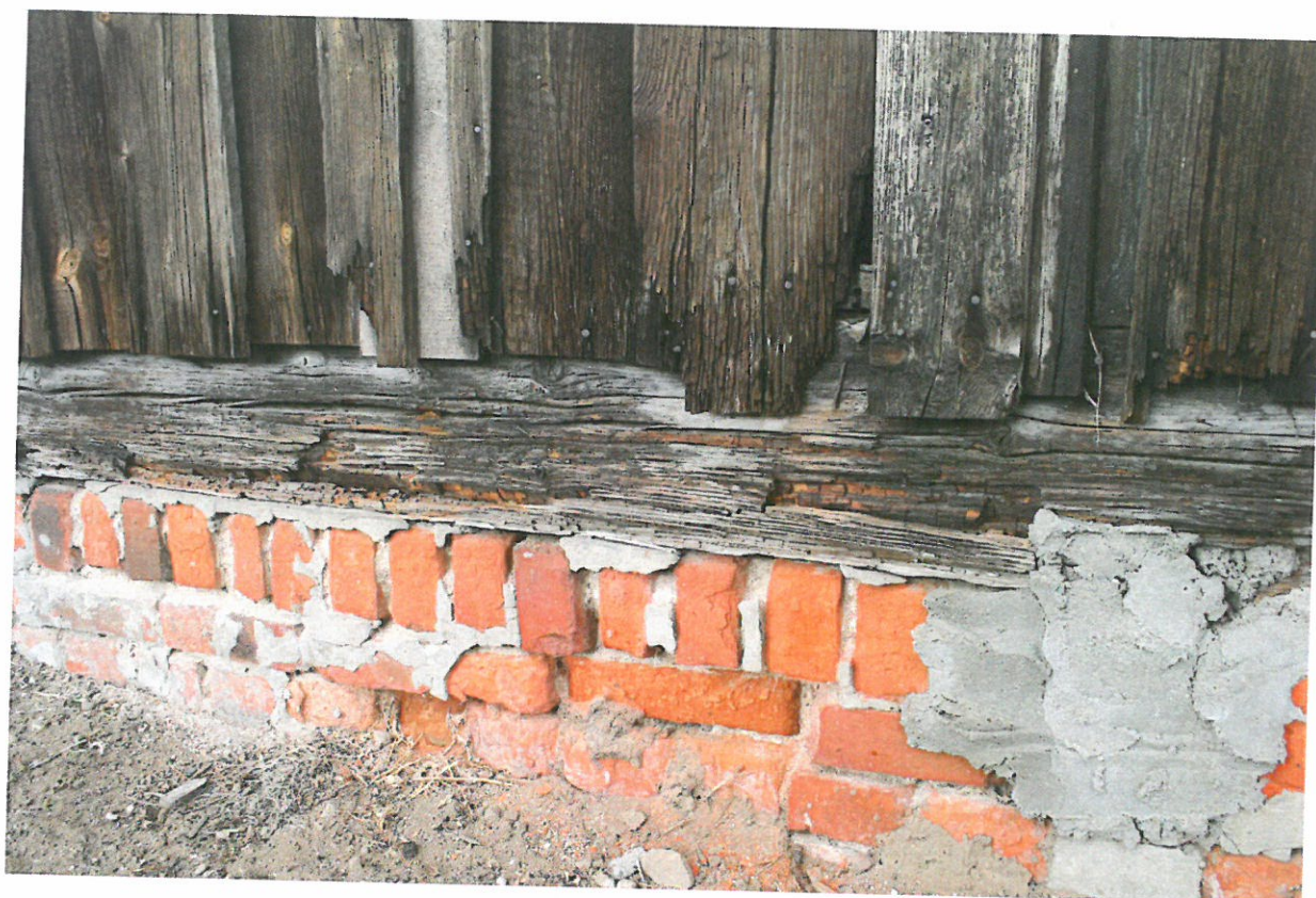
ZDJ. 9 ELK. BUDYNEK D. MAGAZYNU KOLEJOWEGO. DESTRUKCJA BELKI STROPOWEJ (PODWALINY), CEGIEŁ I TYNKÓW
