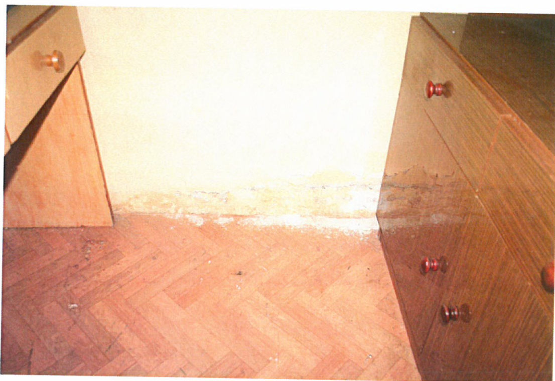
ZDJ. 6 ELK. BUDYNEK D. MAGAZYNU KOLEJOWEGO. NIEPRAWIDŁOWO ODPROWADZANA Z DACHU WODA OPADOWA POWODUJE ZAMAKANIE FUNDAMENTÓW I ZAWILGOCENIE ŚCIAN WE WNĘTRZU BUDYNKU
