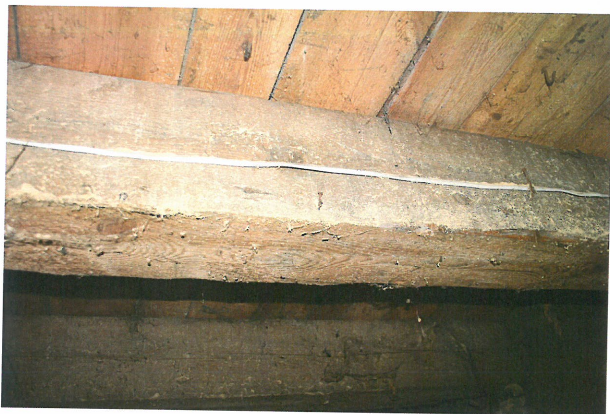
ZDJ. 13; 14 ELK. BUDYNEK D. MAGAZYNU KOLEJOWEGO. MĄCZKA DRZEWNA WYSYPUJĄCA SIĘ Z OTWORÓW WYLOTOWYCH WSKAZUJE NA AKTYWNE ŻEROWANIE KOŁATKA DOMOWEGO (PIWNICA I PODŁOGA W CZĘŚCI DREWNIANEJ MAGAZYNU
