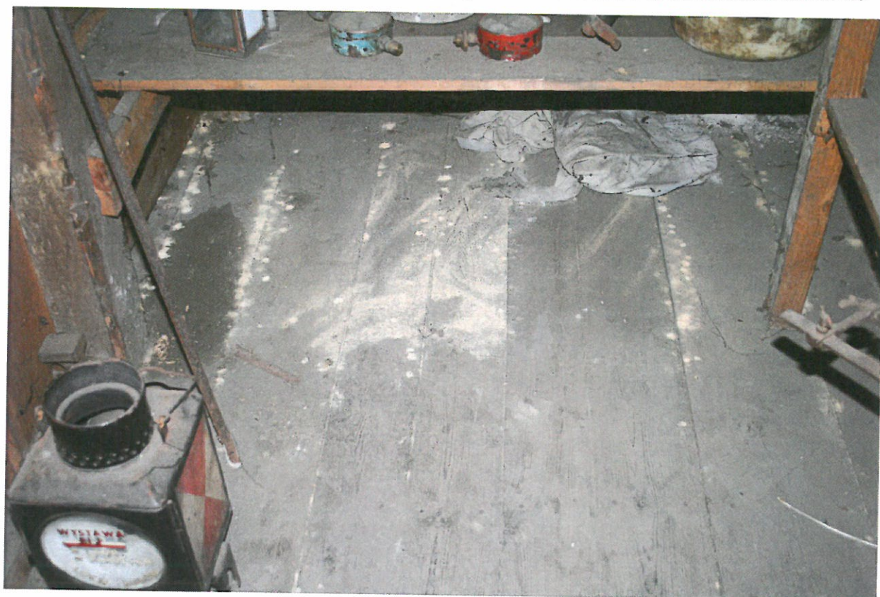
ZDJ. 13; 14 ELK. BUDYNEK D. MAGAZYNU KOLEJOWEGO. MĄCZKA DRZEWNA WYSYPUJĄCA SIĘ Z OTWORÓW WYLOTOWYCH WSKAZUJE NA AKTYWNE ŻEROWANIE KOŁATKA DOMOWEGO (PIWNICA I PODŁOGA W CZĘŚCI DREWNIANEJ MAGAZYNU
