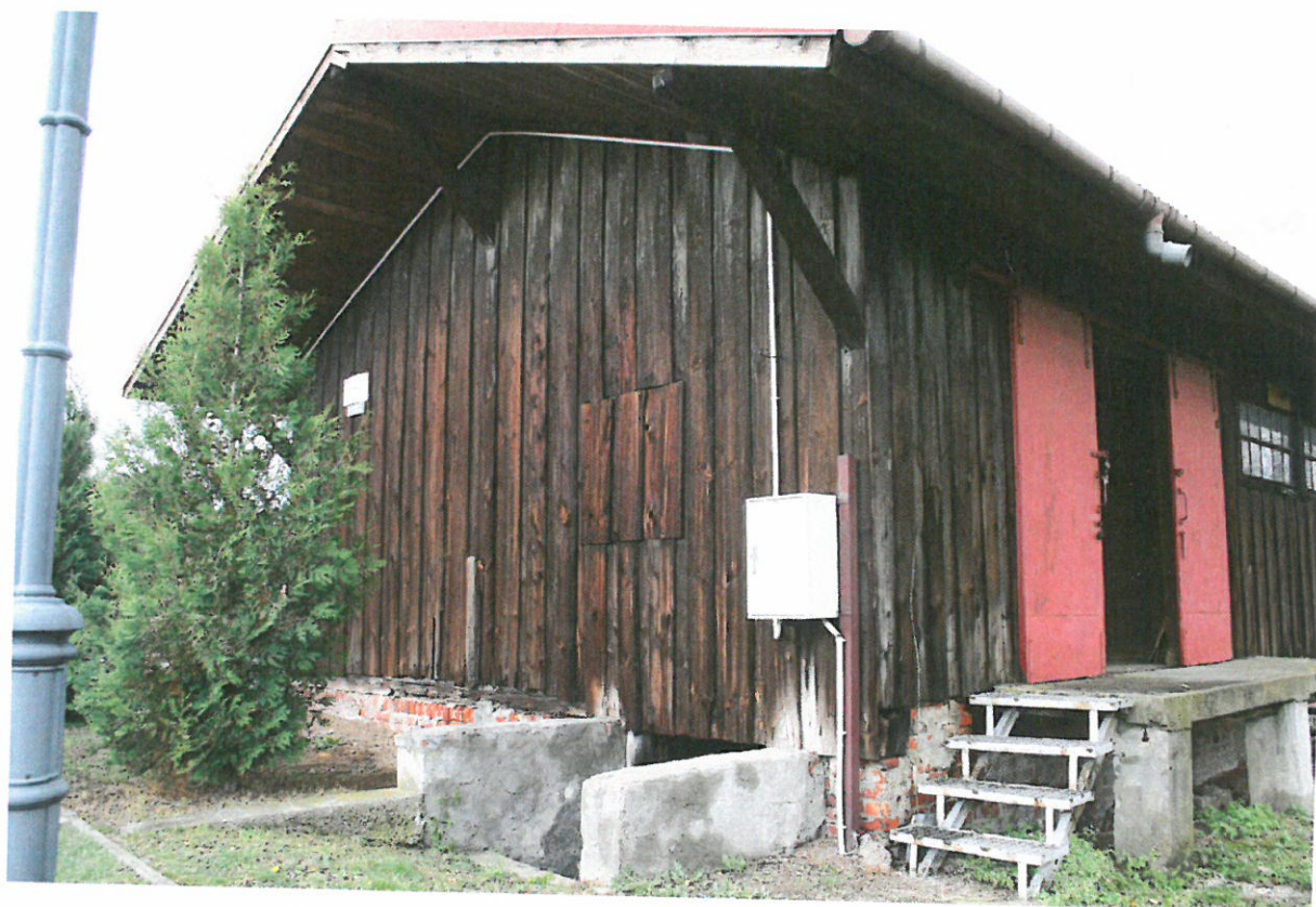
ZDJ. 10 ELK. BUDYNEK D. MAGAZYNU KOLEJOWEGO. WODA Z WADLIWIE ZAMONTOWANEJ RURY SPUSTOWEJ SPADA NA RAMPĘ I ZALEWA ELEWACJĘ
