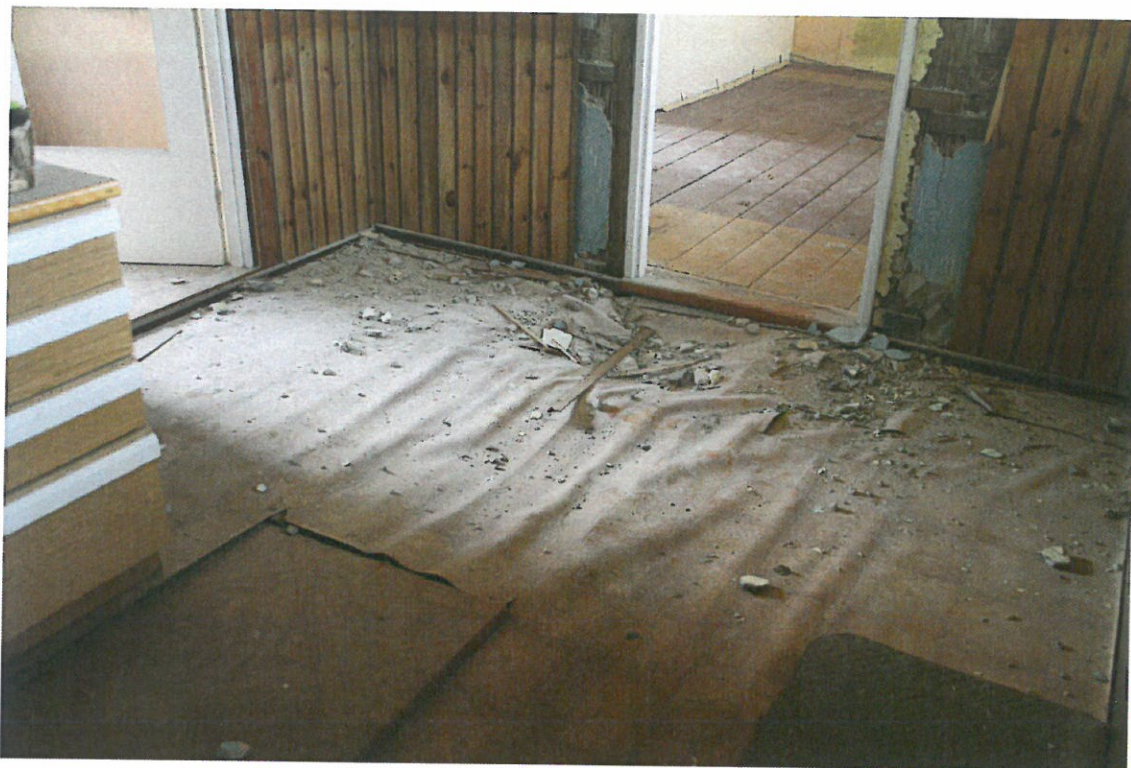
ZDJ. 7 ELK. BUDYNEK D. MAGAZYNU KOLEJOWEGO. ZAŁAMANIE SIĘ ZBUTWIAŁEJ PODŁOGI WE WNĘTRZU BUDYNKU
