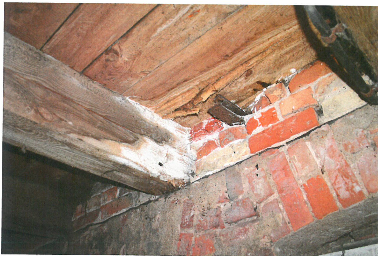
ZDJ. 12 ELK. BUDYNEK D. MAGAZYN KOLEJOWEGO. ZNISZCZENIA KOŃCÓWEK BELEK STROPOWYCH PIWNICY
