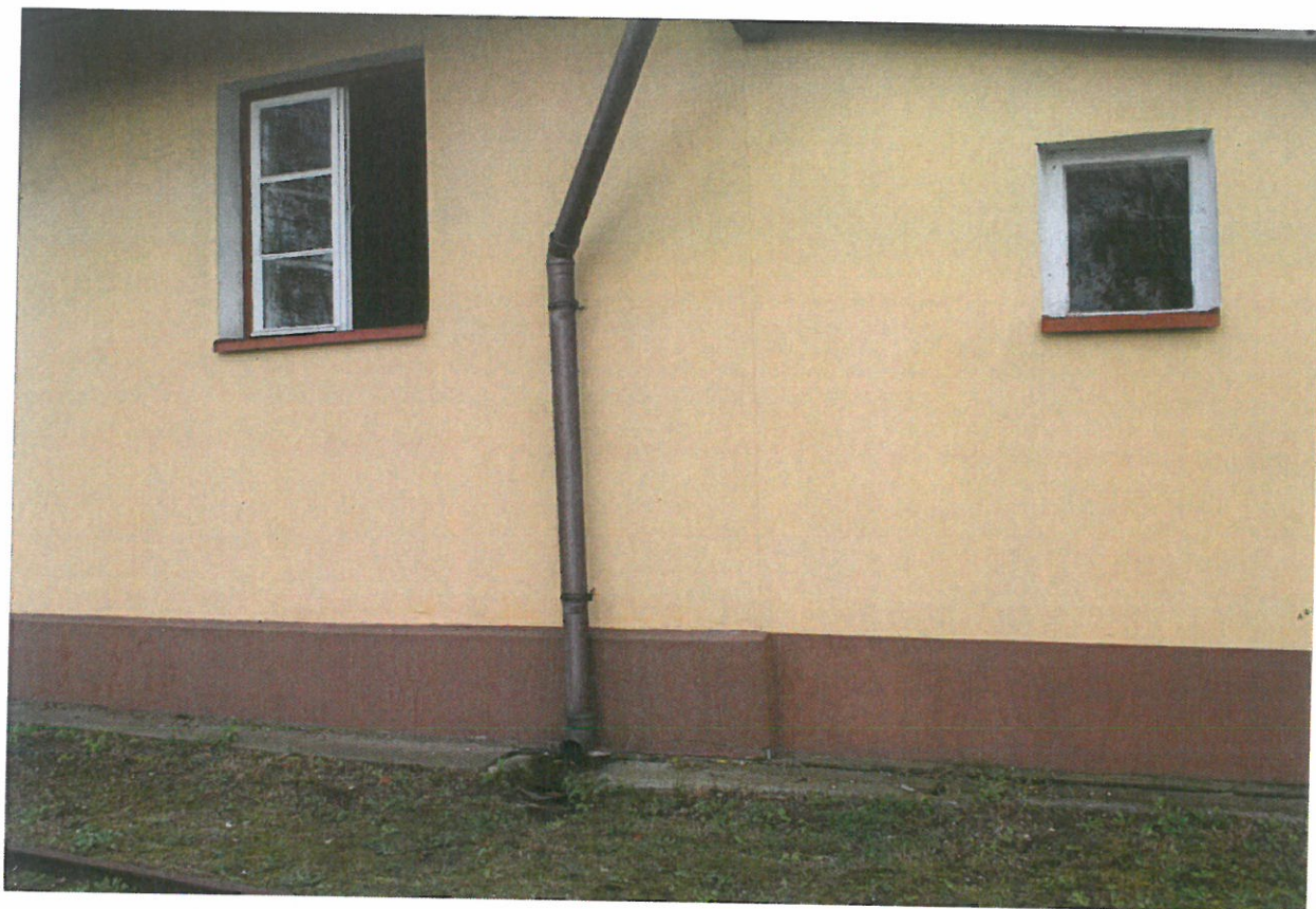
ZDJ. 5 ELK. BUDYNEK D. MAGAZYNU KOLEJOWEGO. NIEPRAWIDŁOWO ODPROWADZANA Z DACHU WODA OPADOWA POWODUJE ZAMAKANIE FUNDAMENTÓW
