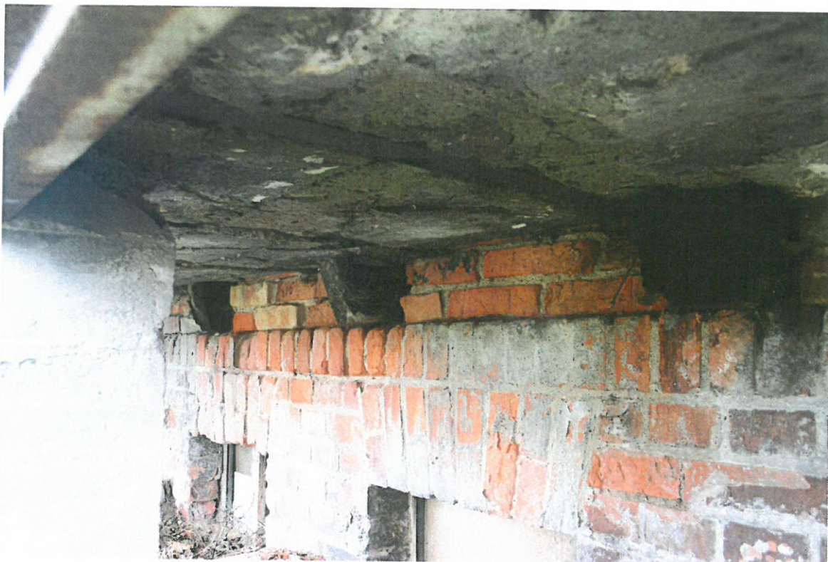
ZDJ. 11 ELK. BUDYNEK D. MAGAZYN KOLEJOWEGO. ZNISZCZENIA KOŃCÓWEK BELEK STROPOWYCH PIWNICY, CEGIEŁ I BETONOWEJ RAMPY
