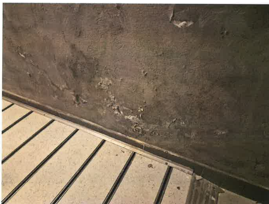
Fot. 6. Korozja chemiczna (zawilgocenie i krystalizacja soli)
