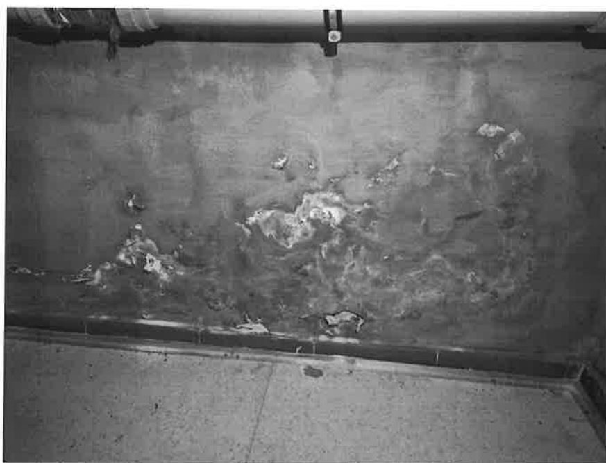
Fot. 4. Korozja chemiczna (zawilgocenie i krystalizacja soli)
