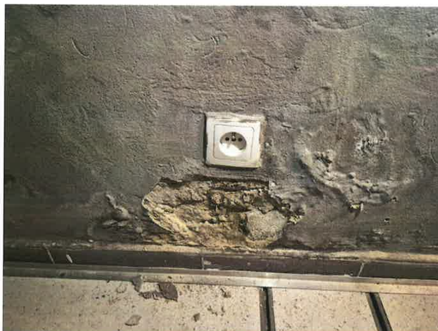
Fot. 2. Korozja chemiczna (zawilgocenie i krystalizacja soli)
