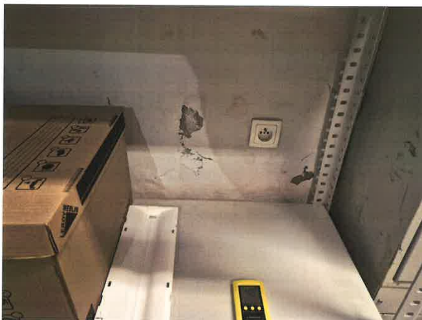
Fot. 9. Korozja chemiczna (zawilgocenie i krystalizacja soli)
