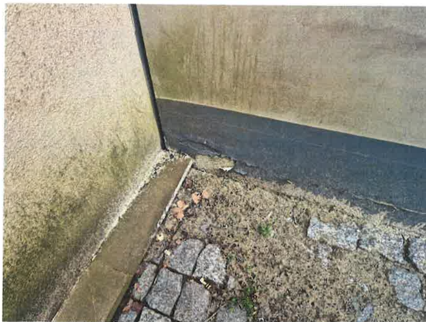
Fot. 7. Korozja chemiczna i biologiczna
