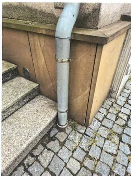
Fot. 8. Rury spustowe wpuszczone w system kanalizacji pod gruntem
