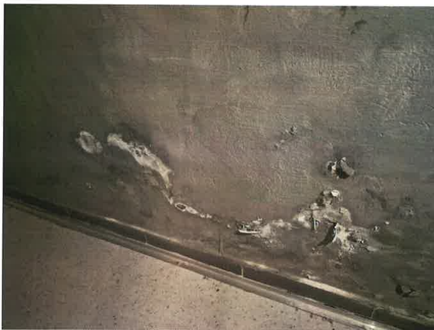
Fot. 5. Korozja chemiczna (zawilgocenie i krystalizacja soli)
