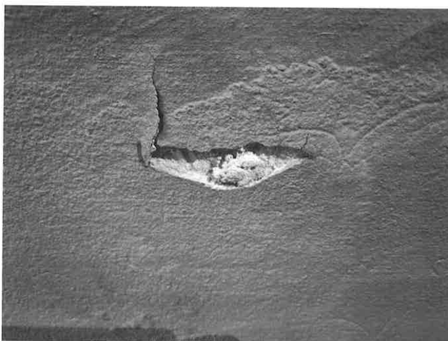
Fot. 3. Korozja chemiczna (zawilgocenie i krystalizacja soli)
