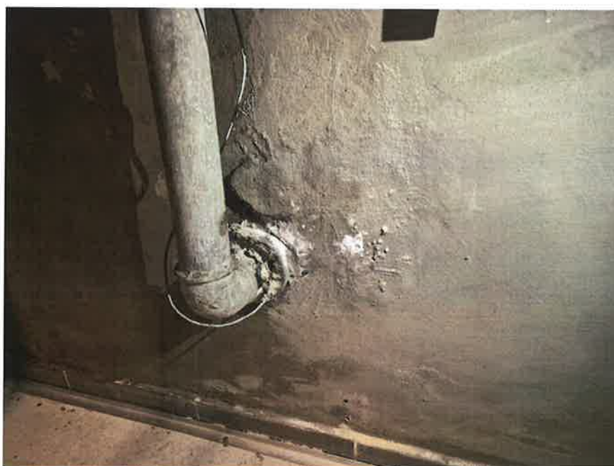
Fot. 10. Korozja chemiczna (zawilgocenie i krystalizacja soli)
