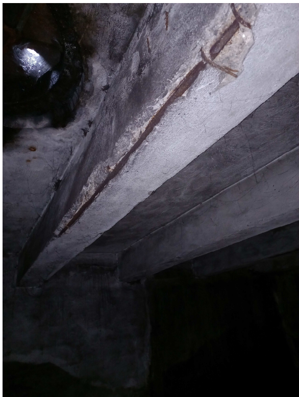
Fot. 3, 4 - Stan belek żelbetowych w magazynie węgla
