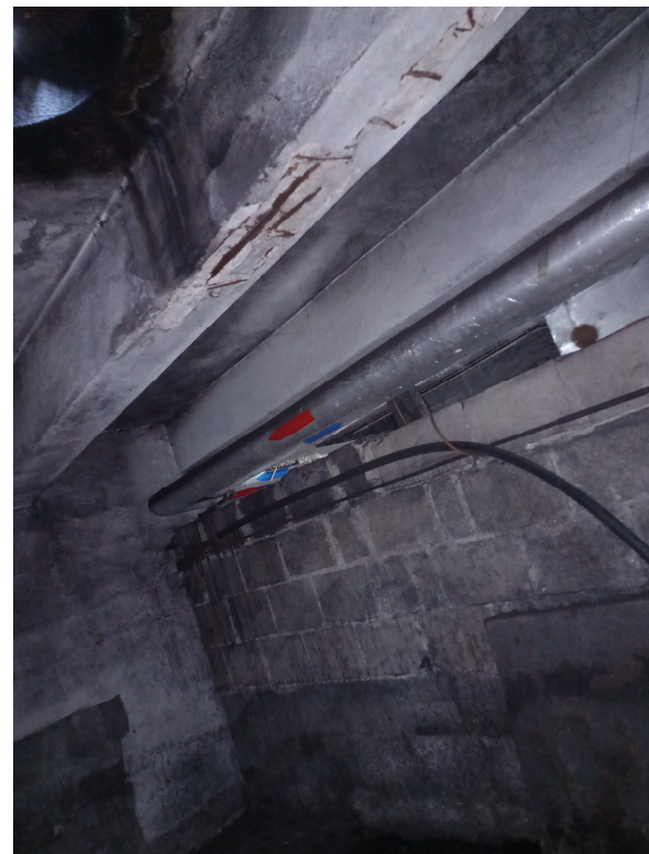
Fot. 3, 4 - Stan belek żelbetowych w magazynie węgla
