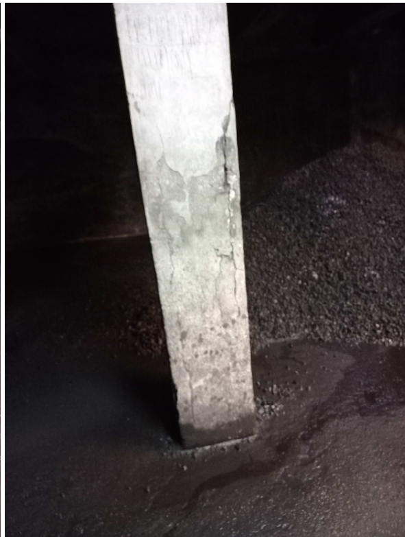
Fot. 1, 2 - Stan słupów żelbetowych w magazynie węgla
