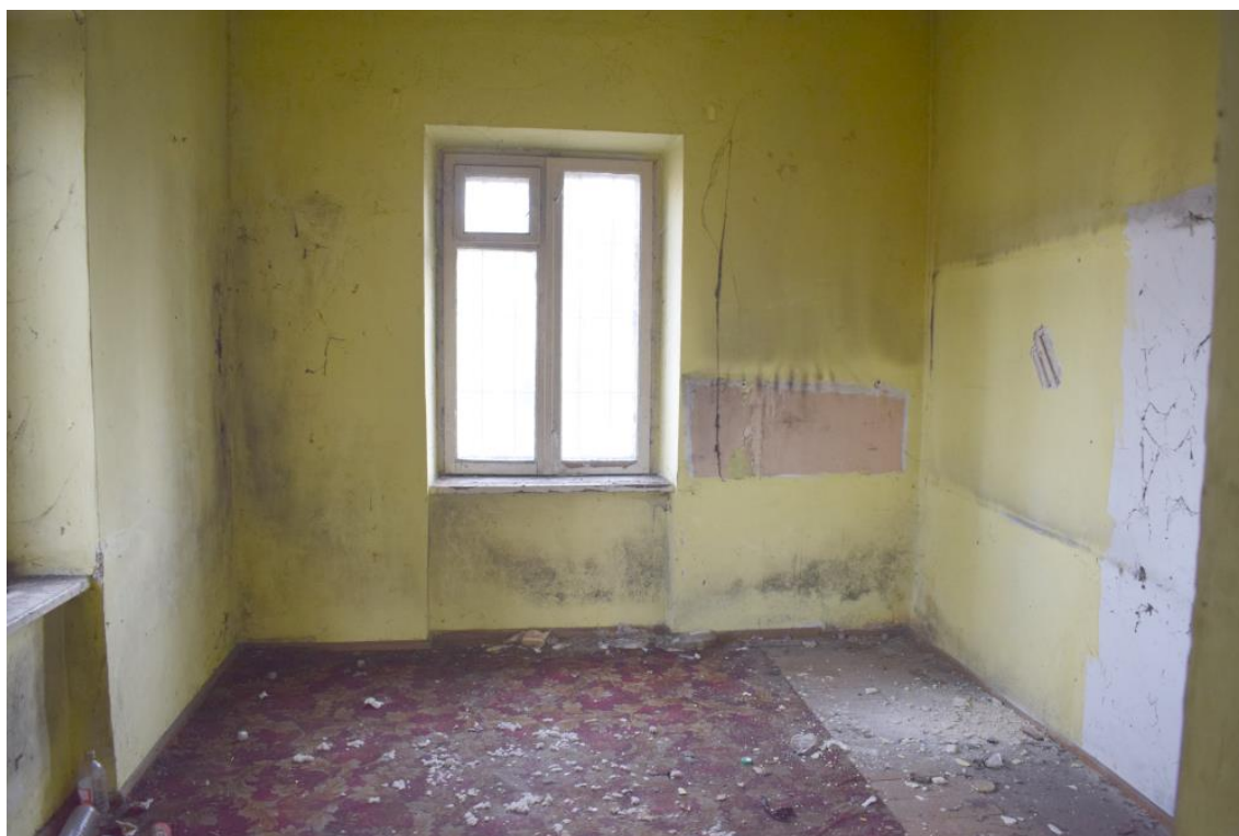
Fot. 35. Podłoga w dawnym pomieszczeniu mieszkalnym (pom. 8.) . Przy ścianie z prawej strony ok. 50-centymetrowy pas posadzki cementowej (fot. A. Wawrzyniak, 2024 r.).
