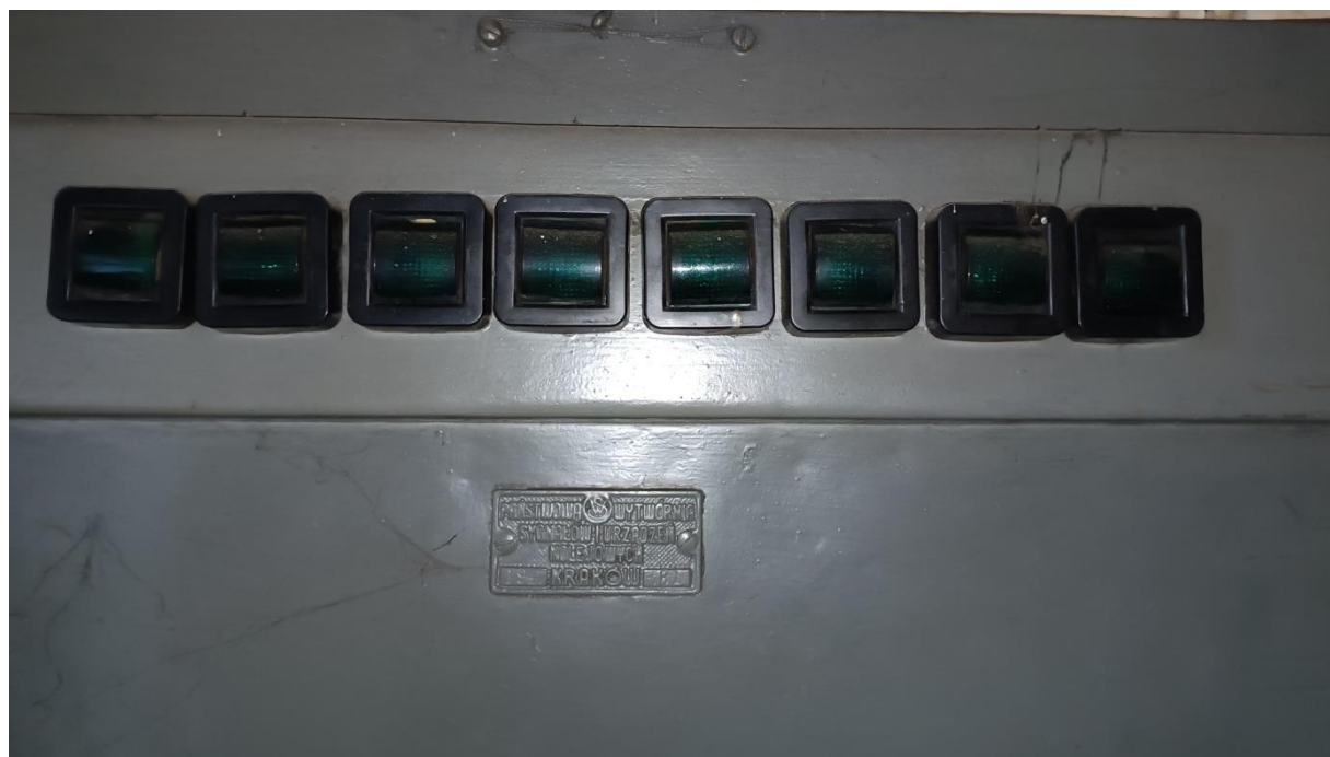
Rys. Lampki sygnałowe w skrzynce sygnałowej sterowania ruchem kolejowym
