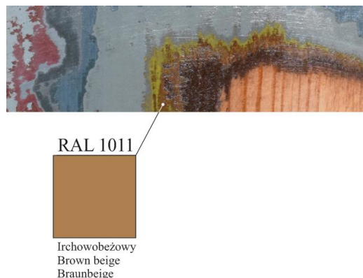
Fot. 75. Odkrywka na zachowanej lamperii w holu dworca (fot. A. Wawrzyniak, 2024 r.)
