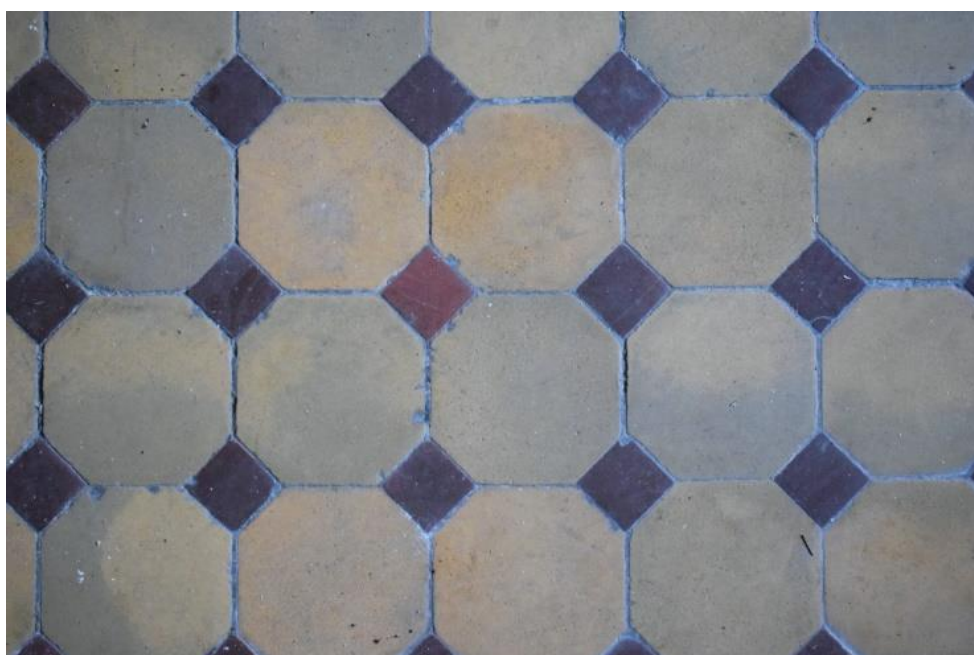
Fot. 73. Zachowany fragment posadzki cementowej w pomieszczeniu poczekalni (fot. A. Wawrzyniak, 2024 r.).
