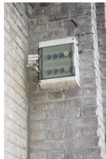
Fot. 27. Rozdzielnica PCV na boku ryzalitu od strony peronów. (fot. A. Wawrzyniak 2024 r.)
