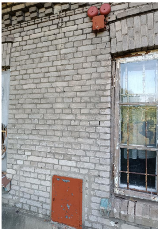
Rys. Dzwonek telefonu kolejowego zainstalowany na elewacji od strony peronów
