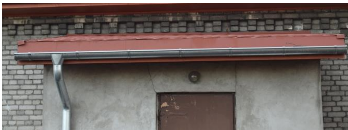
Fot. 38. Przybudówka od strony Białej Rawskiej. Widoczne spękania nadproża. (fot. A. Wawrzyniak, 2024 r.).
