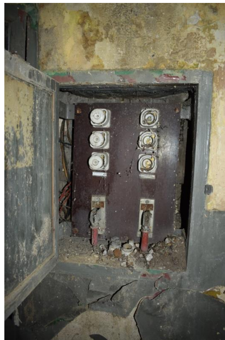
Fot. 82. Mała rozdzielnica elektryczna w pomieszczeniu dyżurnego ruchu (fot. A. Wawrzyniak, 2024 r.)
