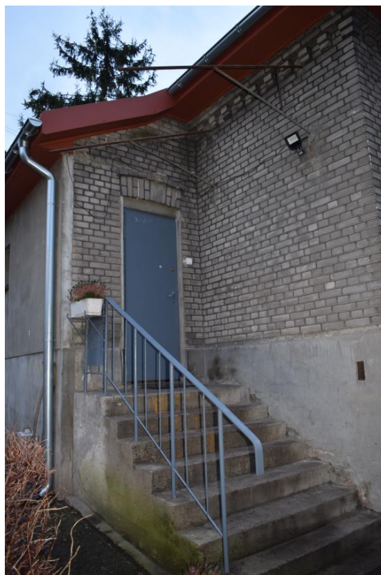
Fot. 48. Schody do przybudówki od strony Rogowa. Widoczna balustrada i szkielet zadaszenia schodów. (fot. A. Wawrzyniak, 2024 r.).
