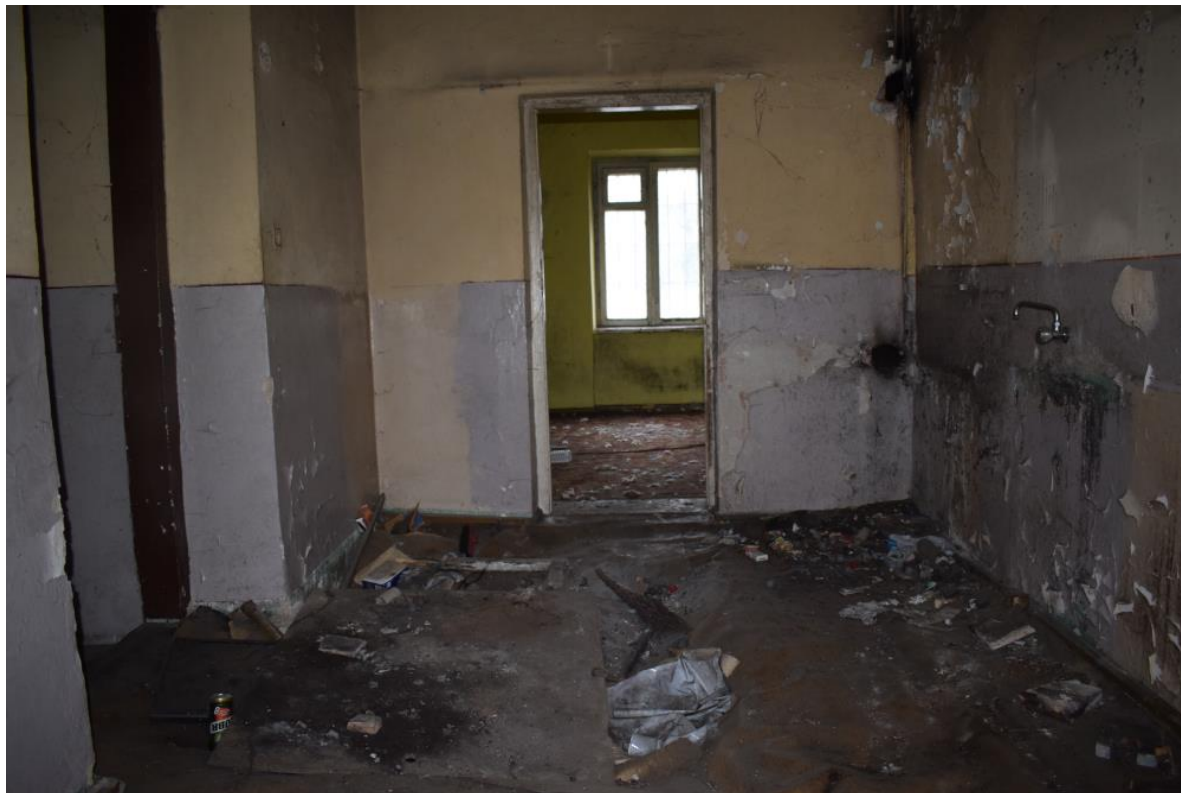
Fot. 36. Podłoga w dawnej kuchni (pom. 7.). Widoczne zarwane deski podłogowe. (fot. A. Wawrzyniak, 2024 r.).
