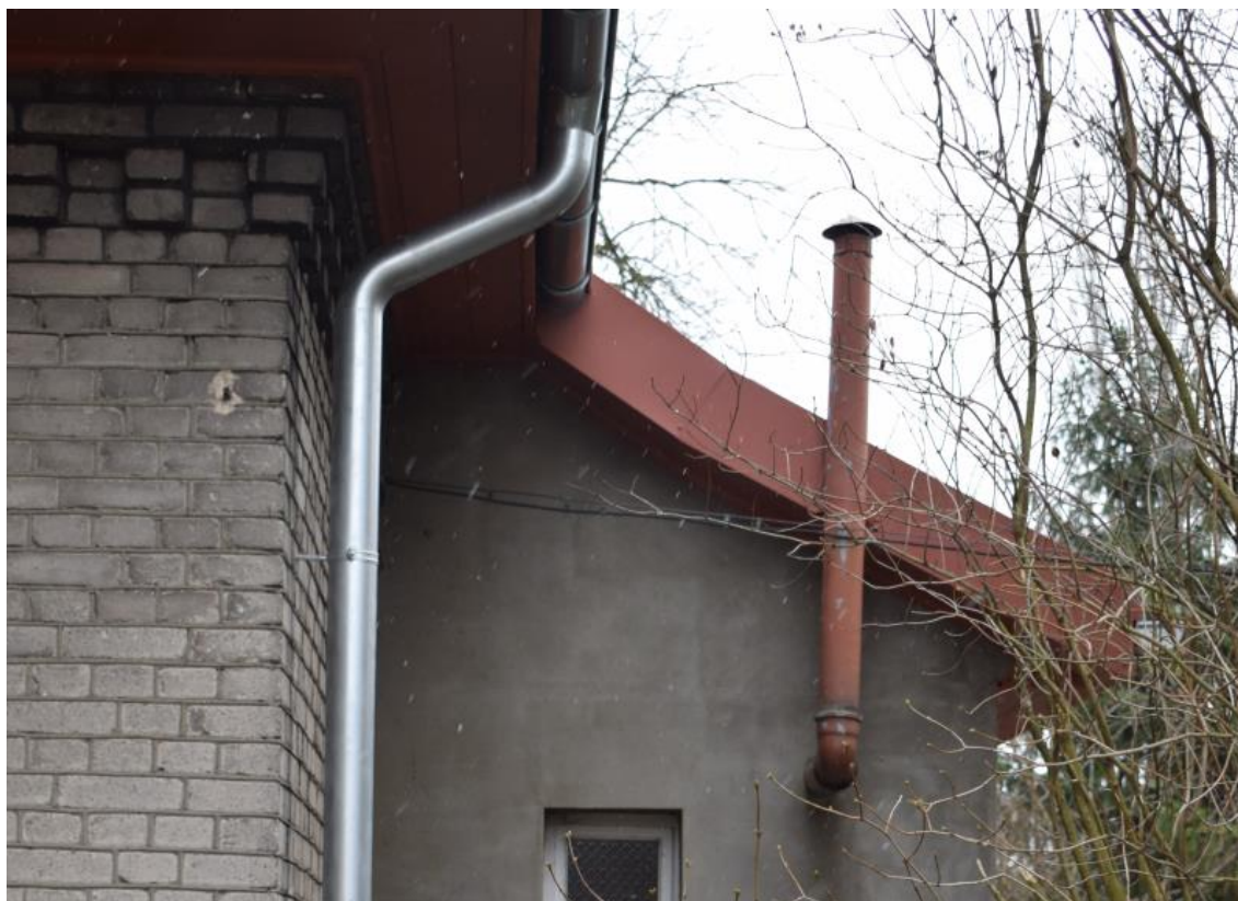
Fot. 26. Przybudówka od strony Rogowa (wtórnie ocieplona styropianem). Widoczny komin wentylacyjny wykonany z rur PCV. (fot. A. Wawrzyniak 2023 r.)
