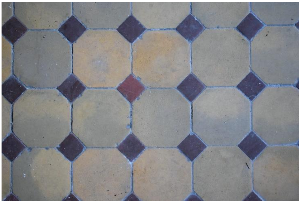
Fot. 73. Zachowany fragment posadzki gresowej w pomieszczeniu poczekalni (fot. A. Wawrzyniak, 2024 r.).
