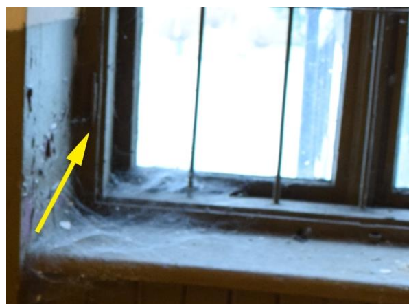
Fot. 3. Okno w poczekalni (Oz1). Widoczna pozostałość zawiasu od wewnętrznej strony (fot. A. Wawrzyniak, 2024 r.)
