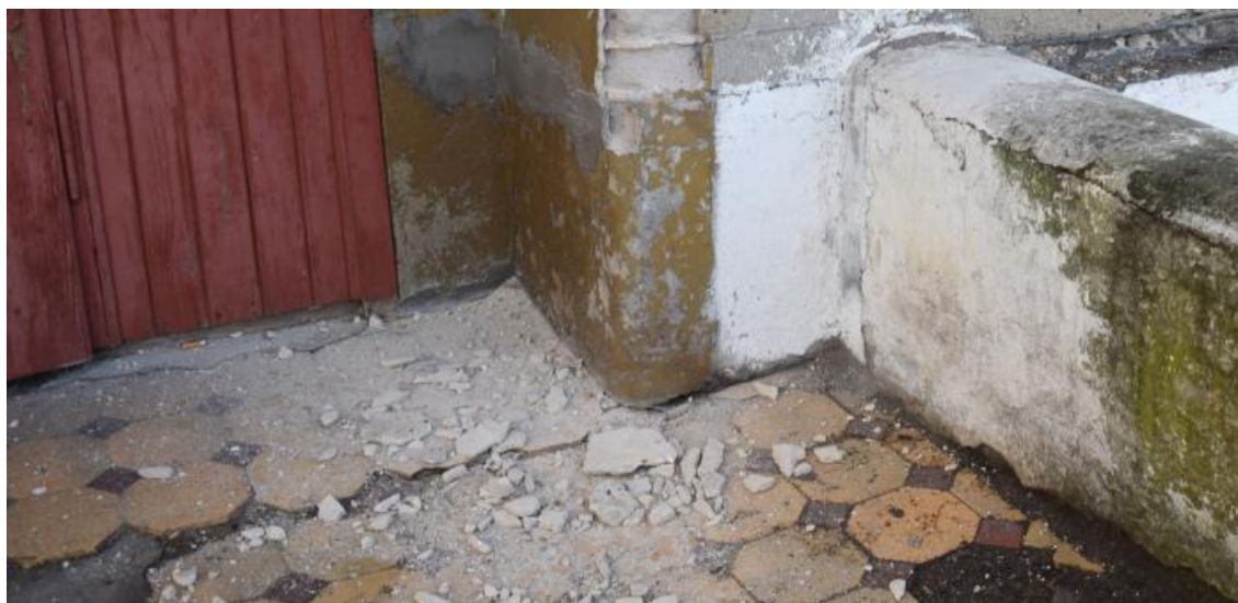
Fot. 33. Posadzka na zewnątrz, przed drzwiami do holu od strony miasta. Widoczne zachowane fragmenty gresu. (fot. A. Wawrzyniak, 2024 r.).
