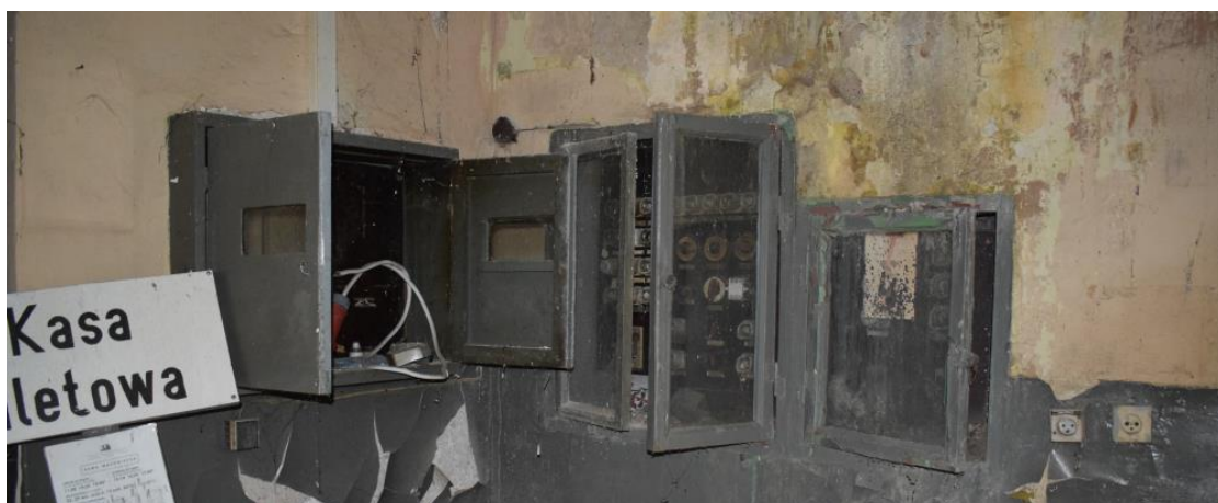
Fot. 30. Rozdzielnie elektryczne w pomieszczeniu dyżurnego ruchu (fot. A. Wawrzyniak 2023 r.).
