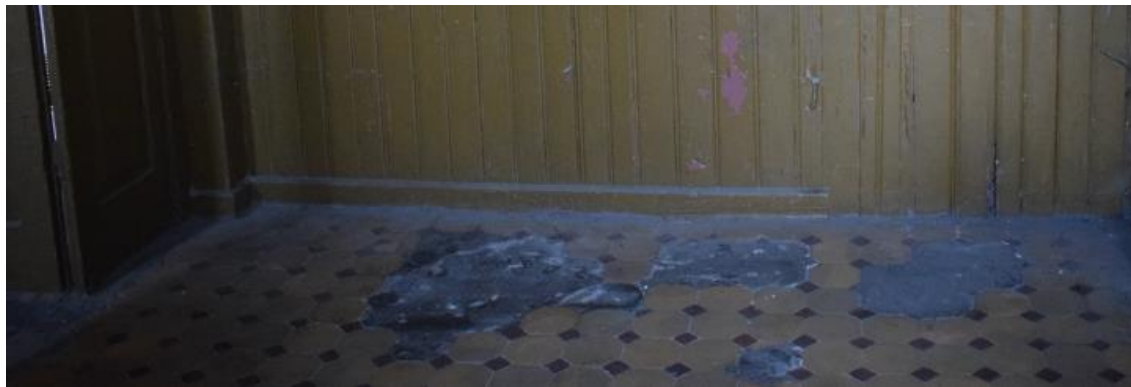
Fot. 34. Posadzka w poczekalni. Widoczne liczne uszkodzenia uzupełnione zaprawą cementową. (fot. A. Wawrzyniak, 2024 r.).
