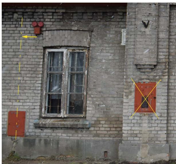
Fot. 70. Skrzynka srk, dzwonek telefonu kolejowego i szafka elektryczna na elewacji od strony peronów (fot. A. Wawrzyniak 2023 r.)
