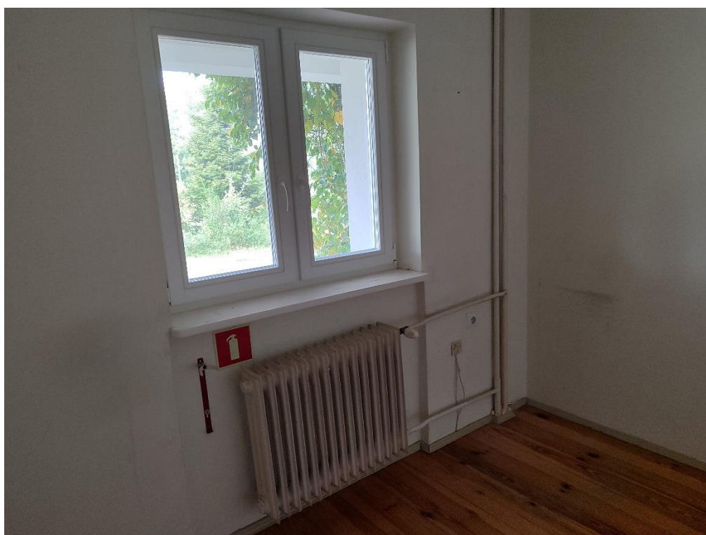
Fot. Kancelaria 1.06 – grzejnik do wymiany, parapet do oczyszczenia i pomalowania, podłoga z desek w korytarzu do cyklizowania, ściany do malowania
