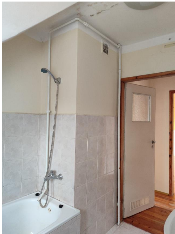
Fot. Łazienka 1.03 – wyposażenie łazienki do wymiany, okładziny ścian i posadzki do wymiany, drzwi wymiany z przesunięciem i powiększeniem otworu, ściany do malowania
