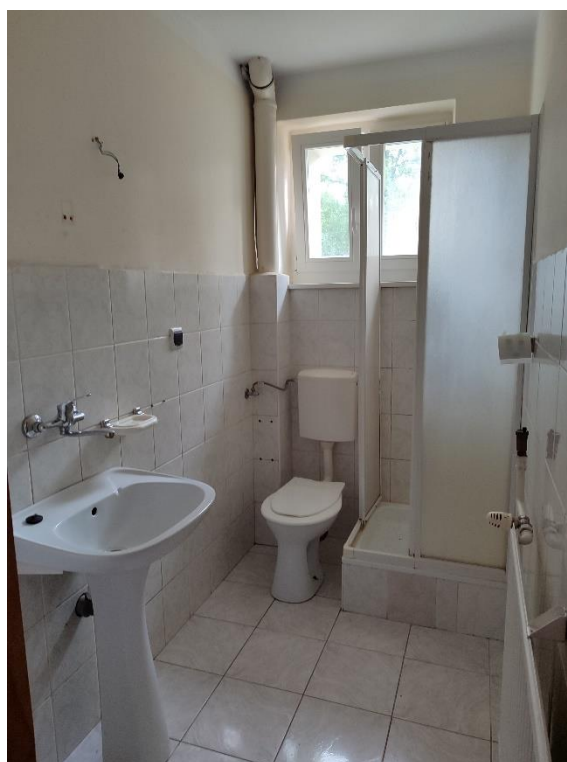
Fot. Łazienka 1.03 – wyposażenie łazienki do wymiany, okładziny ścian i posadzki do wymiany, zabudowa pionu i filarek przyścienny przy brodziku do wykonania, grzejnik do wymiany, ściany do malowania
