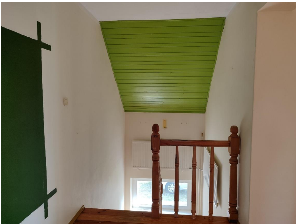
Fot. Korytarz 2.05 – Zabudowa poddasza do wymiany, podłoga z desek i schody do cyklinowania, pochwyt balustrady i słupki z głowicami do szlifowania i lakierowania, ściany do malowania
