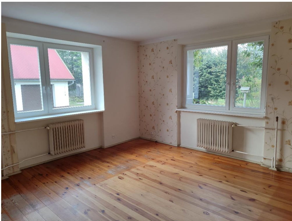
Fot. Pokój 1.01 - grzejniki do wymiany, parapety do oczyszczenia i pomalowania, podłoga z desek do cyklinowania, tapety do zerwania, ściany do malowania
