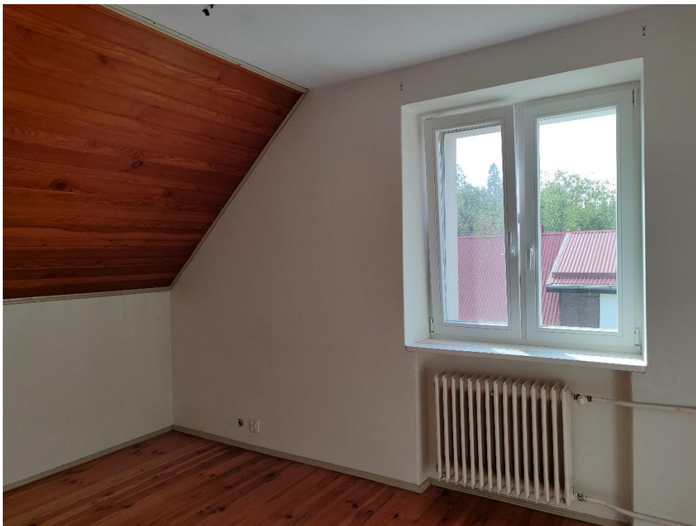
Fot. Pokój 2.03 – zabudowa poddasza do wymiany, grzejnik do wymiany, parapet do oczyszczenia i pomalowania, podłoga z desek do cyklinowania, ściany do malowania
