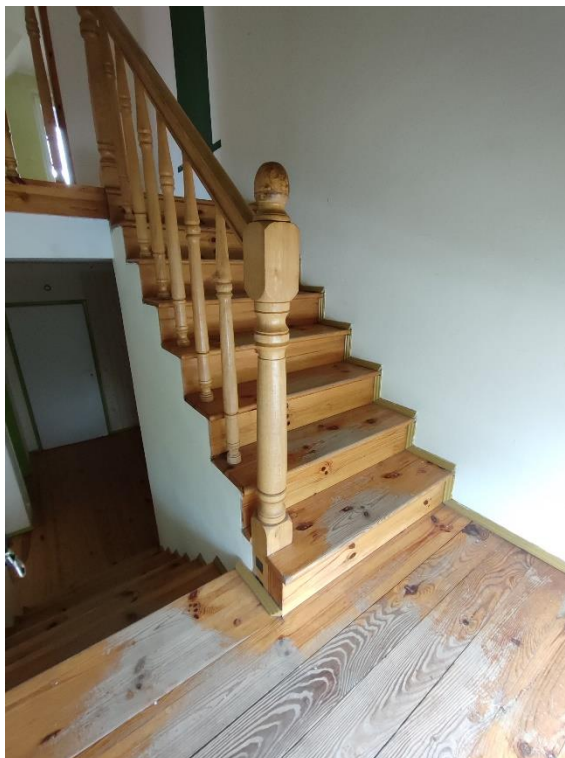
Fot. Podest schodów i schody – do cyklinowania, pochwyt balustrady i słupki z głowicami do szlifowania i lakierowania, ściany do malowania
