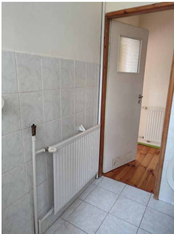
Fot. łazienka 1.03 – okładziny ścian i posadzki do wymiany, grzejnik do wymiany (na drabinkowy), drzwi wymiany z przesunięciem i powiększeniem otworu, ściany do malowania
