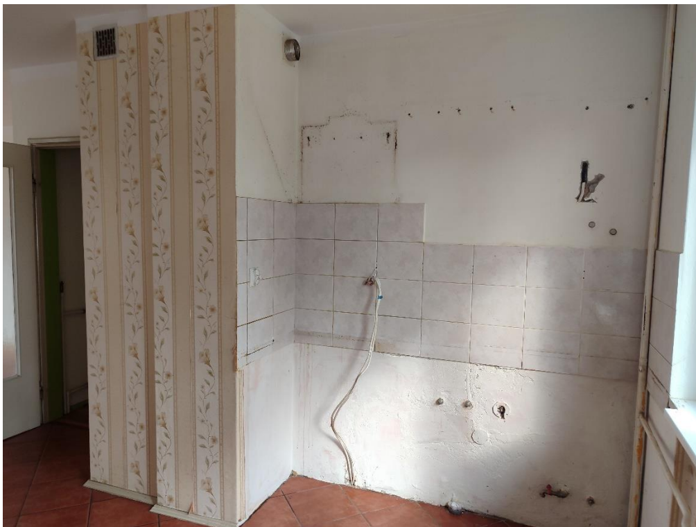
Fot. Kuchnia 1.02 - posadzka z płytek do wymiany, okładzina ścienna z płytek do wymiany, tapety do zerwania, ściany do malowania, wyposażenie kuchni do montażu, przeróbki instalacji, drzwi do wymiany
