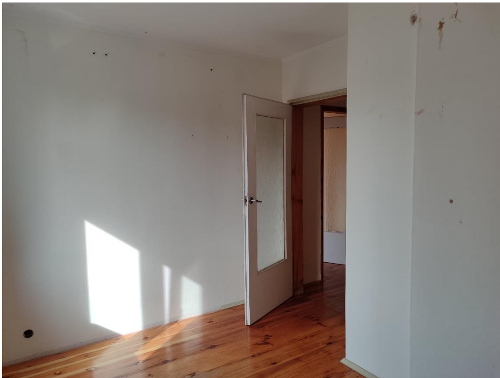
Fot. Pokój 2.03 – podłoga z desek do cyklinowania, drzwi do wymiany, ściany do malowania
