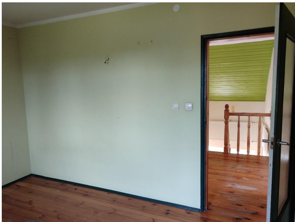
Fot. Pokój 2.01 - podłoga z desek do cyklinowania, ściany do malowania, drzwi do wymiany; (za drzwiami) korytarz 2.05 – zabudowa poddasza do wymiany, podłoga z desek do cyklinowania, ściany do malowania
