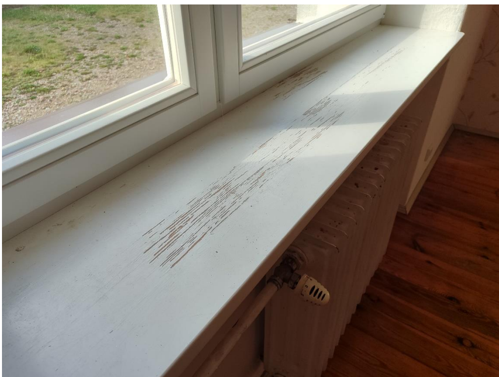
Fot. Parapet drewniany (przykład) – do oczyszczenia i pomalowania
