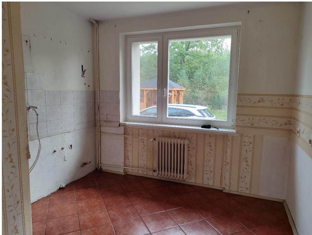
Fot. Kuchnia 1.02 - grzejnik do wymiany, parapet do oczyszczenia i pomalowania, posadzka z płytek do wymiany, okładzina ścienna z płytek do wymiany, tapety do zerwania, ściany do malowania
