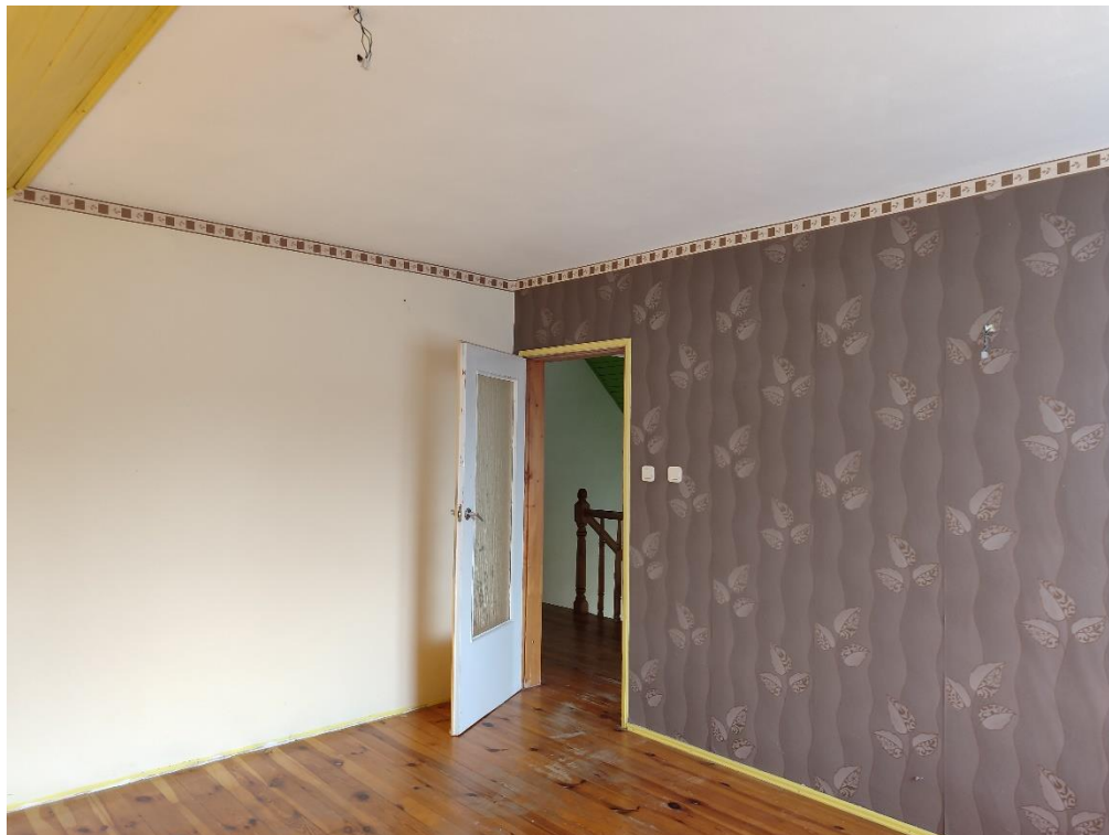
Fot. Pokój 2.02 – zabudowa poddasza do wymiany, podłoga z desek do cyklinowania, drzwi do wymiany, tapety do zerwania, ściany do malowania
