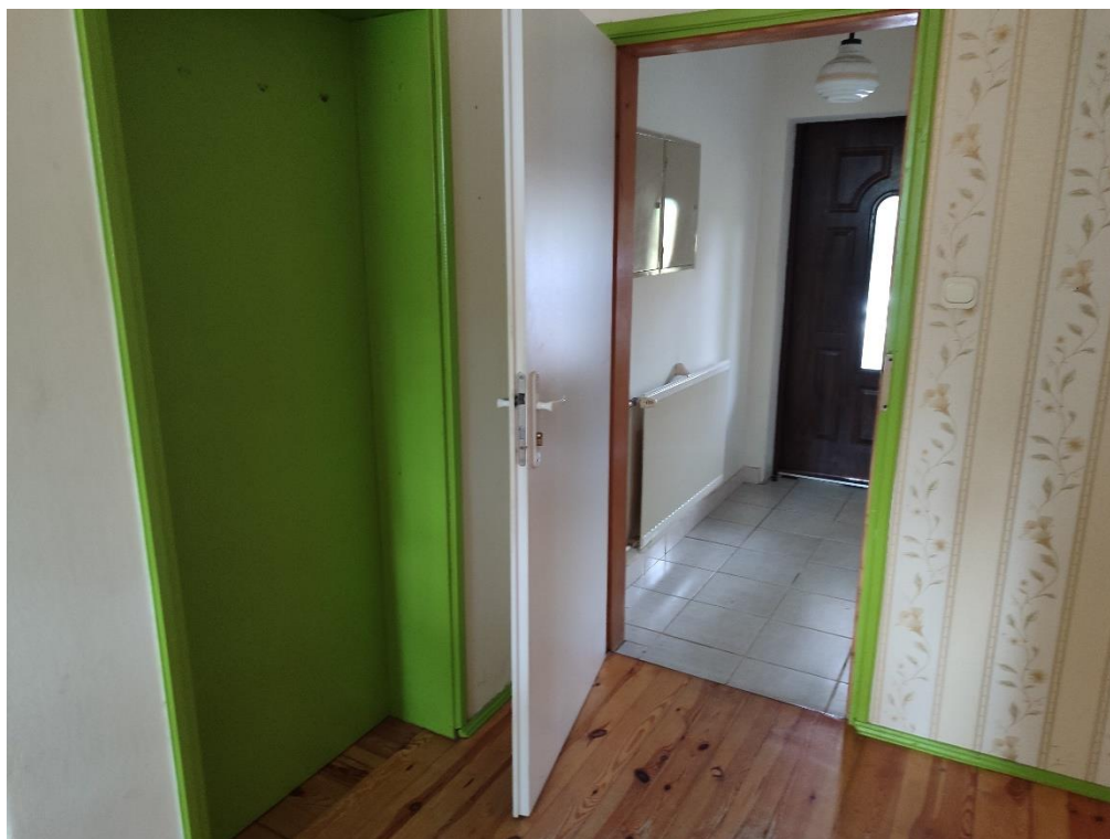
Fot. Korytarz 1.04 – posadzka z płytek w wiatrołapie (1.03) do wymiany, podłoga z desek w korytarzu do cyklizowania, ślepe drzwi do zabudowy, tapety do zerwania, ściany do malowania, drzwi do wymiany
