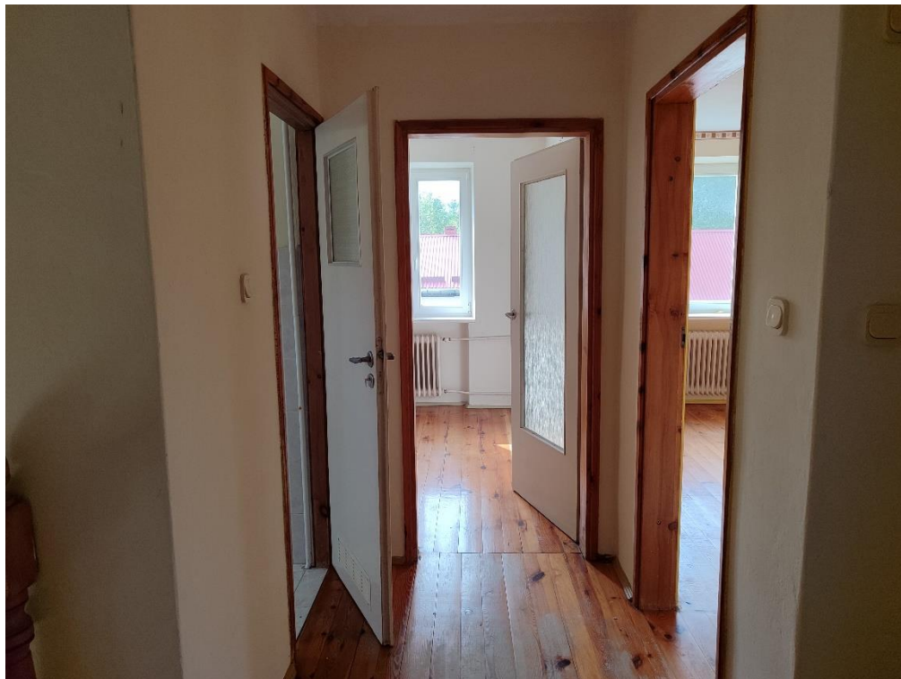
Fot. Korytarz 2.05 – podłoga z desek do cyklinowania, drzwi do wymiany, ściany do malowania
