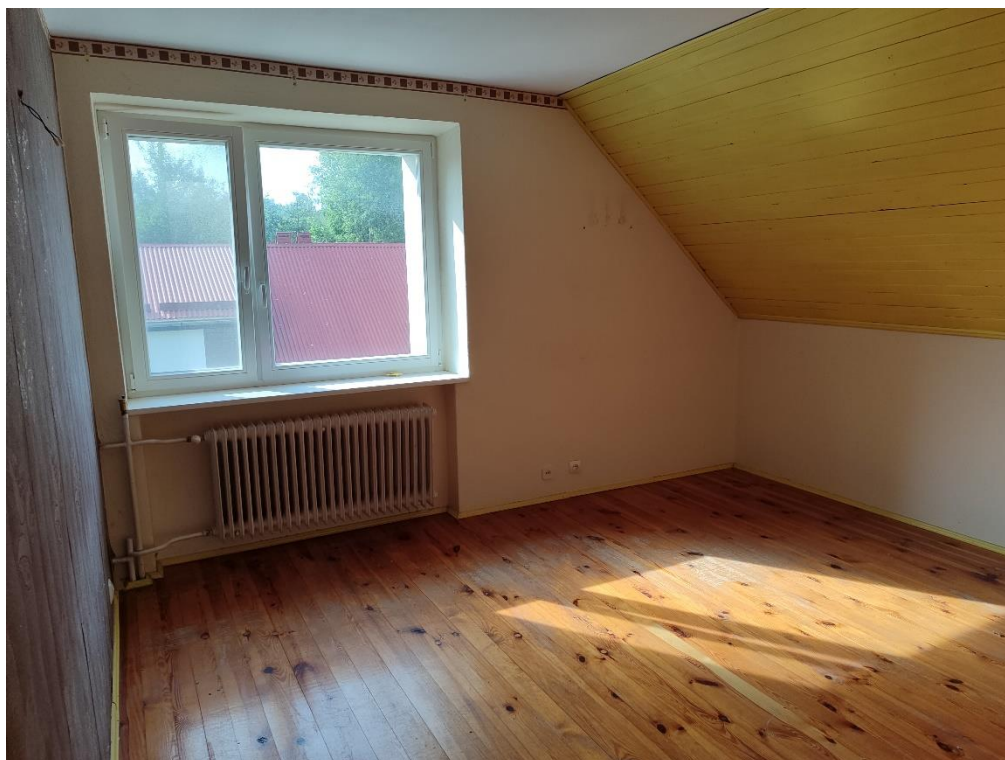
Fot. Pokój 2.02 – zabudowa poddasza do wymiany, grzejnik do wymiany, parapet do oczyszczenia i pomalowania, podłoga z desek do cyklinowania, tapety do zerwania, ściany do malowania
