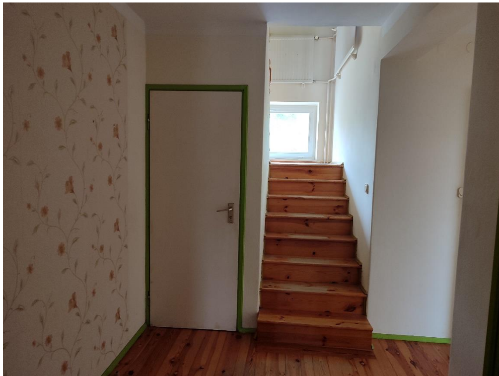
Fot. Korytarz 1.04 i schody - podłoga z desek i stopnie schodów do cyklinowania, drzwi do piwnicy do wymiany, tapety do zerwania, ściany do malowania
