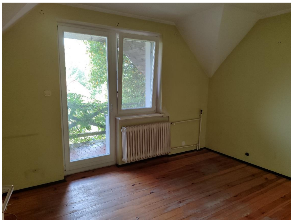
Fot. Pokój 2.01 - grzejnik do wymiany, parapet do oczyszczenia i pomalowania, podłoga z desek do cyklinowania, ściany do malowania; (za oknem) taras zewnętrzny – zabudowa szczytu i balustrada do oczyszczenia i konserwacji
