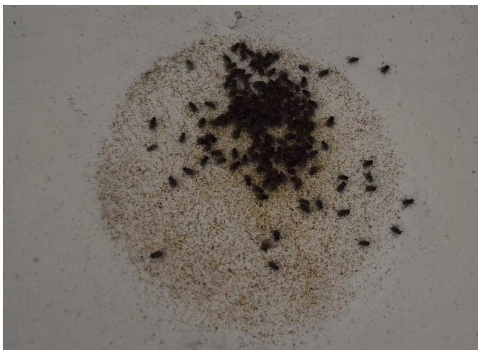
23. To samo miejsce po usunięciu plakietki – widoczne: przebarwienia na skutek zawilgocenia i rozrastającego się ogniska grzyba oraz kolonie zimujących much.
