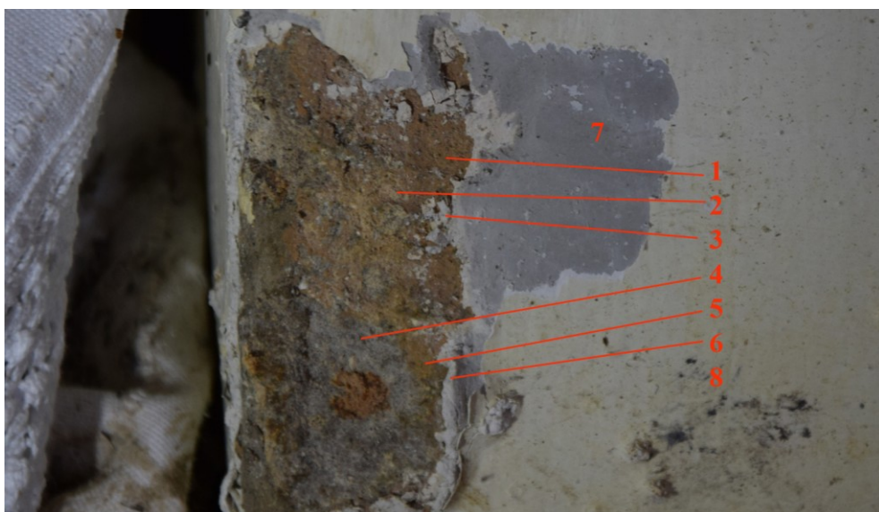
11. Mensa – stratygrafia w punkcie 5: 1-tynk wapienno-piaskowy, 2-pobiała, 3-pobiała, 4- tynk cementowy, 5-w. malarska ugrowa (olejna – jw.), 6-w. malarska biała, 7-zacierka (szlichta gipsowa), 8- w. malarska biała.
