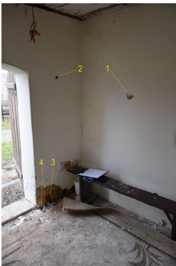
1. Widok wnętrza w kierunku wschodnim. Widoczne partie ścian zainfekowane grzybem.
