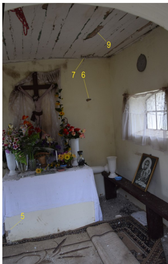
1. Widok wnętrza w kierunku wschodnim. Widoczne partie ścian zainfekowane grzybem.
