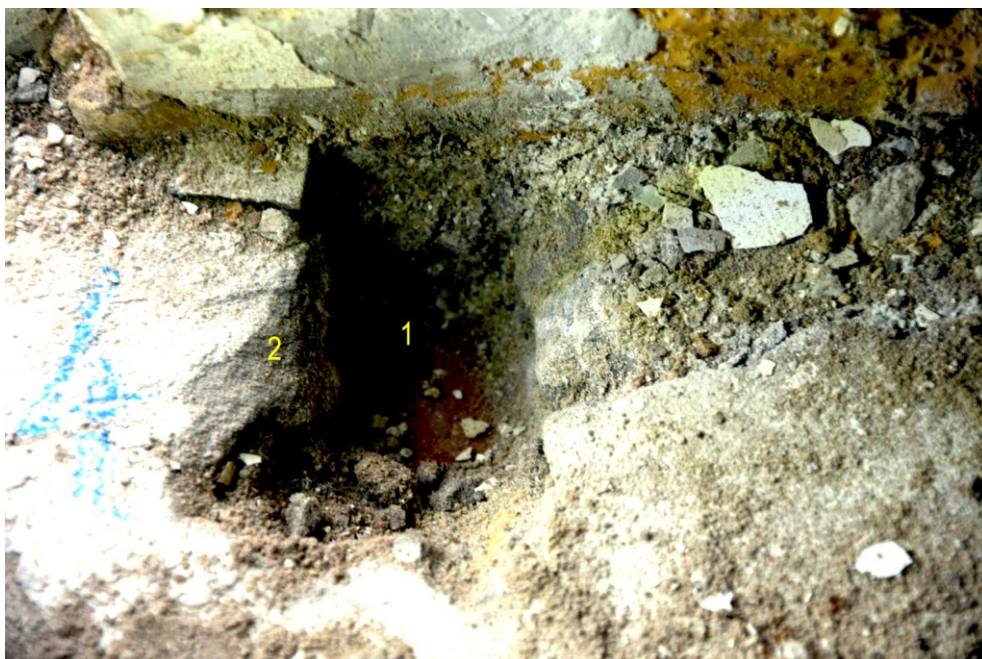
10. Posadzka – stratygrafia w punkcie 4: 1/ posadzka ceglana, 2/ wylewka betonowa.
