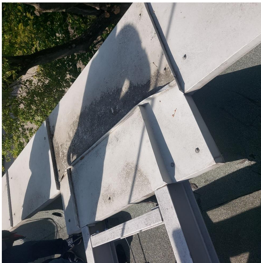
Fot. 32. Zastoiska wody na obróbkach blacharskich
