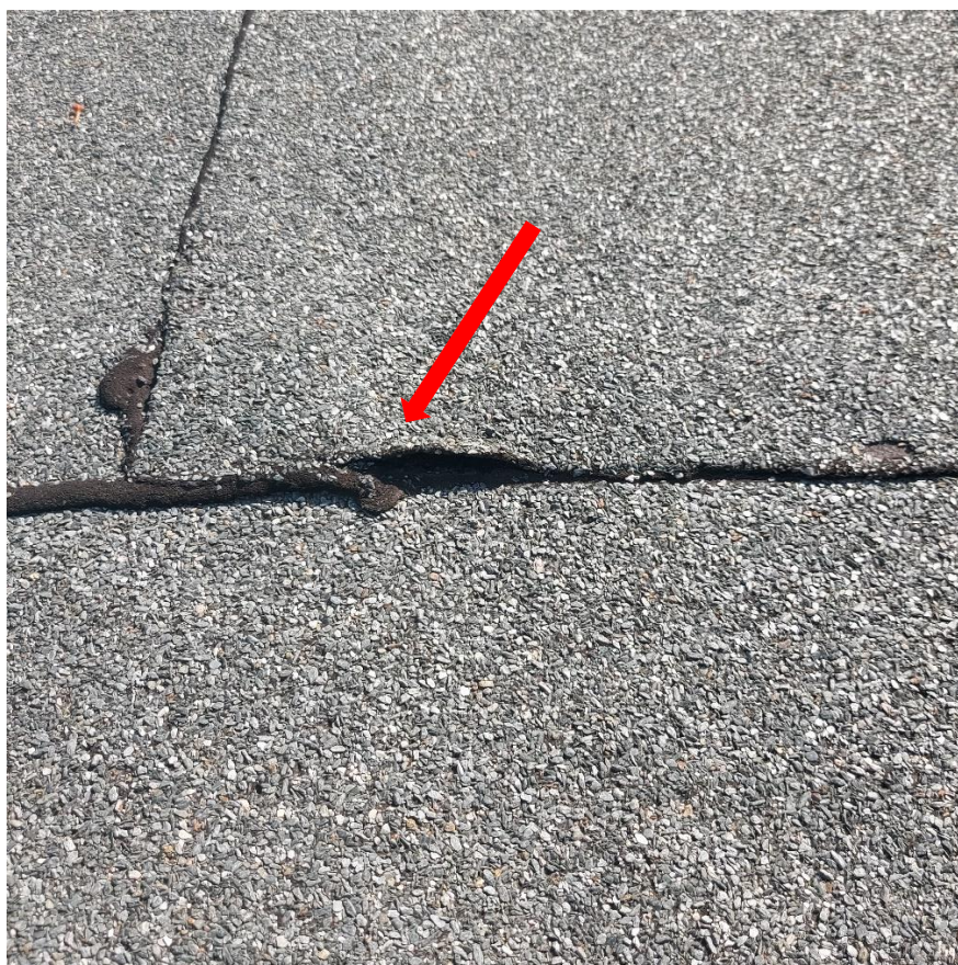
Fot. 22. Nieszczelności i rozwarstwienia hydroizolacji na płaszczyźnie dachu
