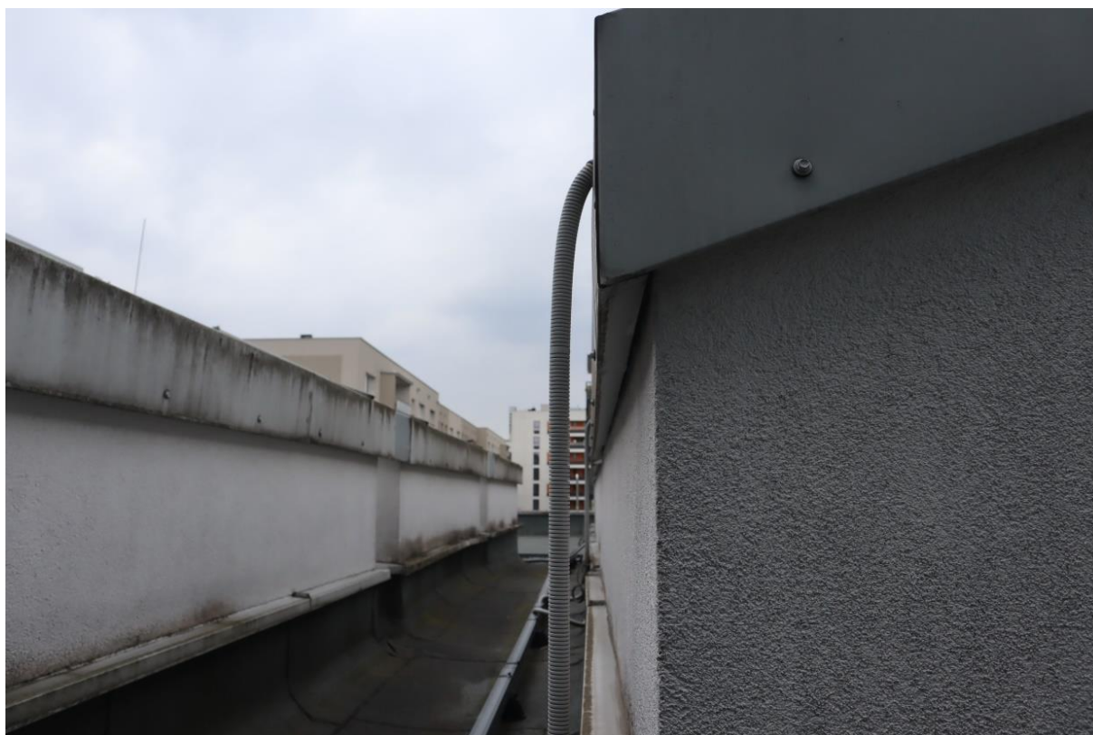
Fot. 6. Obróbka blacharska daszka świetlika przylega krawędzią do ściany świetlika
