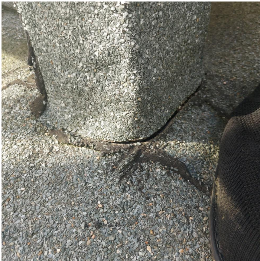
Fot. 35. Nieszczelności hydroizolacji na wywinięciu papy
