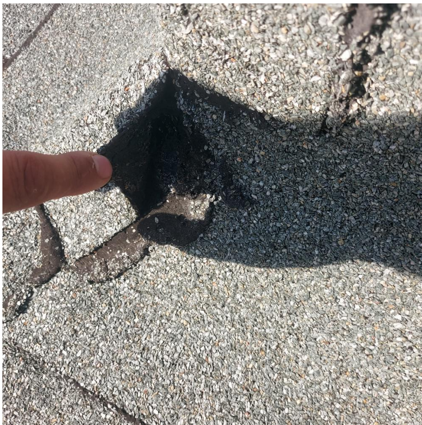
Fot. 23. Nieszczelności i rozwarstwienia hydroizolacji na podstawie komina – pozostałe świetliki
