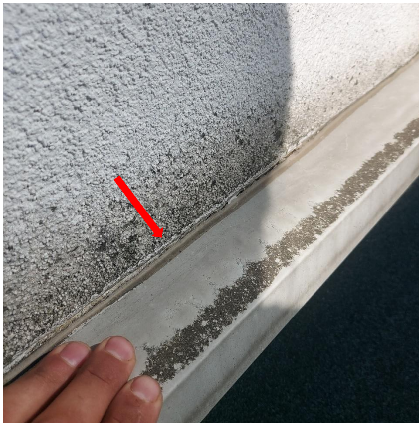
Fot. 21. Braki uszczelnienia obróbki blacharskiej; odwrotny spadek rynny
