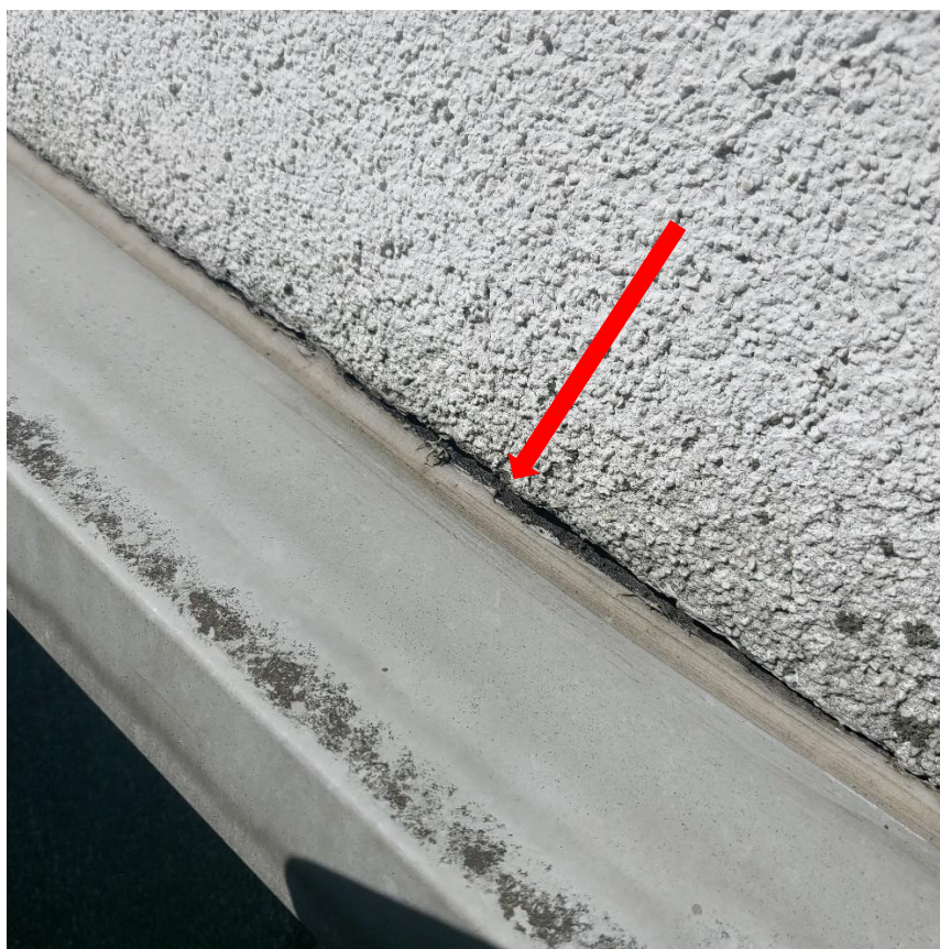
Fot. 20. Obróbki kominów i świetlików zamontowane z odwrotnym spadkiem, braki uszczelnień z BSO
