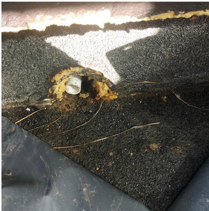
Fot. 41. Okrywak połaci dachowej. Stwierdzono wilgoć, wodę pod paroizolacją i pod warstwami termo i hydroizolacji
