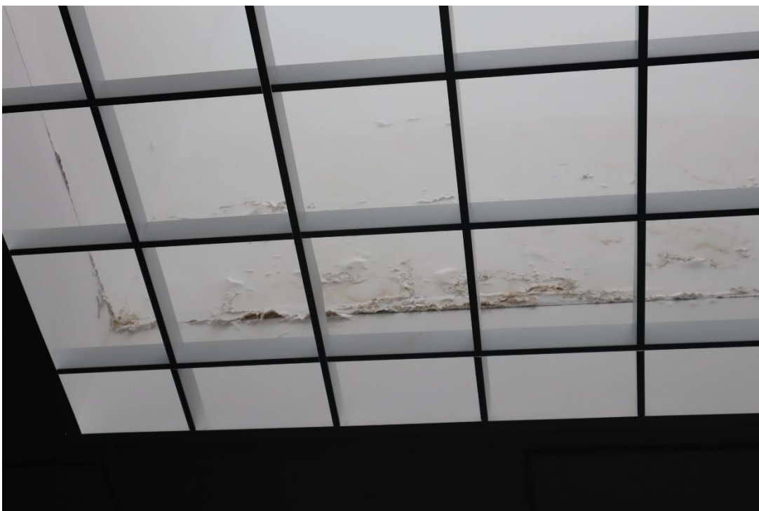
Fot. 2. Zacieki ścian świetlika dachowego
