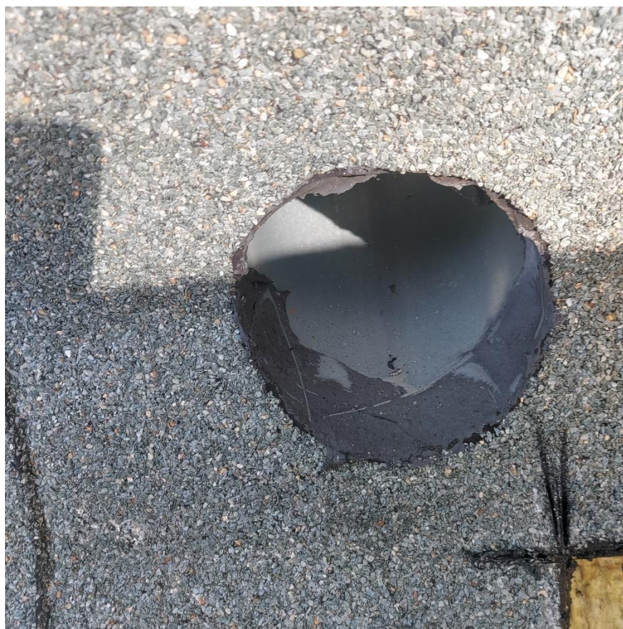
Fot. 38 . Brak właściwego połączenia rur przelewowych
