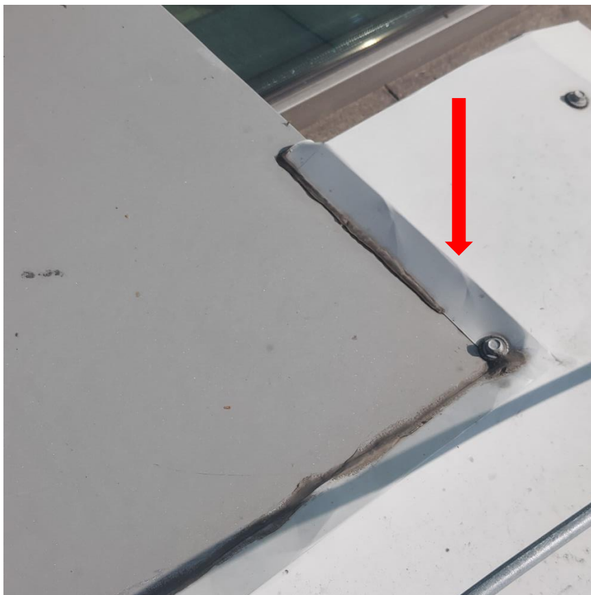
Fot. 13. Braki uszczelnienia obróbki blacharskiej na połączeniu budynków
