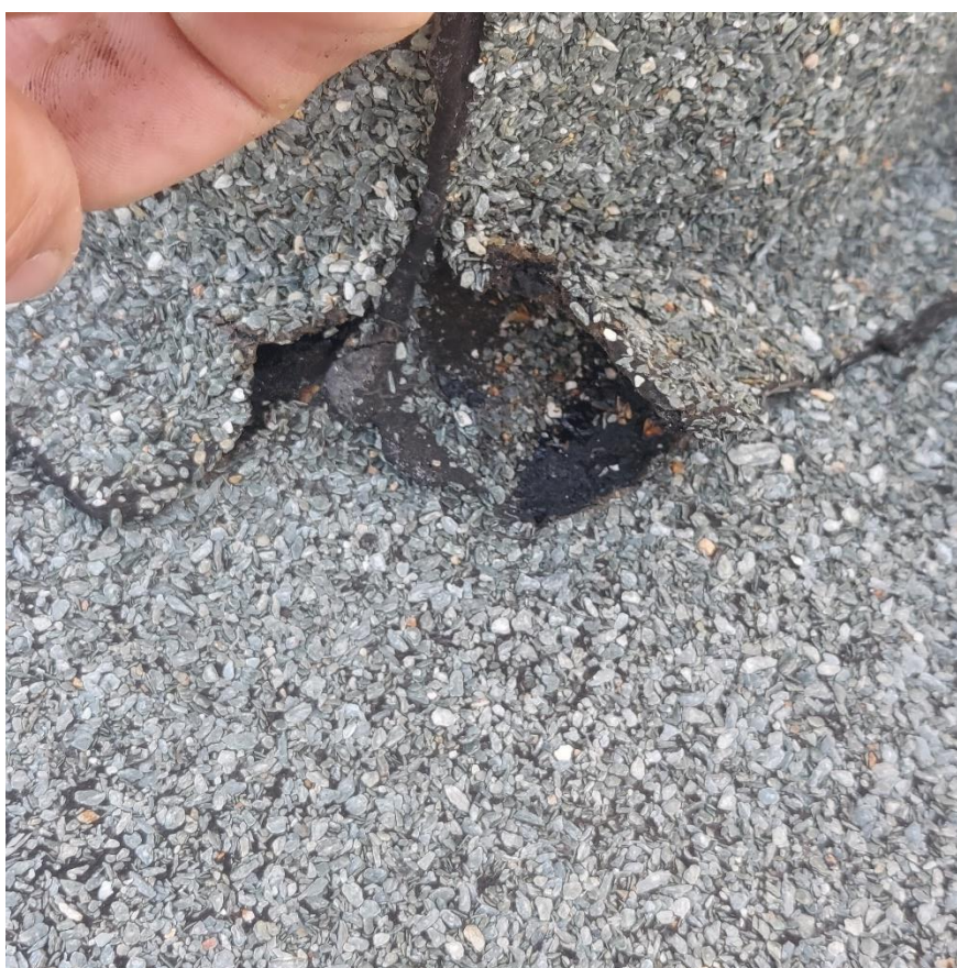
Fot. 24. Nieszczelności i rozwarstwienia hydroizolacji na wywnięć hydroizolacji na kominie – pozostałe świetliki
