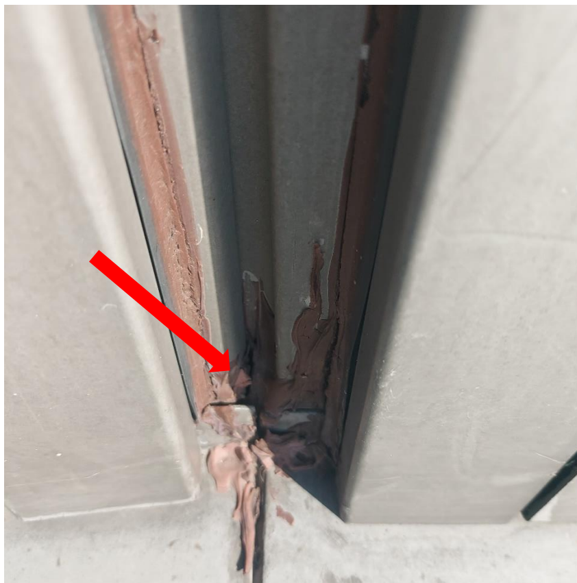
Fot. 17. Braki uszczelnienia obróbki blacharskiej, rozszczelnienia ślusarki okiennej
