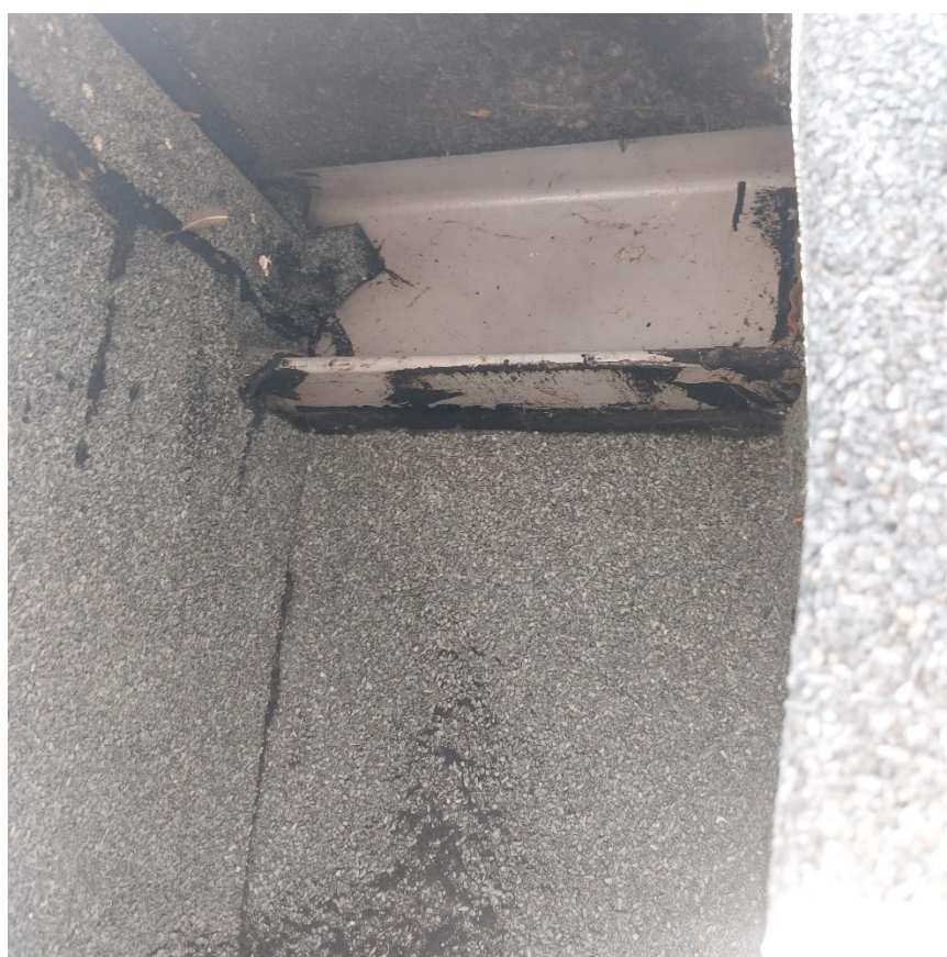
Fot. 34. Braki uszczelnień przebić konstrukcji stalowej przez dach
