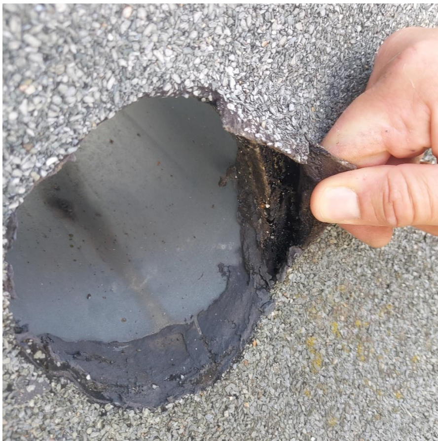
Fot. 39. Brak właściwego połączenia rur przelewowych, odspojenia papy i nieszczelności
