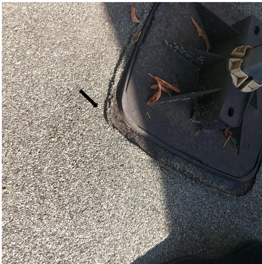
Fot. 29. Degradacja hydroizolacji przez stopę kanałów – jednostek wentylacyjnych, klimatyzacyjnych
