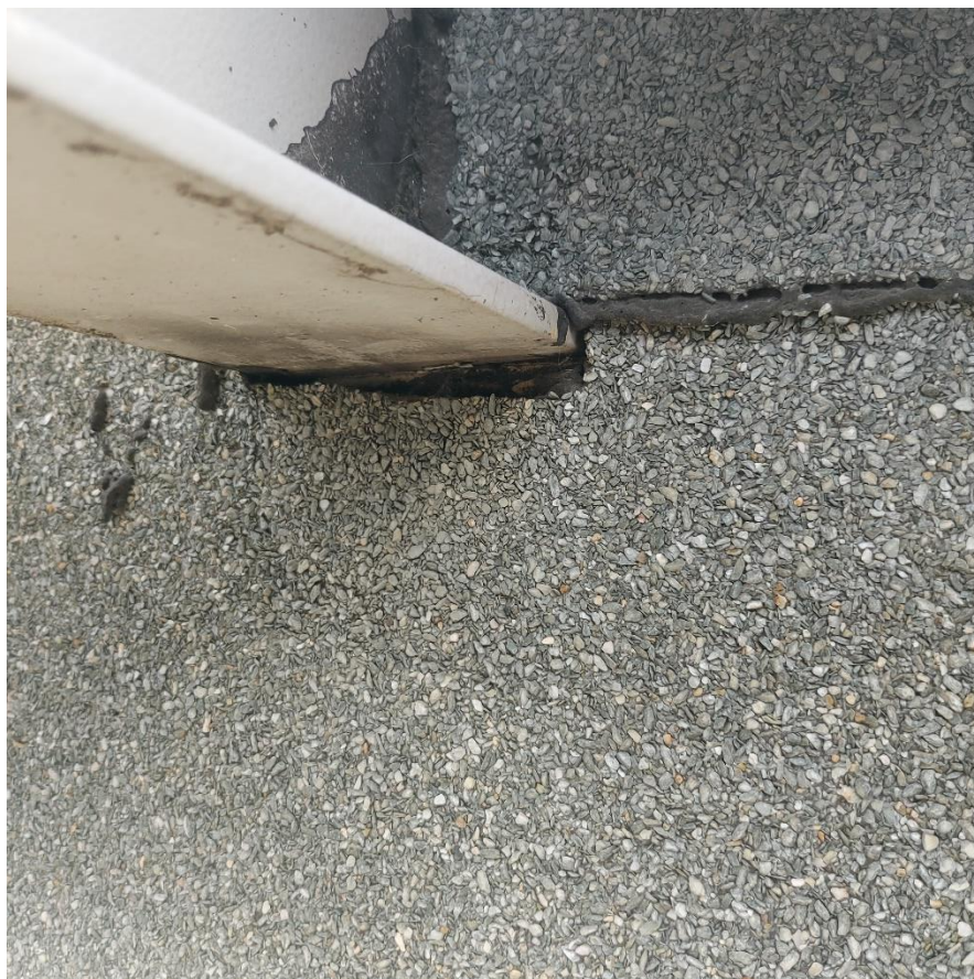
Fot. 33. Braki uszczelnień przebić konstrukcji stalowej przez dach
