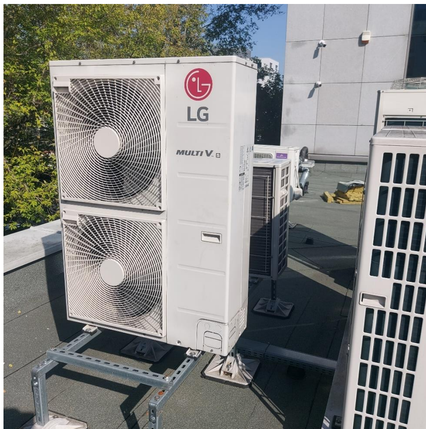
Fot. 30. Degradacja hydroizolacji przez stopę kanałów – jednostek wentylacyjnych, klimatyzacyjnych
