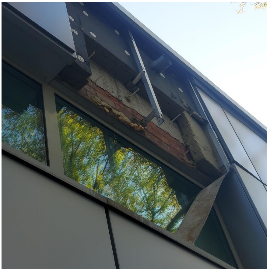
Fot. 9. Odkrywka elewacji w miejscu przecieków, zalewania i degradacji
