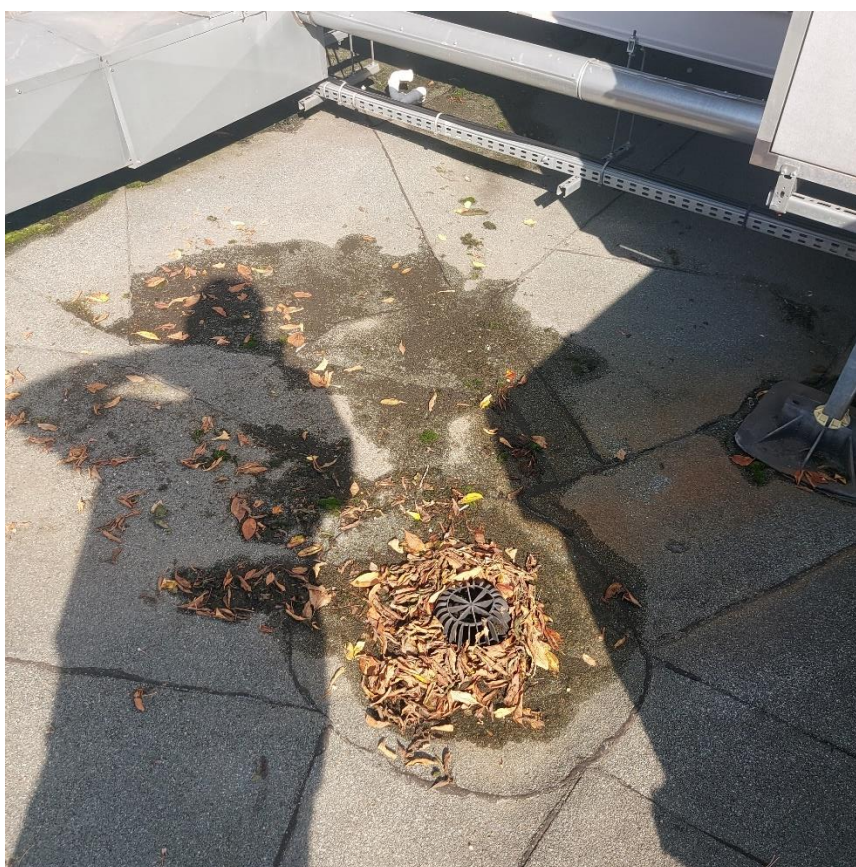
Fot. 40. Miejscowe zastoiska wody na płaszczyźnie hydroizolacji
