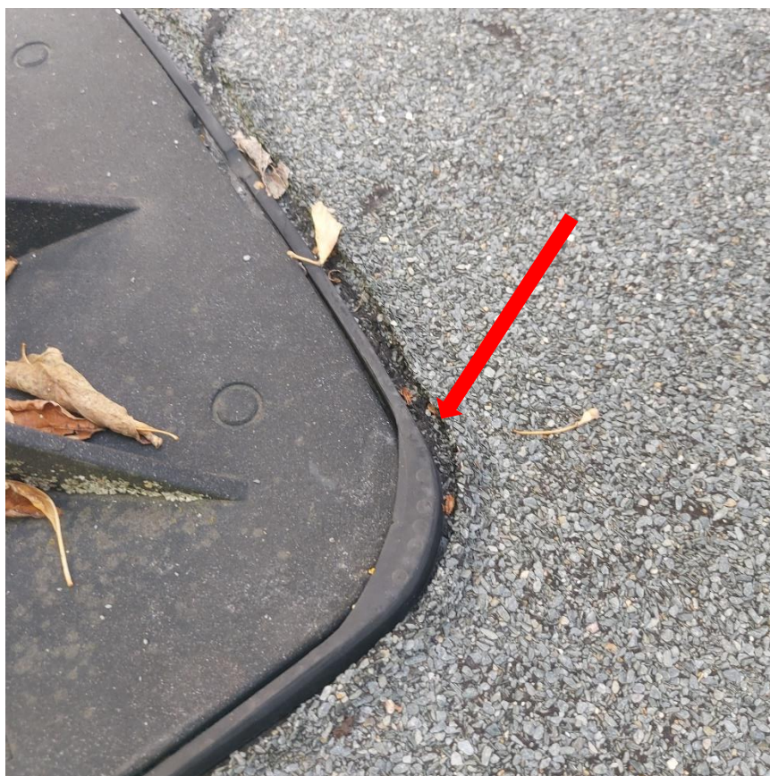
Fot. 28. Degradacja hydroizolacji spowodowana przez stopę kanałów jednostek wentylacyjnych, klimatyzacyjnych
