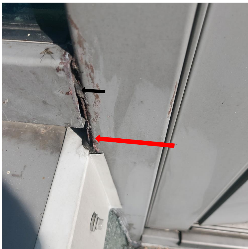
Fot. 16. Braki uszczelnienia obróbki blacharskiej, rozszczelnienia ślusarki okiennej
