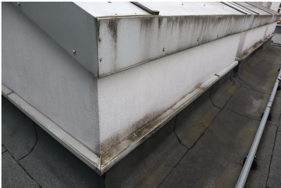
Fot. 5. Ślady zacieków na ścianach świetlików
