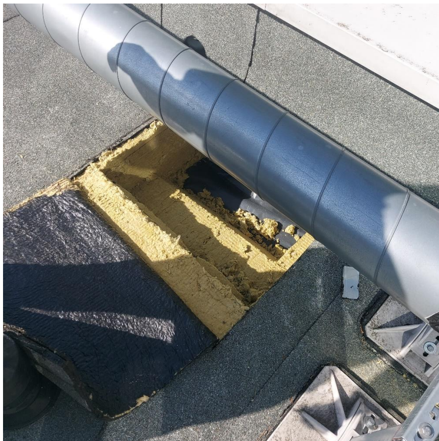
Fot. 7. Miejsce odkrywki na dachu
