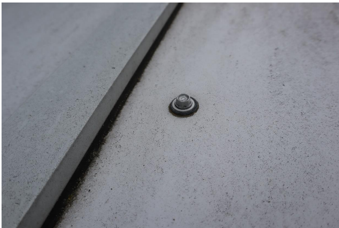
Fot. 4. Mocowanie blachy obróbki blacharskiej do podłoża za pomocą blachowkrętów z podkładką gumową
