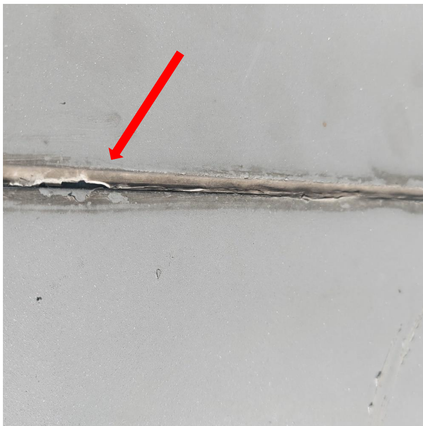
Fot. 14. Braki uszczelnienia obróbki blacharskiej na połączeniu z budynkiem
