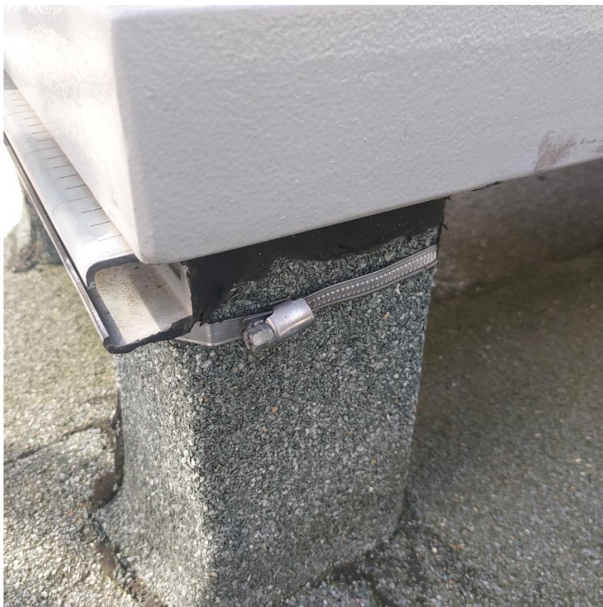
Fot. 36. Wadliwe uszczelnienie kwadratowej konstrukcji opaską zaciskową
