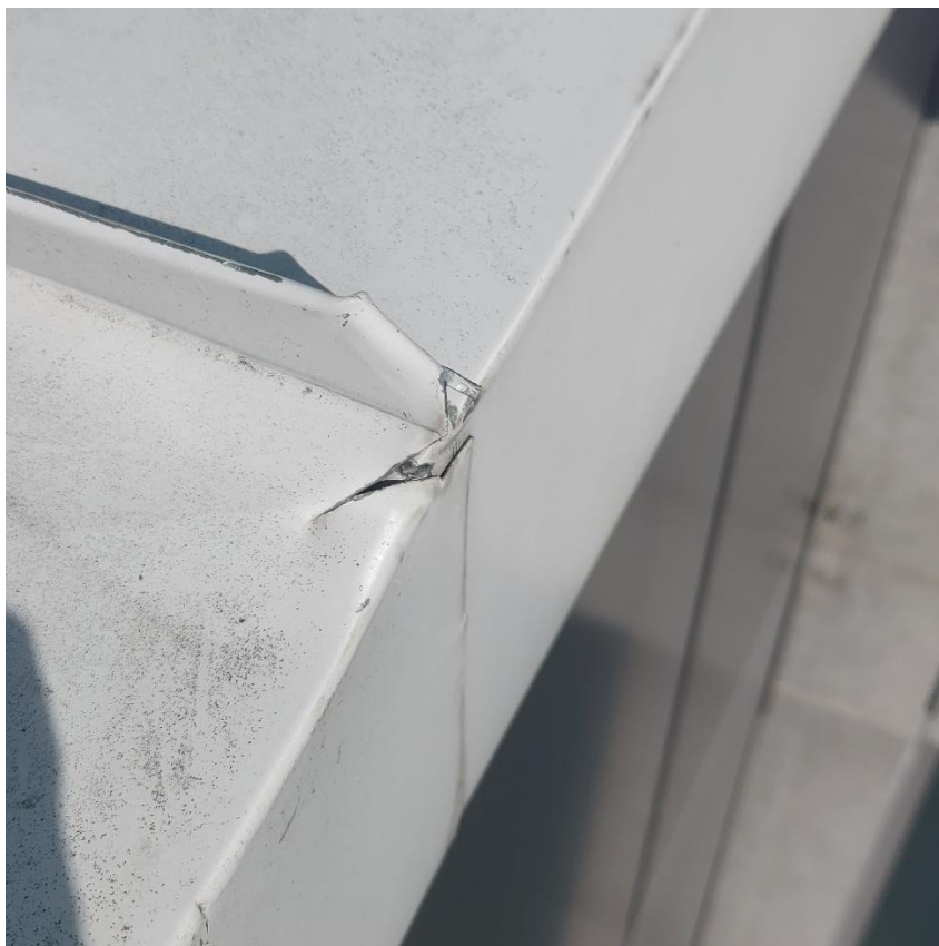
Fot. 19. Zniszczona – nieuszczelna obróbka blacharska
