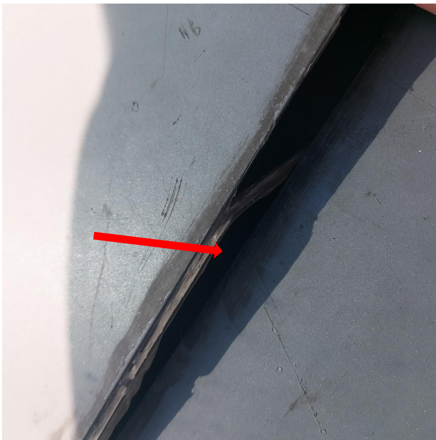
Fot. 15. Braki uszczelnienia obróbki blacharskiej – połączenie budynków – rozszczelnienia
