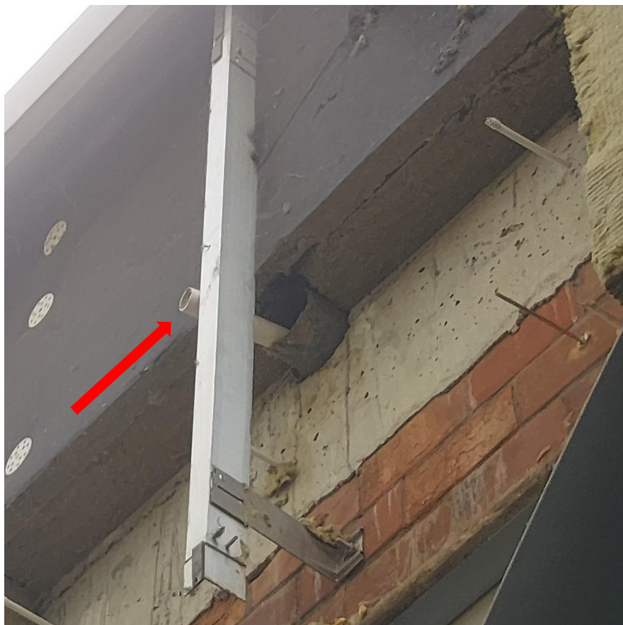
Fot. 11. Sztukowany, prowizoryczny, za krótki rzygacz wychodzący z warstwy termoizolacji, który jest przyczyną zalewania elewacji budynku
