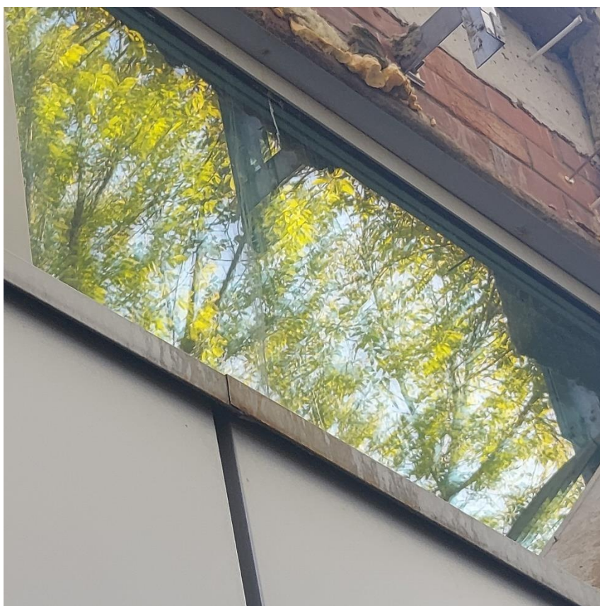
Fot. 10. Miejsce zalewania okien i parapetów
