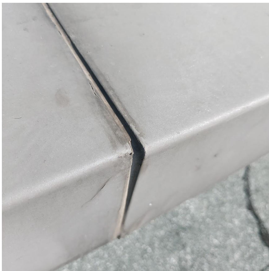
Fot. 18. Nieszczelności obróbki blacharskiej – połączenie budynków – rozszczelnienia
