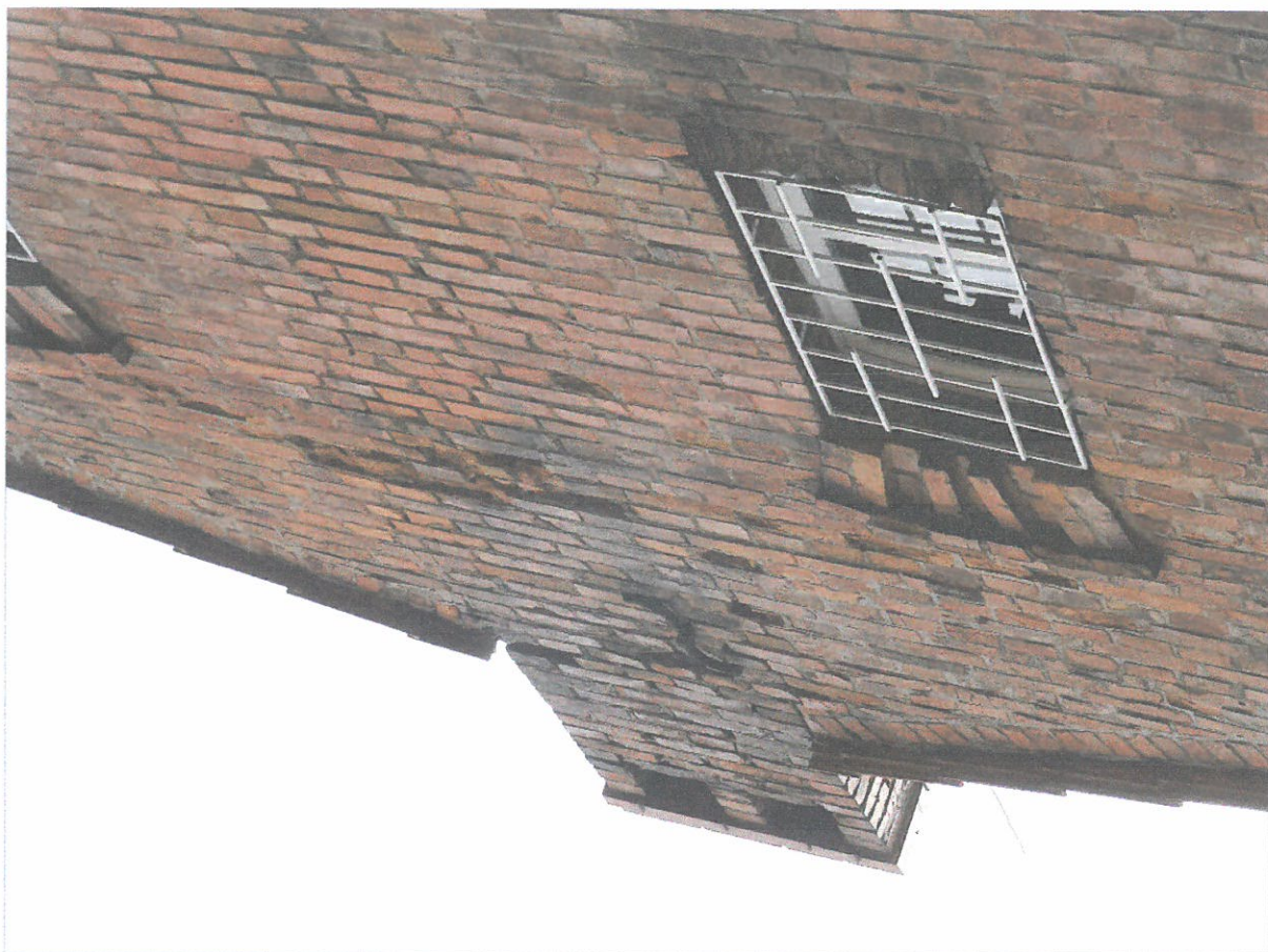
uszkodzenia ceglanoego gzymsu pod dachem, zniszczona blacharka; zróżnicowane kraty w oknach jak również parapety
