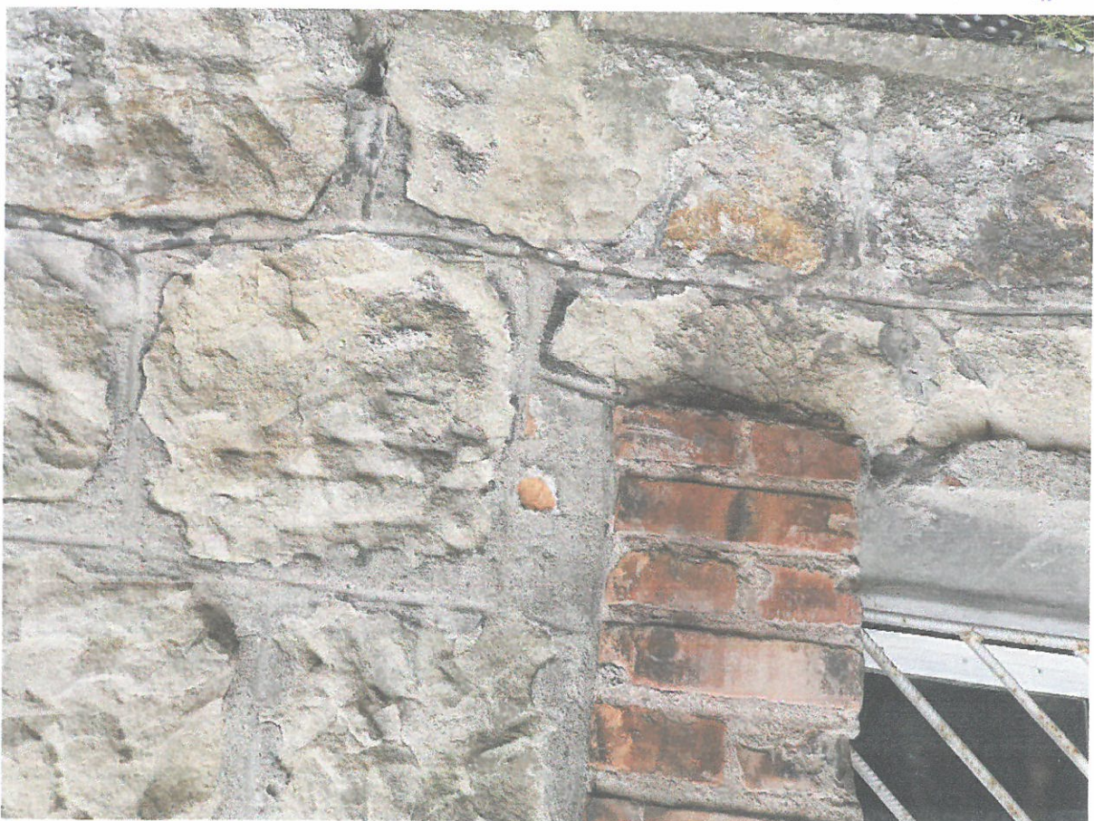
wadliwe spoiny i uzupełnienia cementem na elewacji północnej elewacja od strony południowej - wejściowa
