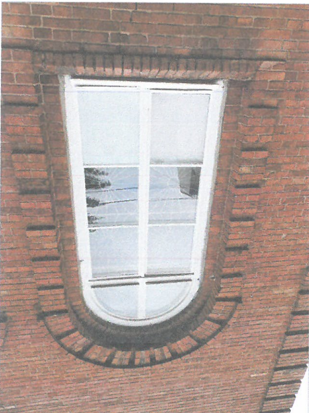
stolarstwo okienna elewacji zachodniej, zaprawy maskujące mniejsze wymiary okien parapety z cegiel układanych pod skosem na elewacji zachodniej
