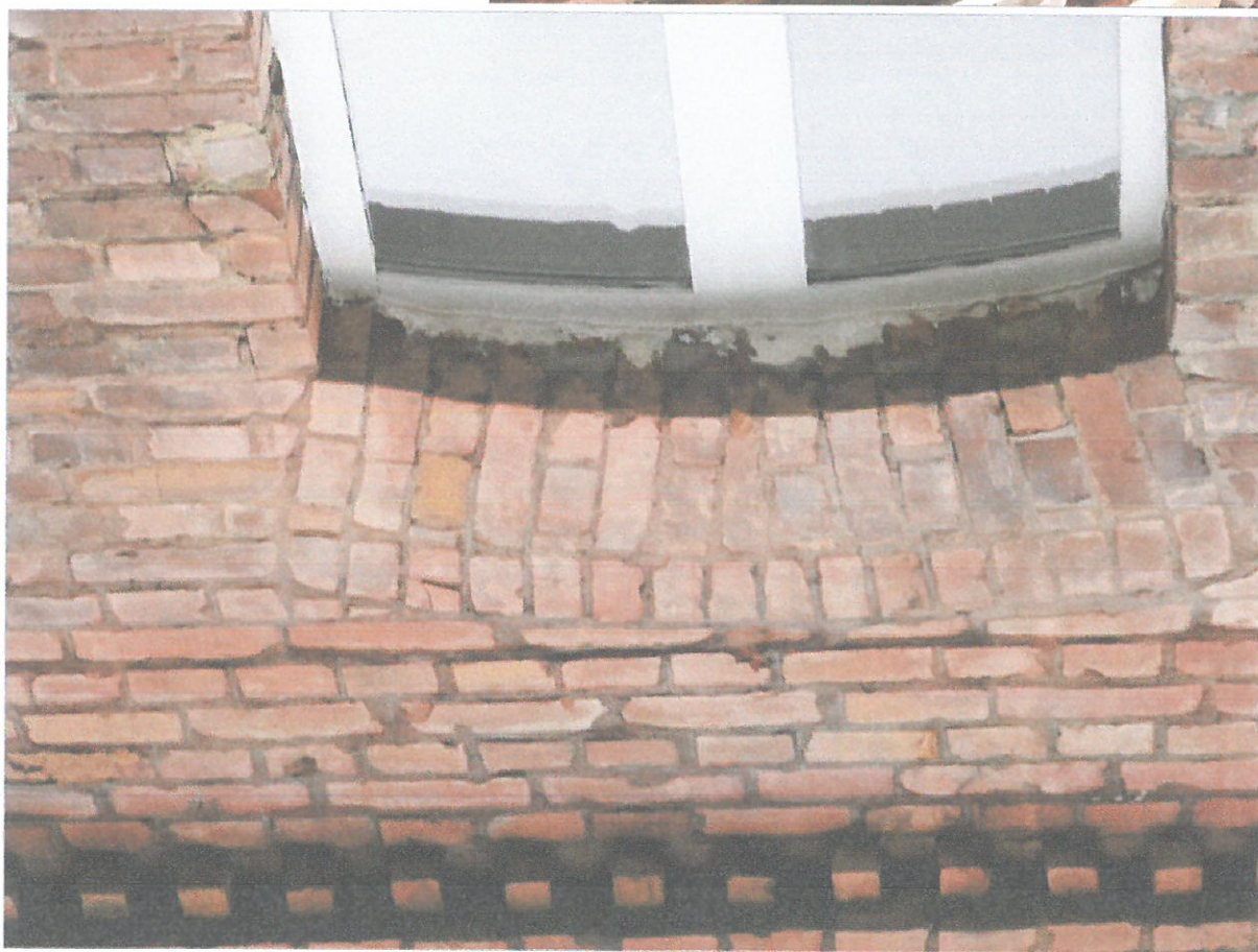
zaprawy naprawcze w obrębie partii gzymsów okiennych – szare i białe, lokalnie widoczne spękania wątków uszkodzenia cegieł ozdoby gzymsu
