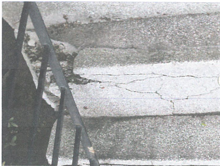
uszkodzenia stopni z lastrika na elewacji południowej
