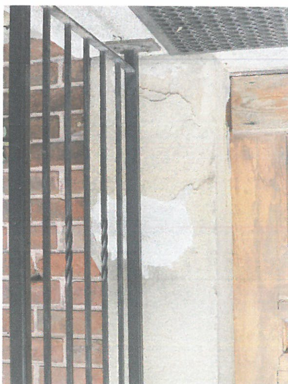
uszkodzenia prawego węgła portalu wejściowego naprawcze zaprawy cementowe schowany w chodniku cokol na elewacji północnej
