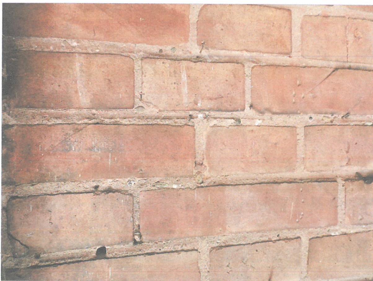
oryginalna spoina oraz w różnych partiach elewacji (dobudowanych) przekształcenia i uzupełnienia spoin, wymieniane cegły w parti cokołu
