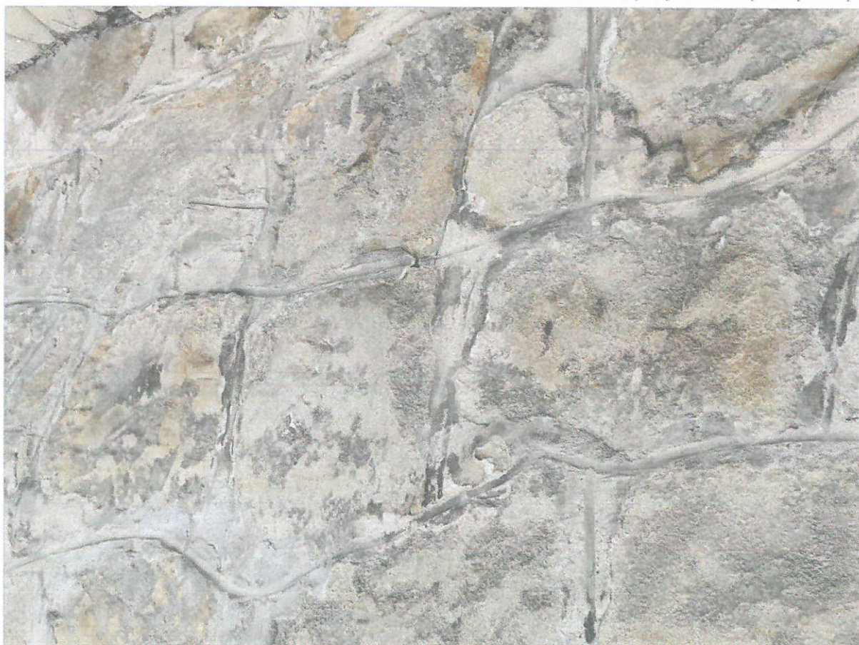
degradacja kamieniarzki objawiająca się osypywaniem się przypowierzchniowych warstw; szare wadliwe technologicznie cementowe naprawy szpony mocno odspajające
