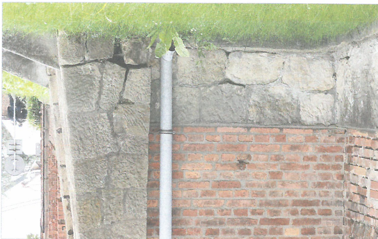
rozluźnienia kamieniarki na szkarpie przy wejściu od elewacji zachodniej (część ponocna)
