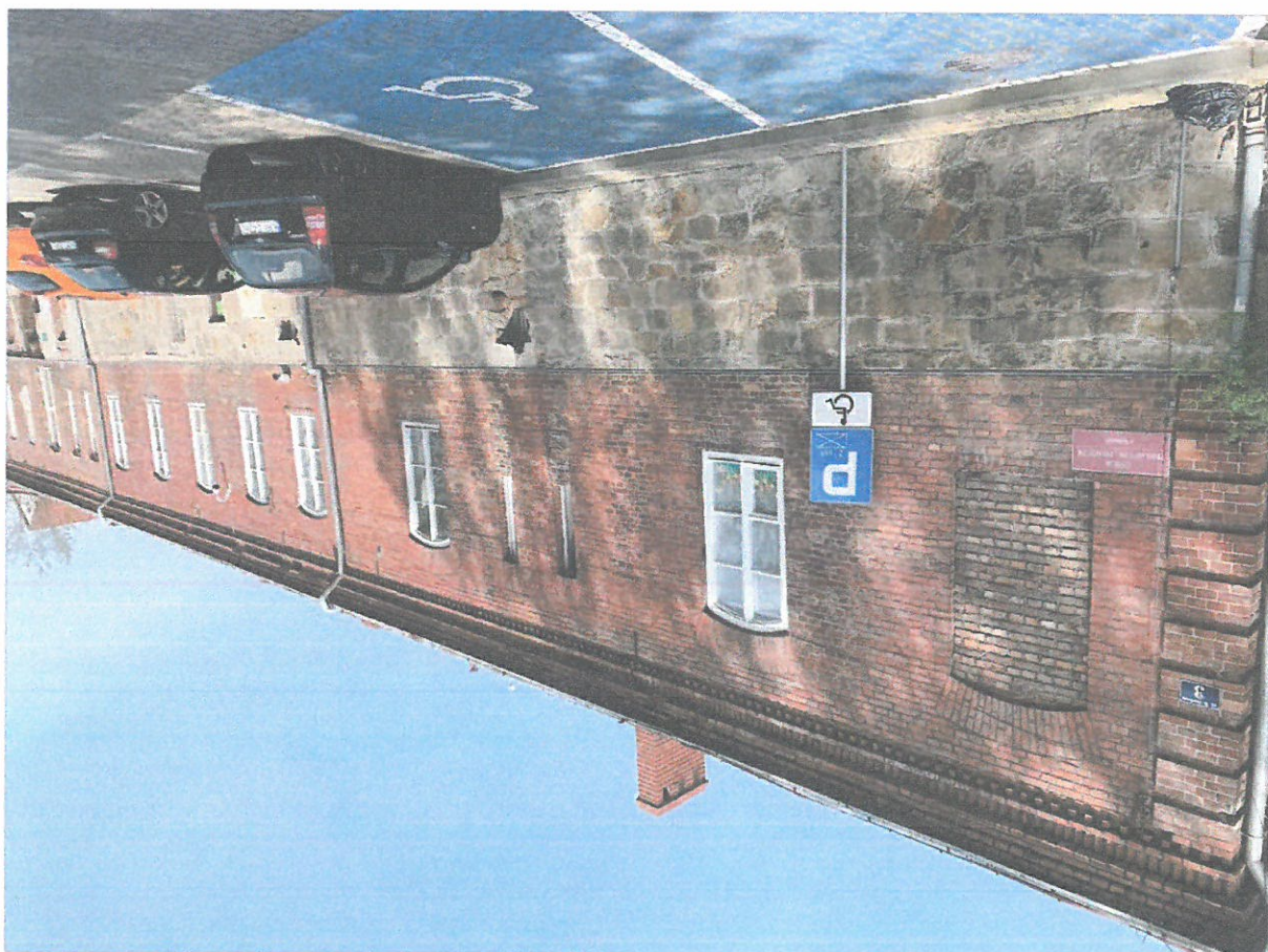
rozróżnicowanie kształtów i kolorystyki cegieł – znaczne ubytki wielu parti niezabezpieczonych przed namakaniem zniszczenie tynek imitujących wątek kamienny w parti elewacji wschodniej od strony północnej
