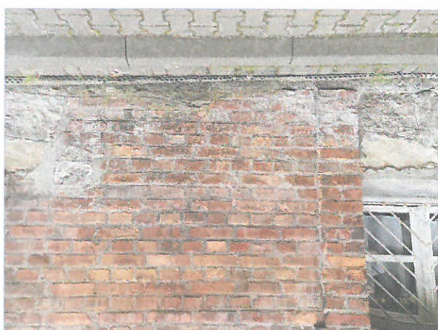
uszkodzenia prawego węgła portalu wejściowego naprawcze zaprawy cementowe schowany w chodniku cokol na elewacji północnej
