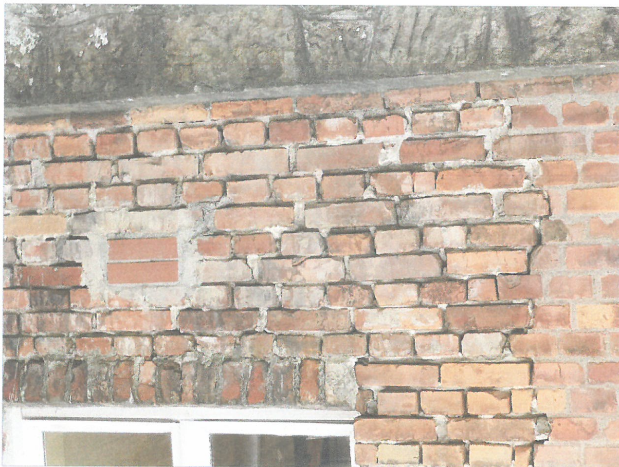
uszkodzenia wników spowodowane przekształceniami związanymi z nią z wyniszczeniem okien demontażem kral, skrzynek technicznych, przemurowanie i brak opracowania spoinowania, liczne zaprawy naprawcze, przypadkowo wstawione cegły
