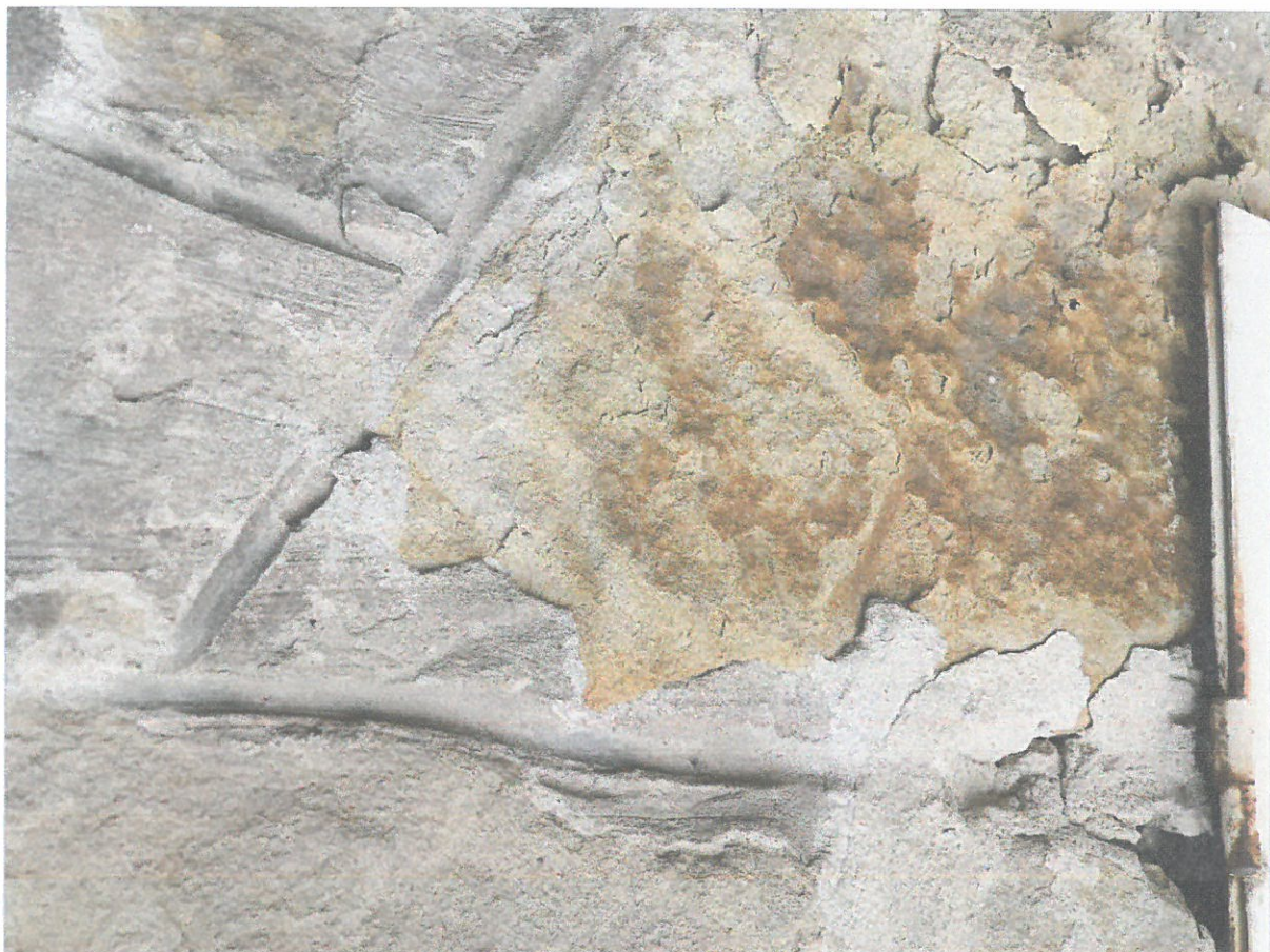
degradacja kamieniarzki objawiająca się osypywaniem się przypowierzchniowych warstw; szare wadliwe technologicznie cementowe naprawy szpony mocno odspajające
