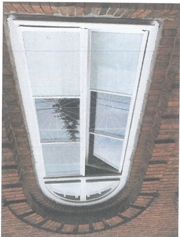
stolarstwo okienna elewacji zachodniej, zaprawy maskujące mniejsze wymiary okien parapety z cegiel układanych pod skosem na elewacji zachodniej
