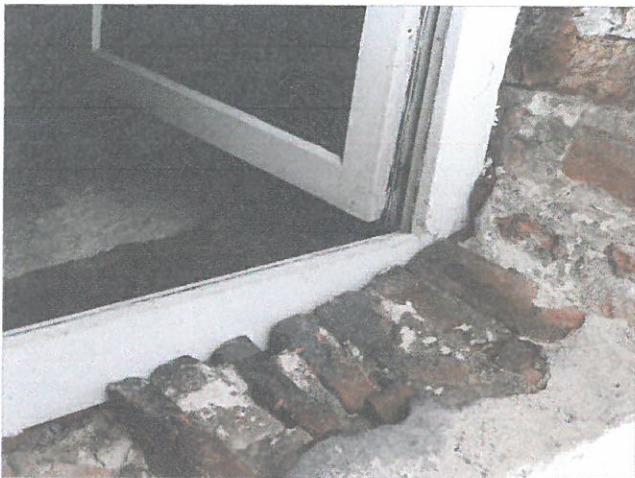
w oknie na parterze na elewacji wschodniej przy wymianie zmieniono jego kształt
