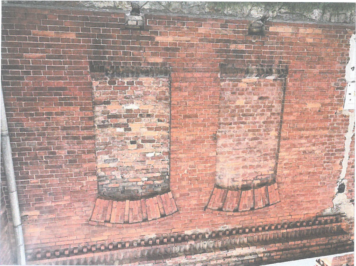
przemianowania wątku w obrębie okien na elewacji zachodniej oraz okienek elewacji wschodniej a także partii wokół okienek w strefie partiu; zabrudzenie wątków kamiennych; uszkodzenia ozdoby dekoracyjnych gzymsów ceglanych w wyniku uszkodzeń obróbek blacharskich pod dachem; zamurowanie okien na elewacji zachodniej; szpeczące zaprawy naprawcze w miejscach przeciek pod instalację
