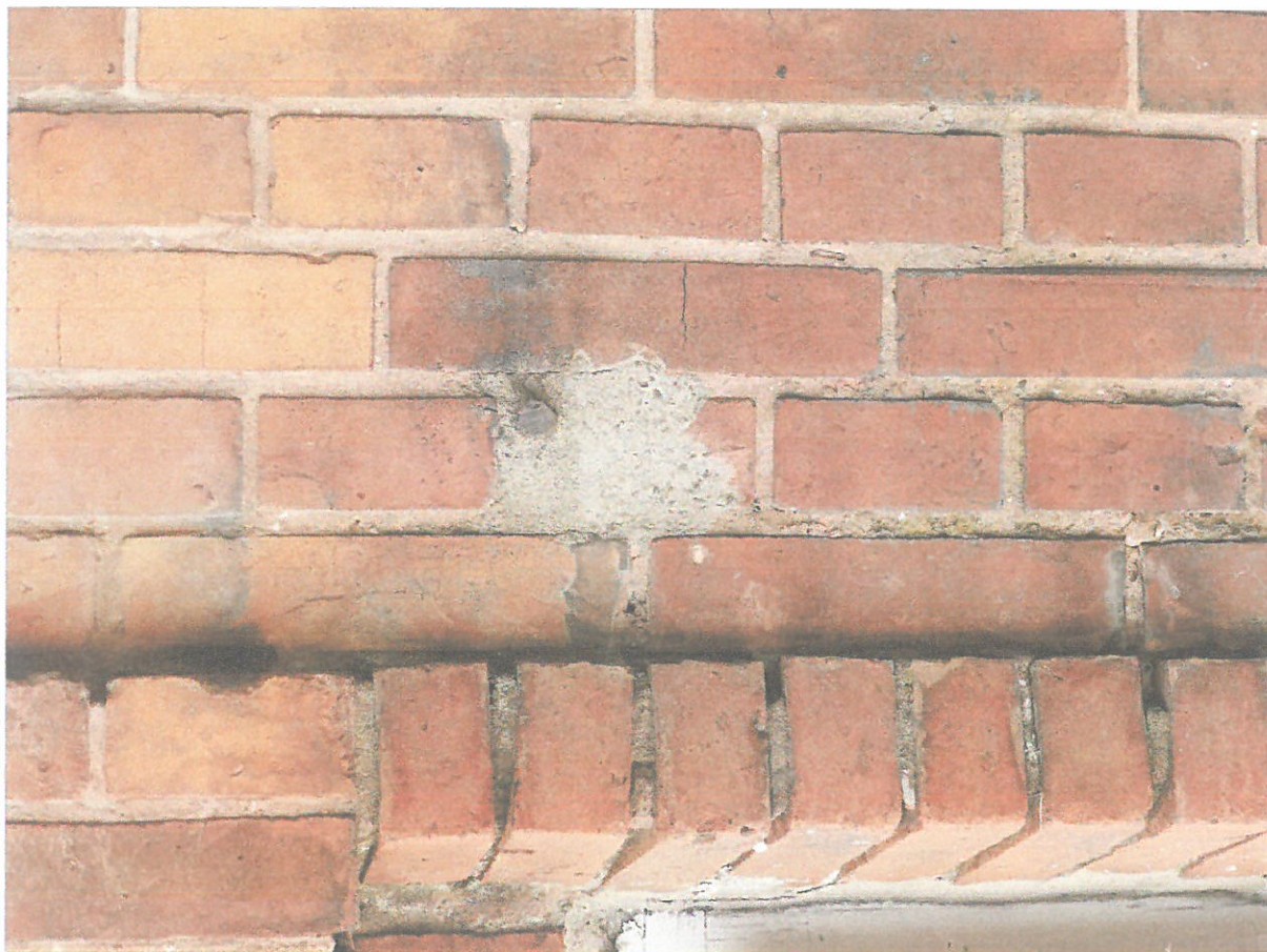
sposób opracowania spoinowania wątków oraz ubytki cegieł wypełnione zaprawami z cementem portlandzkim
