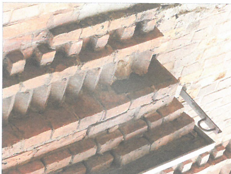
zaprawy naprawcze w obrębie partii gzymsów okiennych – szare i białe, lokalnie widoczne spękania wątków uszkodzenia cegieł ozdoby gzymsu
