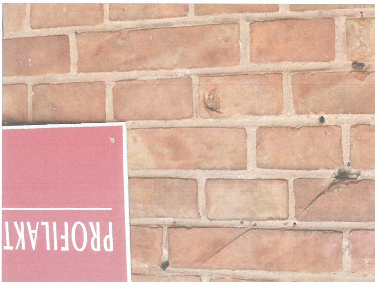
sposób opracowania spoinowania wątków oraz ubytki cegieł wypełnione zaprawami z cementem portlandzkim
