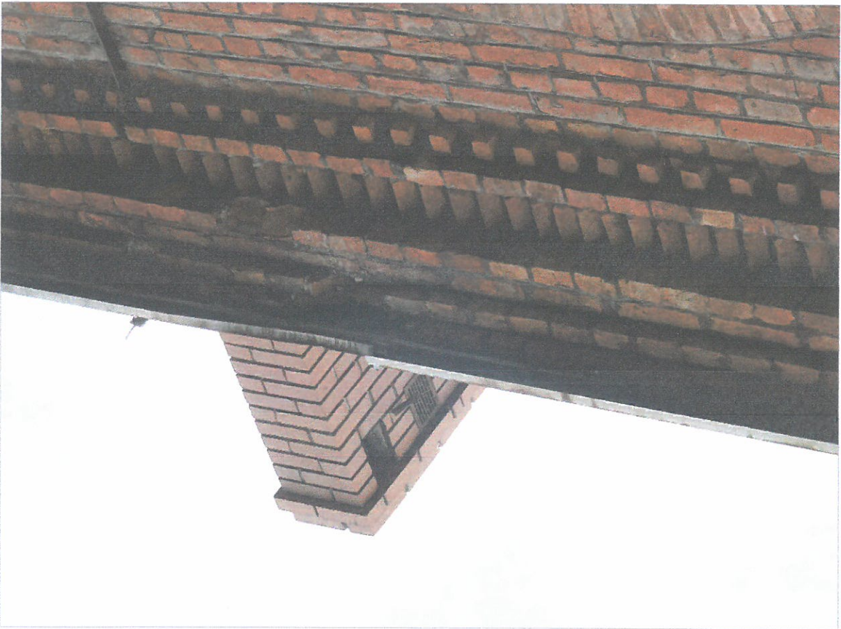
Partie gzymsu naprawiano. Uzupełniano braki nowymi cegłami (lokalnie), jak również zastosowano szare spoiny.
