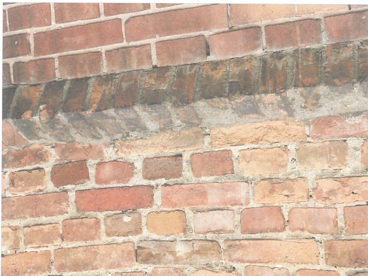
oryginalna spoina oraz w różnych partiach elewacji (dobudowanych) przekształcenia i uzupełnienia spoin, wymieniane cegły w parti cokołu
