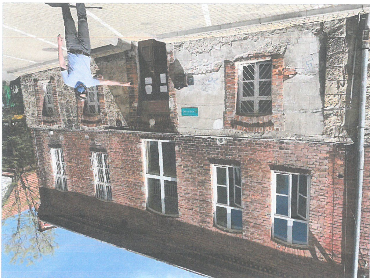
rozróżnicowanie kształtów i kolorystyki cegieł – znaczne ubytki wielu parti niezabezpieczonych przed namakaniem zniszczenie tynek imitujących wątek kamienny w parti elewacji wschodniej od strony północnej
