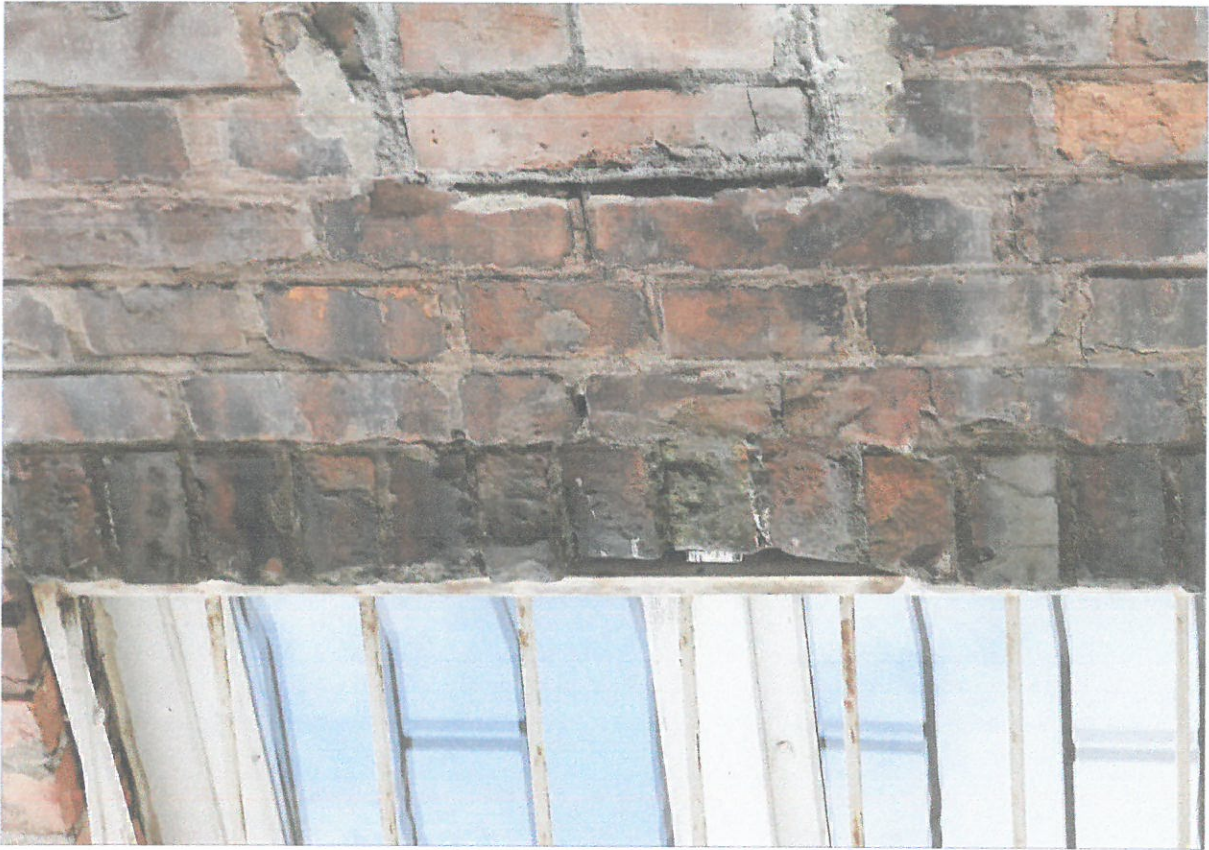
uszkodzenia ceglanego gzymsu pod dachem, zniszczona blacharka; przypadkowe przemurowania cegiel, braki ceglanego parapetu
