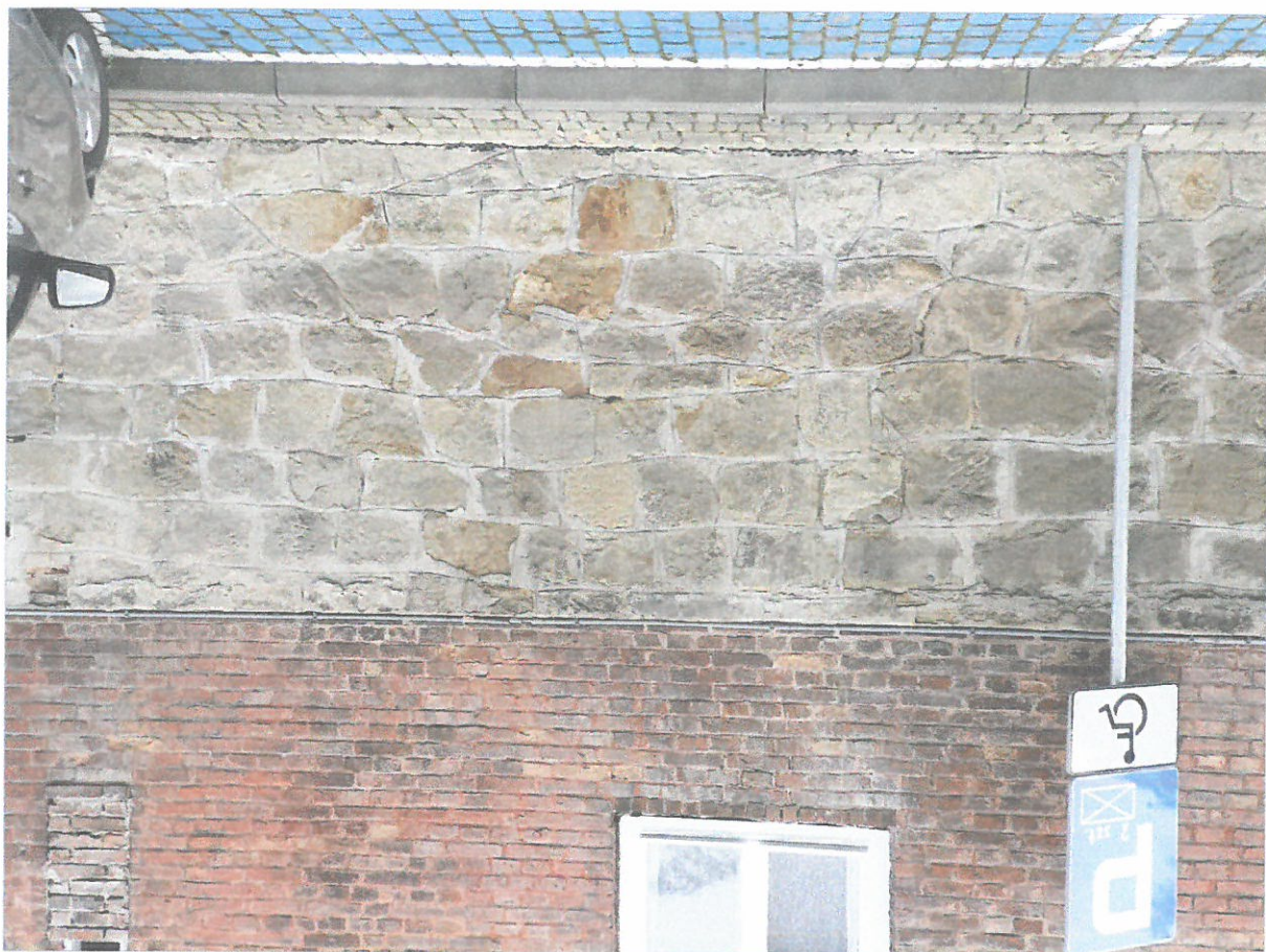
zniszczenia i ciemne zabrudzenia wątków; uszkodzenia cegiel i kamienia; przemurowania wokół wątków ceglanych i kamiennych
