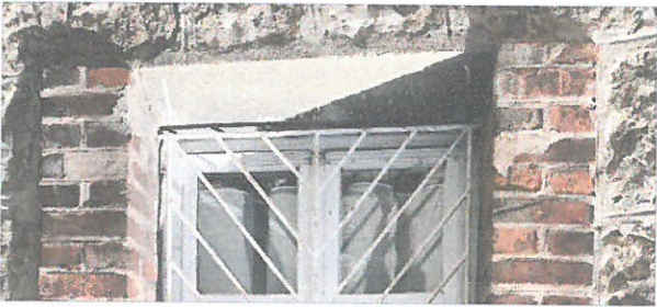
braki i zróżnicowane parapety na elewacji wschodniej
