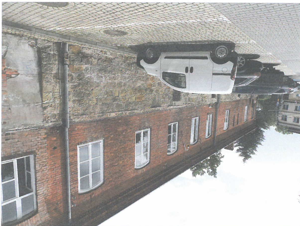
przekształcenia elewacji wschodniej tylniej do 9. osi cokół kamienny dalej kamień zasigpiono tynkiem z imitacją podziałów kamieniarki; widoczna także różnica w kolorystyce cegieł
