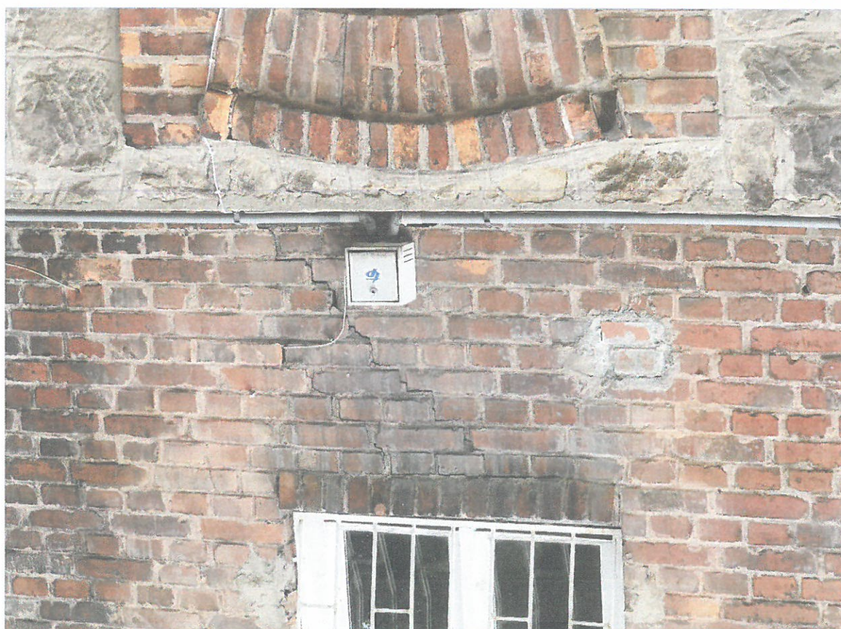
uszkodzenia ceglanoego gzymsu pod dachem, zniszczona blacharka; zróżnicowane kraty w oknach jak również parapety
