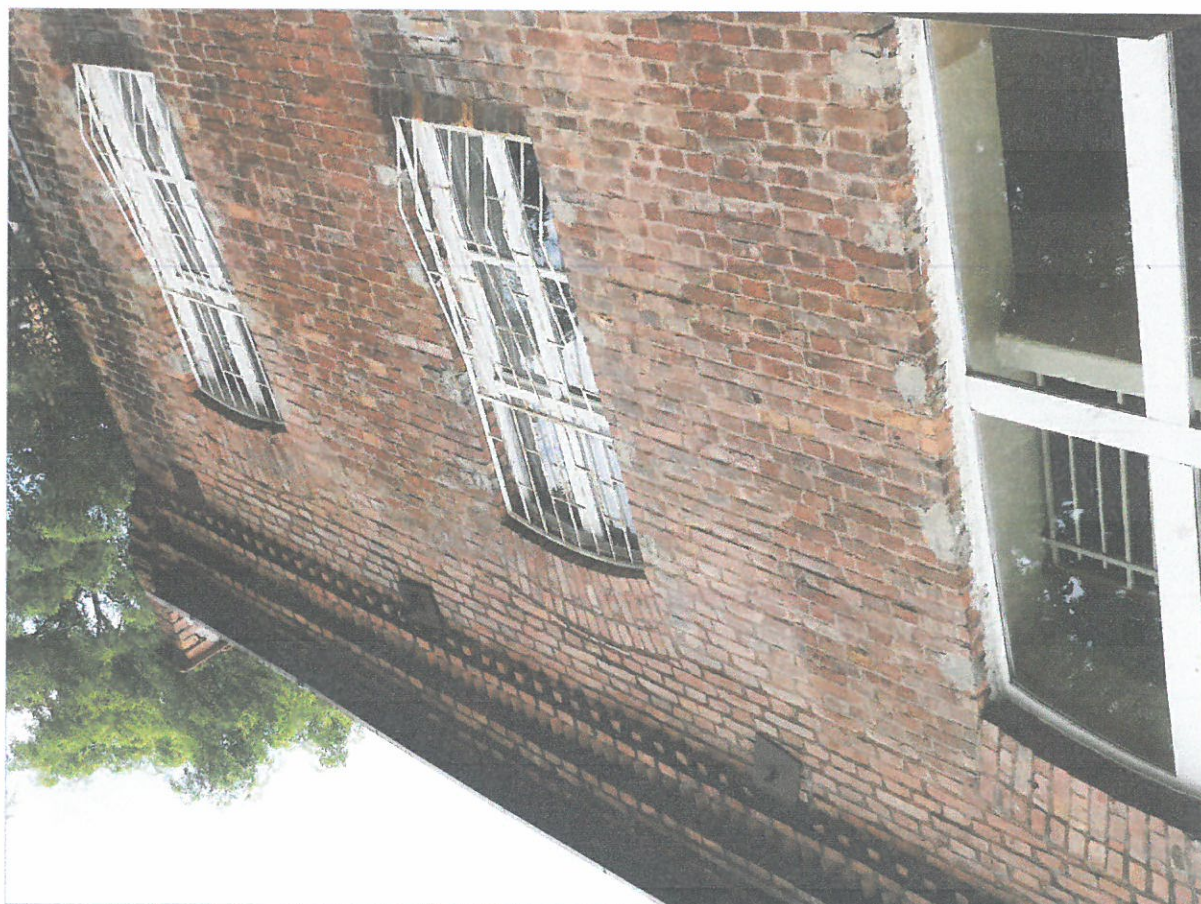
uszkodzenia wników spowodowane przekształceniami związanymi z nią z wyniszczeniem okien demontażem kral, skrzynek technicznych, przemurowanie i brak opracowania spoinowania, liczne zaprawy naprawcze, przypadkowo wstawione cegły
