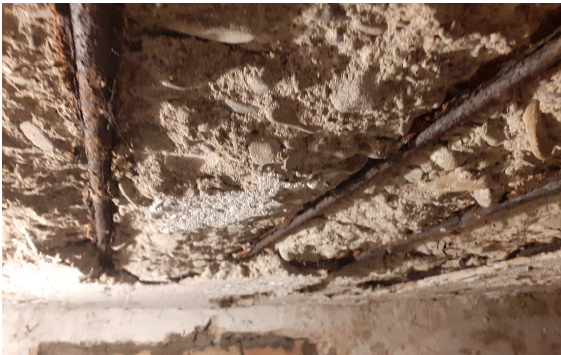
Zdjęcie nr 4 - przedstawia przerdzewiałe i osłonięte pręty konstrukcyjne stropu piwnicy w części dobudowywanej
