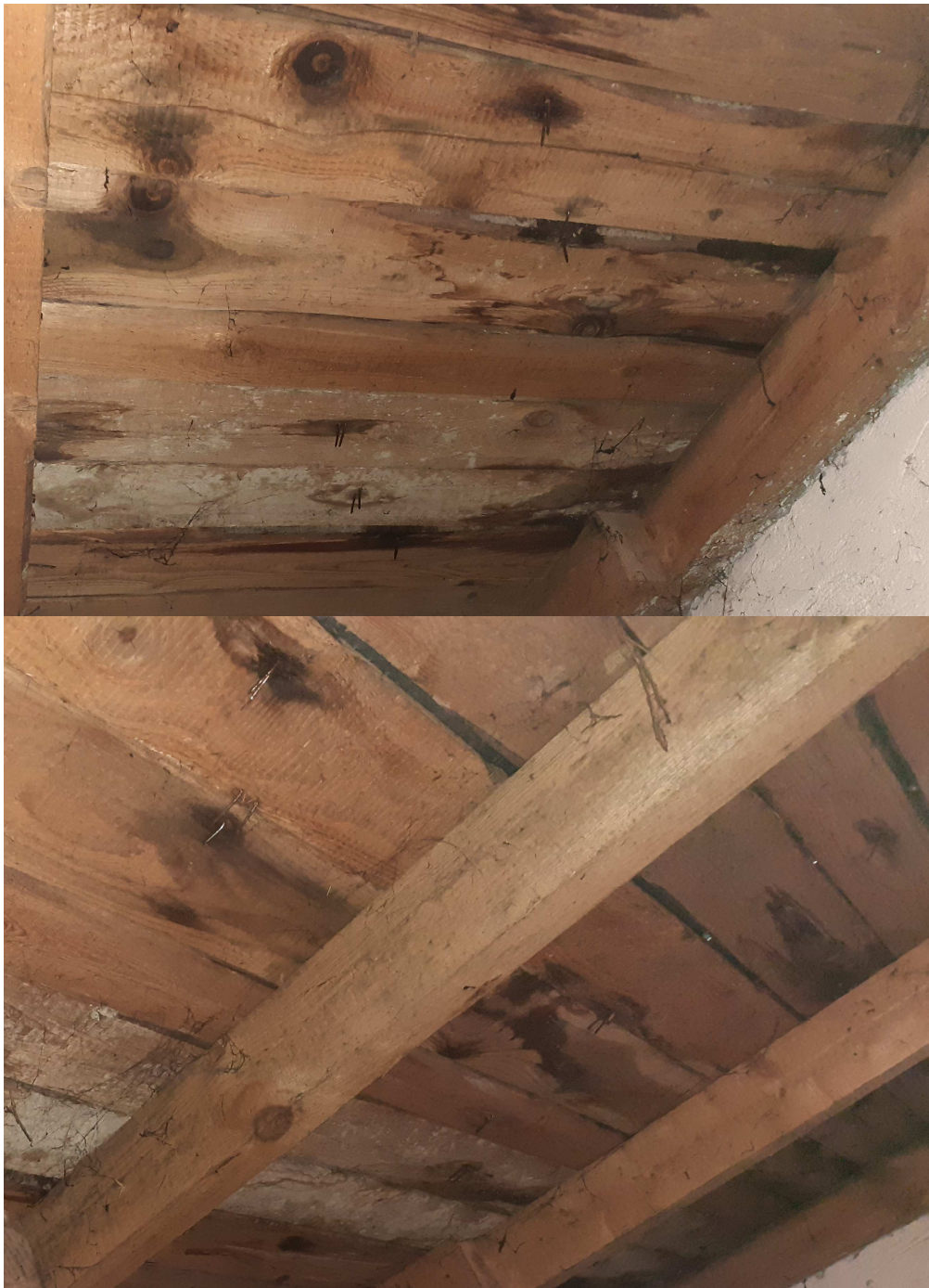
Zdjęcie 9 i 10 - przedstawia zawilgocenia spowodowane nie szczelnością poszycia
