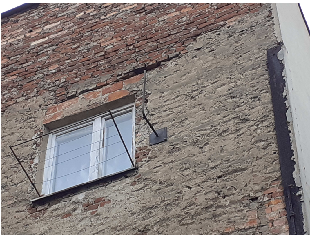
Zdjęcie 8 - przedstawia ubytki w ścianie od strony podwórka.
