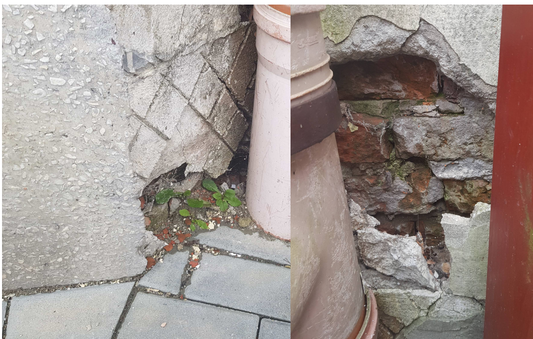
Zdjęcie 5 - przedstawia odspojony tynk na cokole budynku
