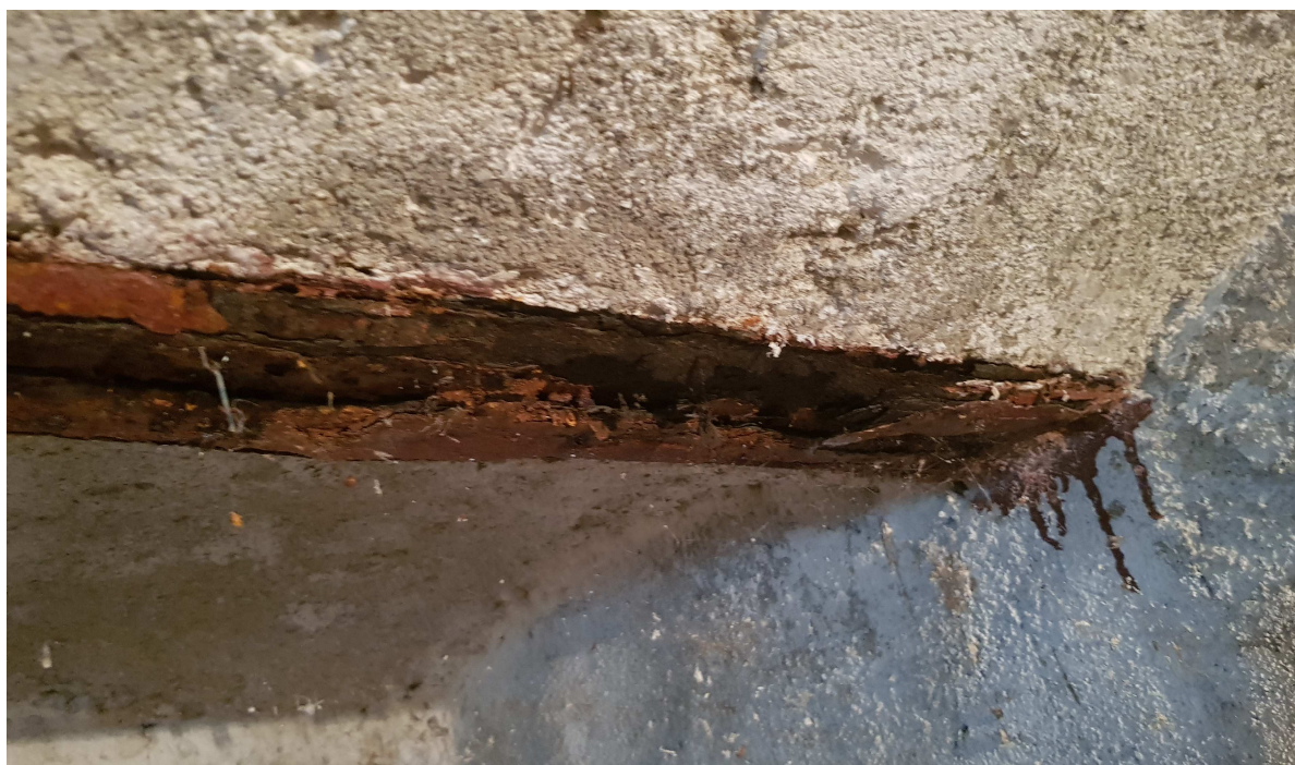
Zdjęcie nr 3 - przedstawia przerdzewiałe i rozwarstwiające się stopki dwuteowników w stropie nad piwnicą
