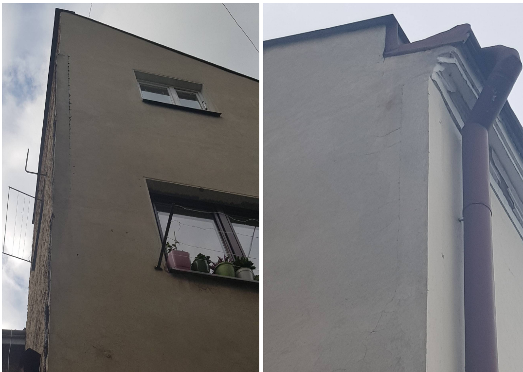
Zdjęcie 7 - przedstawia rysy w ścianie od strony wschodniej oraz wzmocnienie ściany za pomocą kątownika stalowego.
