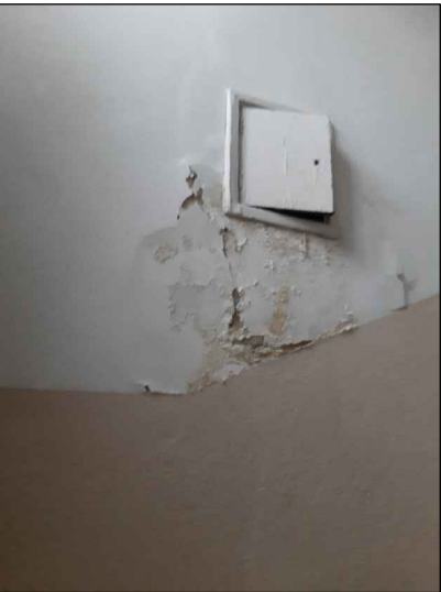
Kanał z zaworem odpowietrzającym na klatce schodowej do likwidacji. Osuszenie ściany.
