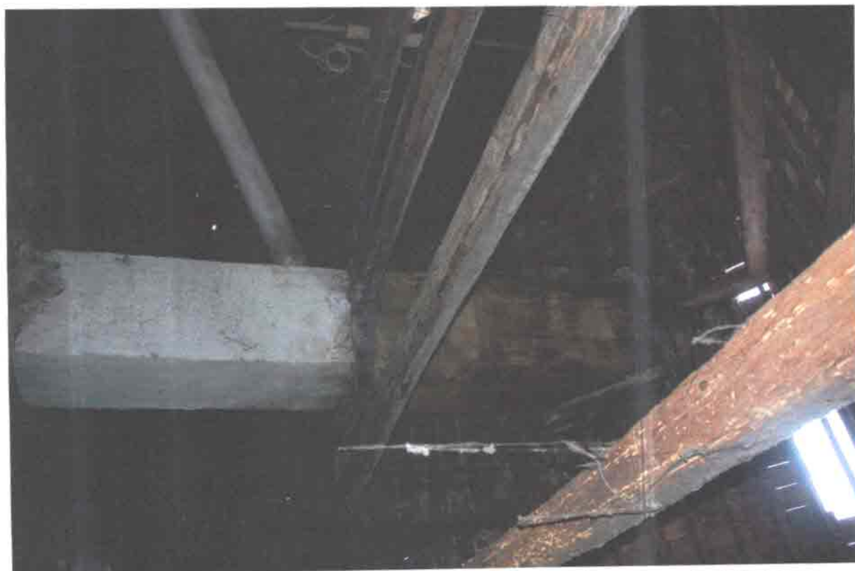
fot. 3. Widoczne elementy więźby dachowej. Powierzchniowo porażone przez szkodniki drewna. Stan dobry.
