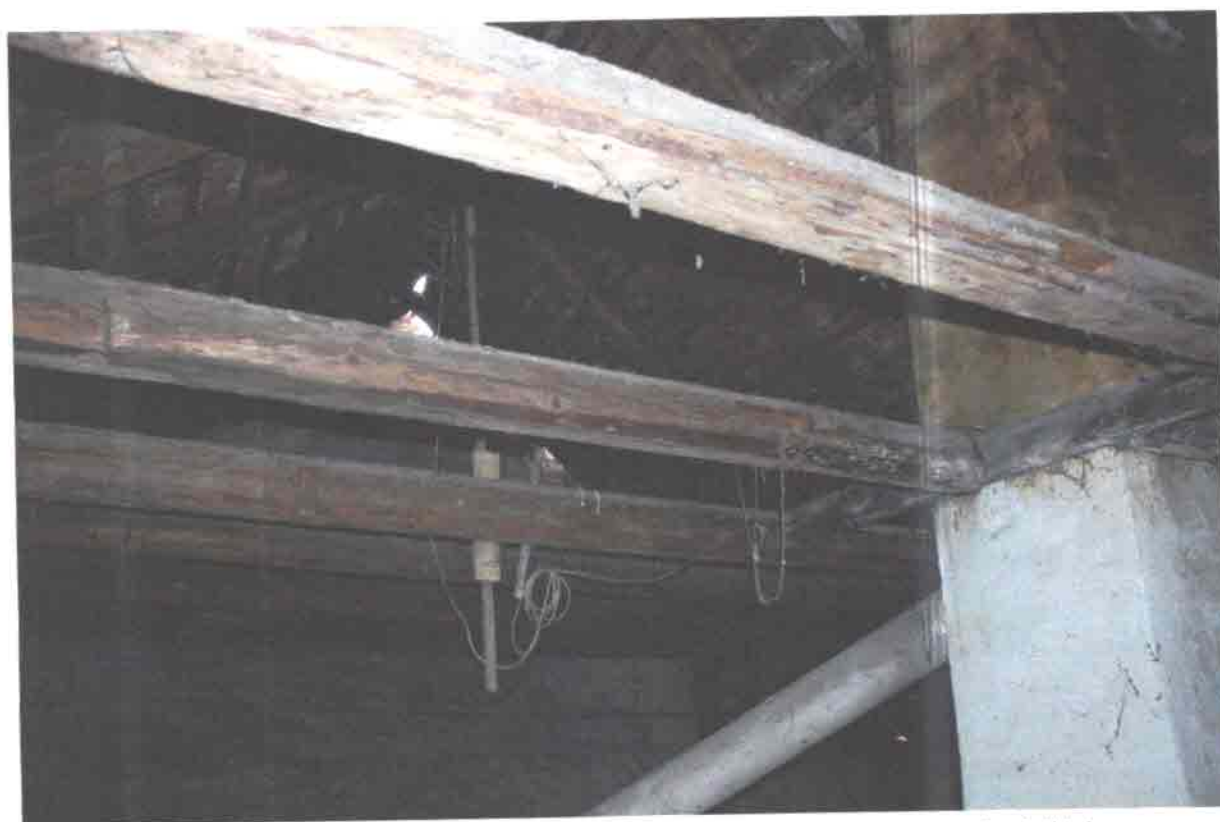
fot.4. Widoczne elementy więźby dachowej. Powierzchniowo porażone przez szkodniki drewna. Stan dobry
