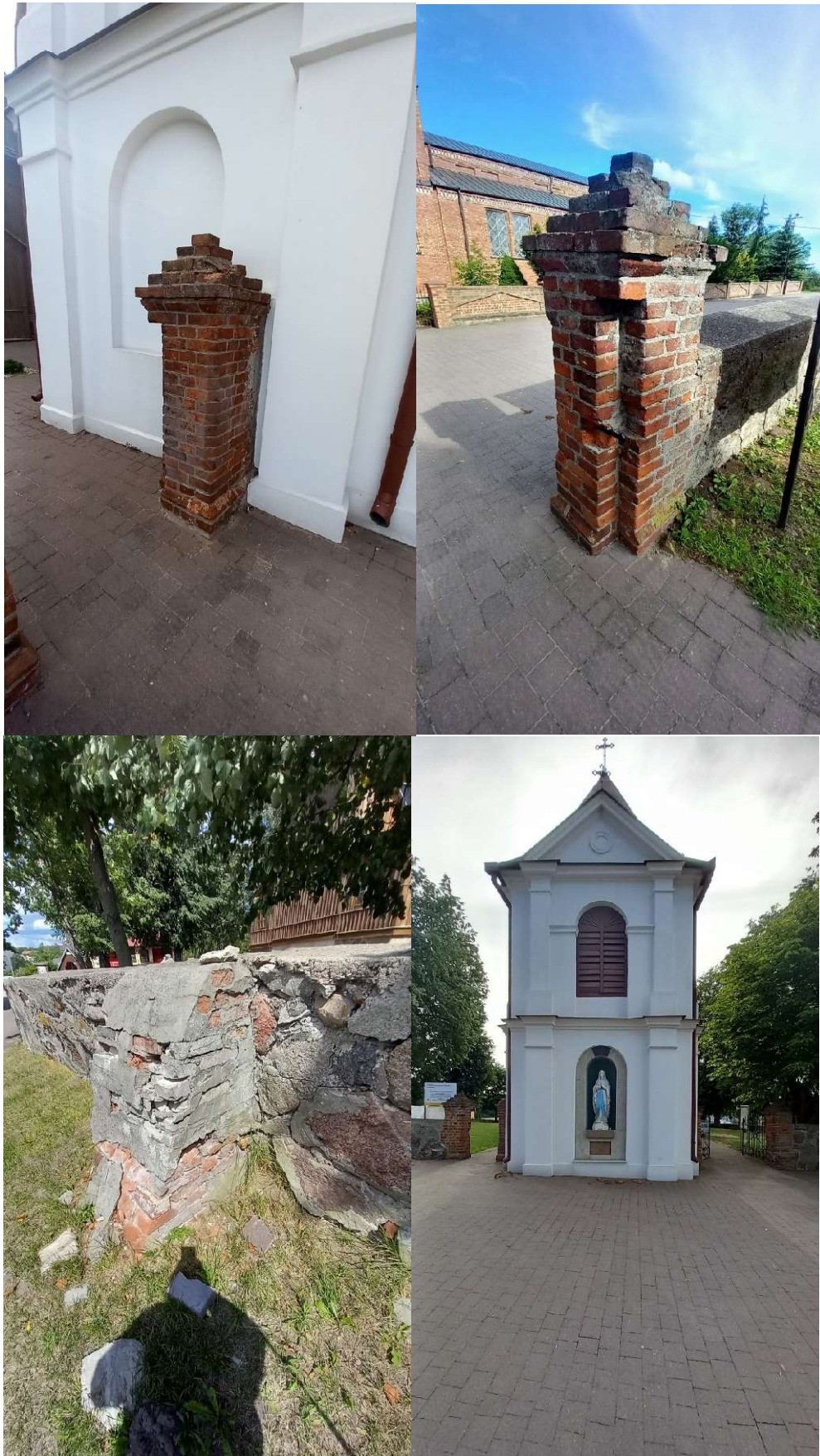
Fot. Słupki bramowe do remontu, przypora do przemurowania, furtka do uzupełnienia
