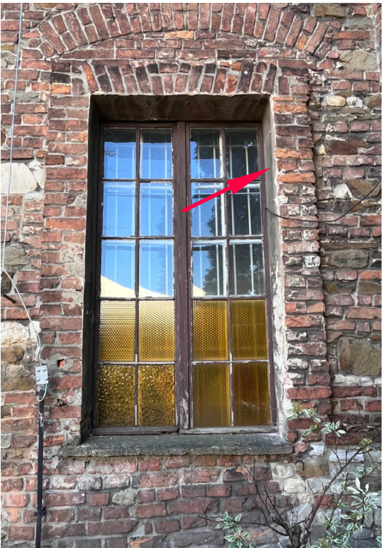
Ryc. 3 Przykładowe okno przeznaczone do wymiany; wyprawy tynkarskie przeznaczone do usunięcia
