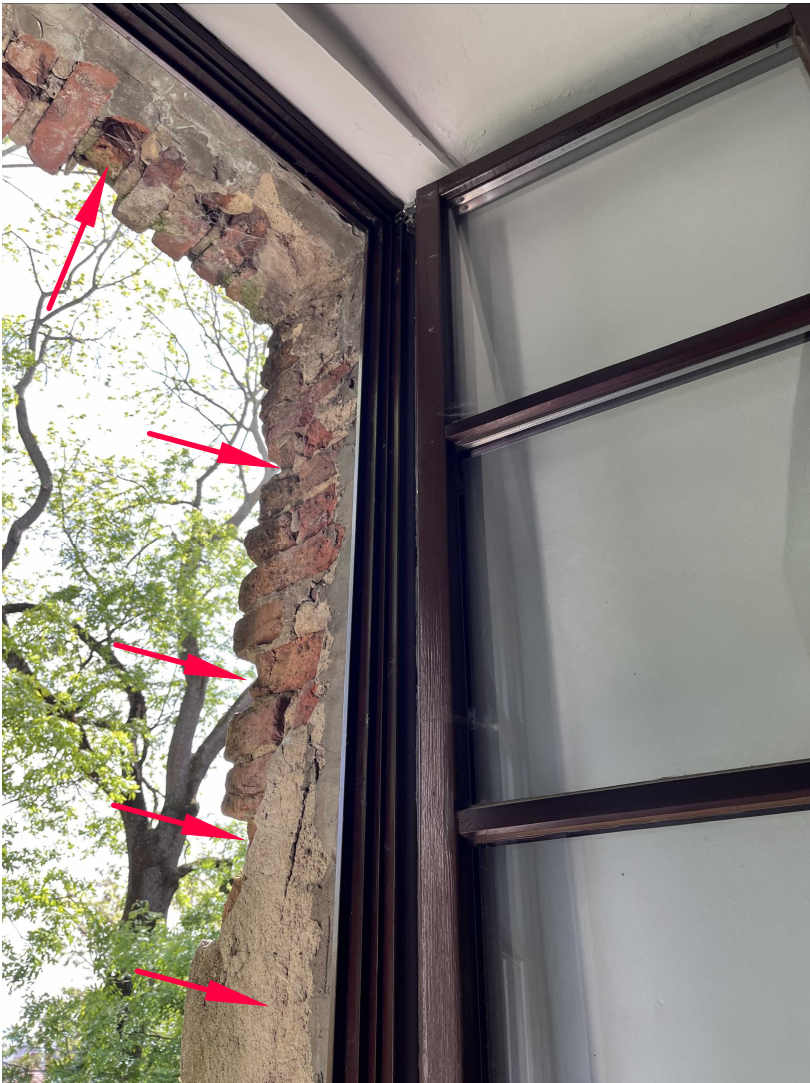
Ryc. 4 Wnęka okienna z uszkodzonym nadprożem, ubytkami cegieł, oraz wyprawą tynkarską do usunięcia.
