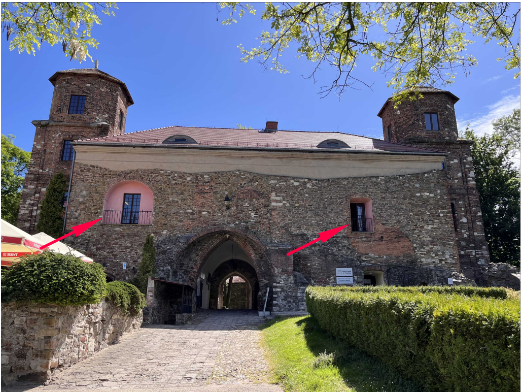
Ryc. 2 Elewacja budynku od strony zachodniej, wymiana balustrad i zmiana kolorystki tynku w obrębie loggi.
