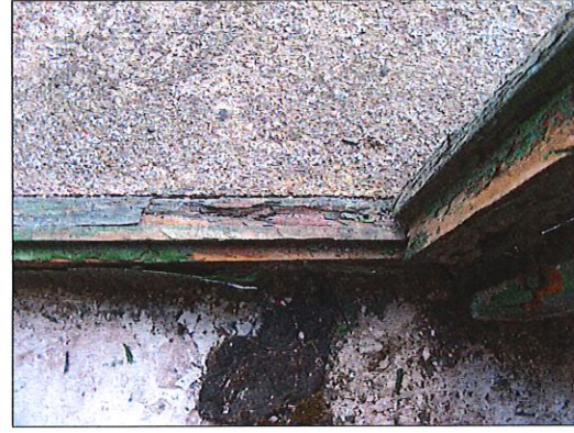
STAN TECHNICZNY: NADPROŻE, OKAPNIK, PRÓG OŚCIEŻNICY, SKRZYDŁO I POZIOMA SZCZEBLINA
