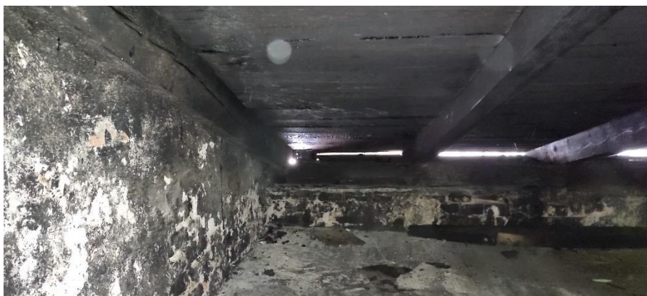
Rys 32. Zwęglone krokiewy przy ścianie szczytowej wschodniej – pomieszczenie 2.4
