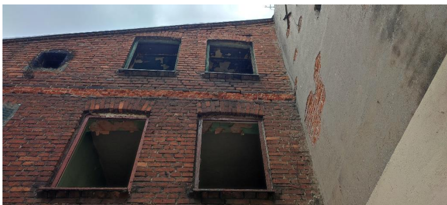
Rys 6. Elewacja wschodnia – źle obsadzone nadproża murowane łukowe
