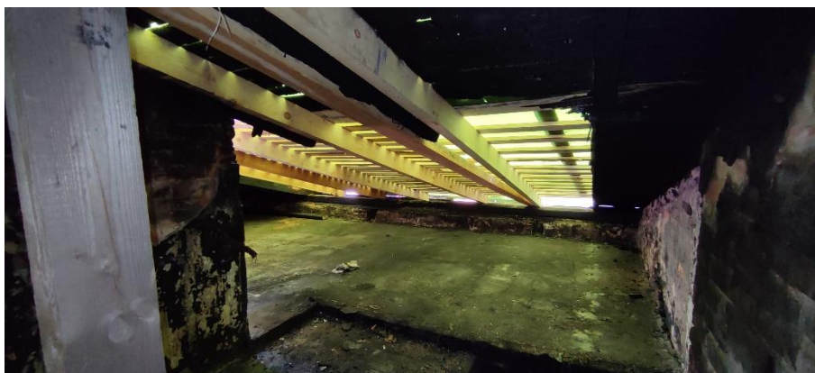
Rys 34. Nowa, tymczasowa więźba dachowa
