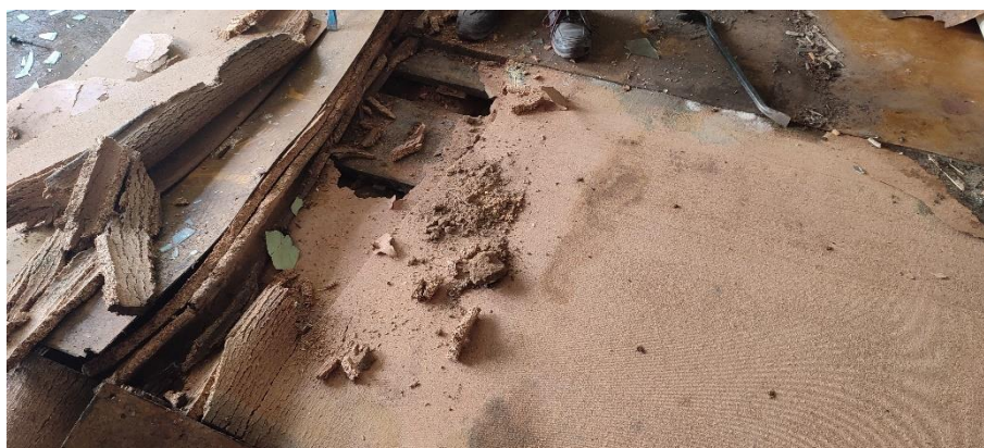
Rys 17. Rozmiękczone warstwy podłogowe w stropie nad parterem (pomieszczenie 1.6)
