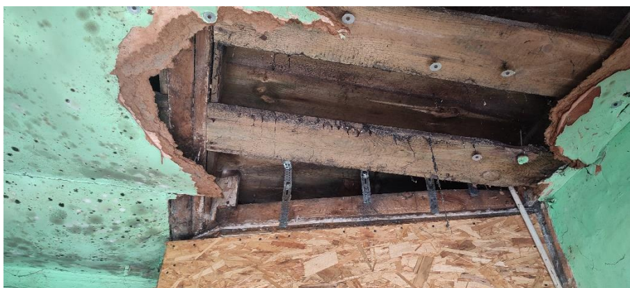
Rys 10. Warstwy sufitu w stropie nad parterem w części środkowej budynku
