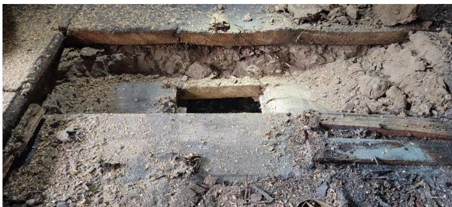
Rys 29. Odkrywka S-1 w stropie nad parterem
