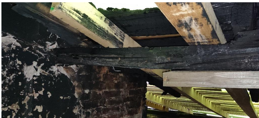
Rys 33. Uszkodzenia płatwi pośredniej więźby dachowej w korytarzu
