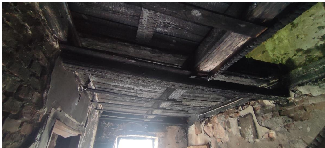
Rys 14. Układ belek stropowych w korytarzu nad piętrem
