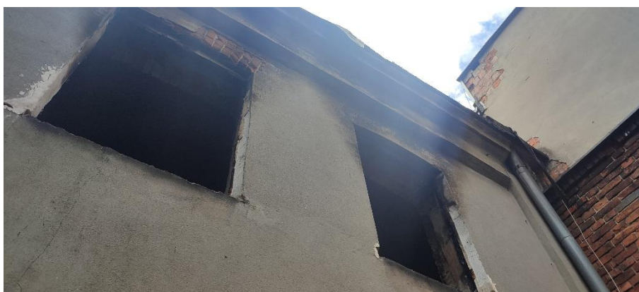
Rys 4. Elewacja południowa – pomieszczenie na piętrze objęte pożarem
