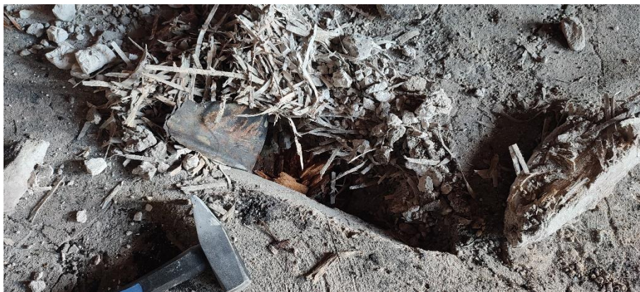
Rys 30. Odkrywka ST-3 w stropie nad piętrem
