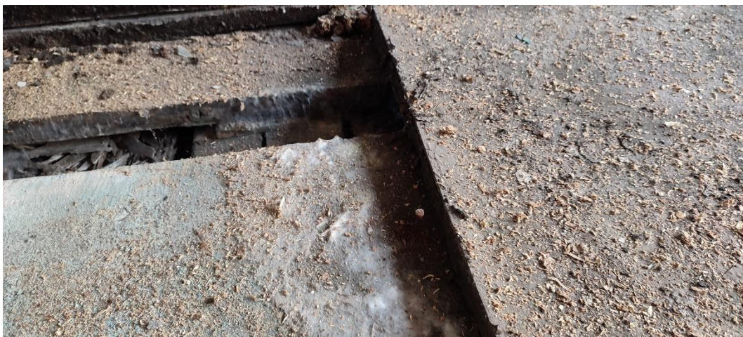
Rys 28. Grzyby pleśnie na deskowaniu w warstwach stropowych nad piętrem – pomieszczenie 2.3
