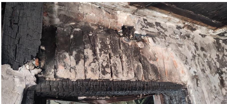
Rys 22. Ubytki zaprawy w nadprożu i ścianie na piętrze
