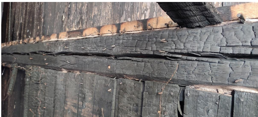
Rys 27. Zwęglenie i uszkodzenie belki stropowej wewnątrz pęknięcia skurczowego
