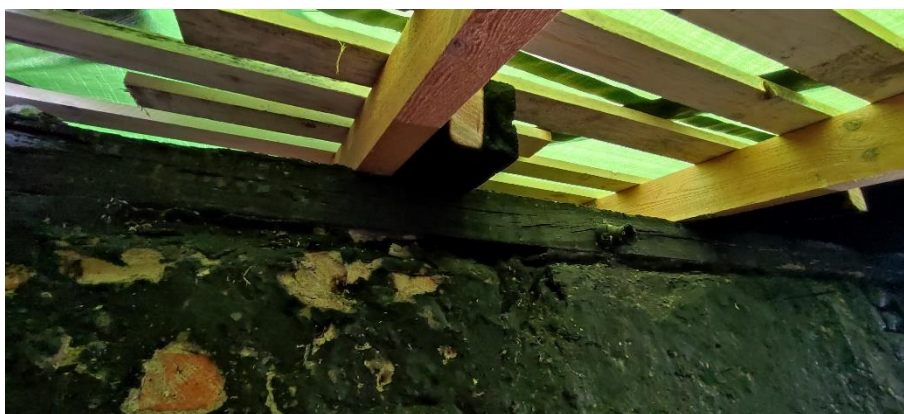
Rys 35. Oparcie starych i nowych krokwi na ścianie wewnętrznej w cz. wschodniej budynku
