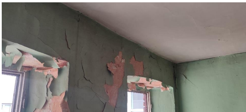
Rys 22. Ubytki tynku w pomieszczeniu 1.6
