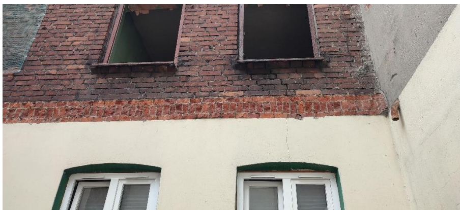
Rys 5. Elewacja wschodnia – skucie gzymsów nad parterem
