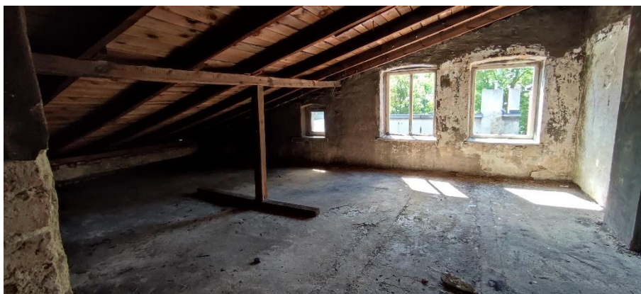
Rys 36. Więźba dachowa w części zachodniej – konstrukcja wyłączona z naprawy
