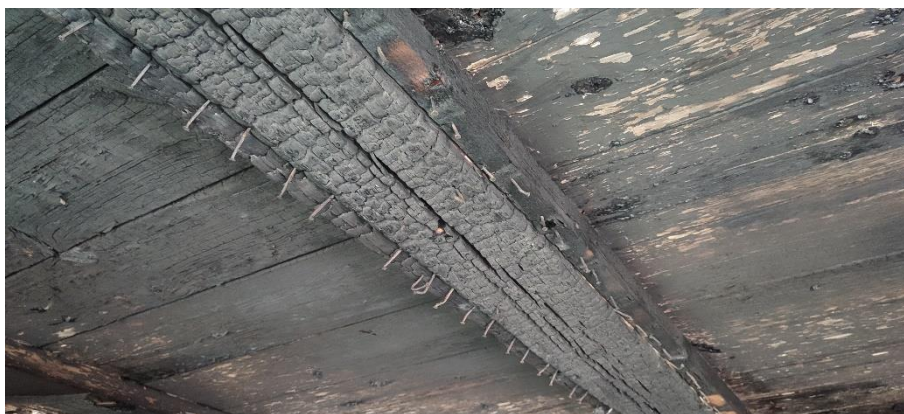
Rys 26. Belka stropowa nad piętrem wraz z łącznikami do podsufitki
