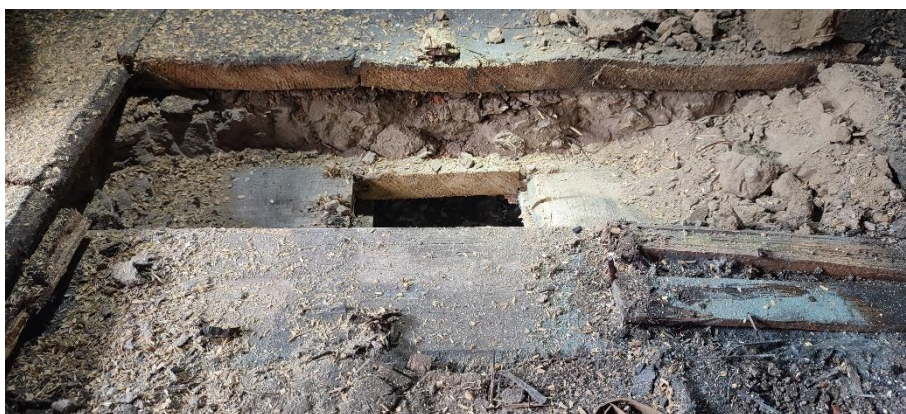
Rys 23. Okrywka S-1 w stropie nad parterem
