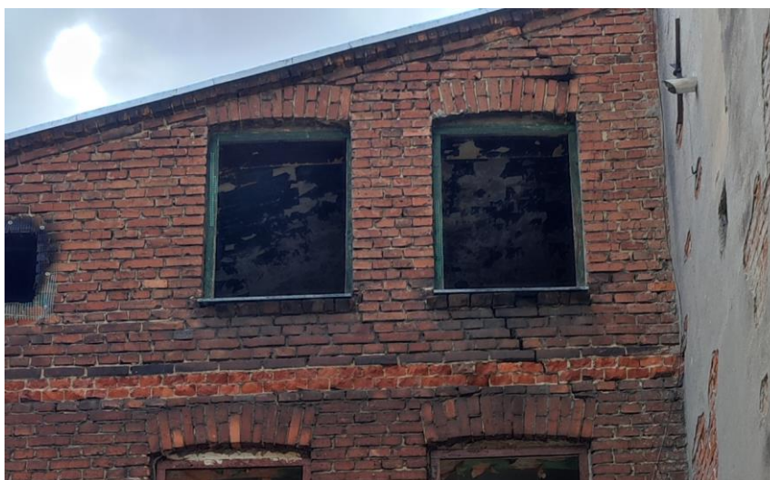
Rys 23. Pęknięcia w murze ściany szczytowej wschodniej
