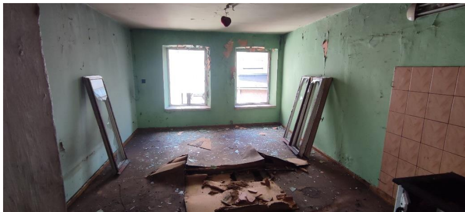
Rys 16. Widok na pomieszczenie 1.6 – uszkodzenia i odpryski tynku
