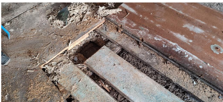
Rys 29. Odkrywka ST-2 w stropie nad piętrem
