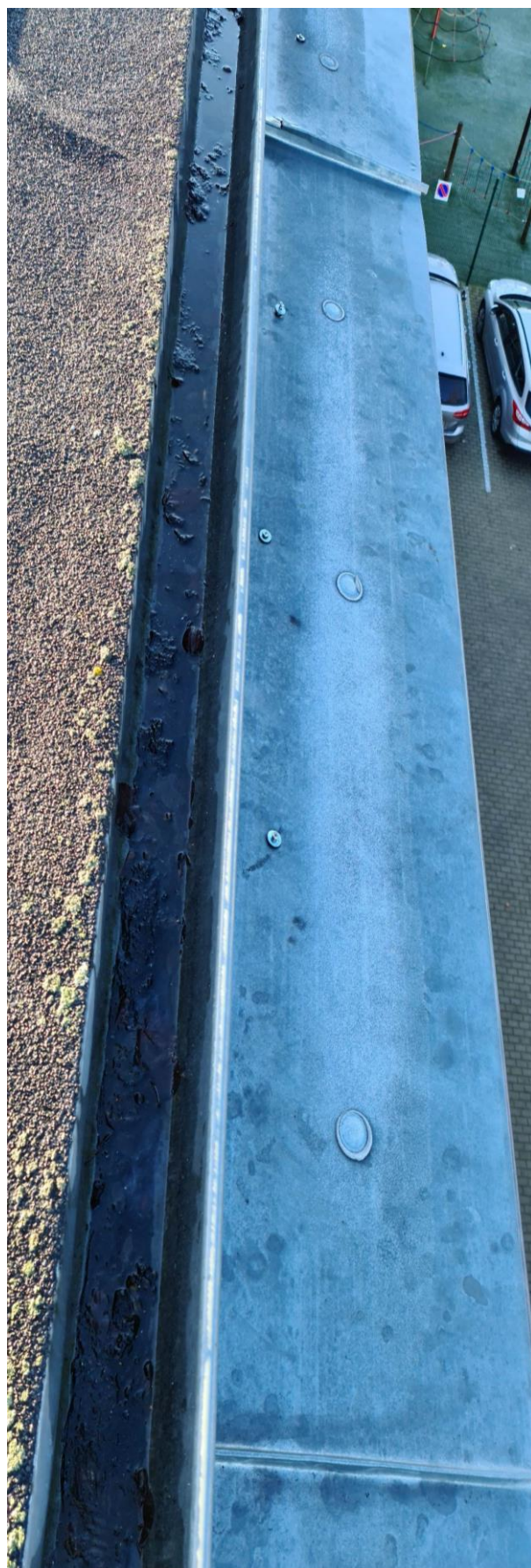
NIEPRAWIDŁOWE MOCOWANIA OBRÓBEK GZYMSÓW
