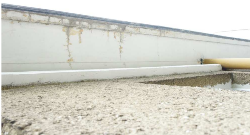
Fot. 2 Zawilgocenie krawędzi gzymsu.
