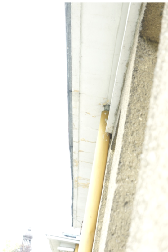
Fot. 3. Nieprawidłowe podłączenie rury spustowej.
