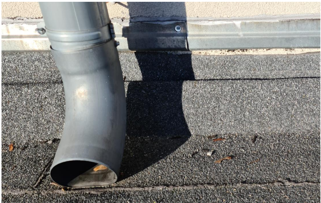
SPŁASZCZONE KOLANO RURY SPUSTOWEJ OPIERAJĄCE SIĘ O PAPĘ
