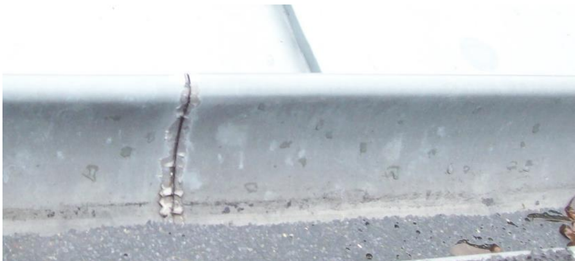
PĘKNIĘCIA W MIEJSCU LUTOWAŃ
