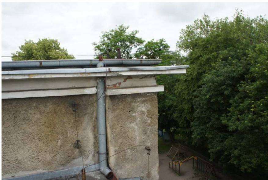
Fot. 9. Zawilgocenie ściany poniżej gzymsu.
