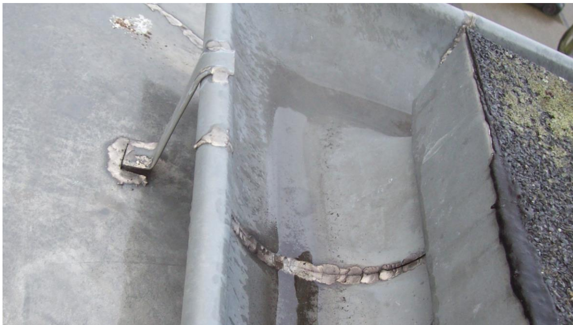
PEKNIĘCIA W MIEJSCU LUTOWAŃ. WSPORNIK ZASTOSOWANY NIEZGODNIE Z TECHNOLOGIĄ
