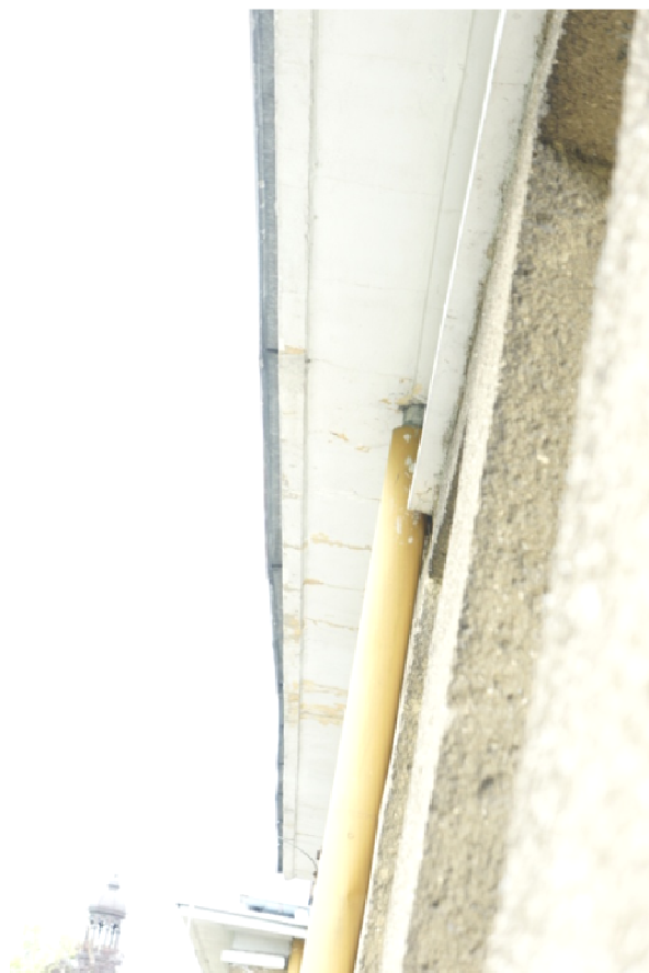
Fot. 3. Nieprawidłowe podłączenie rury spustowej.
