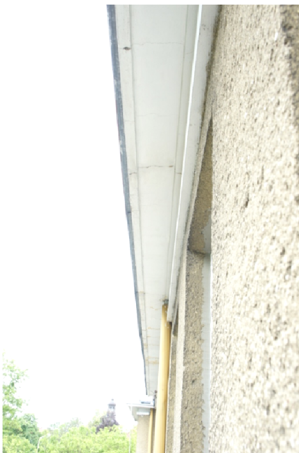
Fot. 1. Rysy na łączeniach elementów prefabrykowanych.
