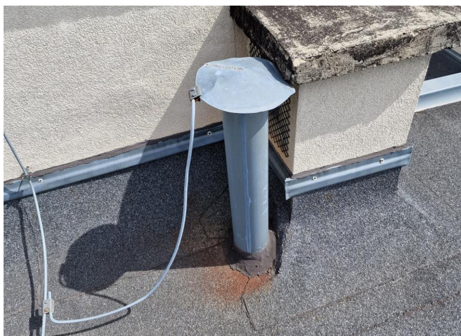
WADLIWE PODŁĄCZENIE UZIOMU DO KOMINKÓW BLASZANYCH
