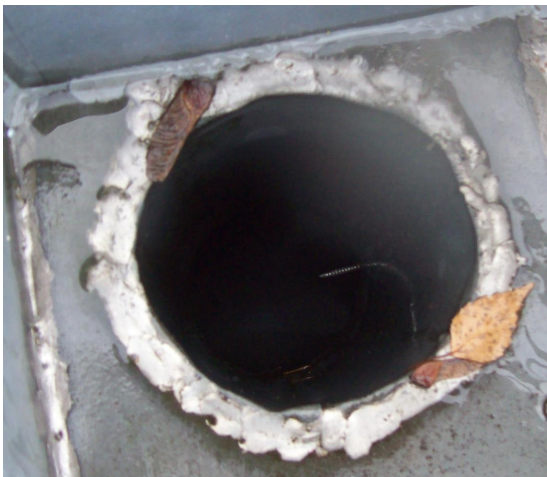
PRZEBICIE RURY SPUSTOWEJ BLACHOWKRĘTEM
