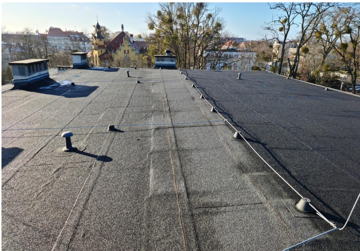
POWIERZCHNIA DACHU O PŁASZCZYNIE Z USKOKAMI , NIERÓWNOŚCIAMI I ZAPADLISKAMI WYSTĘPUJE ODSPAJANIE SIĘ POPY OD PODŁOŻA
