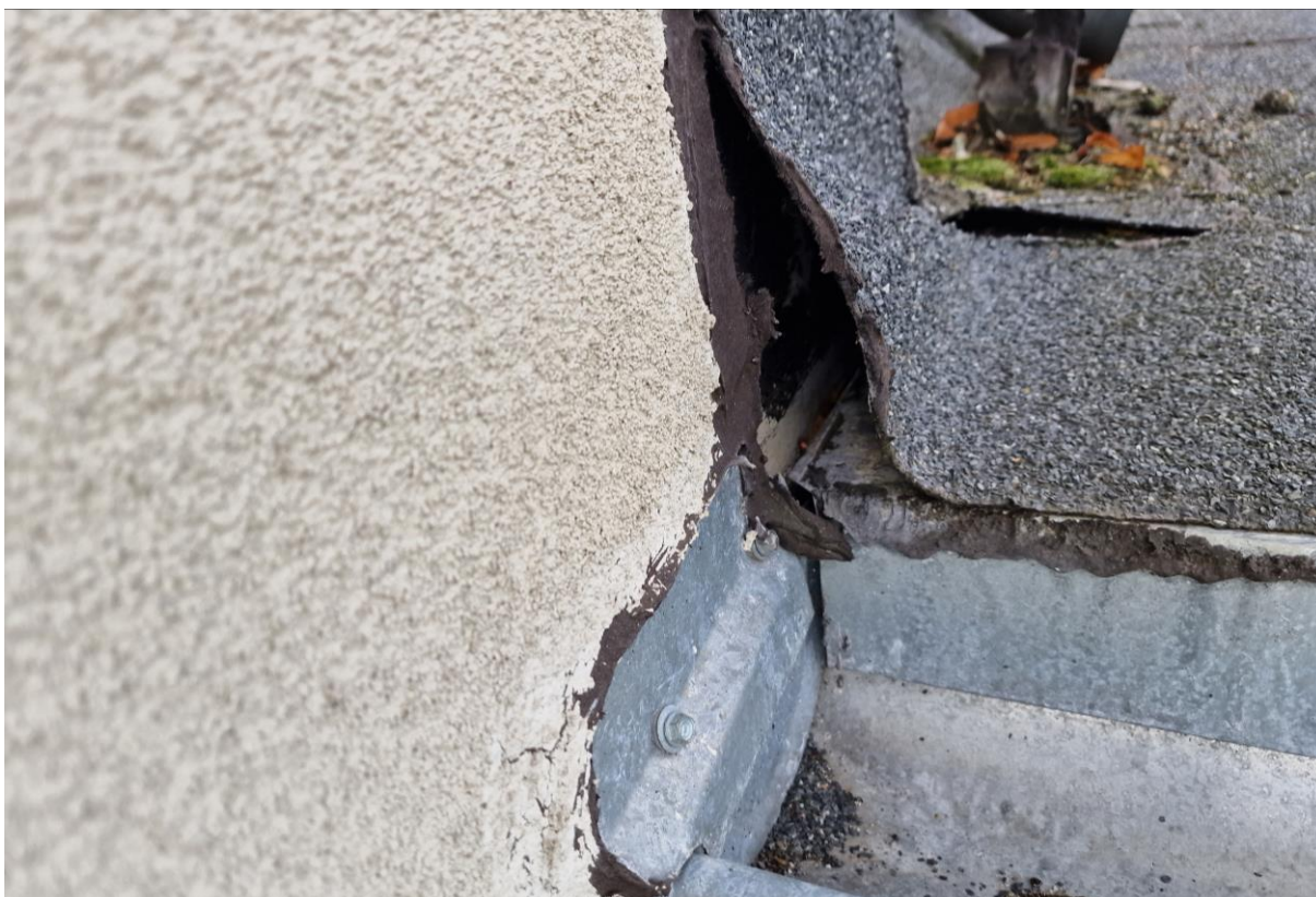
WADY WYKONAWCZE NIEDOKŁADNOŚCI I WADLIWEGO WYKONANIA OBRÓBEK Z PAPY ORAZ KLEJENIA PAPY DO PODŁOŻA
