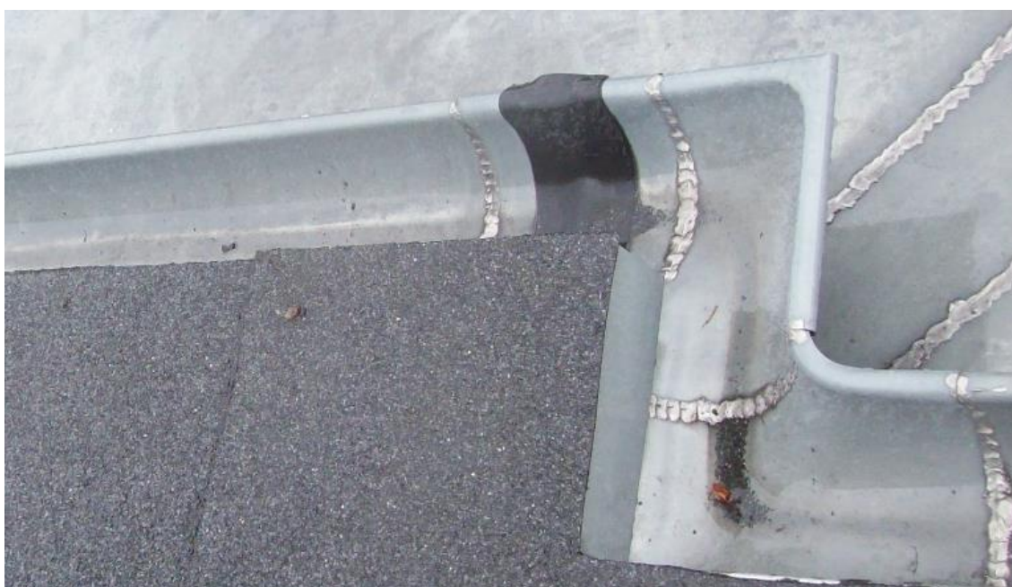
SKLEJANIE LUB USZCZELNIANIE PASKAMI BITUMICZNYMI
