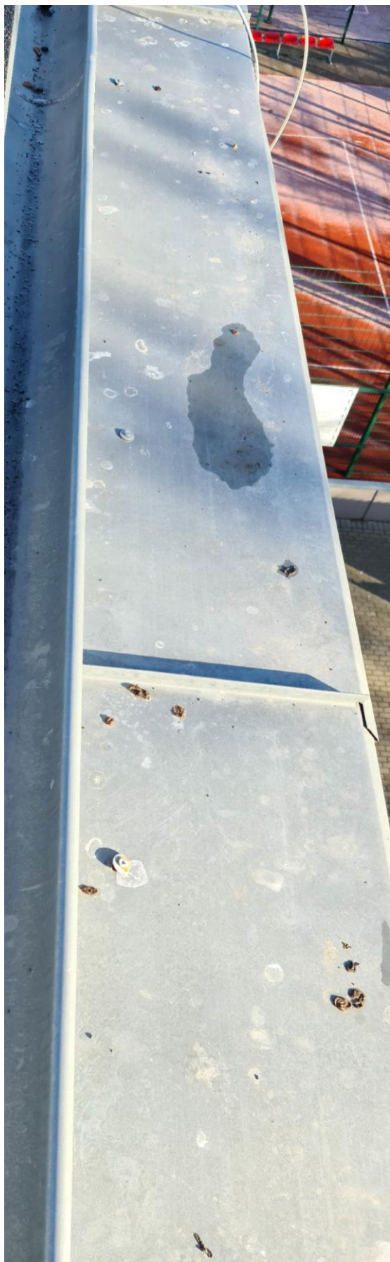
NIEPRAWIDŁOWE MOCOWANIA OBRÓBEK GZYMSÓW
