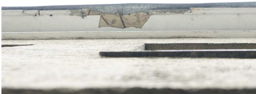
Fot. 5. Zniszczony fragment gzymsu.
