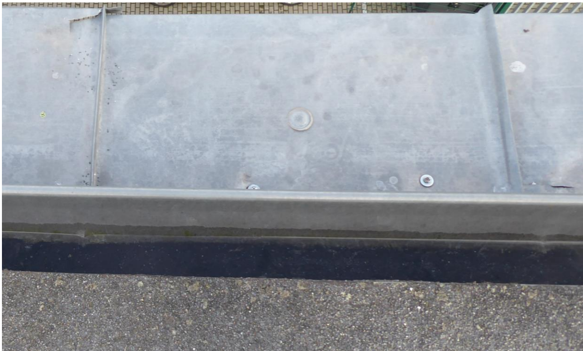
BRAK DYŁATACJI GZYMSÓW POWODUJE ROZSZCZELNIENIE SIĘ ŁĄCZEŃ BLACH I ROZERWANIA BLACHY
