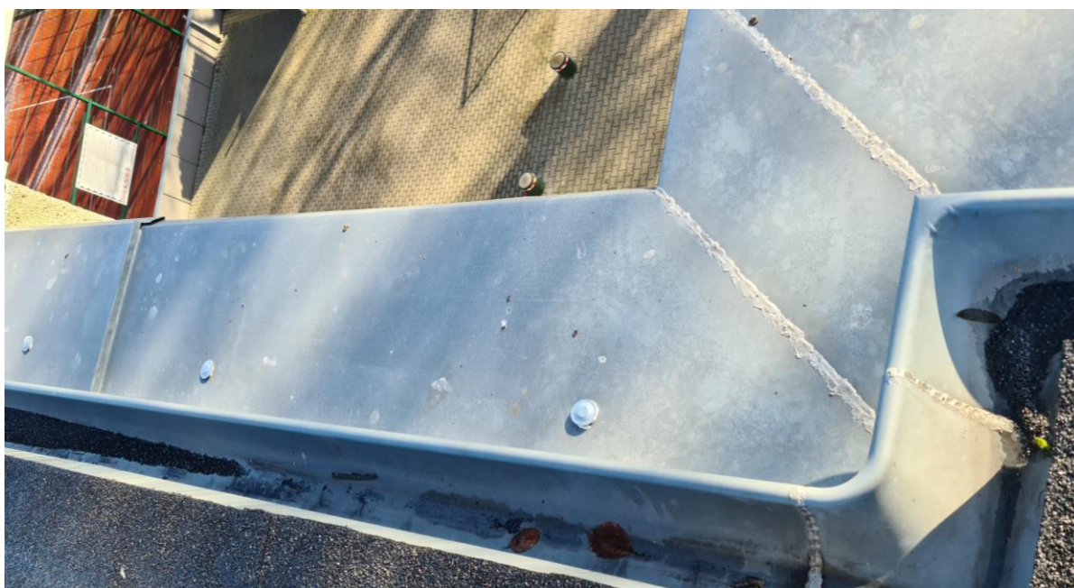
LUTOWANIE ORÓBKI GZYMSU ZAMIAST MONTAŻU NA RĄBEK STOJĄCY
