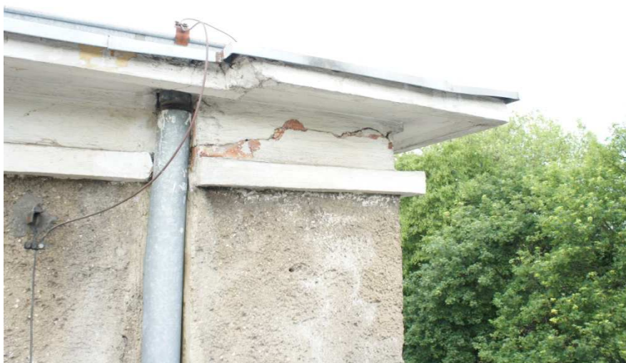
Fot. 7. Ubytki gzymsu oraz pęknięcia tynku na ścianie.
