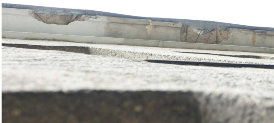
Fot. 6. Zniszczony fragment gzymsu.
