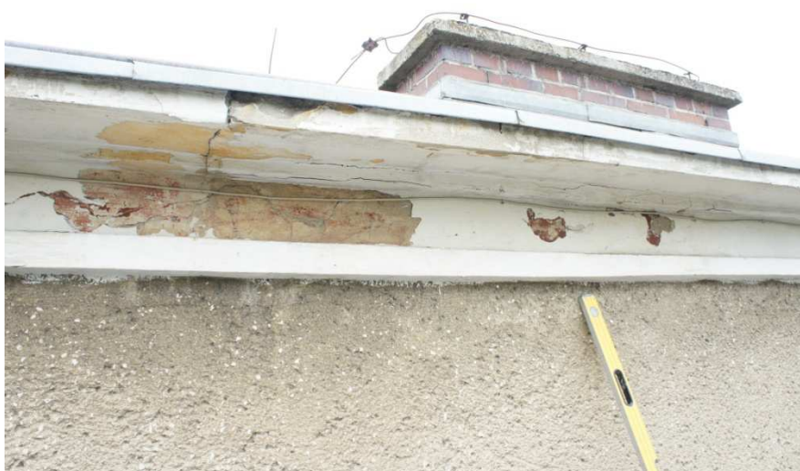
Fot. 8. Rysy, ubytki oraz zawilgocenie gzymsu i ściany.
