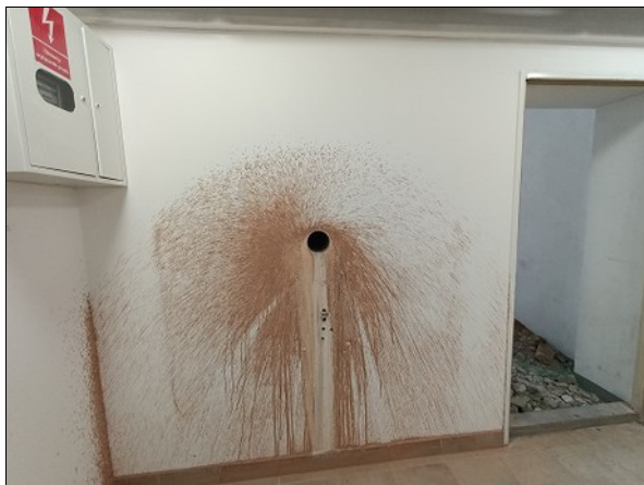
Fot. 4 Widok odwiertu dla sprawdzenia grubości ściany.
