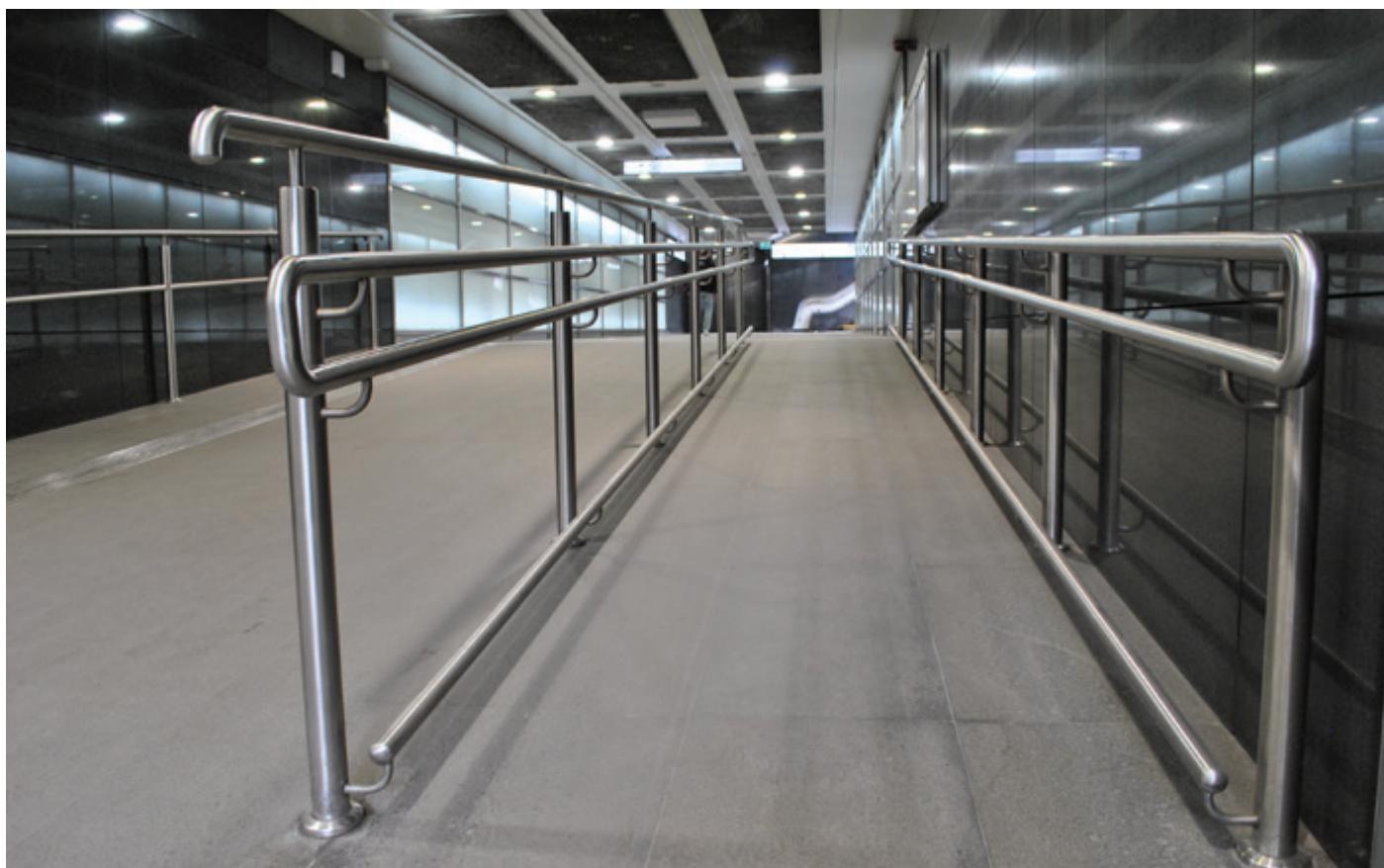
▼ Metro Centrum Nauki Kopernik – poręcze pochylni o przekroju okrągłym, zapewnione na dwóch wysokościach.
