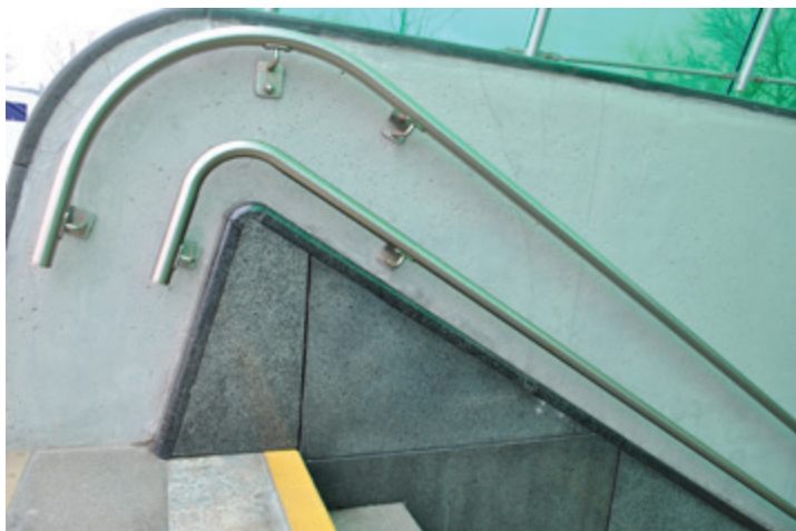
▼ Metro Stadion – poręcze na dwóch wysokościach, wydłużone względem biegu schodów i wywinięte w dół.
