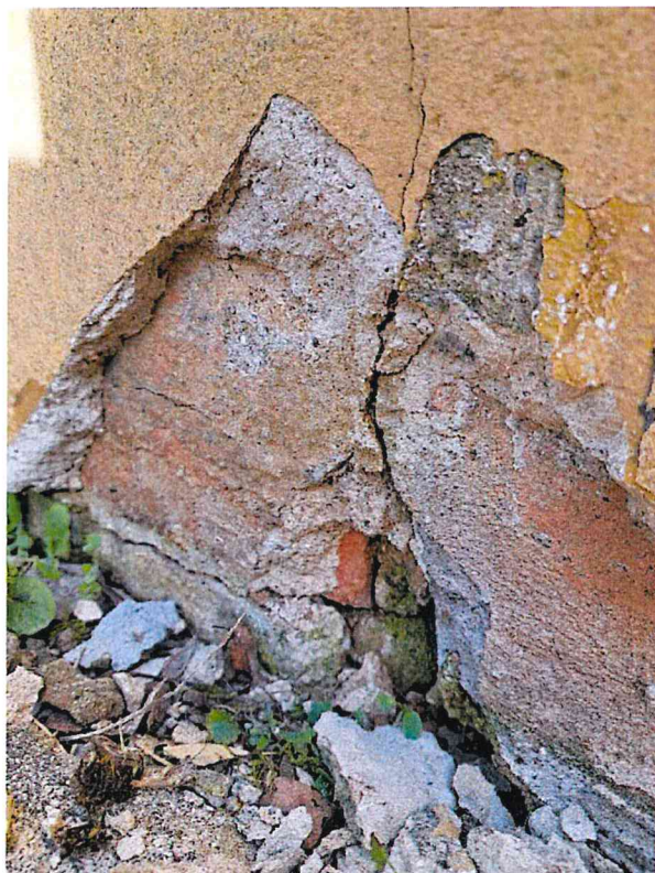
Fot. 11-12. Stan zachowania partii przyziemia w części północnej .Widoczne znaczne zawilgocenie oraz porażenie biologiczne.
