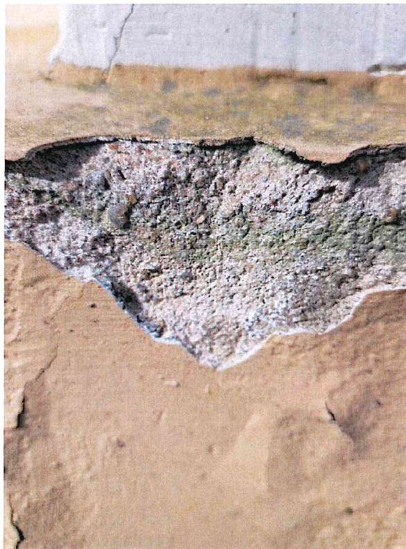
Fot. 11-12. Stan zachowania partii przyziemia w części północnej .Widoczne znaczne zawilgocenie oraz porażenie biologiczne.
