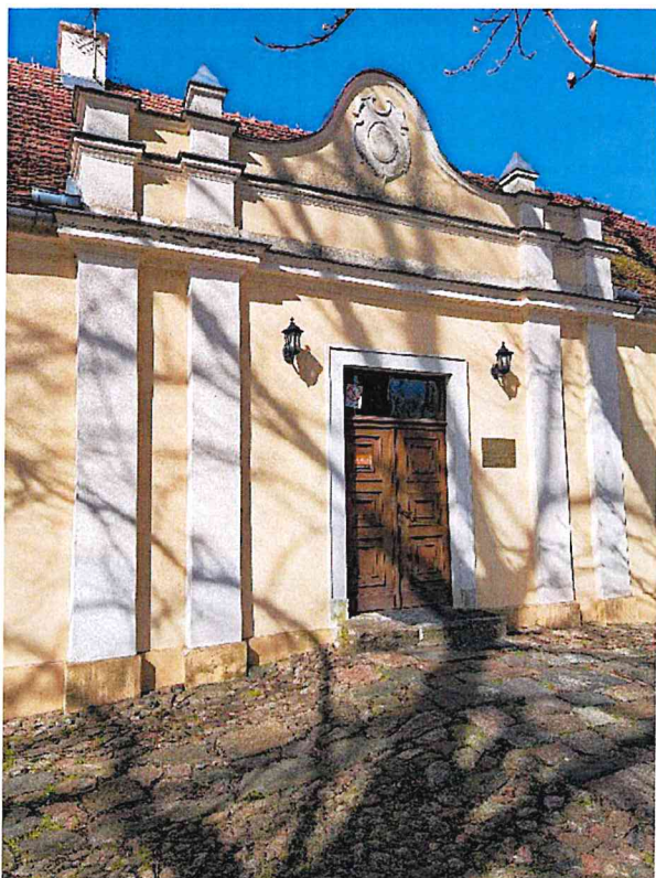
Fot 5-6 Stan zachowania tynków w obrębie głównego wejścia, a także zniszczenia w wyższych partiach detalu sztukatorskiego
