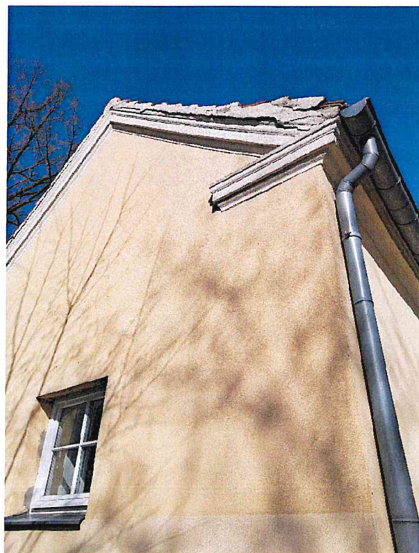
Fot 5-6 Stan zachowania tynków w obrębie głównego wejścia, a także zniszczenia w wyższych partiach detalu sztukatorskiego
