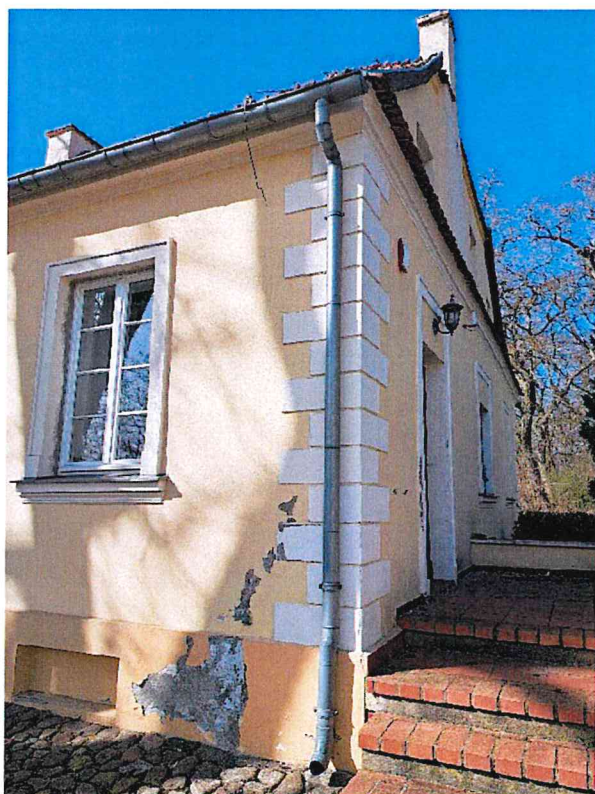
Zdj. 7-8. Stan zachowania tynków w obrębie narożnika południowo-wschodniego. Ogólny widok na elewację w kierunku zachodnim.
