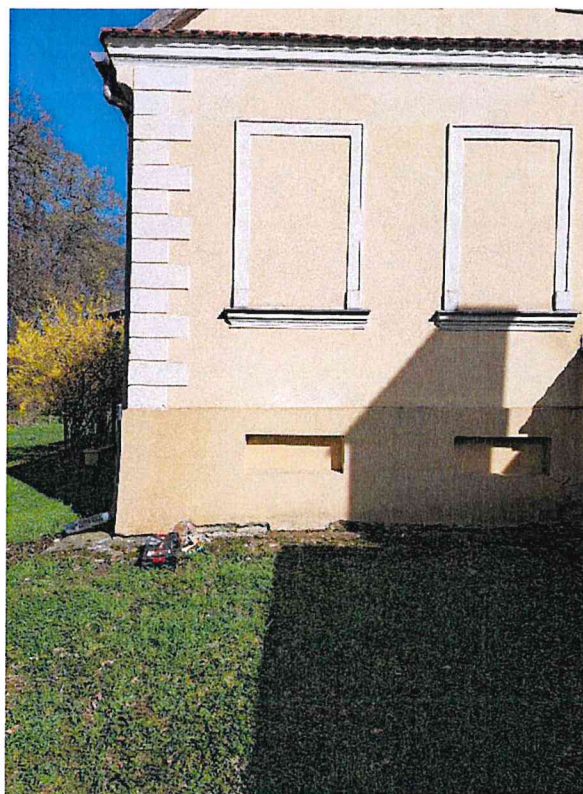
Zdj. 13-14 . Fragment wykonanych na nowo obramień wokół otworów okiennych a także artykulacja ściany zachodniej z wykorzystaniem opasek.
