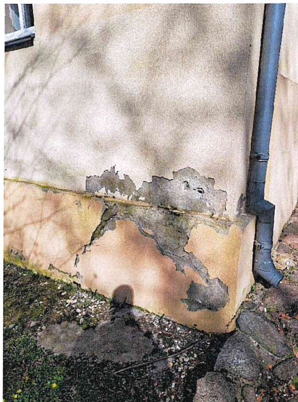
Zdj. 9-10 . Widoczne porażenie biologiczne oraz znaczne zawilgocenie w obrębie narożników
