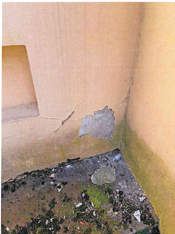
Zdj. 9-10 . Widoczne porażenie biologiczne oraz znaczne zawilgocenie w obrębie narożników
