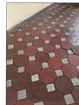
LOKALIZACJA USZKODZENIA PŁYTEK KLINKIEROWYCH POSADZKI
