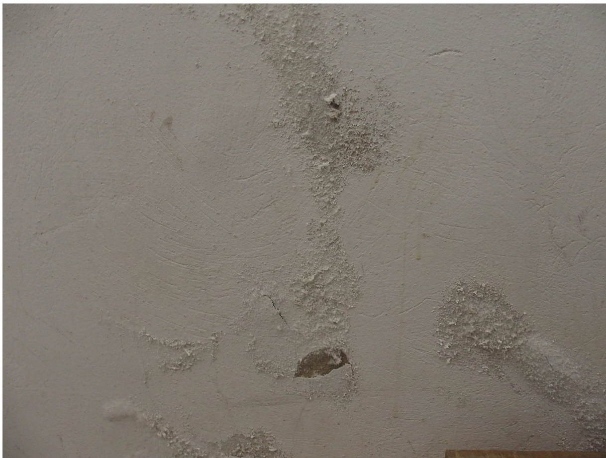
Zawilgocone tynki w piwnicy
