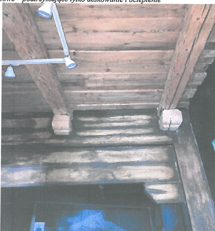
Istniejące belki stropowe – podparcie belek na istniejących ścianach
