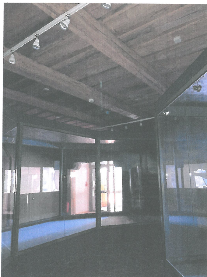
Istniejące belki stropowe – podtrzymujące tylko deskowanie i ocieplenie
