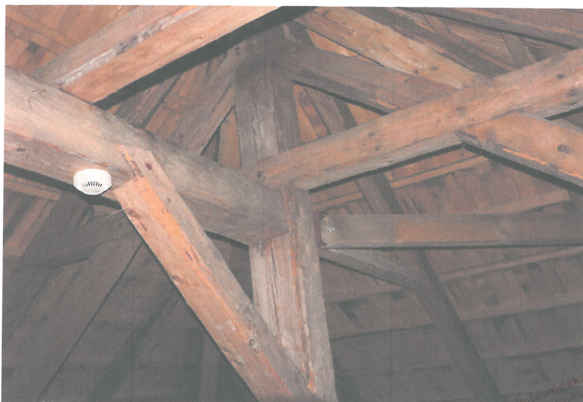
Wzmocnienia podparć krokwi na słupach.
