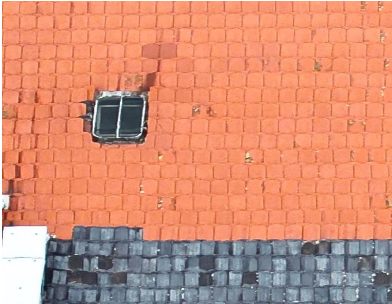
Świetlik w połaci dachowej
