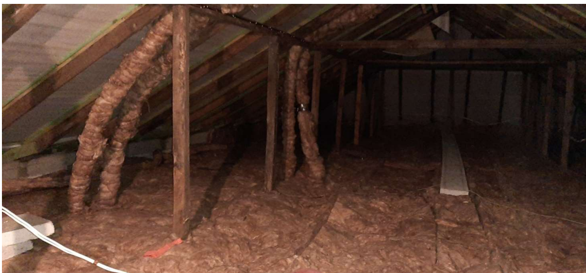
FOT NR 12 KONSTRUKCJA DACHU NAD SWIETLICĄ- OCIEPLENIE PODIĄGU STAŁOWEGO NAD SALĄ ZEBRAŃ
