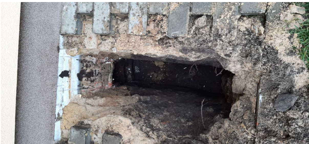
FOT NR 6-8 ODKRYWKA FUNDAMENTÓW OD STRONY POŁUDNIOWEJ
