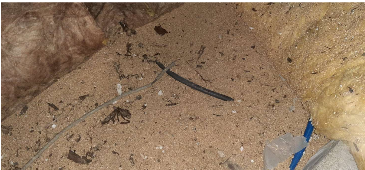
FOT NR 9 OCIEPLENIE STROPU ŚWIETLICY ( MATY Z WEŁNY I TROCINY )
