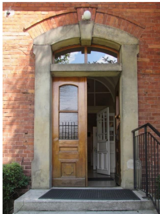
Zdj. 1. Zdjęcie drzwi oznaczonych na rysunkach symbolem "D1" które należy poddać renowacji i konserwacji.
