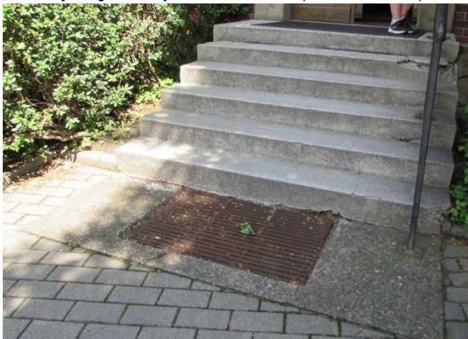
Fot. Schody od strony południowej – widoczna płyta betonowa do rozbiórki wraz z wycieraczką i balustradą do demontażu. Widoczne uszkodzenia okładziny wierzchniej schodów do rozbiórki.
