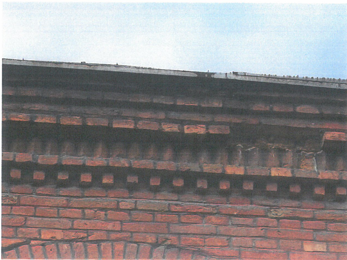
Fot. 5 Ubytki widoczne w elewacji wschodniej.
