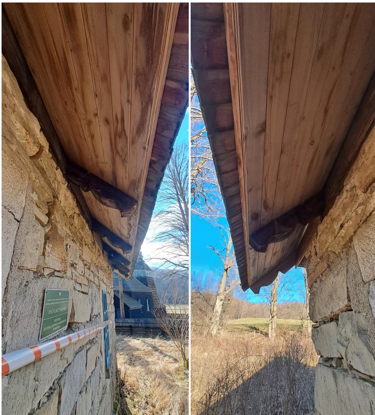
Fot. 53 i 54. Spichlerz plebański w Bartnem. Widok poddasza spichlerza od północy. Stan przed konserwacją. Widoczne uzupełnienia i naprawy spoinowania muru w postaci łat cementowych, widoczne zawilgocenie gontów (zdz. autorki).
