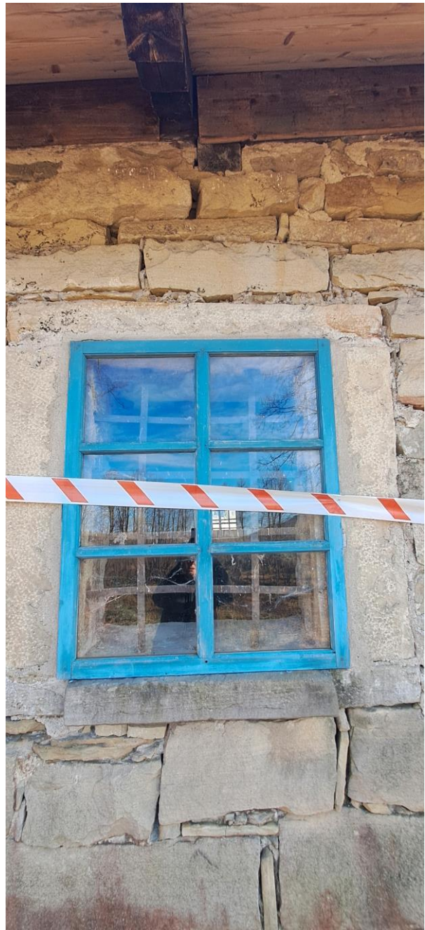
Fot. 39 i 40. Spichlerz plebański w Bartnem. Widok obramień okiennych i okien spichlerza od południa i od północy. Stan przed konserwacją. Widoczny stan zachowania ramy okiennej okna od południa (brak warstw malarskich, skorodowane elementy metalowe, kity cementowe wokół ram) oraz przemalowania ramy okiennej umiejscowionej na północnej elewacji spichlerza. Widoczne liczne, głębokie ubytki spoinowania murów kamiennych (zdj. autorki).
