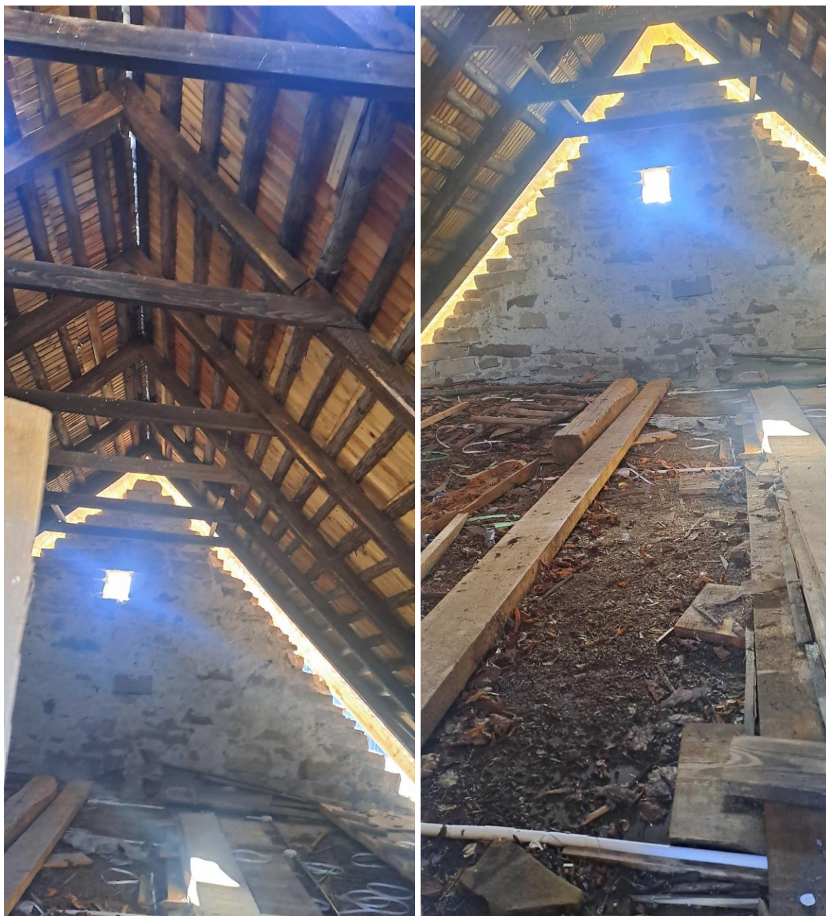
Fot. 45 i 46. Spichlerz plebański w Bartnem. Widok ogólny strychu i zachodniej ściany szczytowej spichlerza. Stan przed konserwacją. Widoczny stan zachowania murów, zły stan zachowania tynków oraz stan zachowania odtworzonej konstrukcji pokrycia dachu (zdj. autorki).
