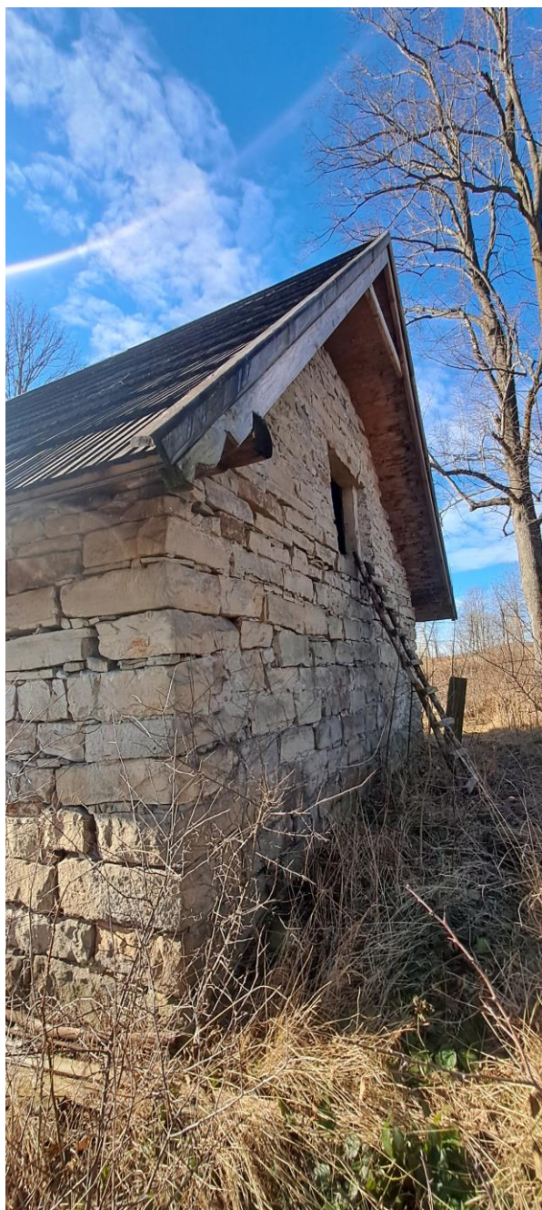
Fot. 51 i 52. Spichlerz plebański w Bartnem. Widok ogólny elewacji spichlerza od wschodu. Stan przed konserwacją. Widok ogólny wejścia na strych, widoczny stan zachowania murów elewacji wschodniej i deskowania poddasza, ubytki spoinowania, przebarwienia spowodowane wilgocą desek pokrycia dachu (zdj. autorki).
