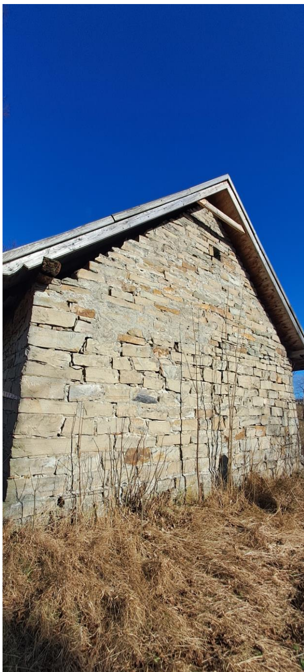
Fot. 7 i 8. Spichlerz plebański w Bartnem. Widok ogólny elewacji spichlerza od zachodu. Stan przed konserwacją. Widoczne spękania elewacji zachodniej, doraźne naprawy w postaci cementowych łat, zabrudzenia powierzchniowe kamienia i ubytki spoinowania. Teren wokół spichlerza, o lekkim spadku w kierunku cerkwi, porośnięty trawą (zdj. autorki).
