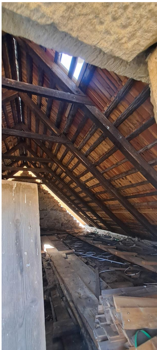
Fot. 47 i 48. Spichlerz plebański w Bartnem. Widok ogólny wejścia na strych oraz strychu i zachodniej ściany szczytowej spichlerza. Stan przed konserwacją. Widoczny stan zachowania murów elewacji wschodniej, ubytki kamieni w górnych partiach ściany szczytowej, ubytki spoinowania oraz stan zachowania odtworzonej konstrukcji pokrycia dachu (zdj. autorki).
