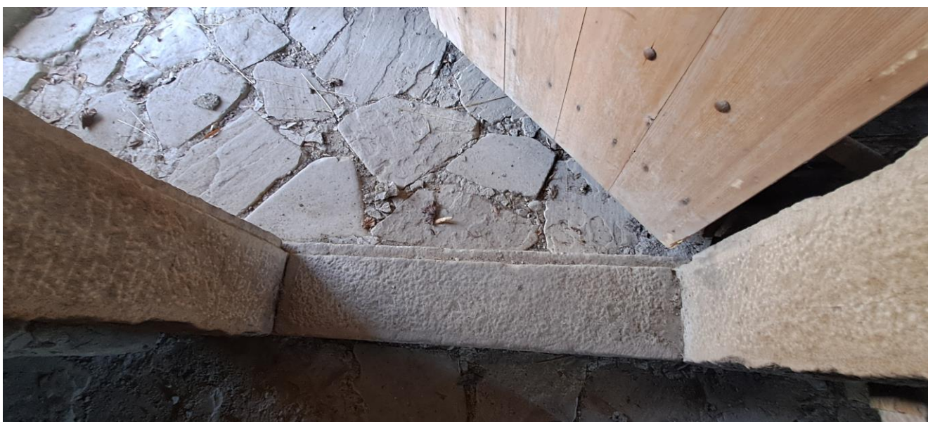
Fot. 15 i 16. Spichlerz plebański w Bartnem. Widok wnętrza spichlerza przed konserwacją. Widoczny stan zachowania podłóg wewnętrznych spichlerza, kamienne obramienia drzwi, zrekonstruowany strop i drzwi skrzydłowe. Widoczny zły stan zachowania wątków muru i podłogi, silne zabrudzenia powierzchniowe i ubytki spoinowania. Poluzowane ciosy kamienne w górnych partiach ściany działowej, zachowane tynki na ścianach zachodniej i północnej, zrekonstruowany strop i drzwi skrzydłowe. Widoczne założone oświetlenie elektryczne i pozostałości dawnej ekspozycji muzealnej (zdj. autorki).
