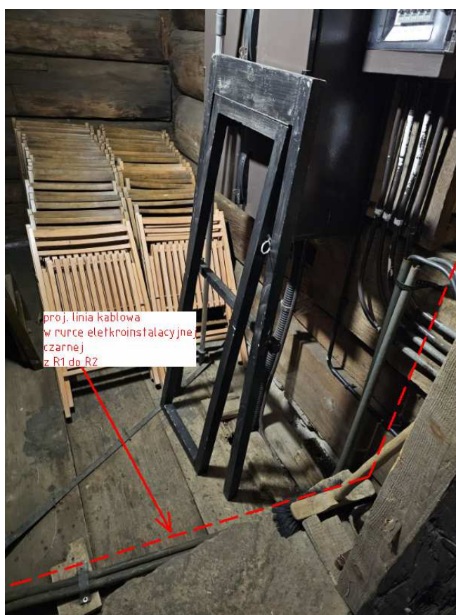
Rys. 2 Linia kablowa w rurce elektroinstalacyjnej z rozdzielnicy R1 w budynku cerkwi
