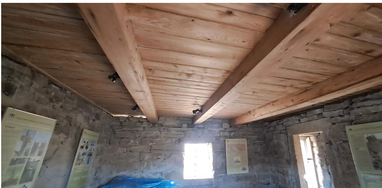
Fot. 17 i 18. Spichlerz plebański w Bartnem. Widok wnętrza spichlerza przed konserwacją. Widoczny ogólny stan zachowania górnych partii ścian i stropu. Poluzowane bloki kamienne, brak spoin i bardzo zły stan zachowania tynków (zdzj. autorki).
