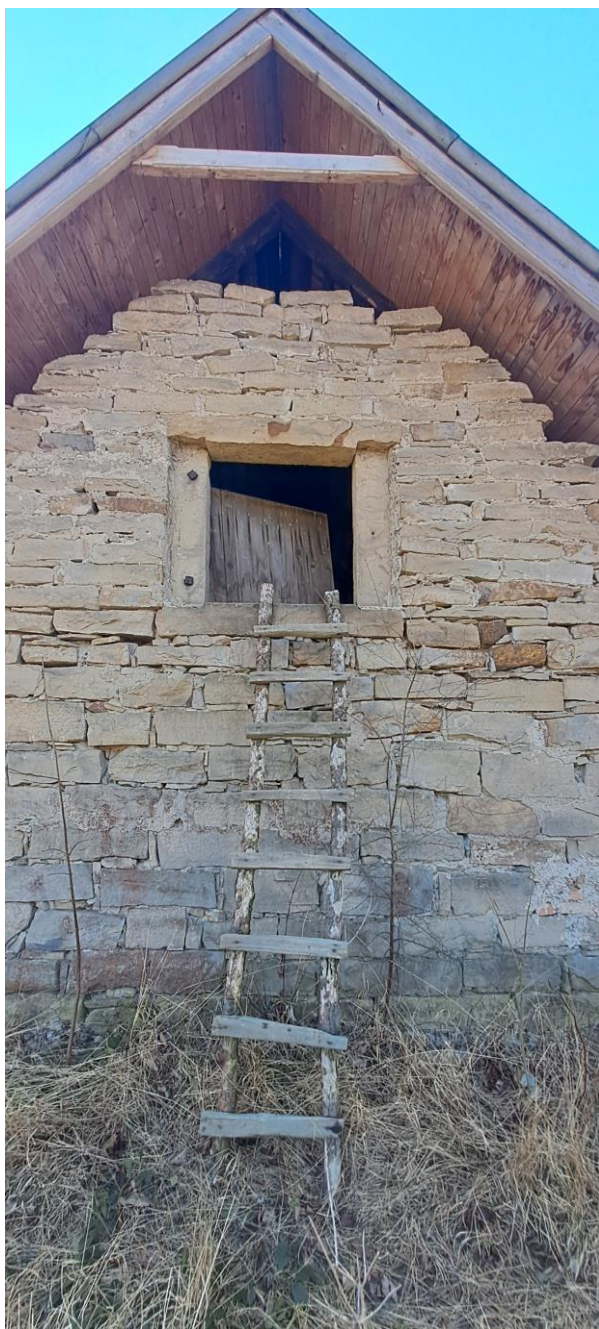
Fot. 47 i 48. Spichlerz plebański w Bartnem. Widok ogólny wejścia na strych oraz strychu i zachodniej ściany szczytowej spichlerza. Stan przed konserwacją. Widoczny stan zachowania murów elewacji wschodniej, ubytki kamieni w górnych partiach ściany szczytowej, ubytki spoinowania oraz stan zachowania odtworzonej konstrukcji pokrycia dachu (zdj. autorki).
