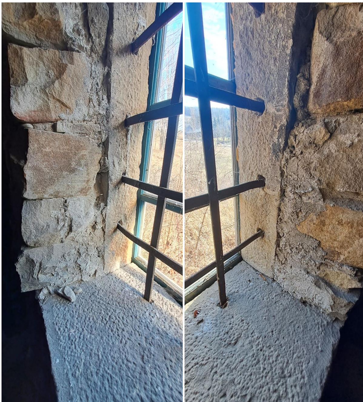
Fot. 29 i 30. Spichlerz plebański w Bartnem. Widok okien południowych spichlerza. Stan przed konserwacją. Widoczny sposób montażu krat i ram okiennych, liczne drobne uszkodzenia mechaniczne kamienia, ubytki spoinowania kamienia oraz założone późniejsze łąty cementowe zachodzące na kamień (zdj. autorki).
