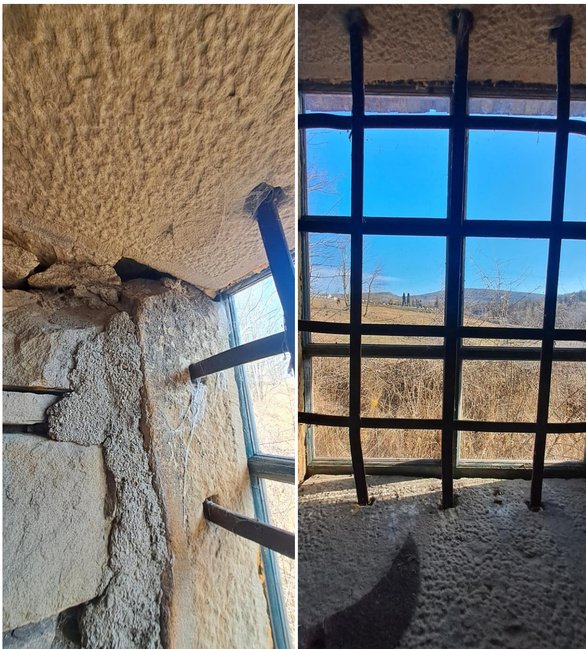
Fot. 35 i 36. Spichlerz plebański w Bartnem. Widok okien południowych spichlerza. Stan przed konserwacją. Widoczny stan zachowania elementów metalowych, liczne drobne uszkodzenia i zabrudzenia powierzchni kamienia, ubytki spoinowania kamienia oraz założone późniejsze łąty cementowe zachodzące na kamień (zdj. autorki).
