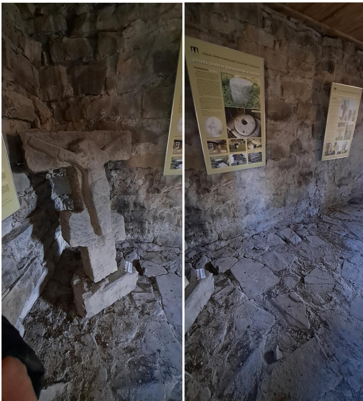
Fot. 21 i 22. Spichlerz plebański w Bartnem. Widok wnętrza spichlerza przed konserwacją. Widoczny stan zachowania ścian i podłóg wewnętrznych spichlerza, nierówny poziom podłogi. Widoczny zły stan zachowania wątków muru i podłogi, silne zabrudzenia powierzchniowe i ubytki spoinowania. Poluzowane ciosy kamienne, szczątkowo zachowane tynki na ścianach. Widoczne pozostałości dawnej ekspozycji muzealnej (elementy sakralnej sztuki łemkowskiej, m.in. kamienny krzyż, ekspozycja edukacyjna o historii wsi i kamieniarstwa) (zdzj. autorki).
