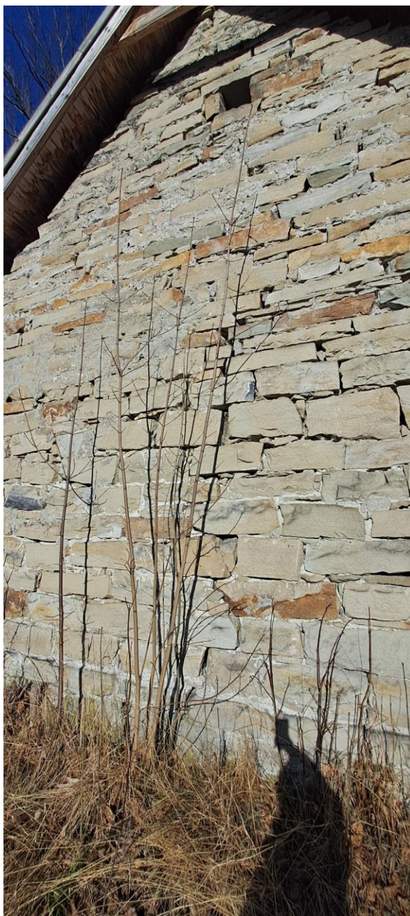
Fot. 57 i 58. Spichlerz plebański w Bartnem. Widok ogólny elewacji spichlerza od północy i od zachodu. Stan przed konserwacją. Widoczny zabrudzenia murów, pokrycie glonami i mchem dolnych powierzchni kamienia, ubytki spoinowani, widoczne późniejsze naprawy spoinowania z łąt cementowych (zdzj. autorki).
