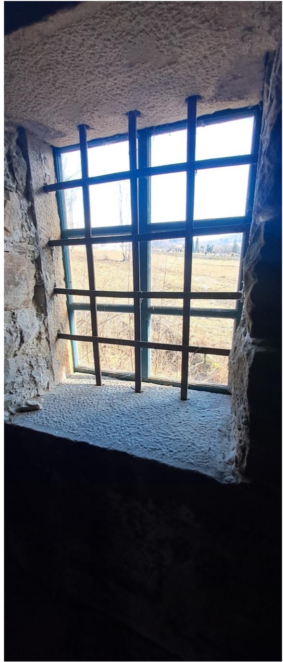
Fot. 27 i 28. Spichlerz plebański w Bartnem. Widok okien południowych spichlerza. Stan przed konserwacją. Widoczny sposób montażu krat i ram okiennych w obramieniach kamiennych, widoczny pierwotny sposób wykończenia powierzchni kamienia, liczne drobne uszkodzenia mechaniczne kamienia, stan zachowania ram okiennych (przemalowania farbą w kolorze niebieskim), ubytki spoinowania kamienia (zdj. autorki).
