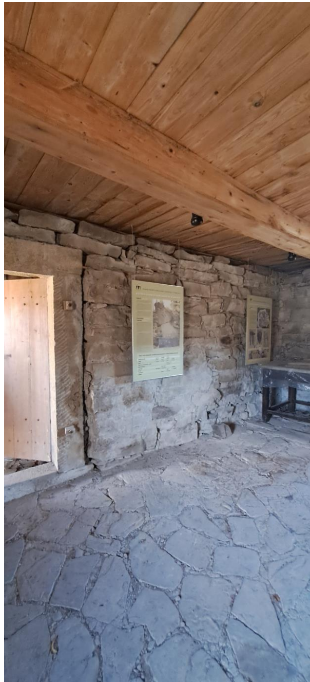
For. 23 i 24. Spichlerz plebański w Bartnem. Widok wnętrza spichlerza przed konserwacją. Widoczny stan zachowania ścian i podłóg wewnętrznych spichlerza, kamiennych obramień okiennych i drzwiowych, zrekonstruowany strop i drzwi skrzydłowe. Widoczny zły stan zachowania wątków muru i podłogi, silne zabrudzenia powierzchniowe i ubytki spoinowania. Poluzowane ciosy kamienne w górnych partiach ściany działowej, zniszczone, szczątkowo zachowane tynki na ścianach. Widoczne założone oświetlenie elektryczne oraz pozostałości dawnej ekspozycji muzealnej (zdj. autorki).
