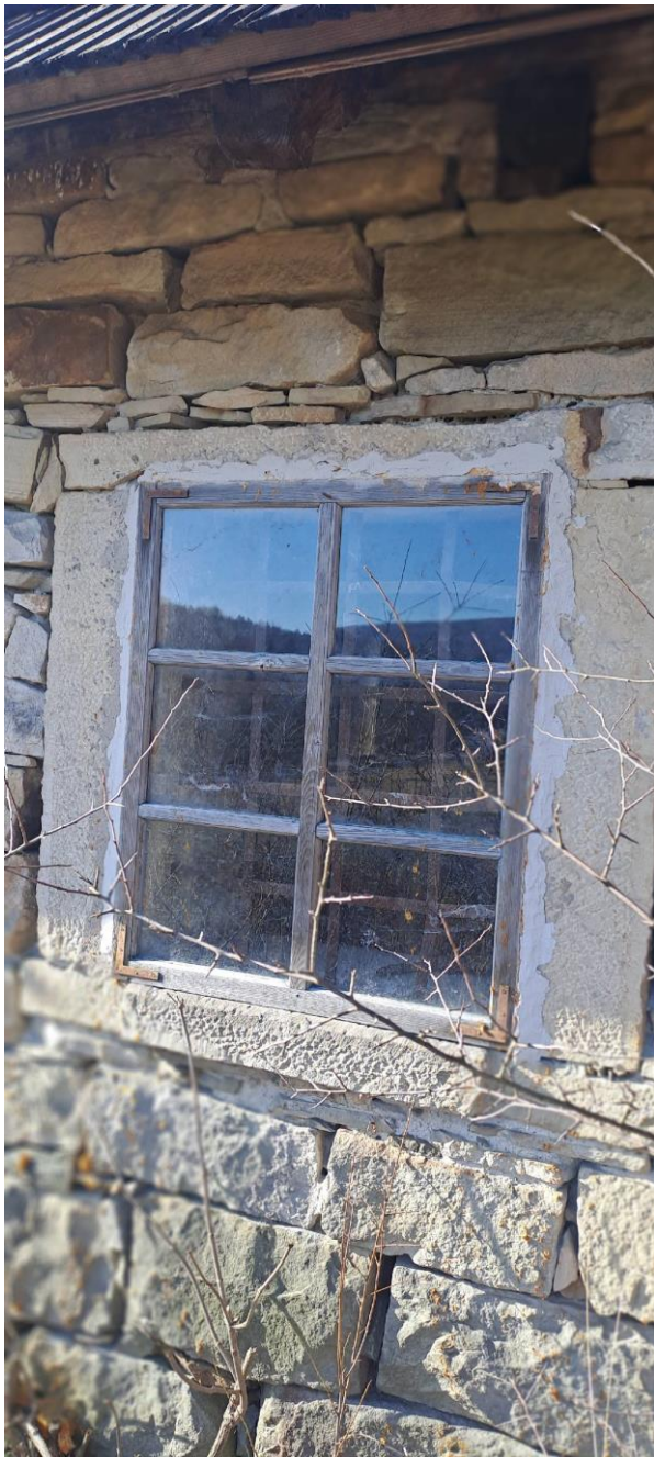
Fot. 39 i 40. Spichlerz plebański w Bartnem. Widok obramień okiennych i okien spichlerza od południa i od północy. Stan przed konserwacją. Widoczny stan zachowania ramy okiennej okna od południa (brak warstw malarskich, skorodowane elementy metalowe, kity cementowe wokół ram) oraz przemalowania ramy okiennej umiejscowionej na północnej elewacji spichlerza. Widoczne liczne, głębokie ubytki spoinowania murów kamiennych (zdj. autorki).
