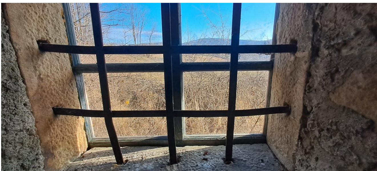
Fot. 33 i 34. Spichlerz plebański w Bartnem. Widok okien południowych spichlerza. Stan przed konserwacją. Widoczny sposób montażu krat i ram okiennych, stan zachowania elementów metalowych pokrytych produktami korozji i miejscami odkształconych, liczne drobne uszkodzenia mechaniczne kamienia, ubytki spoinowania oraz założone późniejsze łąty cementowe zachodzące na kamień (zdj. autorki).
