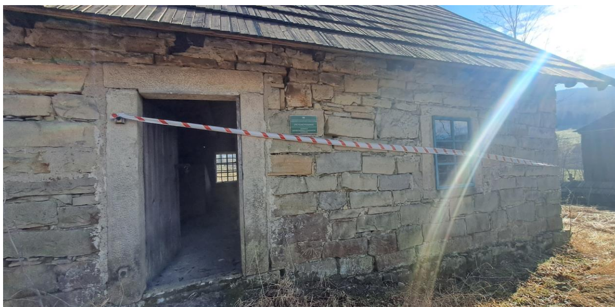
Fot. 43 i 44. Spichlerz plebański w Bartnem. Widok ogólny elewacji spichlerza od północy. Stan przed konserwacją. Widoczny stan zachowania drewnianych gontów, zabrudzenia powierzchniowe, nawarstwienie biologiczne, ubytki spoinowania murów kamiennych (zdj. autorki).
