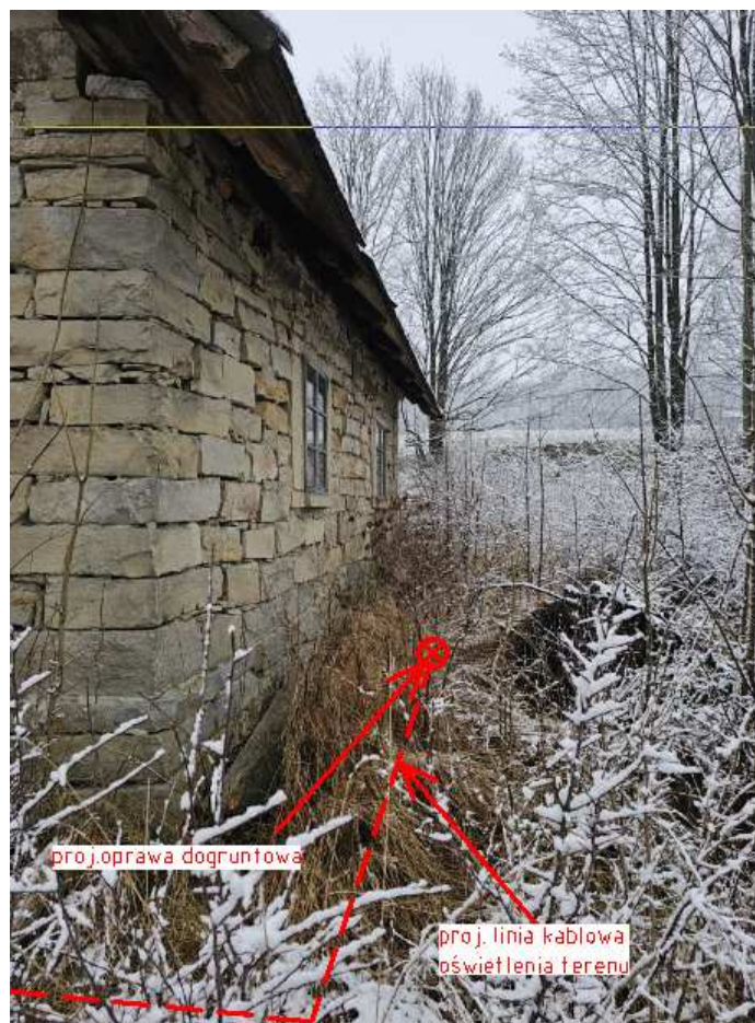
Rys. 7 Trasa linii kablowej od R2 w bud. spichlerza oświetlenia – elewacja wschodnia
