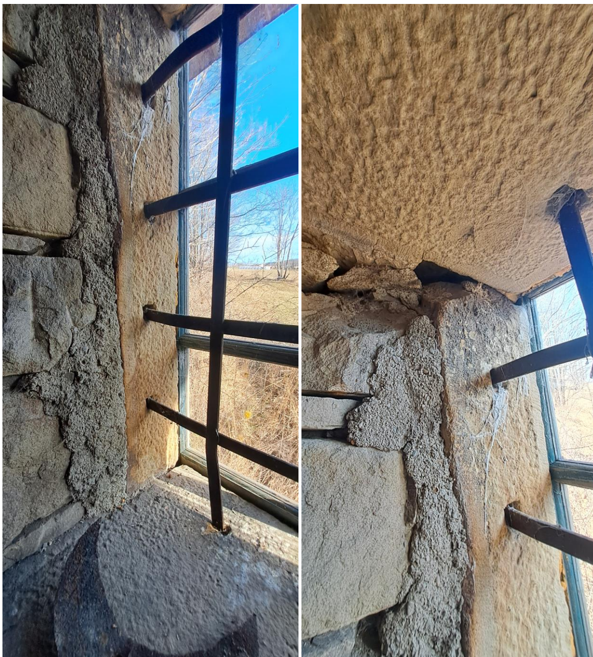
Fot. 31 i 32. Spichlerz plebański w Bartnem. Widok okien południowych spichlerza. Stan przed konserwacją. Widoczny sposób montażu krat i ram okiennych, liczne drobne uszkodzenia mechaniczne kamienia, zabrudzenia powierzchniowe, ubytki spoinowania kamienia oraz założone późniejsze łaty cementowe obszernie zachodzące na kamień (zdj. autorki).
