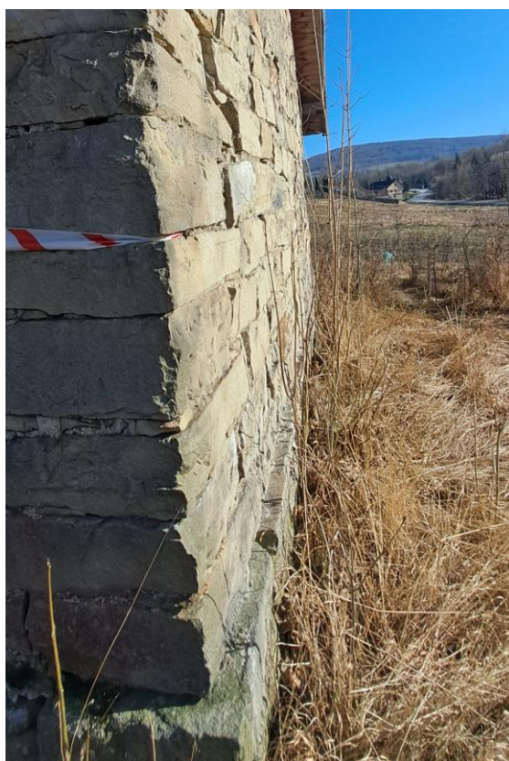
Fot. 59 i 60. Spichlerz plebański w Bartnem. Zbliżenia elewacji spichlerza od zachodu. Stan przed konserwacją. Widoczny stan zachowania kamiennego muru, widoczne ubytki spoinowania i przesunięcia kamieni muru względem siebie (zdj. autorki).
