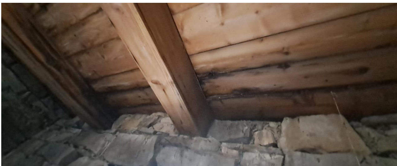
Fot. 19 i 20. Spichlerz plebański w Bartnem. Widok wnętrza spichlerza przed konserwacją. Widoczny stan zachowania górnych partii ścian i stropu. Poluzowane bloki kamienne, brak spoin i tynków. Widoczne zawilgocenia i przebarwienia drewna; deskowania i belek stropu przez przenikająca wilgoć z dachu (zdj. autorki).
