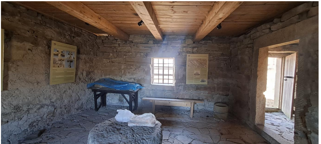
Fot. 13 i 14. Spichlerz plebański w Bartnem. Widok wnętrza północnej ściany spichlerza. Stan przed konserwacją ścian i podłóg wewnętrznych spichlerza, kamiennych obramień okiennych i drzwiowych. Widoczny zły stan zachowania wątków muru i podłogi, silne zabrudzenia powierzchniowe i ubytki spoinowania. Poluzowane ciosy kamienne w górnych partiach ścian, źle zachowane tynki na ścianach zachodniej i północnej, zrekonstruowany strop i drzwi skrzydłowe. Widoczne założone oświetlenie elektryczne oraz pozostałości dawnej ekspozycji muzealnej (elementy sakralnej sztuki łemkowskiej, m.in. koło młyńskie, kamienny krzyż, ekspozycja edukacyjna o historii wsi i kamieniarstwa) (zdz. autorki).
