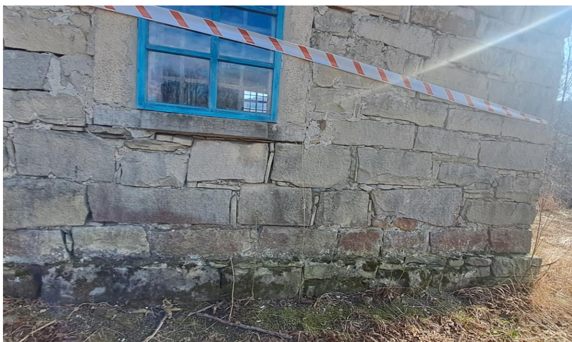
Fot. 5 i 6. Spichlerz plebański w Bartnem. Widok ogólny elewacji spichlerza od północy. Stan przed konserwacją. Widoczne ułożenie wątku muru; z dużych bloków ciosowych oraz mniejszych kamieni wypełniających przestrzenie pomiędzy blokami kamiennymi. Widoczne ubytki spoin w przestrzeniach pomiędzy kamieniami, zanieczyszczenia powierzchniowe i mchy w dolnej części cokołu. Widoczne umiejscowienie otworów okiennych przemalowanych na kolor niebieski (zdzj. autorki).
