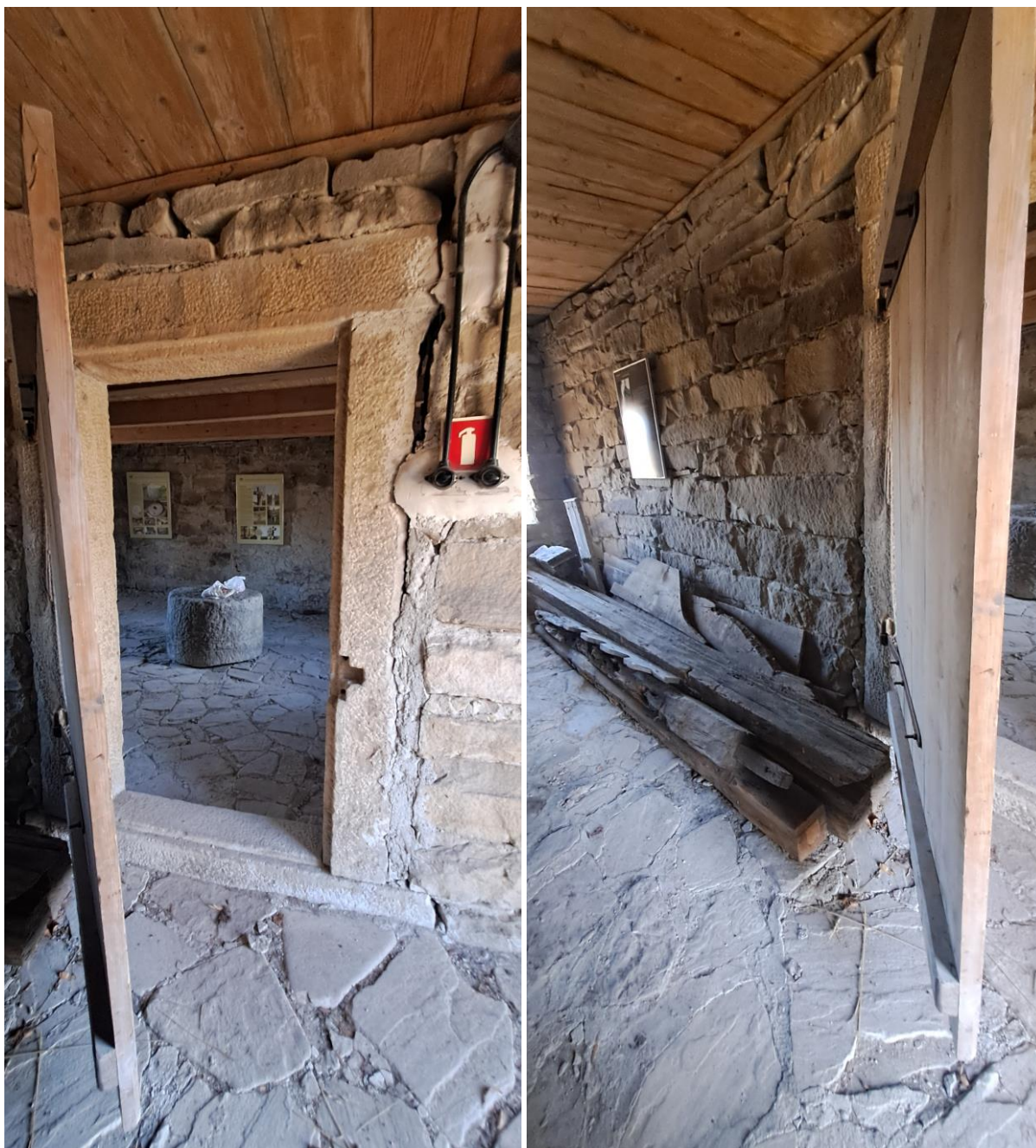
Fot. 25 i 26. Spichlerz plebański w Bartnem. Widok wnętrza spichlerza przed konserwacją. Widoczny stan zachowania ścian i podłóg wewnętrznych spichlerza, kamiennych obramień drzwiowych, zrekonstruowany strop sieni i drzwi skrzydłowe. Widoczny zły stan zachowania wątków muru i podłogi, silne zabrudzenia powierzchniowe i ubytki spoinowania. Poluzowane ciosy kamienne w górnych partiach ściany działowej, zrekonstruowany strop i drzwi skrzydłowe. Widoczne założone oświetlenie elektryczne, a także wtórne łaty cementowe i pozostałości dawnej ekspozycji muzealnej (zdj. autorki).
