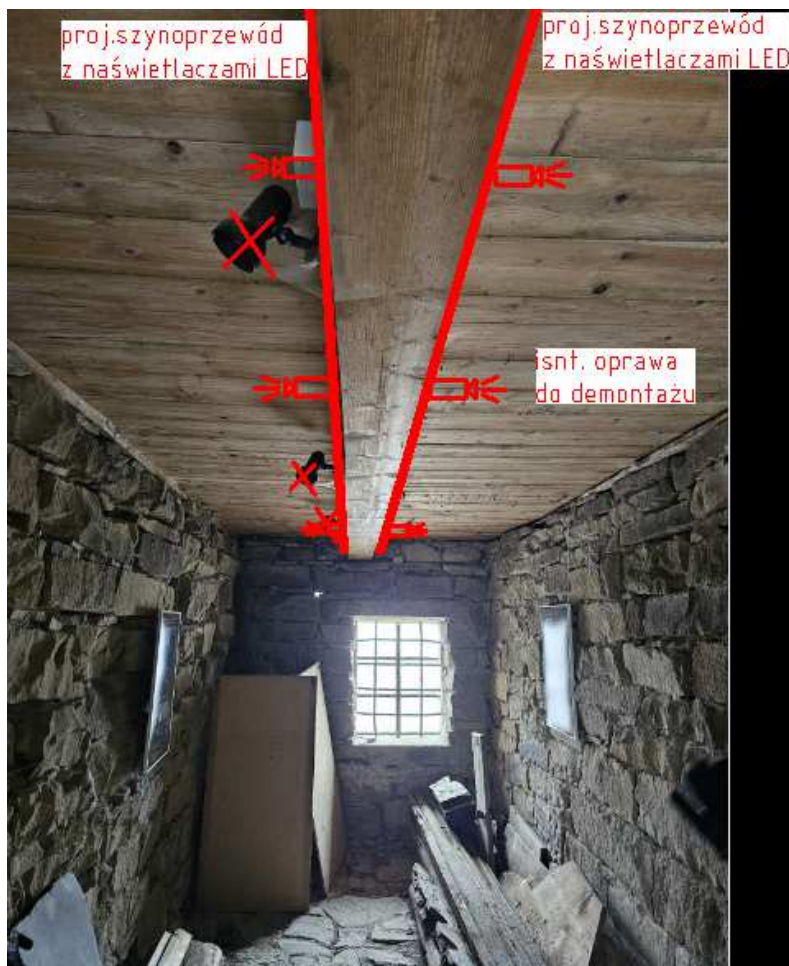
Rys. 9 Korytarz, szynoprzewód na belce stropowej
