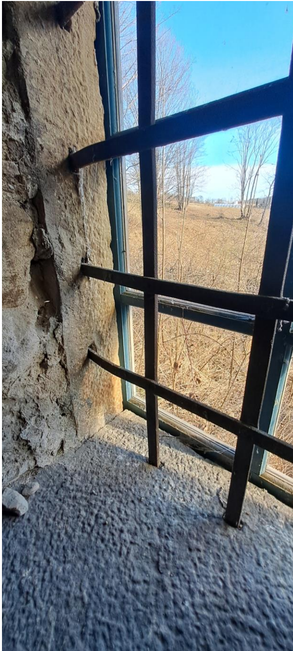
Fot. 27 i 28. Spichlerz plebański w Bartnem. Widok okien południowych spichlerza. Stan przed konserwacją. Widoczny sposób montażu krat i ram okiennych w obramieniach kamiennych, widoczny pierwotny sposób wykończenia powierzchni kamienia, liczne drobne uszkodzenia mechaniczne kamienia, stan zachowania ram okiennych (przemalowania farbą w kolorze niebieskim), ubytki spoinowania kamienia (zdj. autorki).
