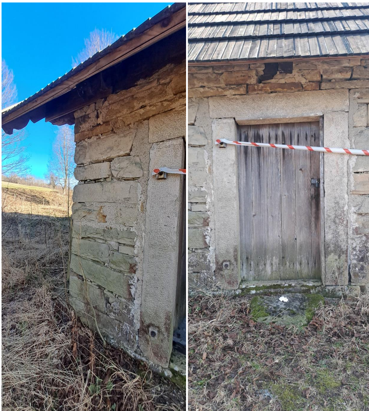
Fot. 55 i 56. Spichlerz plebański w Bartnem. Widok ogólny elewacji spichlerza od północy przed konserwacją. Widoczne zabrudzenia murów, pokrycie glonami i mchem dolnych powierzchni kamienia, ubytki spoinowania. Widoczne późniejsze naprawy spoinowania wokół portalu kamiennego z łat cementowych (zdj. autorki).
