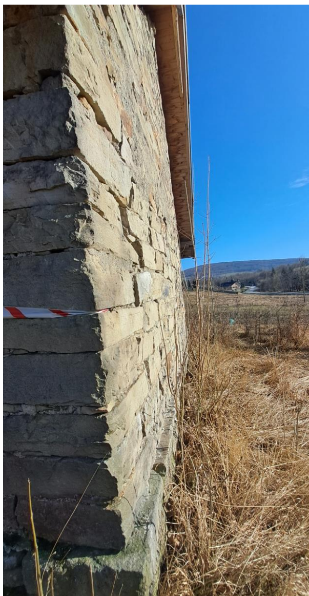
Fot. 7 i 8. Spichlerz plebański w Bartnem. Widok ogólny elewacji spichlerza od zachodu. Stan przed konserwacją. Widoczne spękania elewacji zachodniej, doraźne naprawy w postaci cementowych łat, zabrudzenia powierzchniowe kamienia i ubytki spoinowania. Teren wokół spichlerza, o lekkim spadku w kierunku cerkwi, porośnięty trawą (zdj. autorki).
