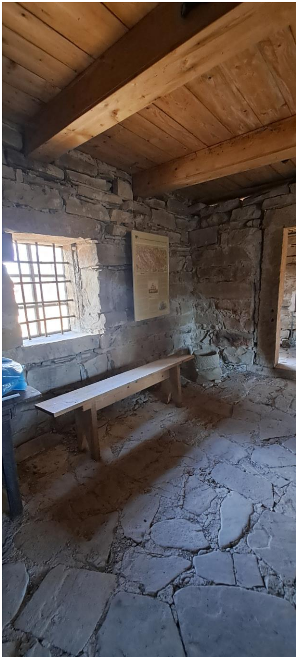
For. 23 i 24. Spichlerz plebański w Bartnem. Widok wnętrza spichlerza przed konserwacją. Widoczny stan zachowania ścian i podłóg wewnętrznych spichlerza, kamiennych obramień okiennych i drzwiowych, zrekonstruowany strop i drzwi skrzydłowe. Widoczny zły stan zachowania wątków muru i podłogi, silne zabrudzenia powierzchniowe i ubytki spoinowania. Poluzowane ciosy kamienne w górnych partiach ściany działowej, zniszczone, szczątkowo zachowane tynki na ścianach. Widoczne założone oświetlenie elektryczne oraz pozostałości dawnej ekspozycji muzealnej (zdj. autorki).
