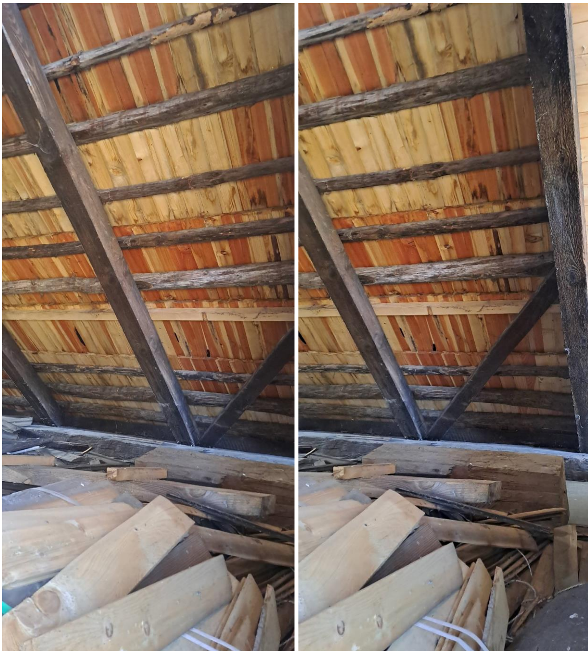
Fot. 49 i 50. Spichlerz plebański w Bartnem. Widok od wewnątrz pokrycia dachu spichlerza, połąć północna dachu. Stan przed konserwacją. Widoczne ślady zawilgocenia desek, zacieki i przebarwienia drewna (zdj. autorki).
