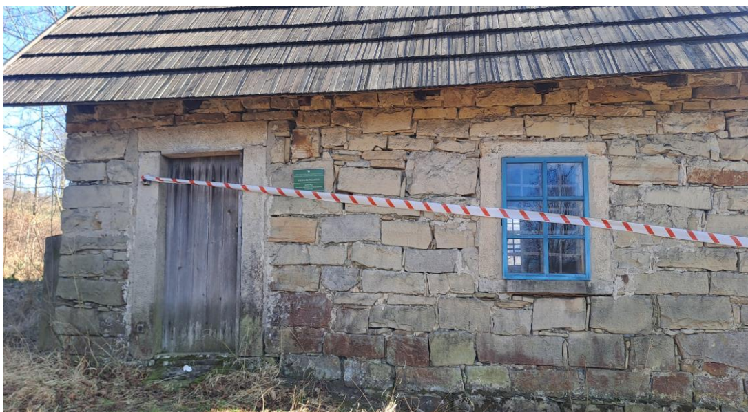
Fot. 3 i 4. Spichlerz plebański w Bartnem. Widok ogólny elewacji spichlerza od północy. Stan przed konserwacją. Widoczny stan zachowania kamieniarki oraz elementów drewnianych. Kamień elewacyjny odsłonięty, elewacja bez tynków, liczne ubytki spoinowania kamiennego.
