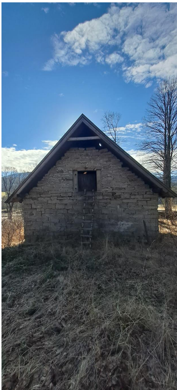
Fot. 9 i 10. Spichlerz plebański w Bartnem. Widok ogólny wschodniej elewacji spichlerza oraz północnej i zachodniej przed konserwacją. Widoczny stan zachowania elewacji, dachu i otworów okiennych spichlerza; widoczne wejście na poddasze (zdj. autorki).
