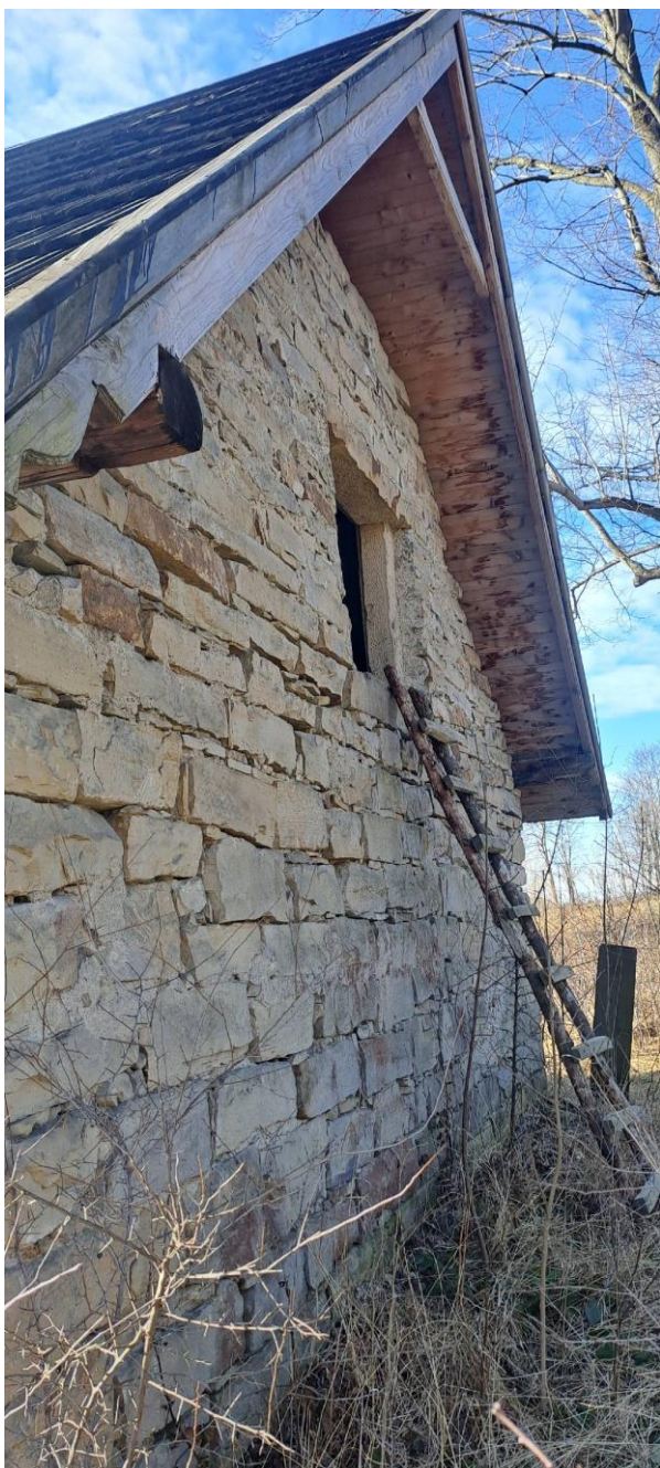
Fot. 51 i 52. Spichlerz plebański w Bartnem. Widok ogólny elewacji spichlerza od wschodu. Stan przed konserwacją. Widok ogólny wejścia na strych, widoczny stan zachowania murów elewacji wschodniej i deskowania poddasza, ubytki spoinowania, przebarwienia spowodowane wilgocą desek pokrycia dachu (zdj. autorki).
