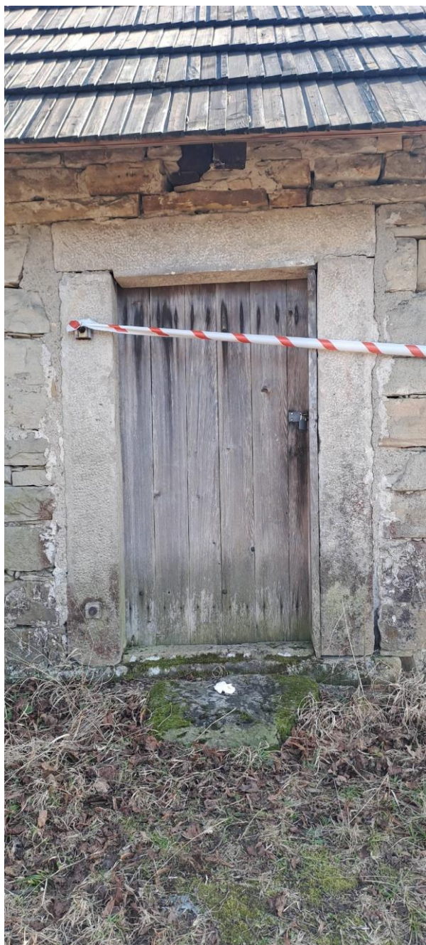
Fot. 57 i 58. Spichlerz plebański w Bartnem. Widok ogólny elewacji spichlerza od północy i od zachodu. Stan przed konserwacją. Widoczny zabrudzenia murów, pokrycie glonami i mchem dolnych powierzchni kamienia, ubytki spoinowani, widoczne późniejsze naprawy spoinowania z łąt cementowych (zdzj. autorki).
