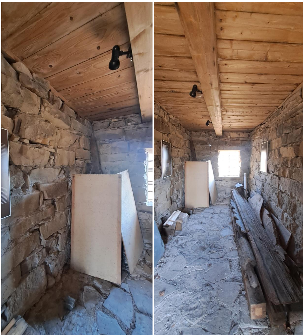
Fot. 37 i 38. Spichlerz plebański w Bartnem. Widok ogólny wnętrza sieni spichlerza. Stan przed konserwacją. Widoczny stan zachowania ścian i podłóg wewnętrznych, kamiennych obramień drzwiowych, zrekonstruowany strop sieni i drzwi skrzydłowe. Widoczny zły stan zachowania wątków muru i podłogi, silne zabrudzenia powierzchniowe i ubytki spoinowania. Poluzowane ciosy kamienne ścian. Widoczne założone oświetlenie elektryczne i pozostałości dawnej ekspozycji muzealnej (zdj. autorki).
