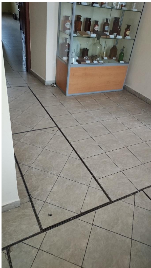
Zdj. 2 Przykładowe typy pokryw kanałów podposadzkowych.
