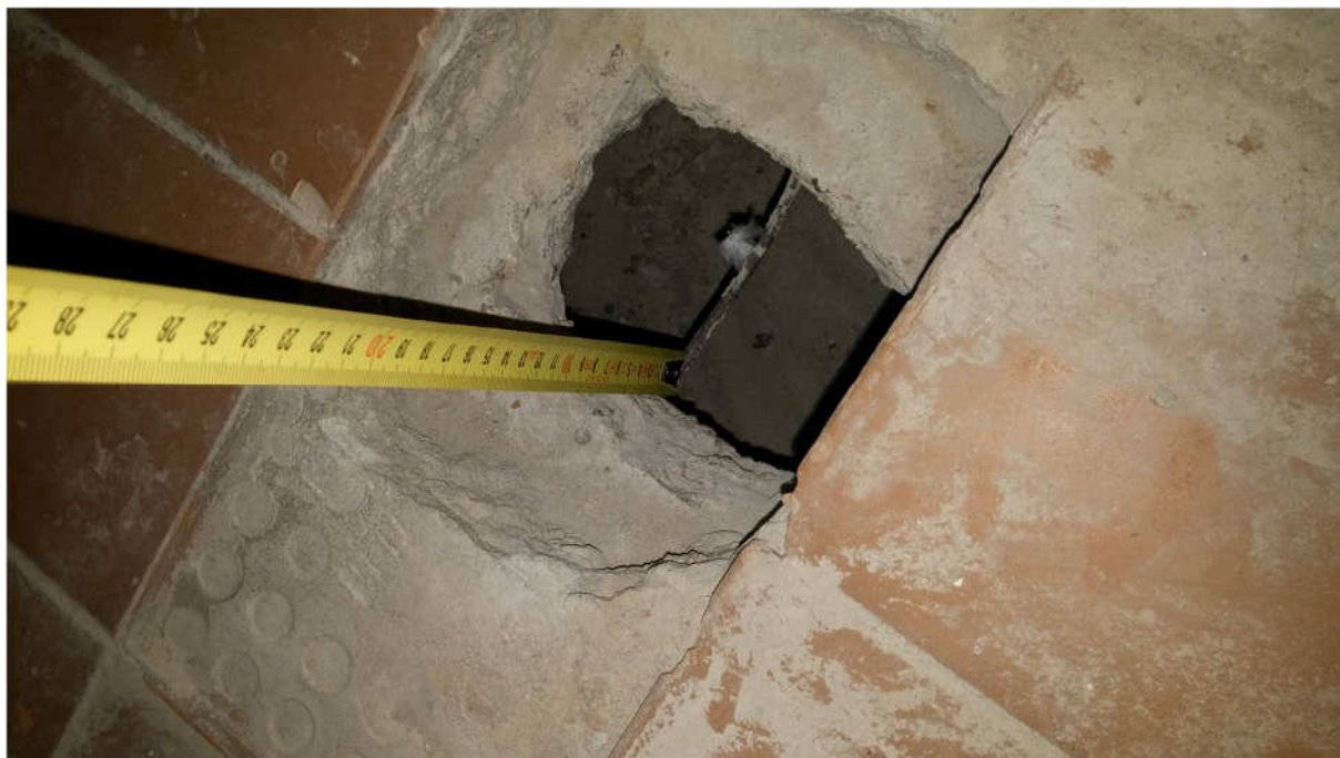
Fot.1 Odkrywka nr1 w stropie nad parterem w tzw. starej części budynku. Widoczna pustka poniżej płytki żelbetowej oraz nieprzecięte zbrojenie płytki – ze stali gładkiej.
