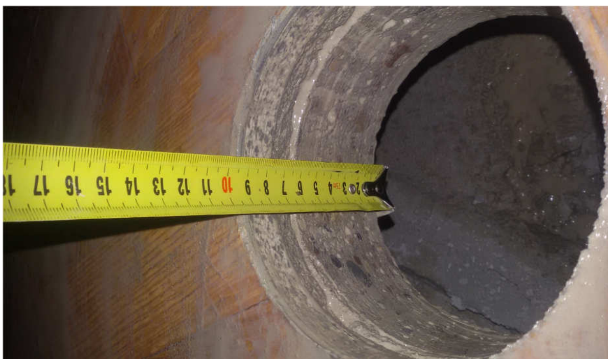
Fot.2 Odkrywka nr2 w stropie nad parterem w tzw. starej części budynku. Widoczna pustka poniżej płytki żelbetowej oraz układ warstw wykończeniowych stropu.
