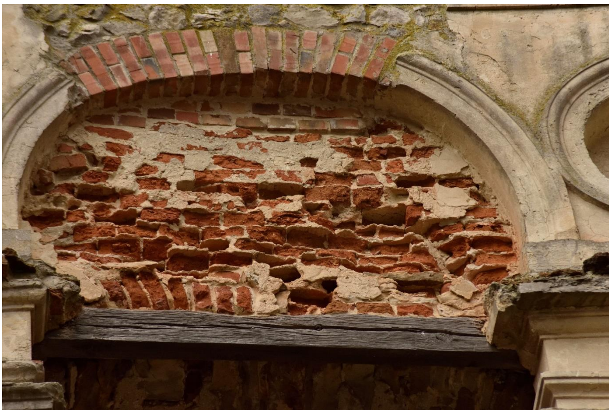
Fot. 7 Przykład głębokich uszkodzeń wstęgu ceglanego we wnęce szczytowej III kondygnacji
