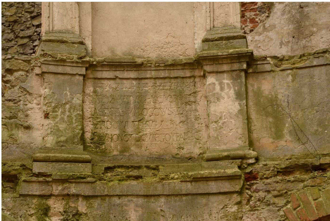
Fot. 14 Przykład płyty z inskrypcjami pokrytej zabrudzenia i zazielenieniami
