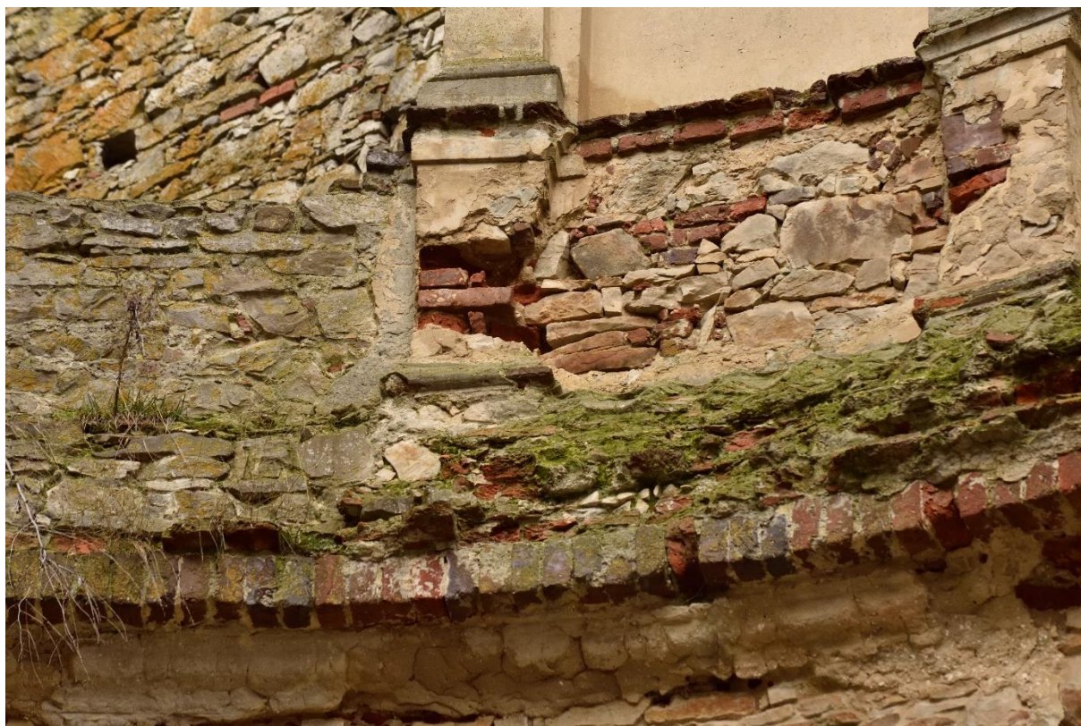
Fot. 12 Przykład roślinności porastającej gzysms kordonowy od strony dziedzińca eliptycznego pomiędzy drugą a trzecią kondygnacją
