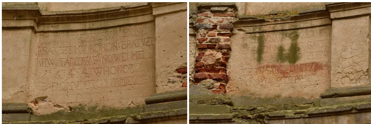
Fot. 3 i 4 Porównanie stanu zachowania płyt z inskrypcjami z zachowaną ciągłością gzymsu oraz uszkodzonego. Wyraźnie zauważyć można negatywny wpływ działania wody opadowej skutkujący kumulacją wilgoci i wzrostem biologicznym na płycie
