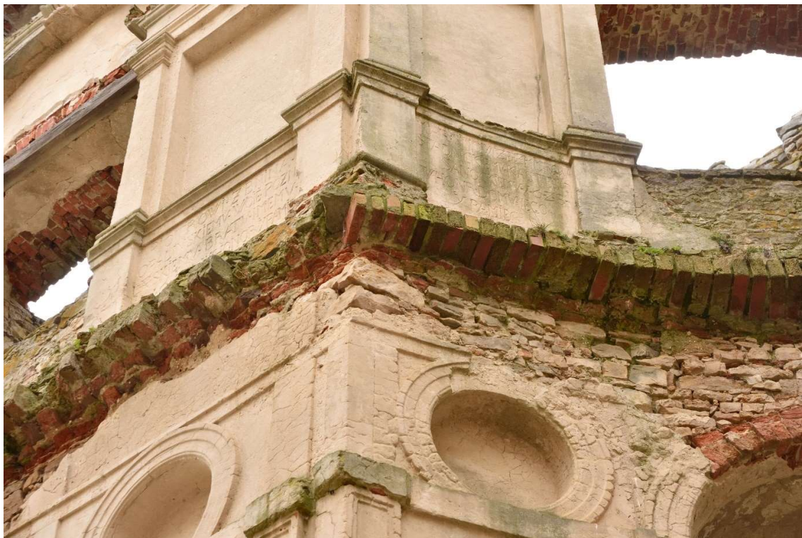
Fot. 9 Uszkodzony narożnik gzymsu ceglanego przy osi nr 1 elewacji wewnętrznej
