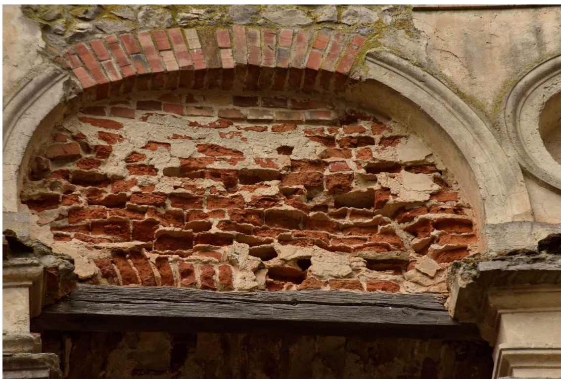
Fot. 7 Przykład głębokich uszkodzeń wstępu ceglanego we wnęce szczytowej III kondygnacji
