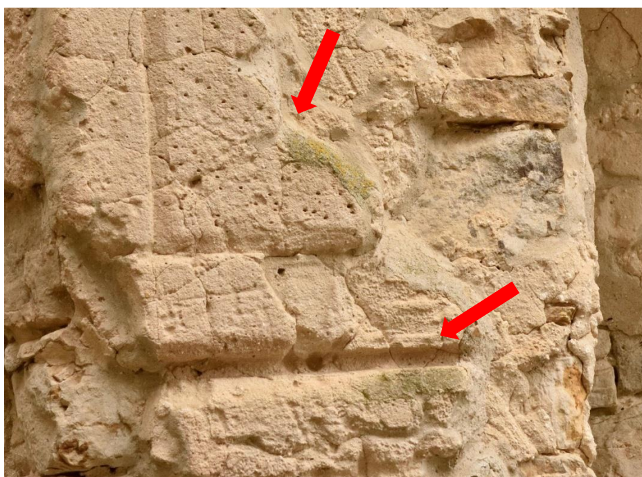
Fot. 11 Przykład rozwoju porostów na opaskach okalających pozostałości historycznych tynków
