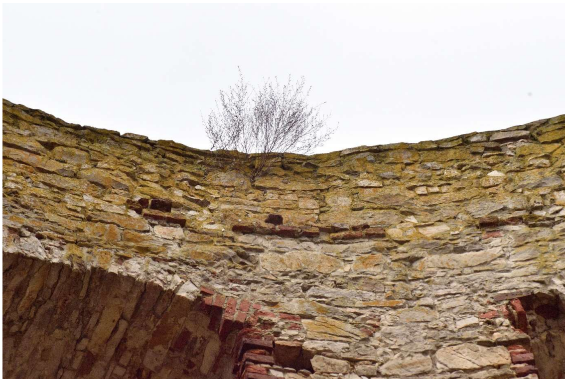
Fot. 13 Przykład roślinności porastającej koronę muru od strony dziedzińca eliptycznego
