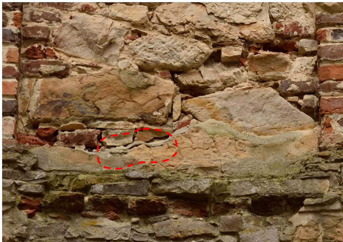
Fot.8 Przykład odspojień i uszkodzeń opasek tynkowych, wykonanych w trakcie poprzednich prac konserwatorskich, na skutek działania czasu i czynników atmosferycznych
