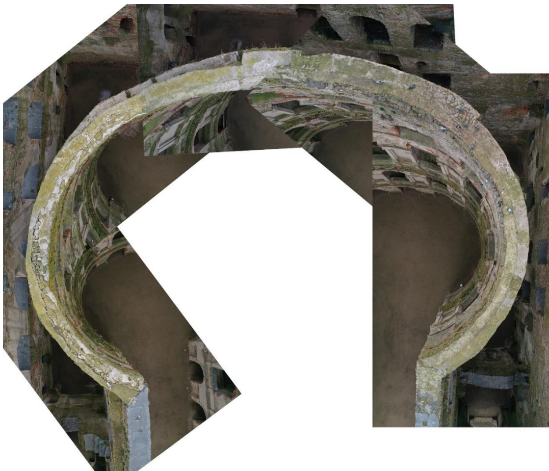
Fot. 60 Widok całościowy (mapowanie), stan zachowania korony murów dziedzińca eliptycznego
