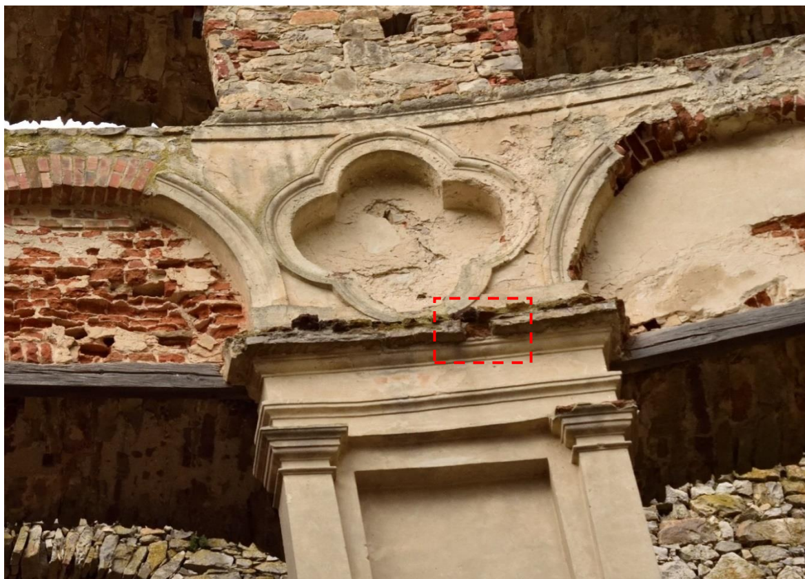
Fot. 5 Przykład przerwania ciągłości gzymsu pod czworolistną rozetą zlokalizowanego pomiędzy 5 i 6 osią elewacji wewnętrznej
