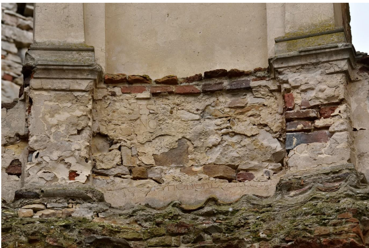
Fot. 43 Płycina nr 14 z resztkami inskrypcji zlokalizowana na poziomie III kondygnacji po lewej stronie osi 7
