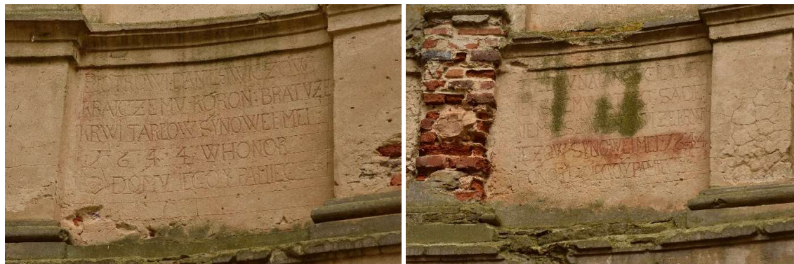
Fot. 3 i 4 Porównanie stanu zachowania płyty z inskrypcjami z zachowaną ciągłością gzymsu oraz uszkodzonego. Wyraźnie zauważyć można negatywny wpływ działania wody opadowej skutkujący kumulacją wilgoci i wzrostem biologicznym na płycinie
