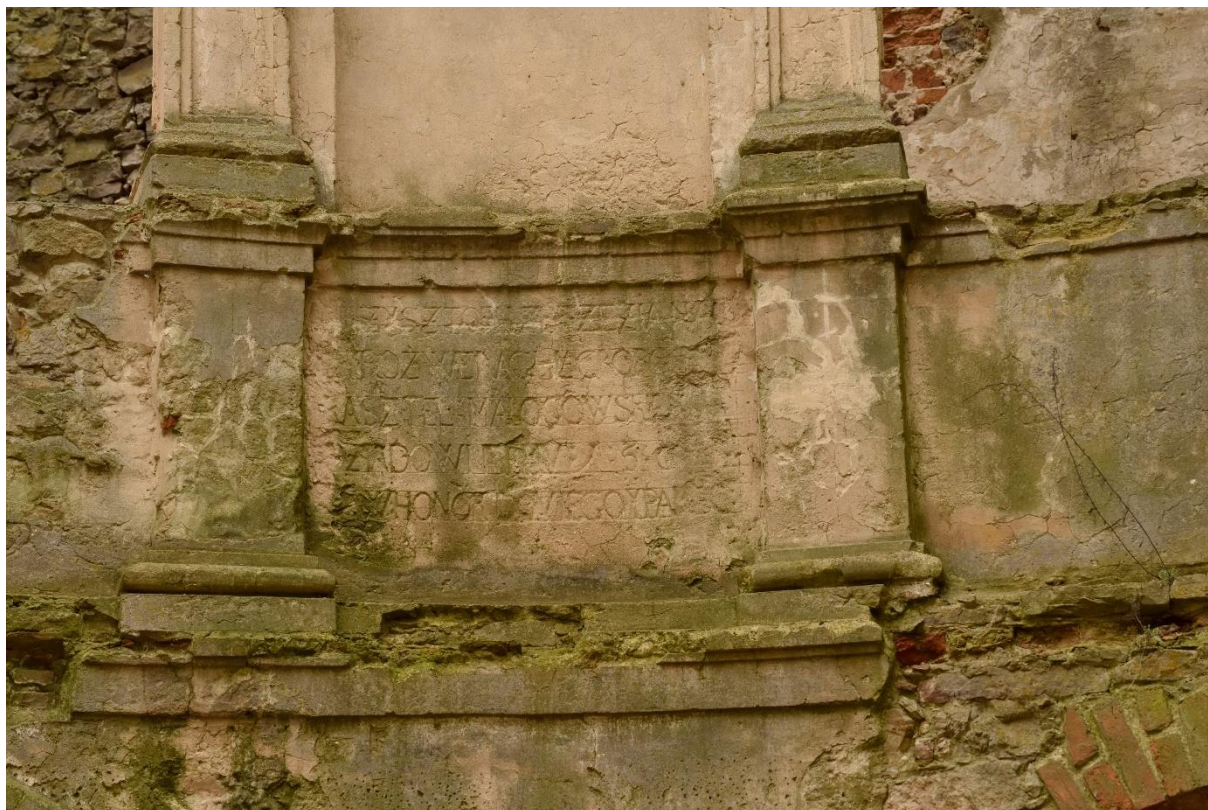
Fot. 14 Przykład płyciny z inskrypcjami pokrytej zabrudzenia i zazielenieniami
