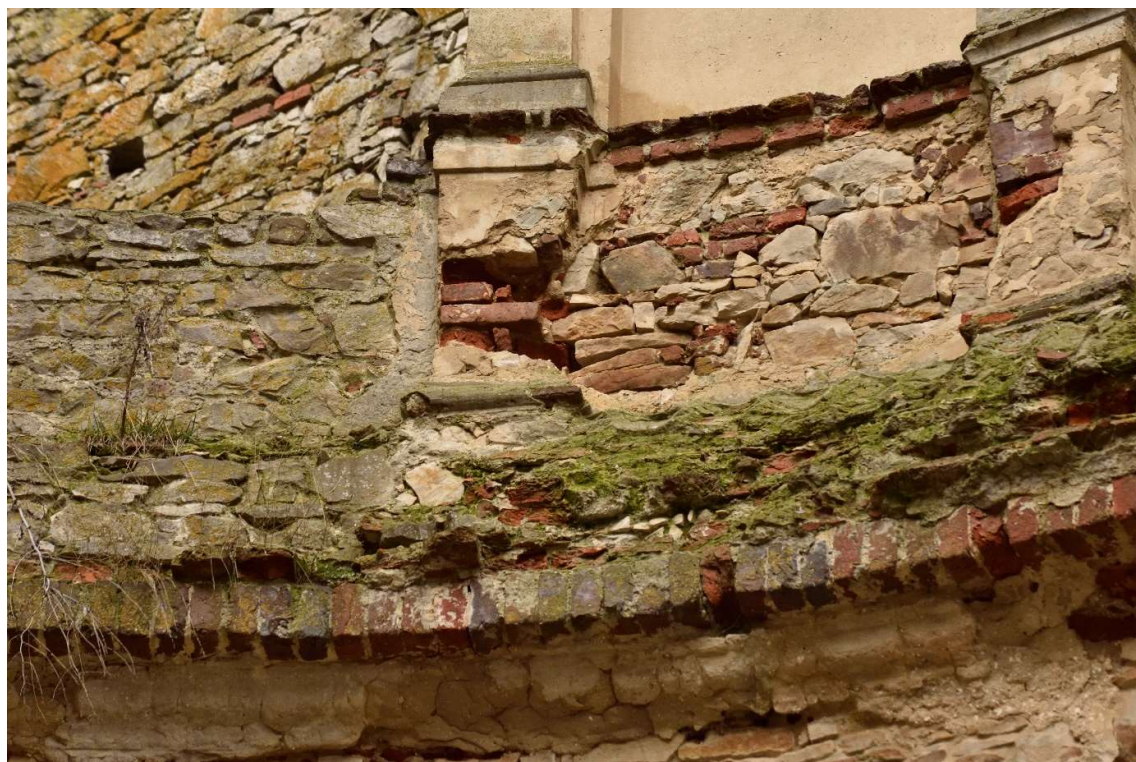
Fot. 12 Przykład roślinności porastającej gzyms kordonowy od strony dziedzińca eliptycznego pomiędzy drugą a trzecią kondygnacją
