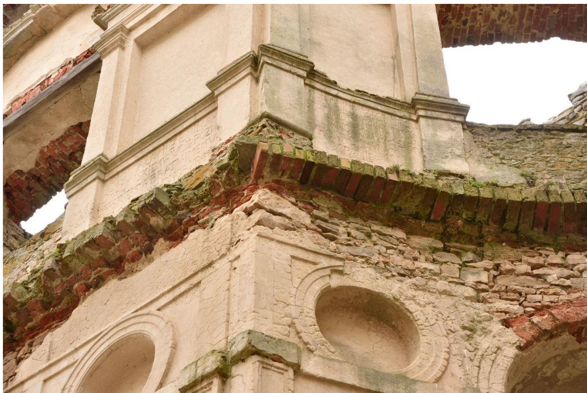
Fot. 9 Uszkodzony narożnik gzymsu ceglany przy osi nr 1 elewacji wewnętrznej
