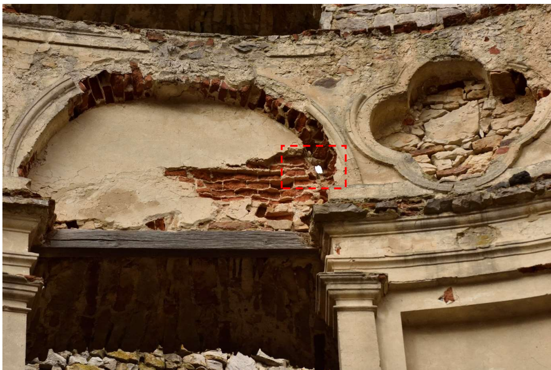
Fot. 6 Przykład ubytku „na wylot” zlokalizowanego w blendzie nad otworem okiennym III kondygnacji w osi nr 6
