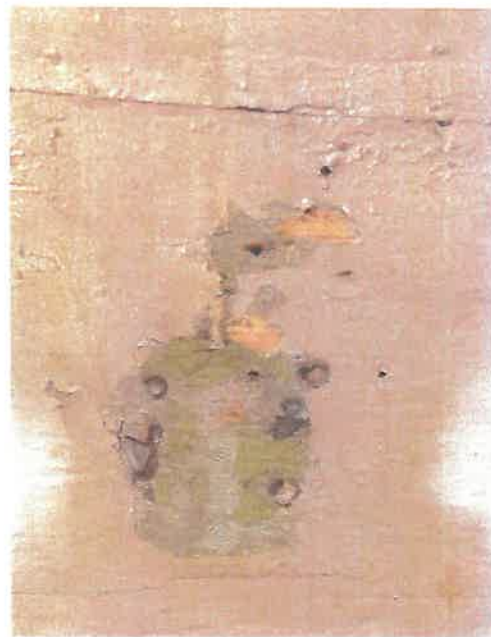
Fot. 38. W Odkrywce nr 5 na drewnie leży szara warstwa, na niej kolejno zielonkawa, szarooliwkowa, zielona i ostatnia beżowa.
