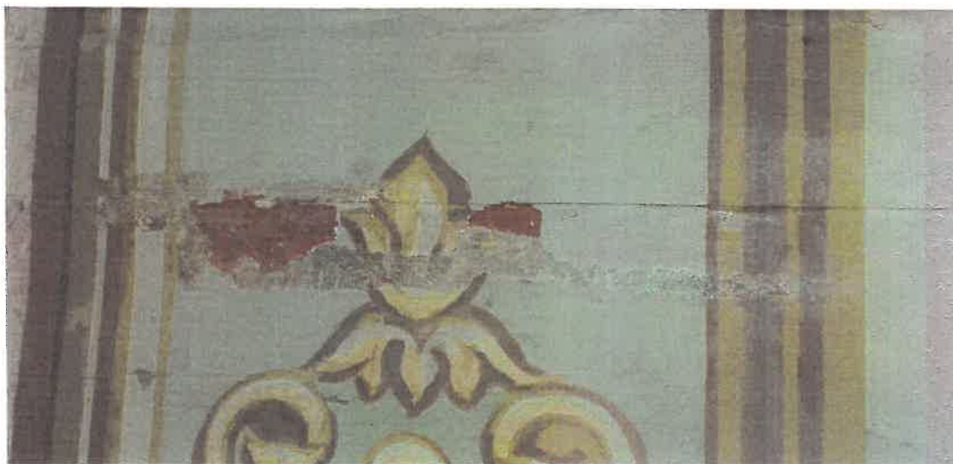
Fot. 25. W Odkrywcę nr 14 widoczna jest czerwona najstarsza warstwa na drewnie. Najmłodsza polichromia różni się kolorystycznie od starszej i nie została namalowana po jej formie.
