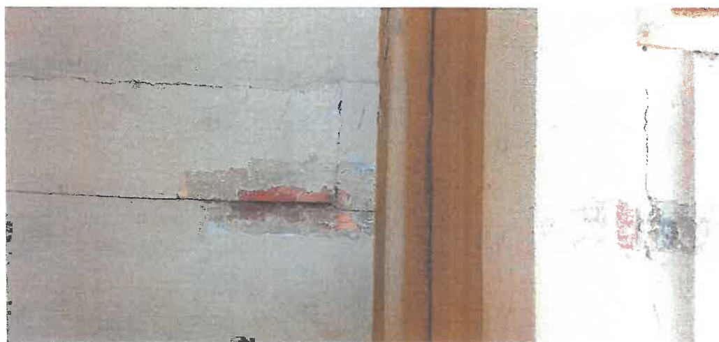
Fot. 22. Odkrywka nr 11 . Stratygrafia nawarstwień: 0 – drewno, 1 – czerwona, 2 – grunt, 3 – szaroniebieska, 4 – szara, 5 – zielonkawa, 6 – oliwkowa.
