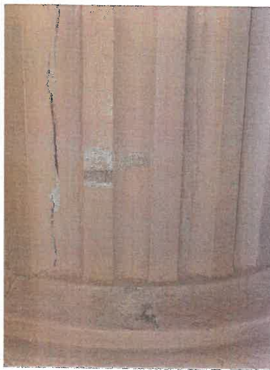
Fot. 73. Odkrywka nr 26 na kolumnie. Najstarsze opracowanie kolorystyczne było białawe, na nim beżowe, szarobeżowe i obecne beżowe.
