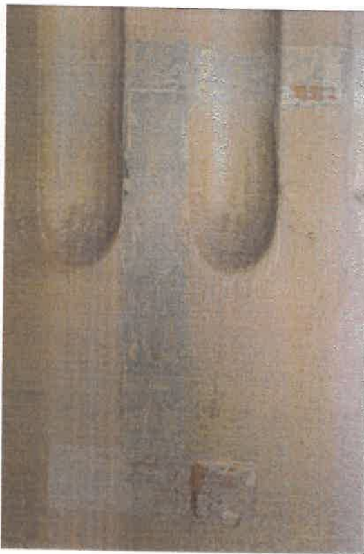
Fot. 85. Pilaster. W Odkrywce nr 31 na drewnie wystąpiły kolejno: szarobiaława, kremowa, szara, szara, beżowa.
