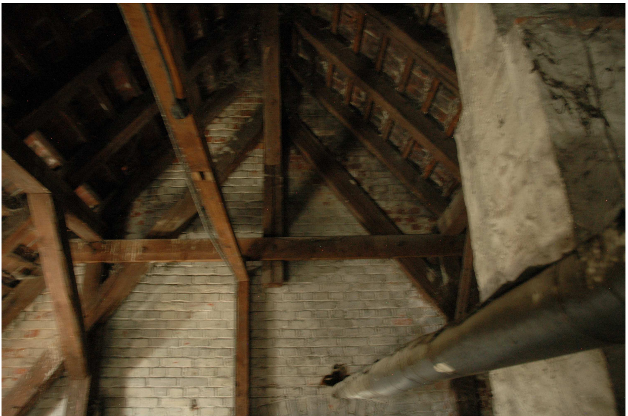
fot. nr 16 Wiązar przy ścianie szczytowej - zastrzały przechodzące do centralnie ustawionego wieszaka zredukowanego.
