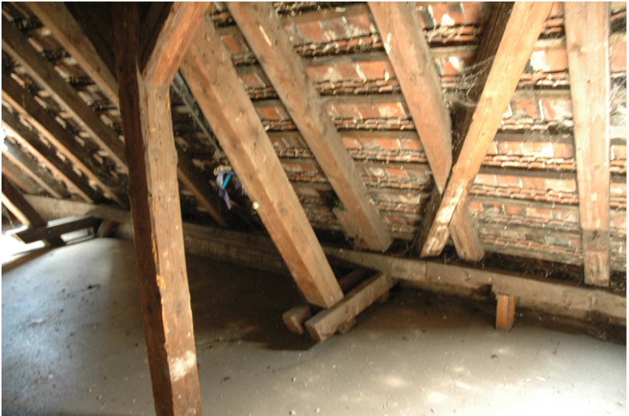
fot. nr 12 Widok na wiązary pełne skrzydła zachodniego - zastrzał spięty półkleszczami do ramy kolankowej, widoczna płatew kolankowa
