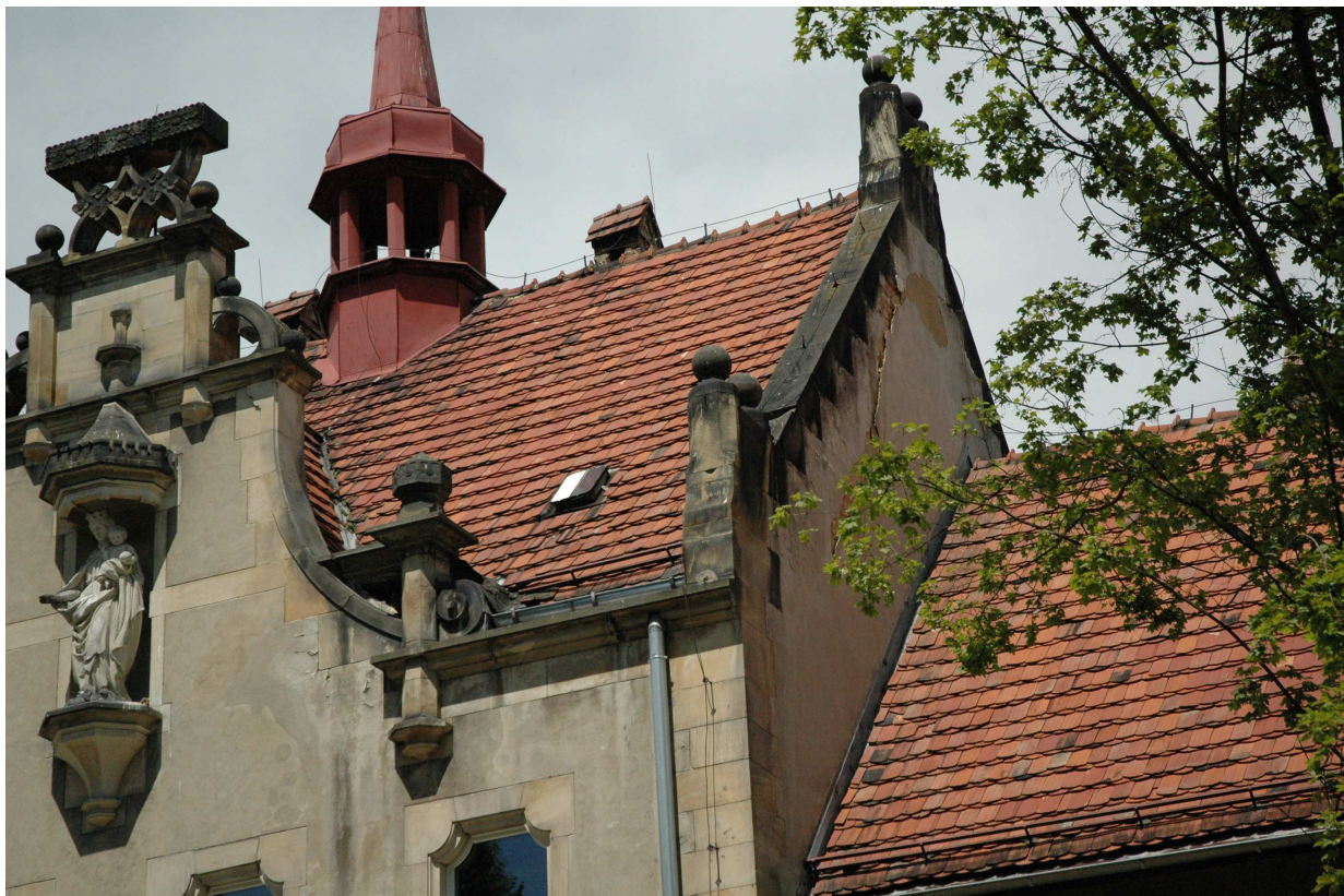
fot. nr 21 Szczyt wschodni widoczne ubytki tynku i luźne odspojenia
