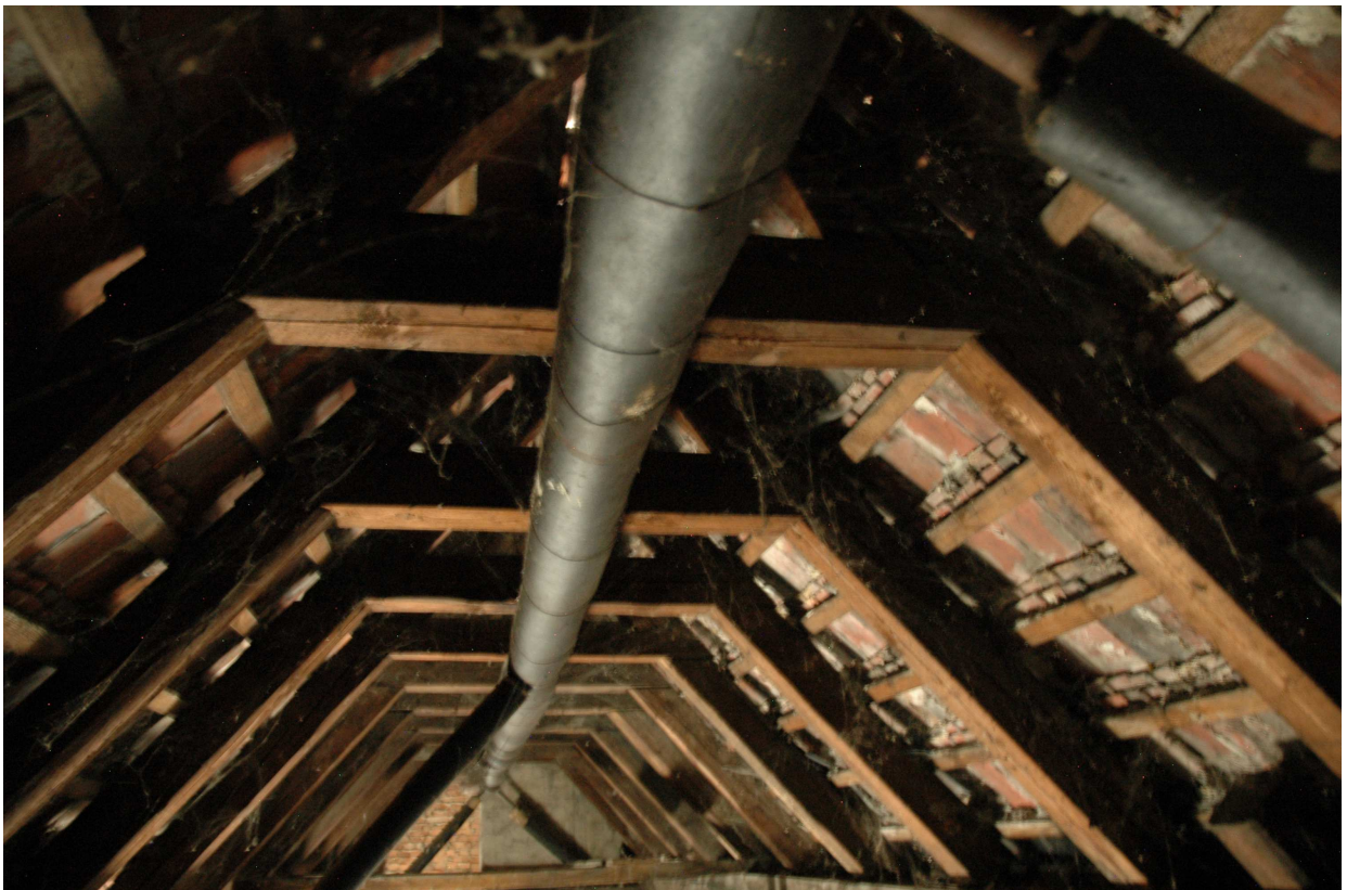
fot. nr 13 Widok na wiązary pełne skrzydła zachodniego - górna jętka (grzędą) w każdym wiązarze
