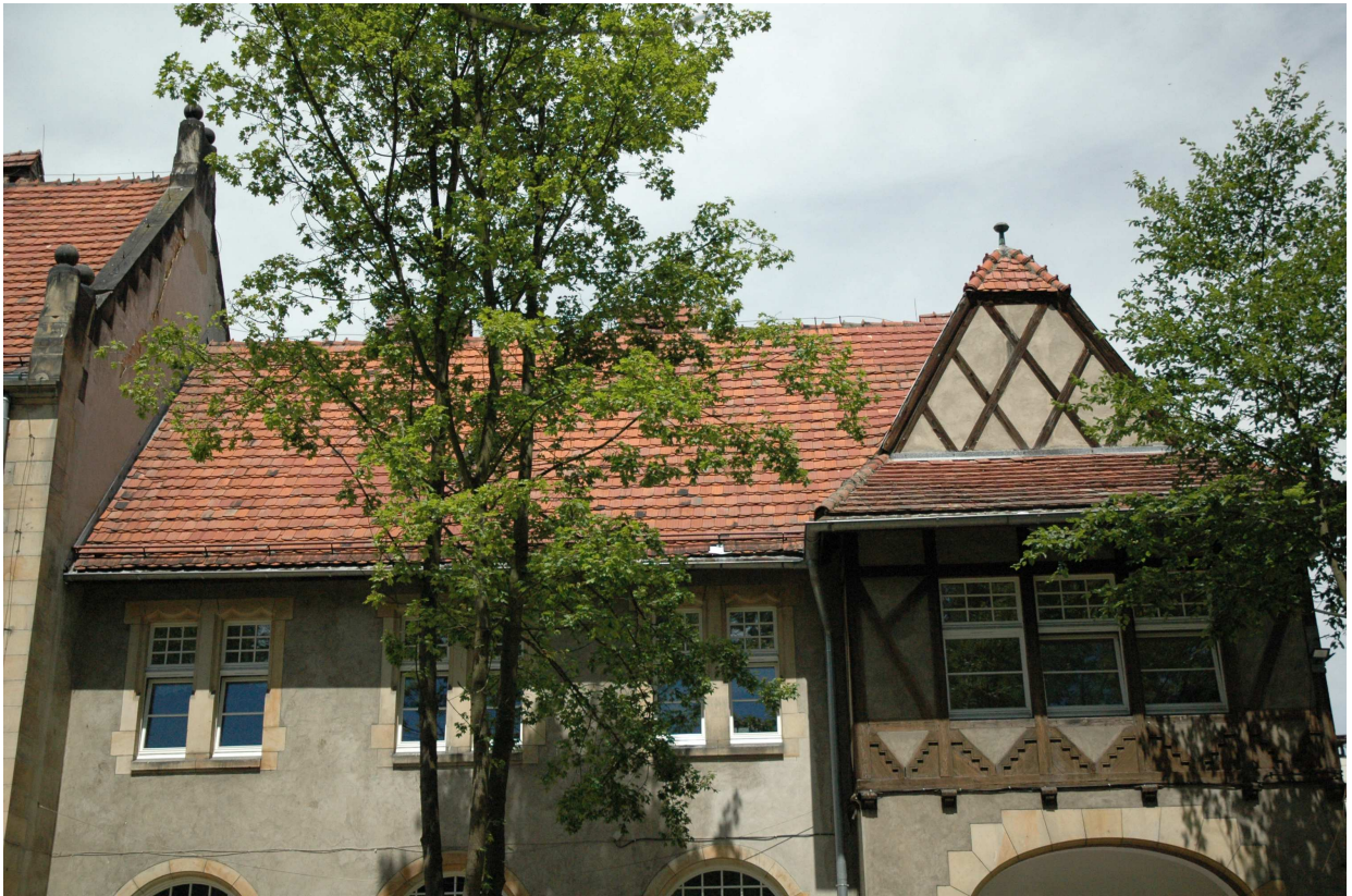
fot. nr 5 Widok dachu skrzydła wschodniego od strony południowej. Widoczny szczyt szachulcowy i dolny dach pulpitowy
