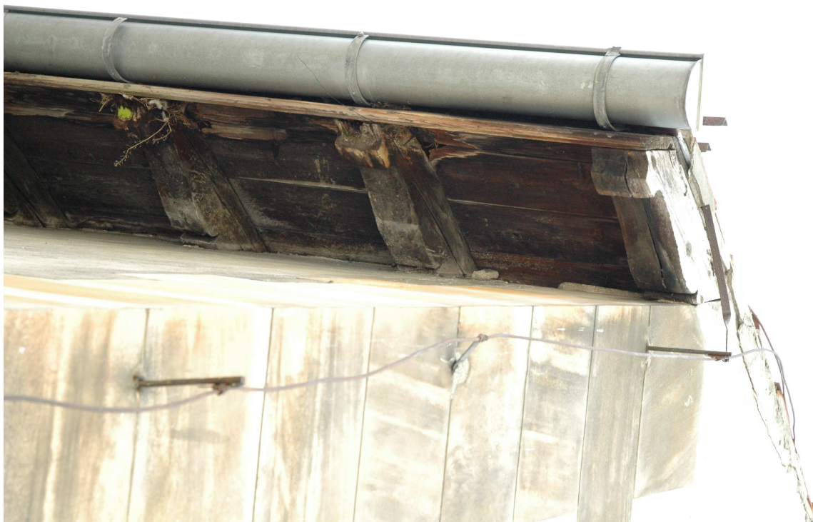
fot. nr 26 Zdobione końcówki krokwi, widoczna destrukcja zdobień oraz jeden zachowany profil
