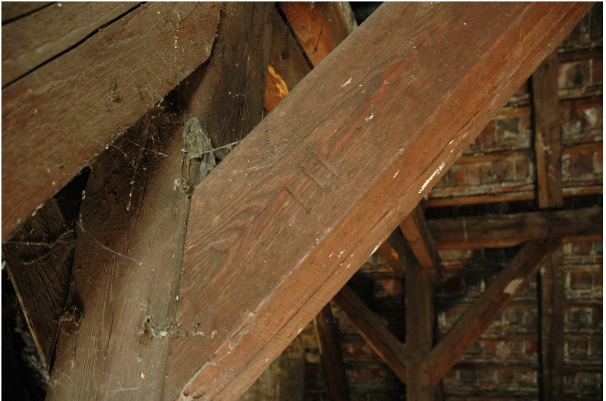
fot. nr 14 Oznaczenia ciesielskie wykonano kolejno na mieczach - nie ma numeracji całego więzara pełnego
