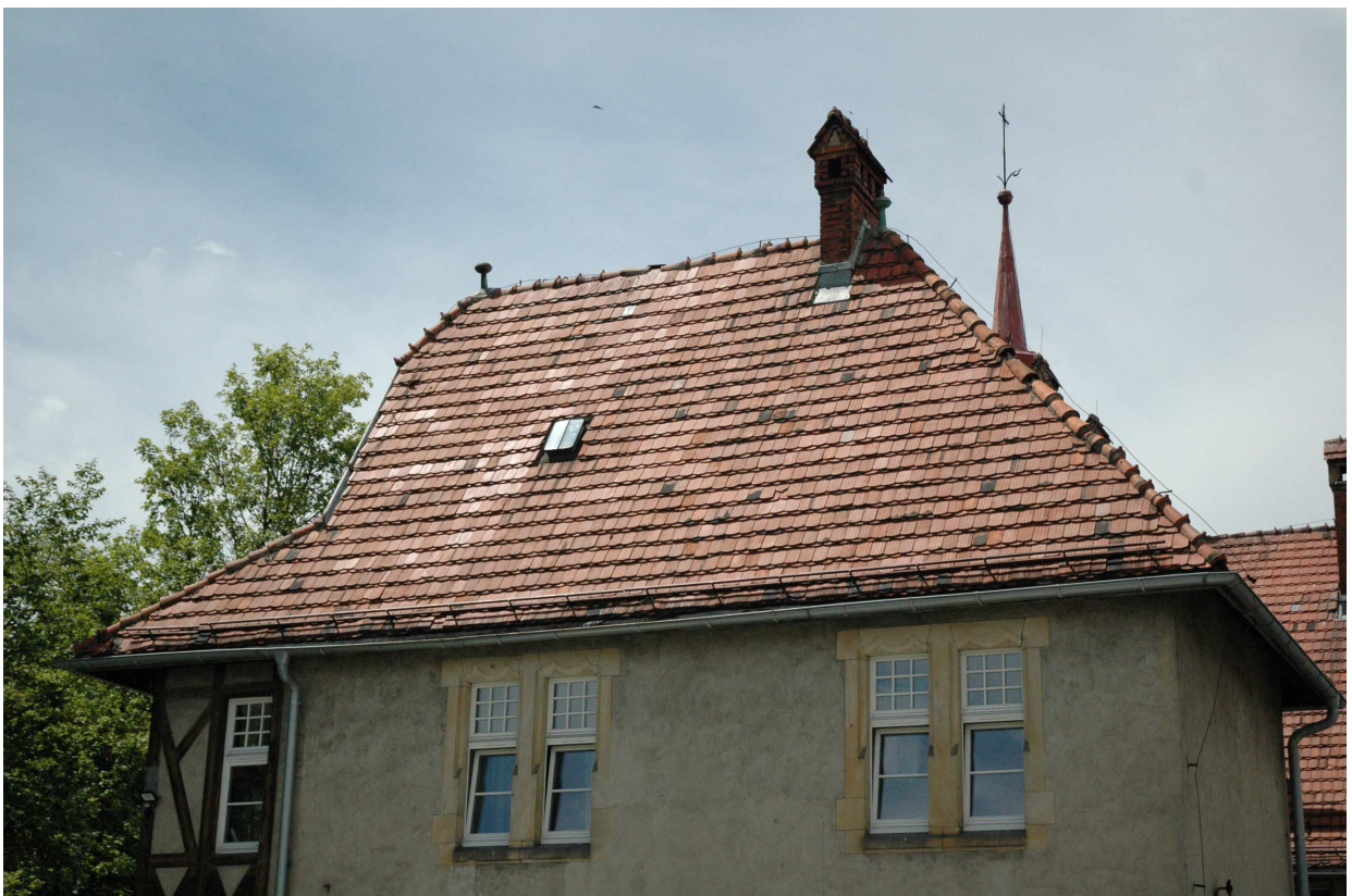
fot. nr 6 Widok dachu kopertowego skrzydła wschodniego od strony wschodniej.
