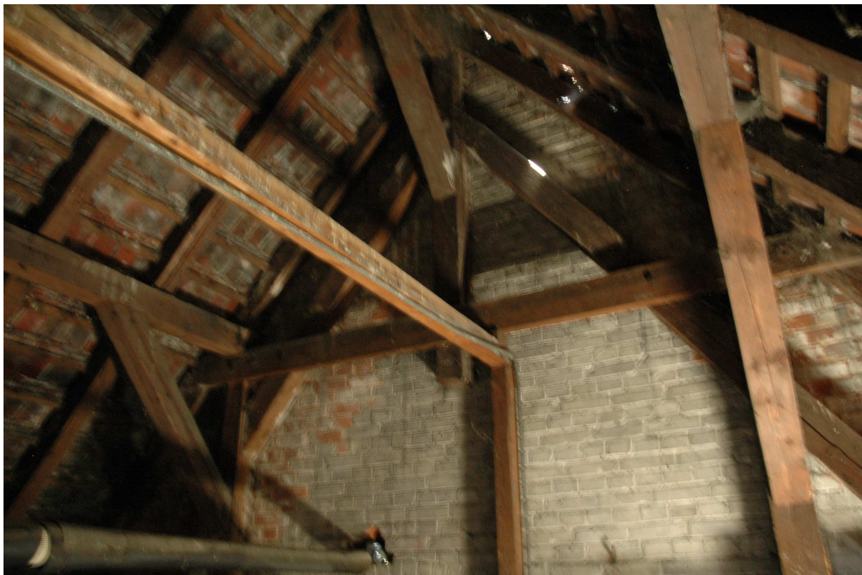
fot. nr 17 Wiązar przy ścianie szczytowej - zastrzały przechodzące do centralnie ustawionego wieszaka zredukowanego. Widoczna płatew kalenicowa z mieczem ramy podłużnej. Widoczne poniżej kleszczy elementy są wtórne i nie mają związku z układem konstrukcyjnym więźby
