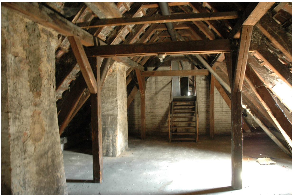
fot. nr 11 Widok na wiązary pełne skrzydła zachodniego - widoczne stolce boczne, kleszcze środkowe, miecze, płatwie połaciowe, zastrzały oraz górna jętka.
