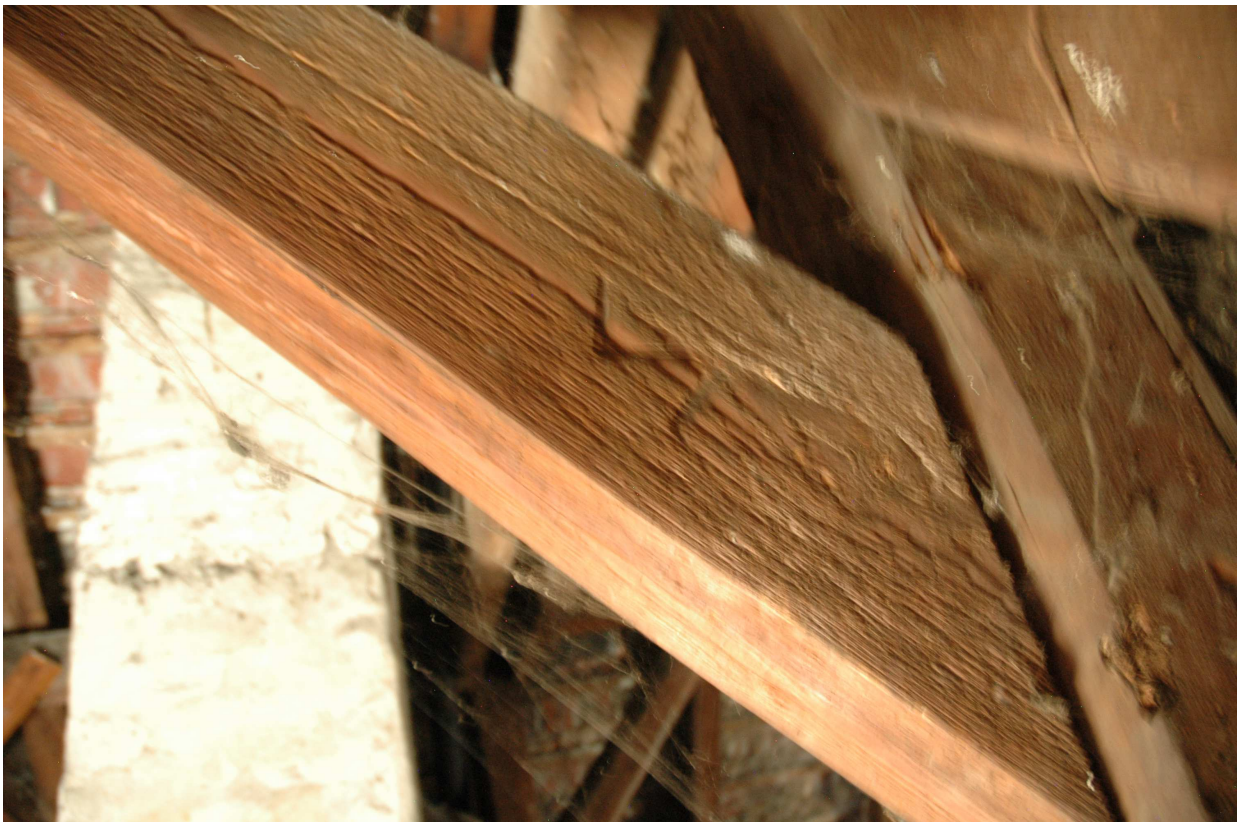
fot. nr 15 Oznaczenia ciesielskie wykonano kolejno na mieczach - nie ma numeracji całego więzara pełnego
