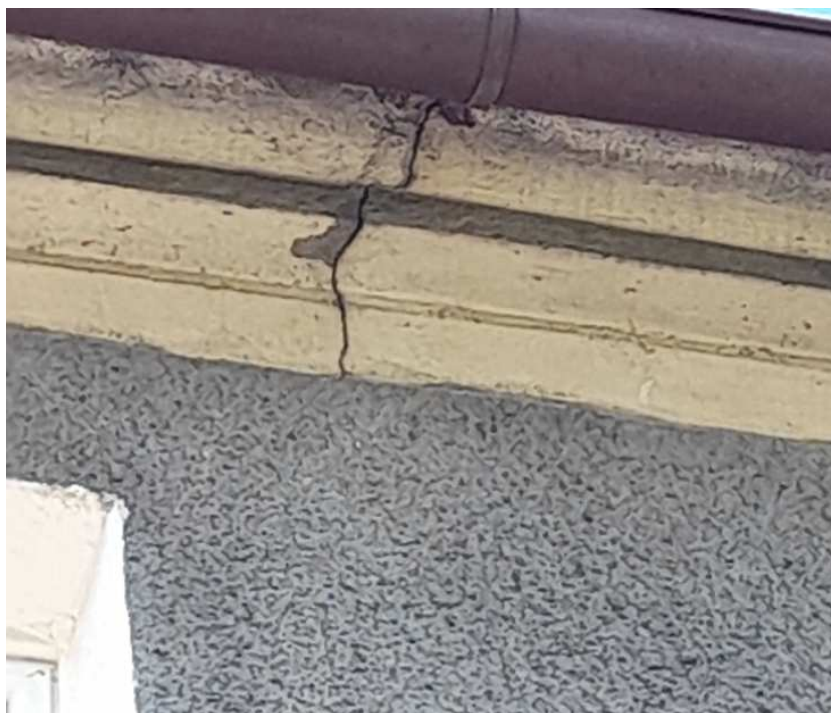
Fot. 1: „Spękanie gzymsu od strony elewacji południowo-wschodniej”
