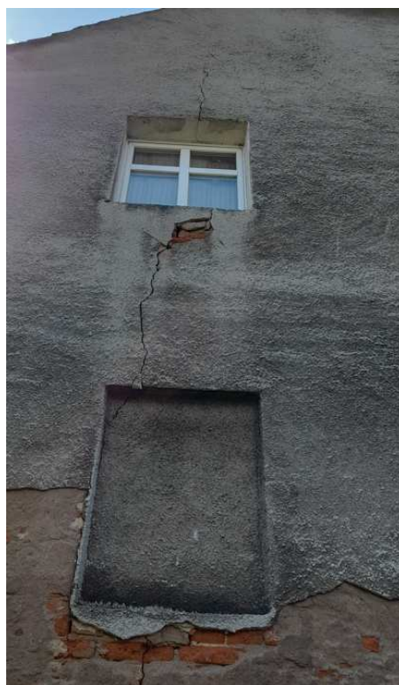
Fot. 2: „Spękanie elewacji szczytowej północno-wschodniej”
