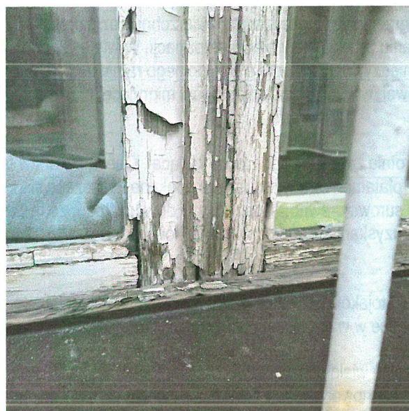
Fot.3 Stan zachowania listwy przymykowej i progu ościeżnicy
