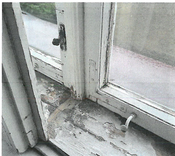
Fot. 9. Zasułka, kątowniki wzmacniające i odbojnik
