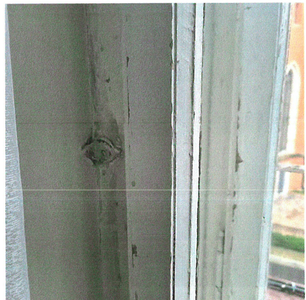
Fot. 13 Kotwa mocująca ościeżnicę w ścianie
