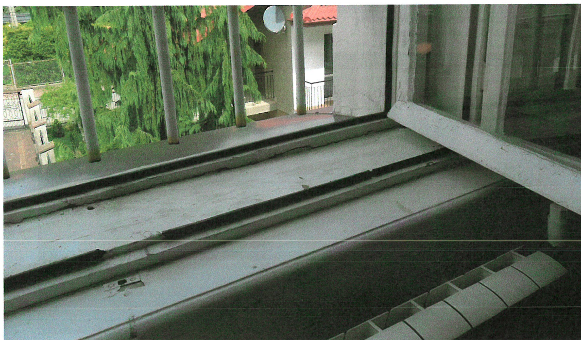
Fot.21 Wyraźnie widoczne wybrzuszenie ościeżnicy
