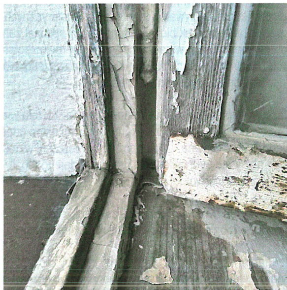
Fot.4 Stan zachowania progu i dolnej części słupka ościeżnicy
