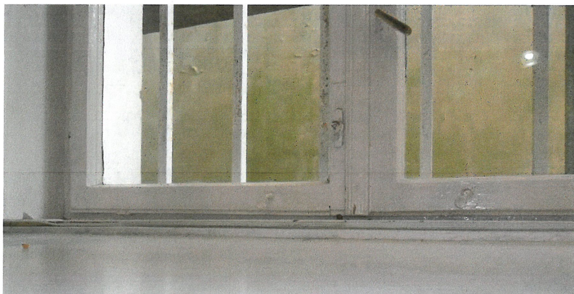
Fot. 18 Widoczny brak równoległości pomiędzy ramiakiem skrzydła a progiem ościeżnicy
