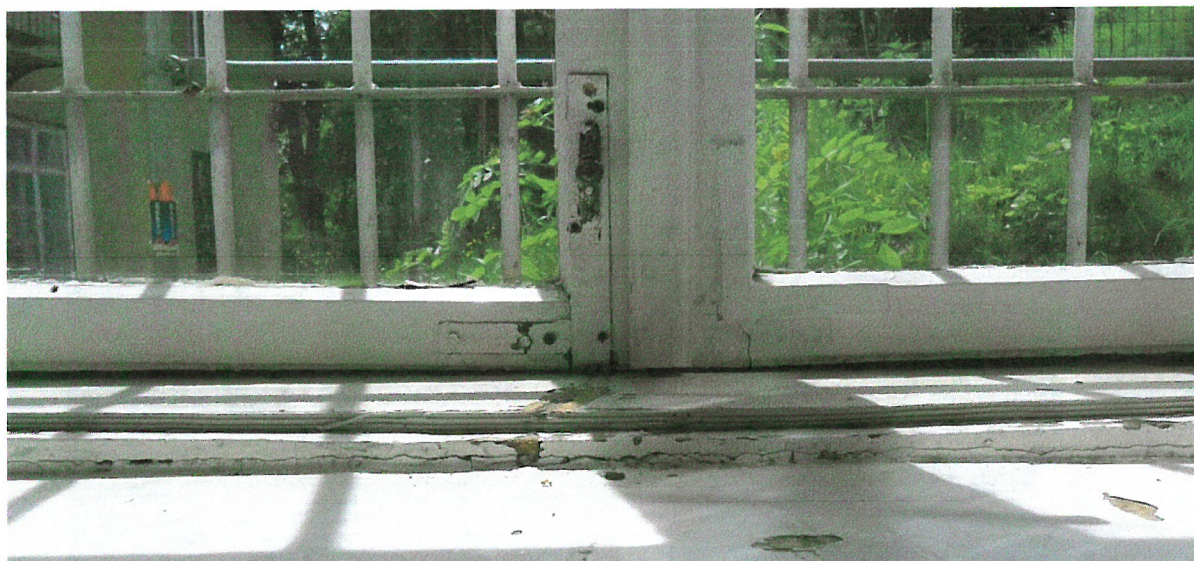
Fot.20 Ościeżnica wybrzuszona w części środkowej
