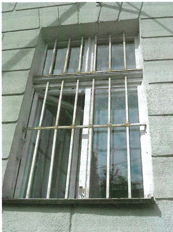
Fot. 2 okno z wymienionymi kwaterami dolnymi
