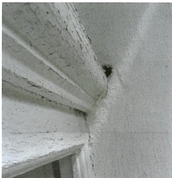
Fot.8 Profil ślemienia i wyłógów nadproża i słupków ościeżnicy
