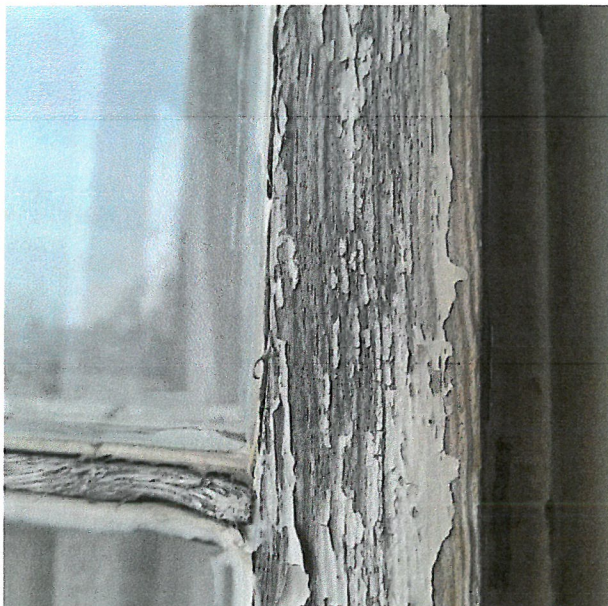
Fot. 5 Prawie całkowity brak warstw malarskich na ramiaku zewnętrznych skrzydeł
