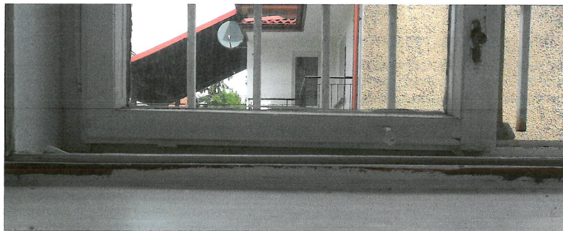
Fot. 19 Widoczny brak równoległości pomiędzy ramiakiem skrzydła a progiem ościeżnicy
