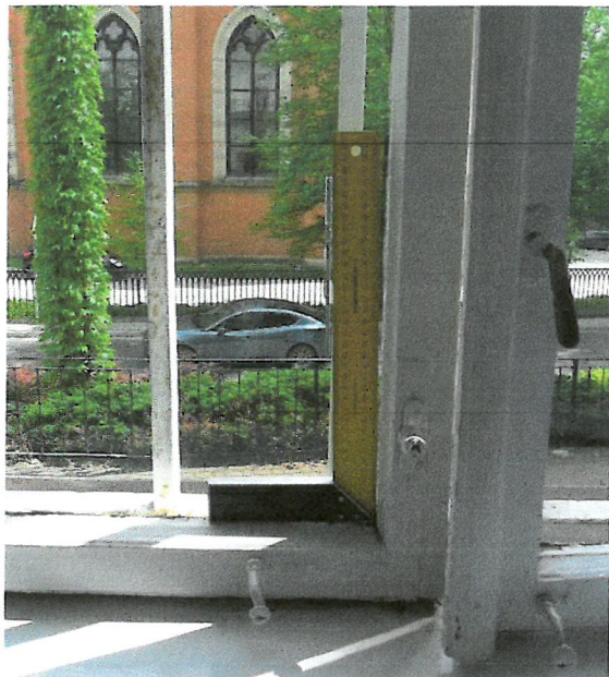
Fot. 16, 17 Skrzydła wewnętrzne, które utraciły właściwą geometrię – widoczny brak kąta prostego pomiędzy ramiakami
