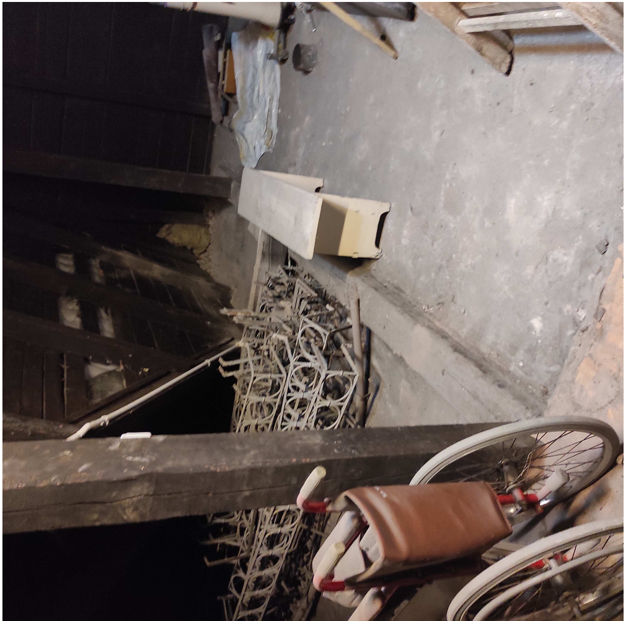
Fot.3 Widok tramów i stojących na nich słupów podpierających konstrukcję dachową.
