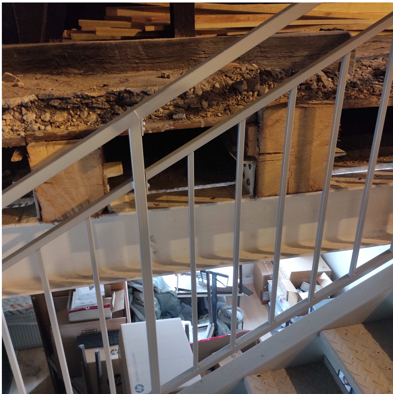
Fot.2 Widok belki stropowej i tramu w przekroju przy nowych schodach stalowych.
