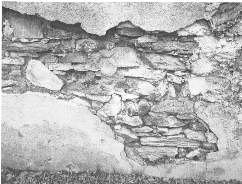
Fragment muru, wątek i ślady użycia zaprawy klejowej
