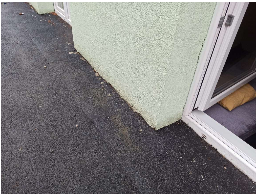
Zdjęcie nr 9 – Widok obróbki dachu „łącznika” ze ścianą od strony części internatu
