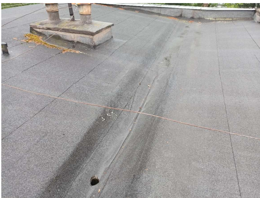
Zdjęcie nr 6 – Istniejące obrobienie kosza zlewowego oraz wpust dachowy części wyższej „internat”
