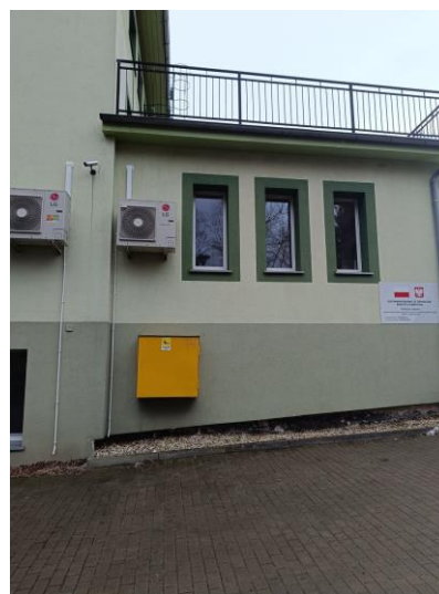
Skrzynka z głównym zaworem gazu zlokalizowanym na elewacji północnej pawilonu B. Gaz ziemny w budynku pawilonu B służy do zasilania urządzeń kuchennych.
