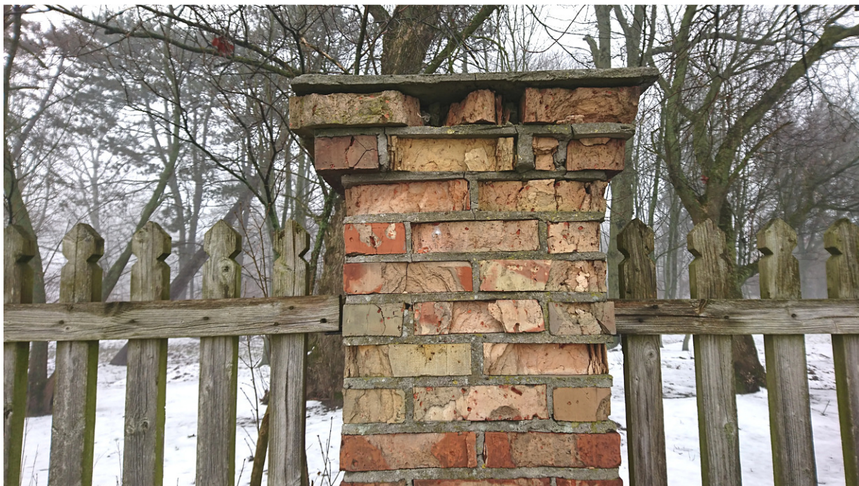
Zniszczenia cegieł i drewna.
