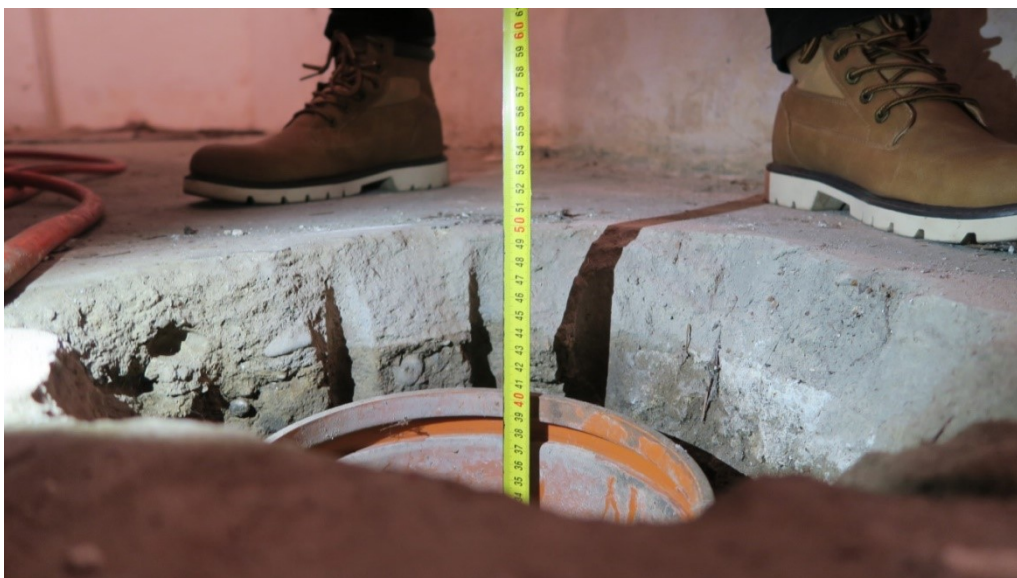
Zdjęcie 2. Poziom wody gruntowej w pom. magazynu oleju na wysokości 50 cm od górnego poziomu podłogi betonowej
