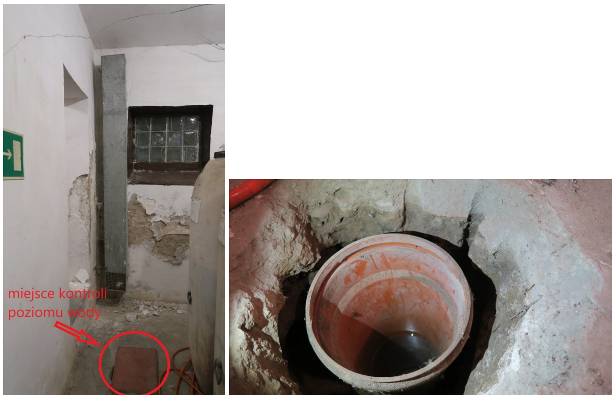
Rys. 3. Miejsce kontroli poziomu wody przy wejściu do pom. magazynu oleju
