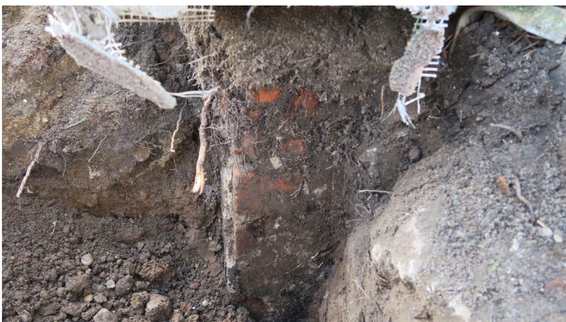
Zdjęcie 3. Brak izolacji przeciwwilgociowej i termicznej ścian fundamentowych oraz izolacja termiczna cokołu zakończona na poziomie gruntu.
