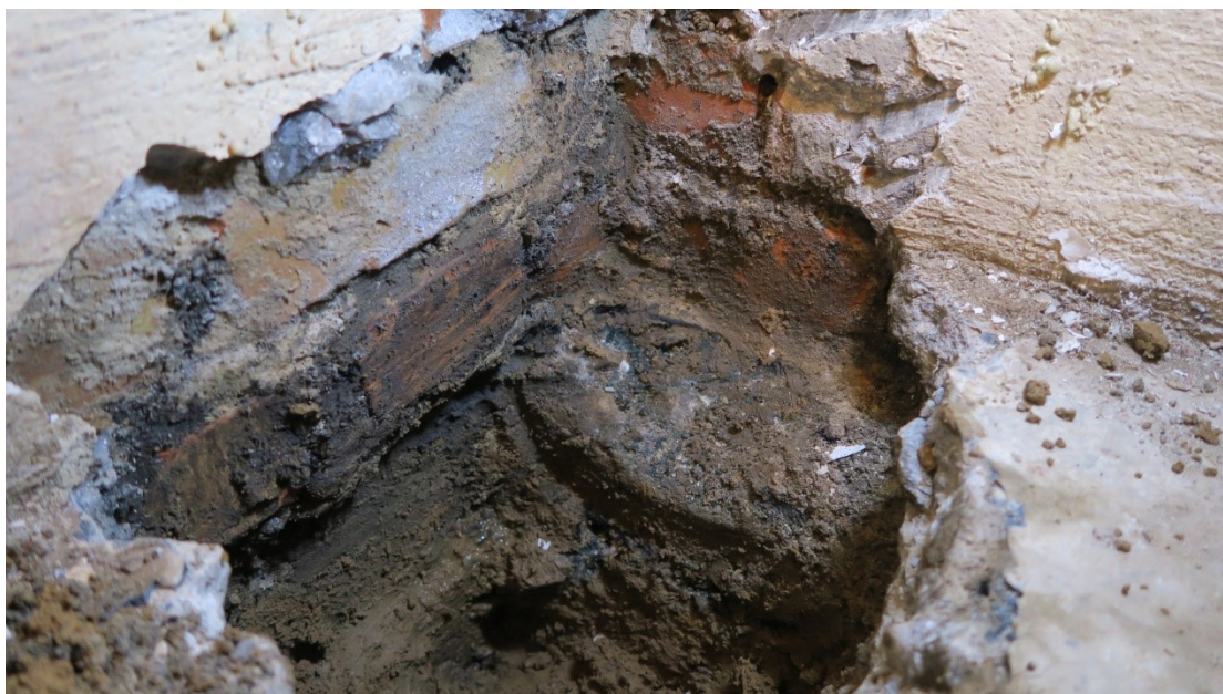
Zdjęcie 1. Odkrywka tynku w pom. magazynu oleju w narożniku przy połączeniu podłogi betonowej i ściany
