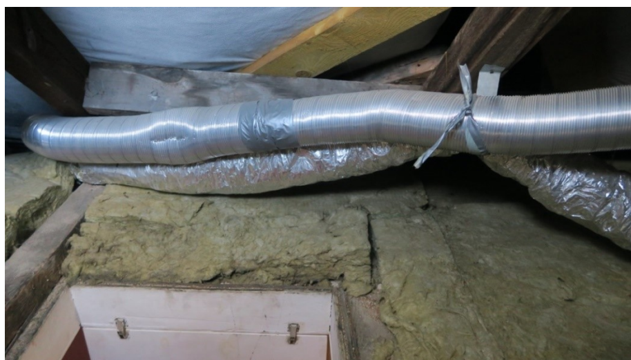
Rys. 6. Poziome ułożenie rur wentylacyjnych na poddaszu nieużytkowym bez izolacji termicznej
