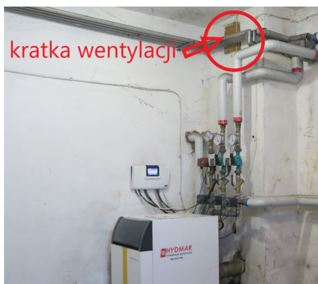
Rys. 5. Zasłonięta kratka wentylacyjna w pom. kotłowni. W ten sam kanał wpięto rurę odprowadzenia spalin z pieca olejowego
