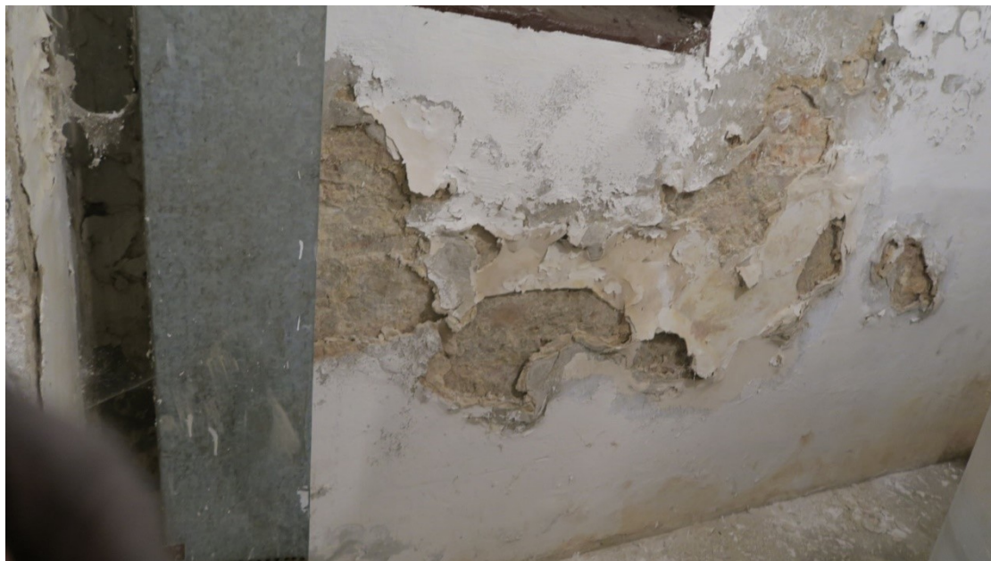
Rys. 4. Odspojenia tynków na ścianach w A. kotłowni oraz B. magazynie oleju
