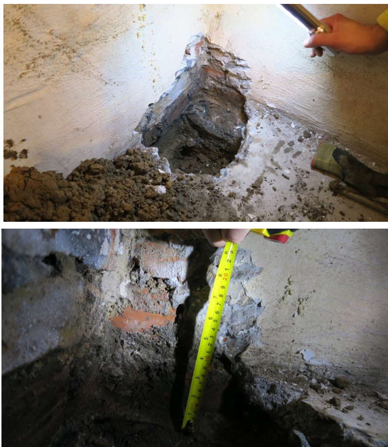
Rys. 2. Odkrywka w pom. magazynu oleju pod ścianą fundamentową, zewnętrzną (narożnik pomieszczenia)
