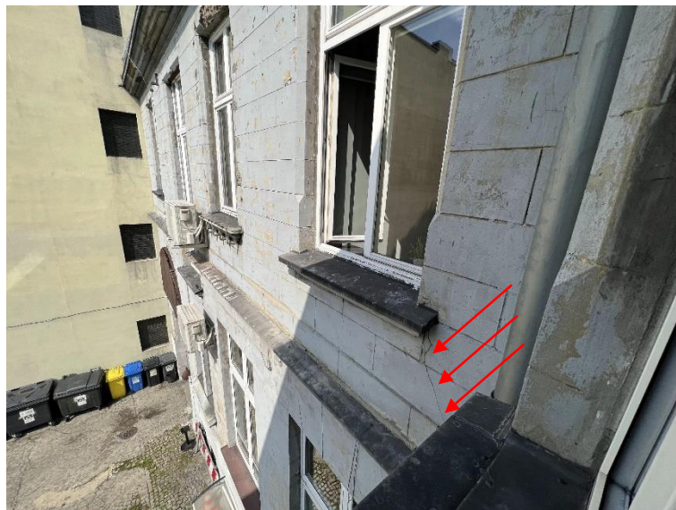
Fot. 5.1-2: Ukośne zarysowanie ściany zewnętrznej pod otworem okiennym
