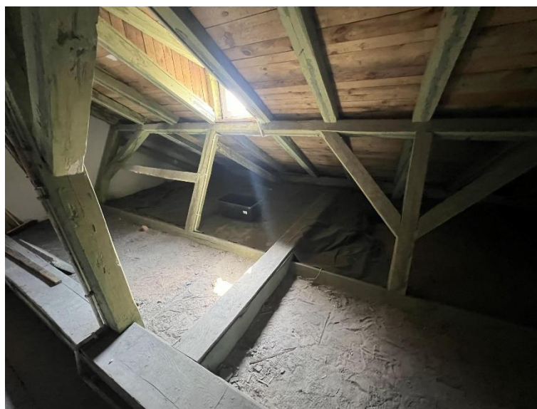
Fot. 5.3-1: Konstrukcja dachu widoczna z poddasza nieużytkowego
