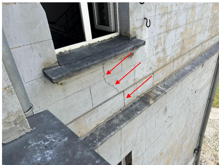
Fot. 5.1-3: Zarysowanie ściany zewnętrznej pod otworem okiennym
