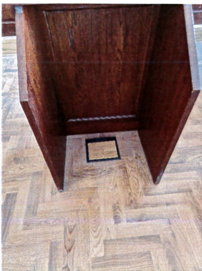
Puszka instalacyjna przy pulpicie świadka – wykończenie zbieżne z warstwą posadzki - przykład.
