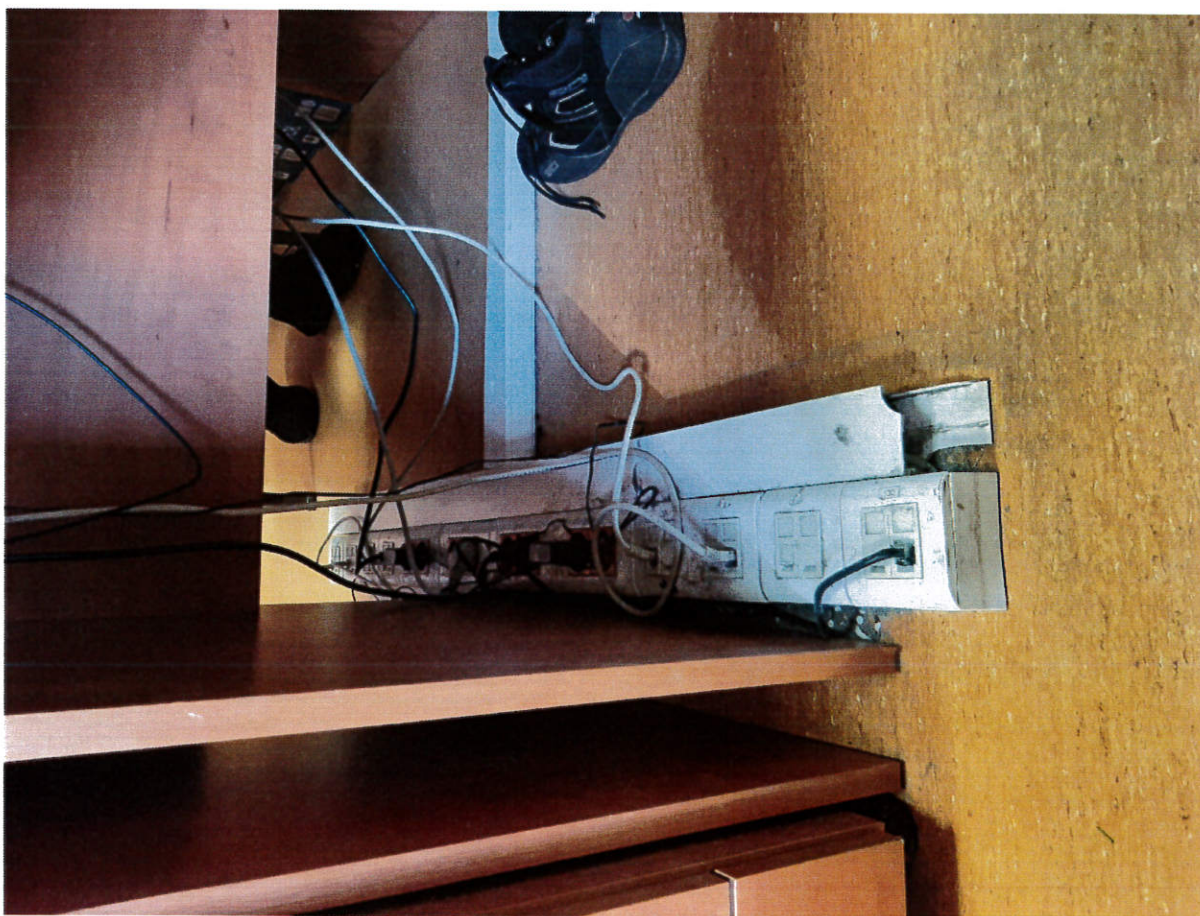
Zestaw gniazd elektrycznych i teletechnicznych do przeniesienia na ścianę.
