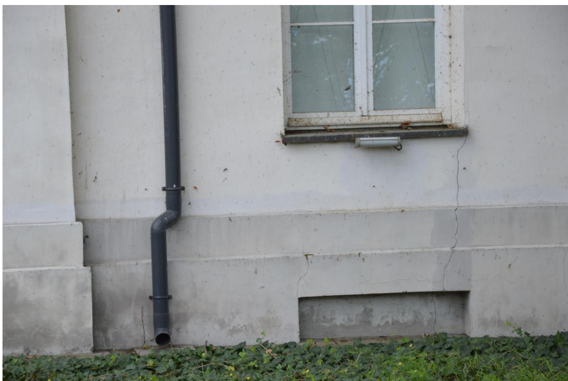
Fot. 34 i 35. Pęknięcia w ścianie południowo-zachodniej
