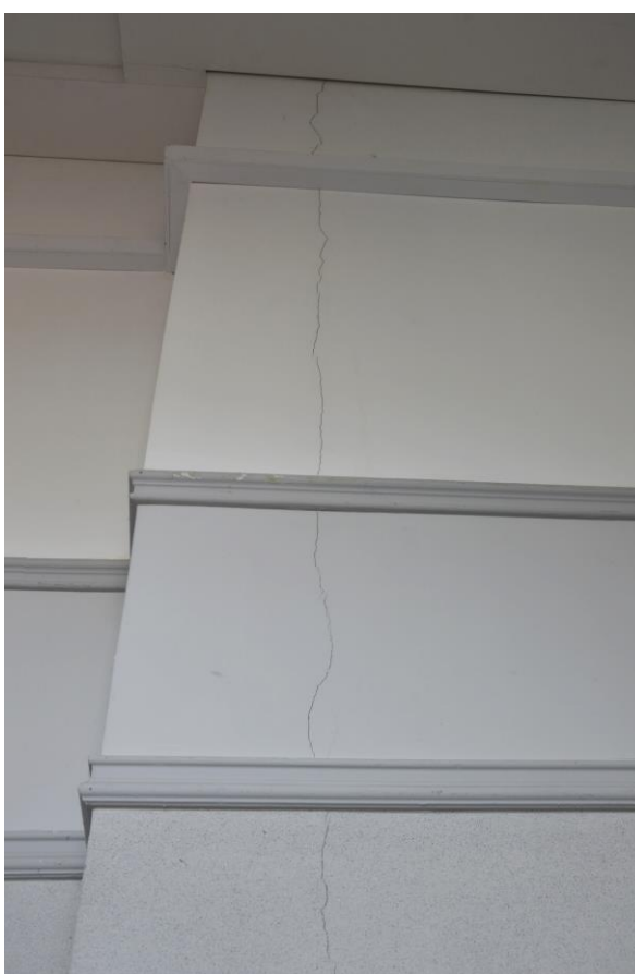
Fot. 18 i 21. Pęknięcia ściany wewnętrznej piętra
