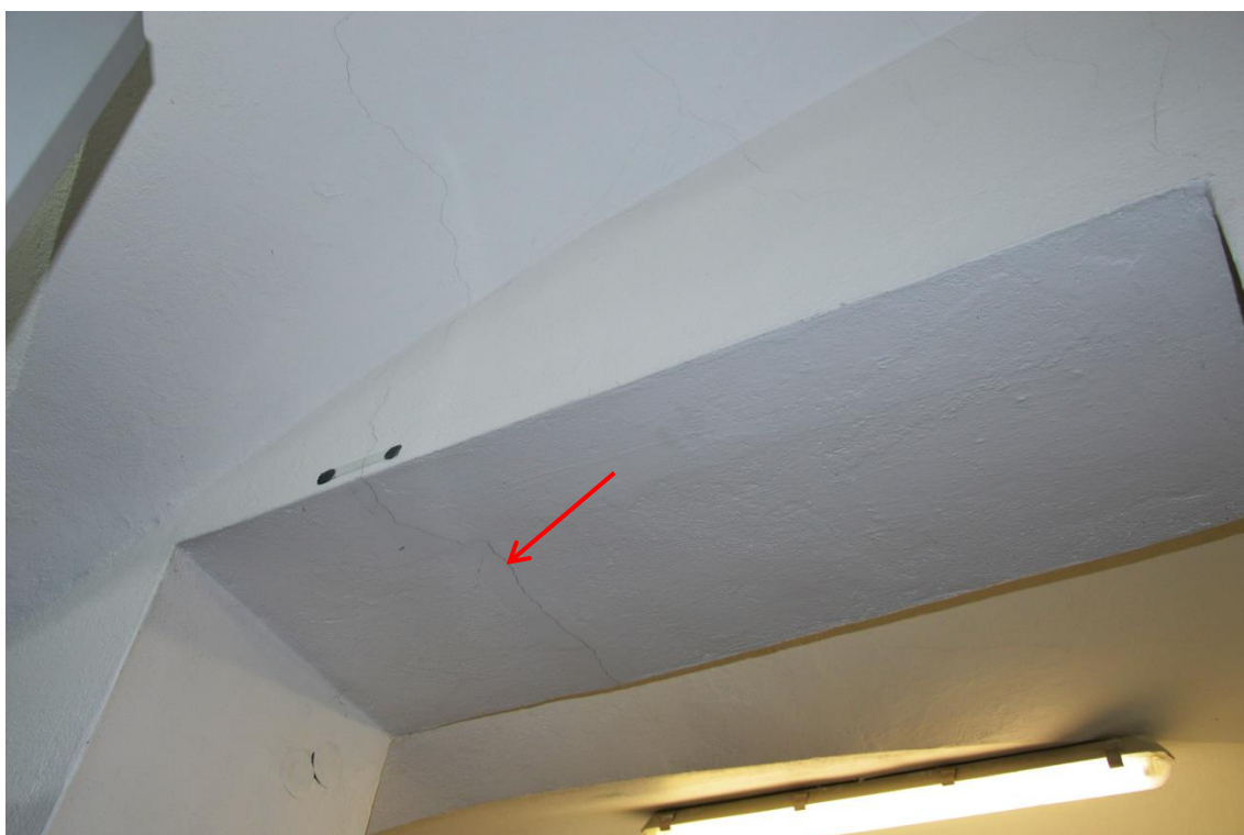
Fot. 1 i 2. Pęknięcia nadproży na parterze
