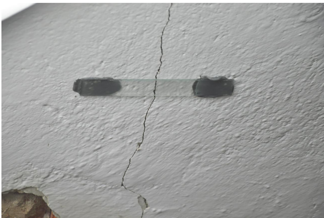
Fot. 11. Nieuszkodzona plomba kontrolna na sklepieniu
