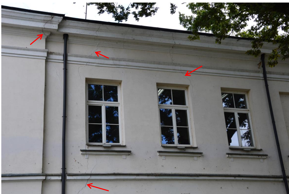
Fot. 32. Liczne pęknięcia i rysy w ścianie południowo-zachodniej
