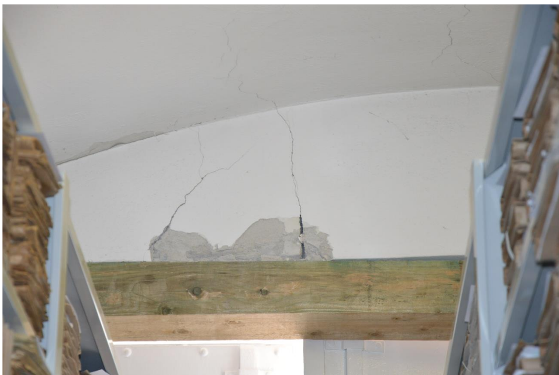
Fot. 5. Pęknięcie nadproża okiennego na parterze – widoczne podparcie
