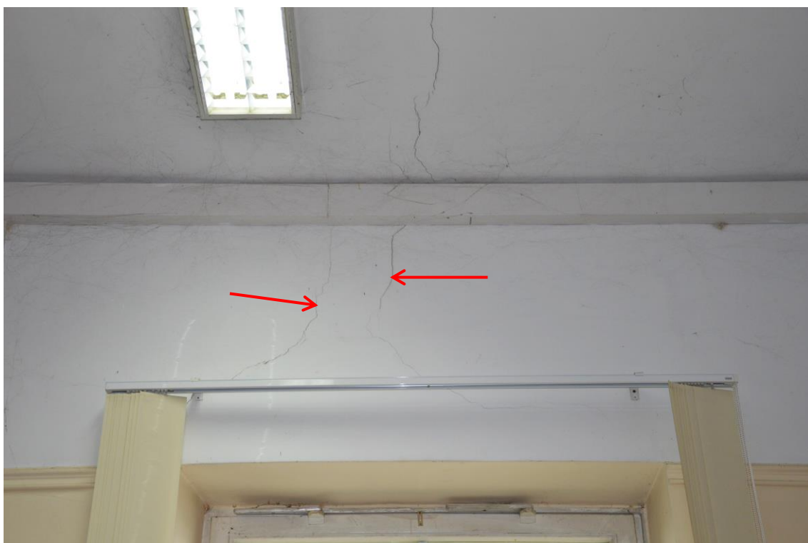
Fot. 26. Pęknięcia nadproża piętra
