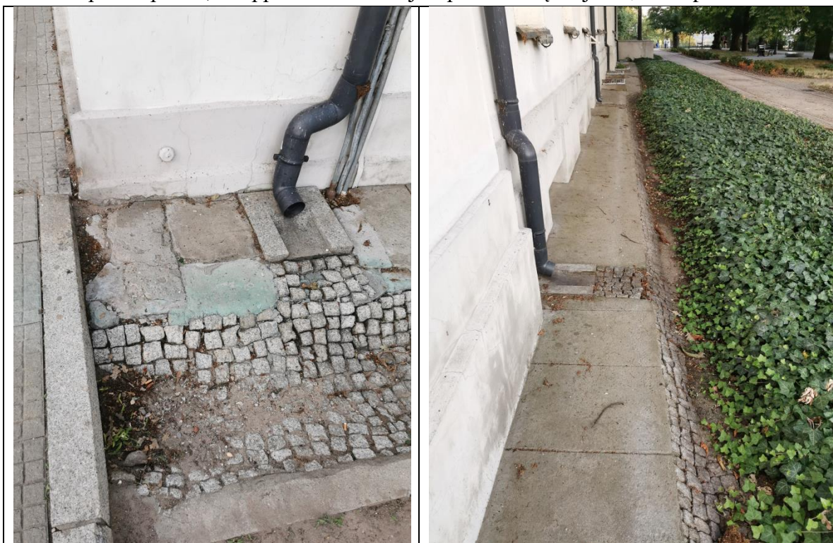
Odprowadzenie wody opadowej od strony skarpy
