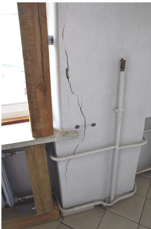
Fot. 29. Pęknięcie krawędzi filara międzyokiennego piętra
