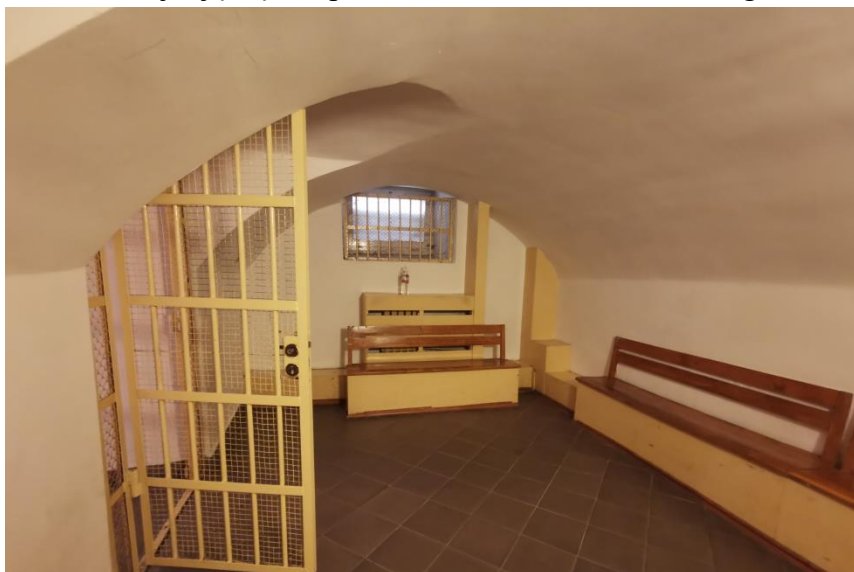
Sklepienie kolebkowe nad piwnicą
