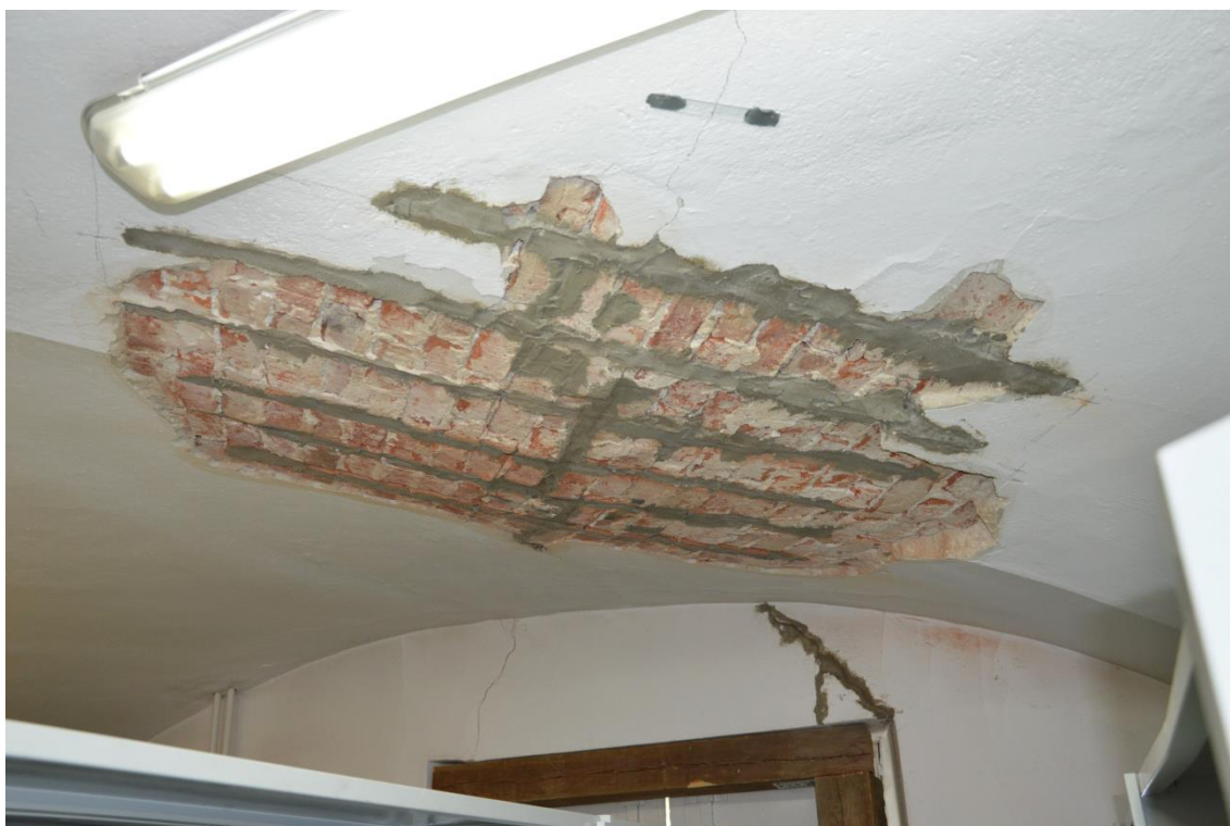
Fot. 10. Wzmocniony fragment sklepienia parteru
