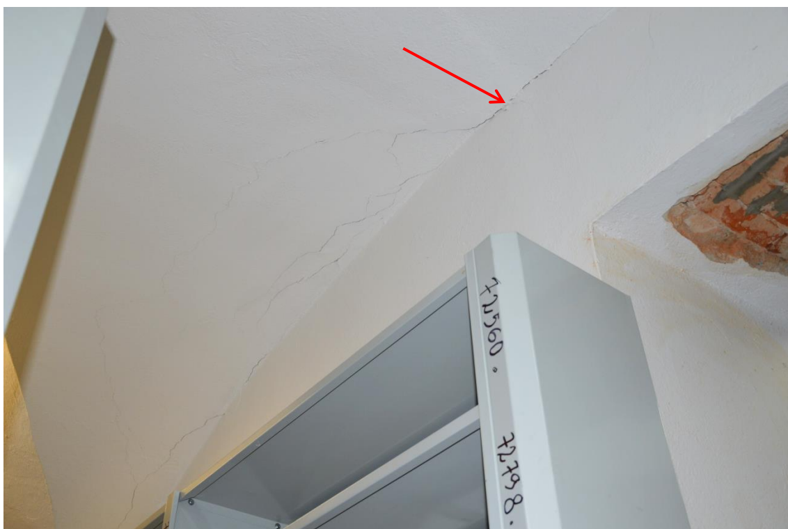
Fot. 7. Pęknięcie na styku sklepienia i ściany na parterze
