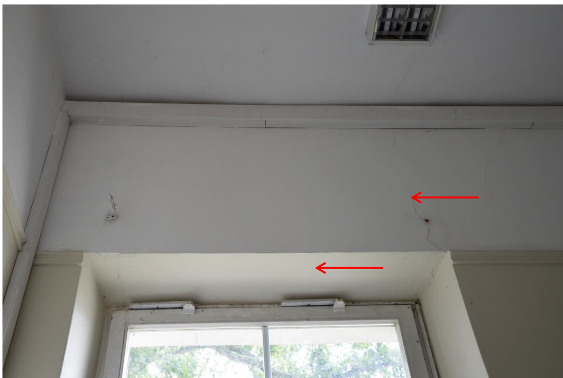
Fot. 24. Pęknięcia nadproża piętra
