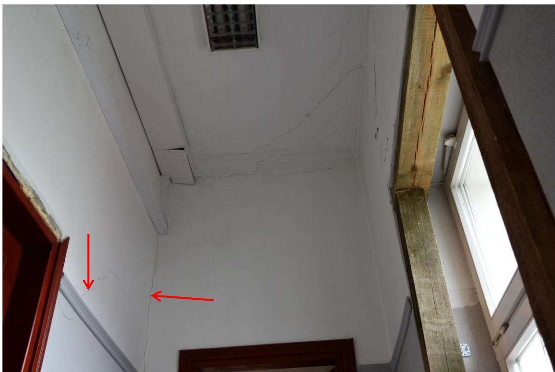
Fot. 29. Pęknięcie na styku ściany poprzecznej i podłużnej oraz skośne przy drzwiach piętra
