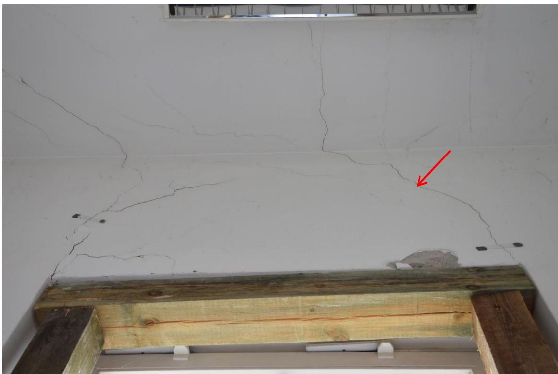
Fot. 28. Spękane i podparte nadproże piętra
