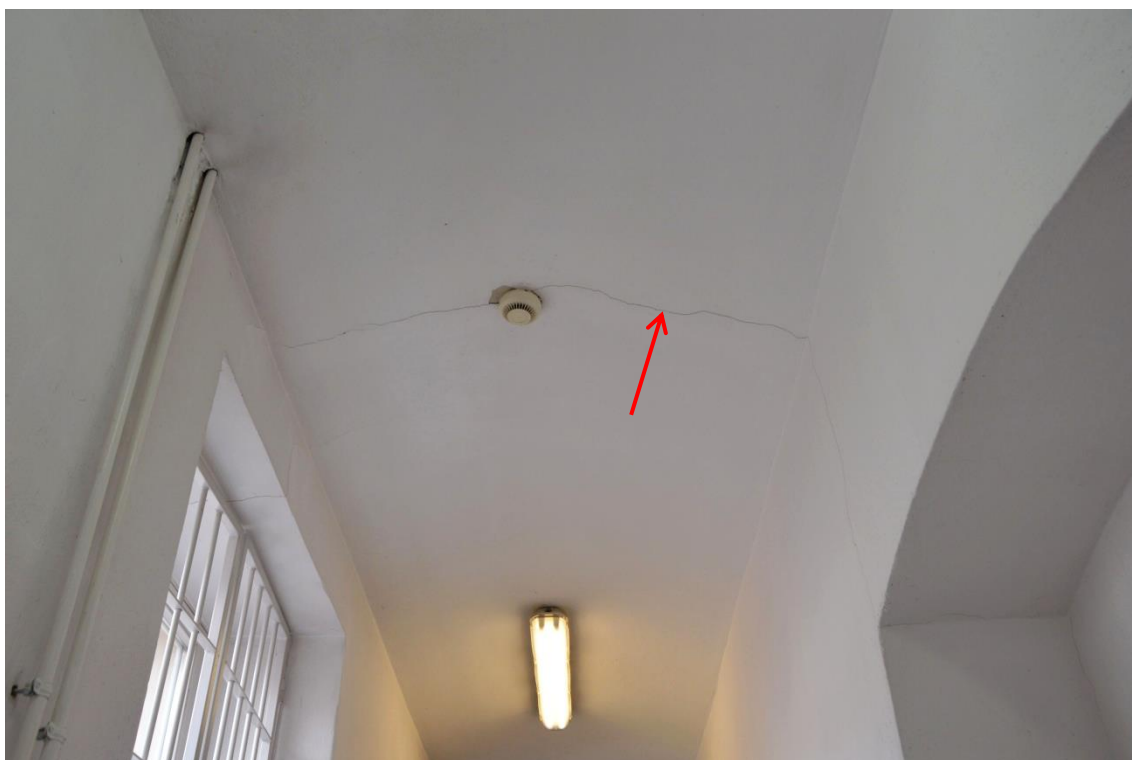
Fot. 13. Pęknięcie sklepienia w korytarzu parteru
