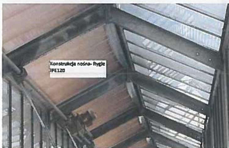
Zdjęcie 11-Konstrukcja nośna- Rygle IPE120
