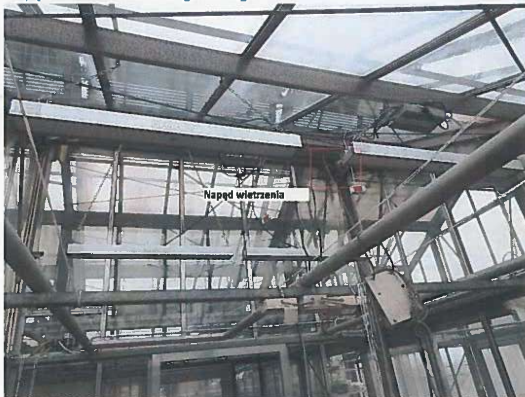
Zdjęcie 35-Napęd wietrzenia dachowego w boksach
