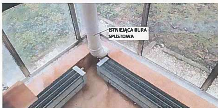
Zdjęcie 32-Istniejąca wewnętrzna rura spustowa
