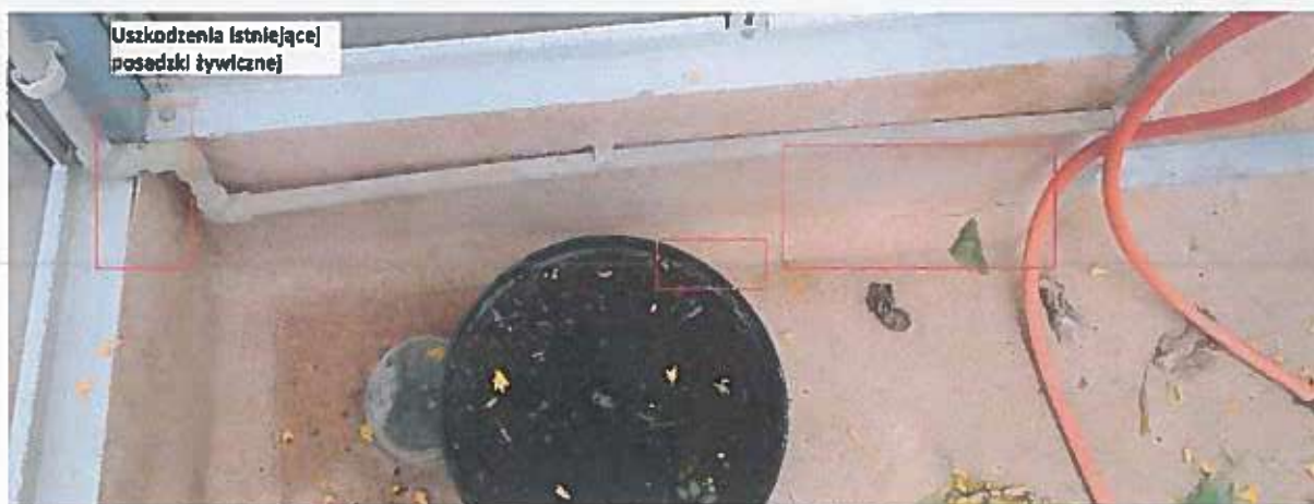
Zdjęcie 26 Uszkodzenia istniejącej posadzki żywicznej
