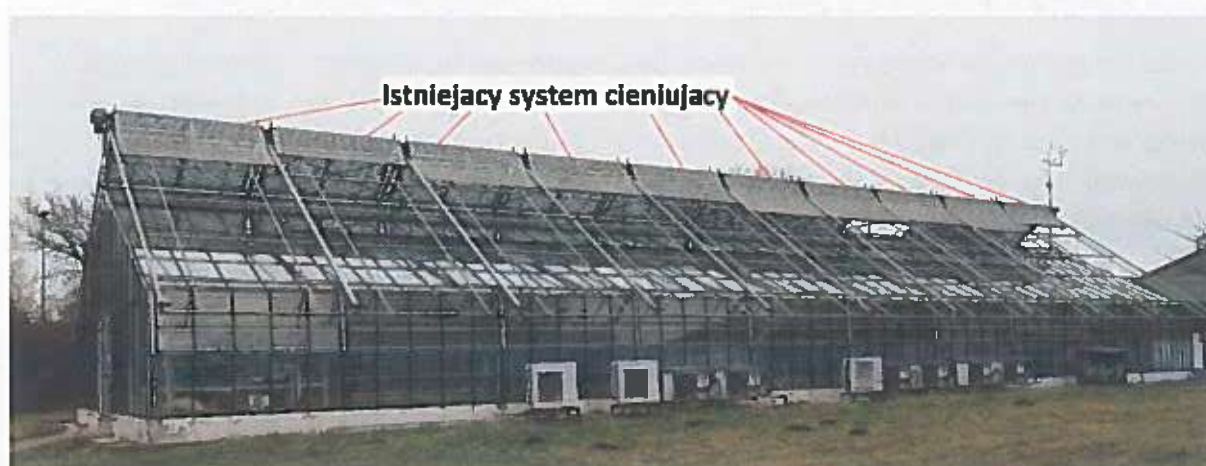
Zdjęcie 41-Istniejący system cieniujący
