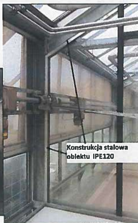
Zdjęcie 10-Konstrukcja stalowa- słup i rygiel
