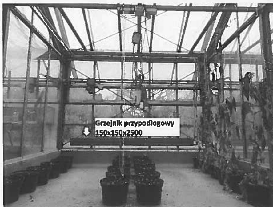
Zdjęcie 20 Instalacja CO- grzejnik przypodłogowy
