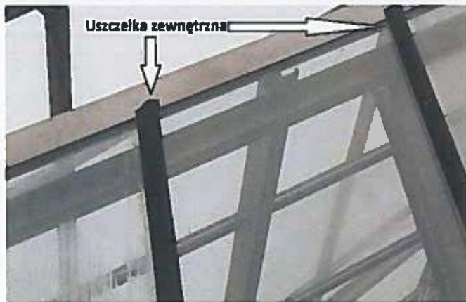
Zdjęcie 6 Istniejące uszczelki zewnętrzne
