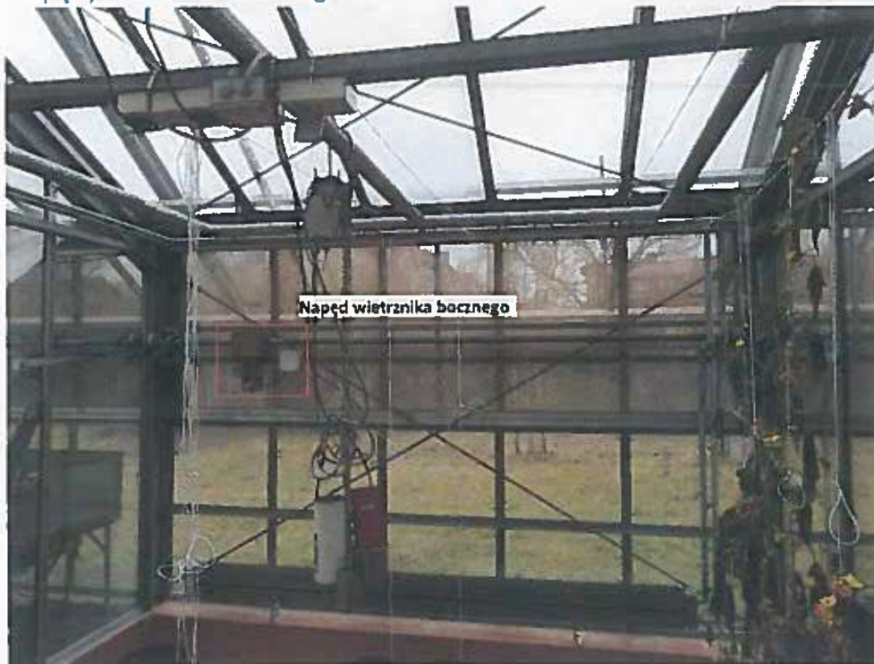
Zdjęcie 33-Istniejące napędy wietrzników bocznych
