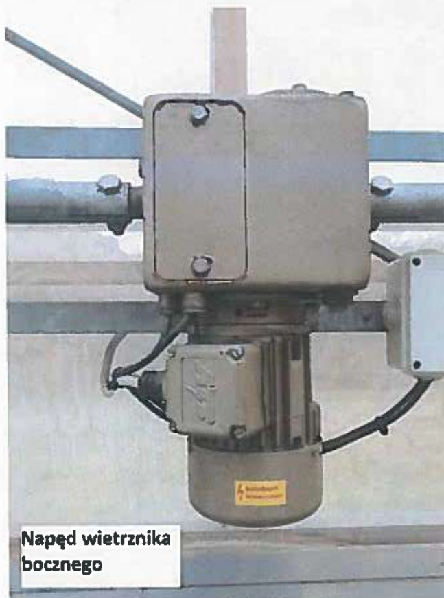
Zdjęcie 34 Napęd wietrznika bocznego
