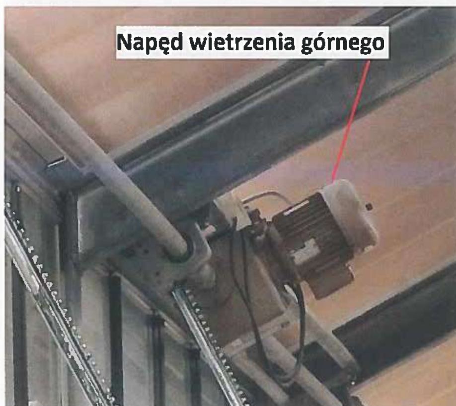
Zdjęcie 38 – Napęd wietrznika górnego
