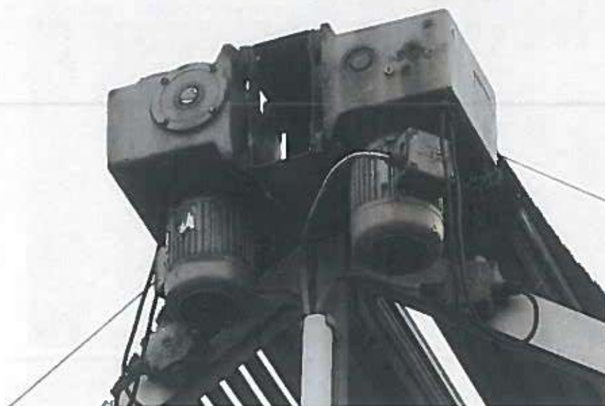
Zdjęcie 42-Napęd systemu cieniującego
