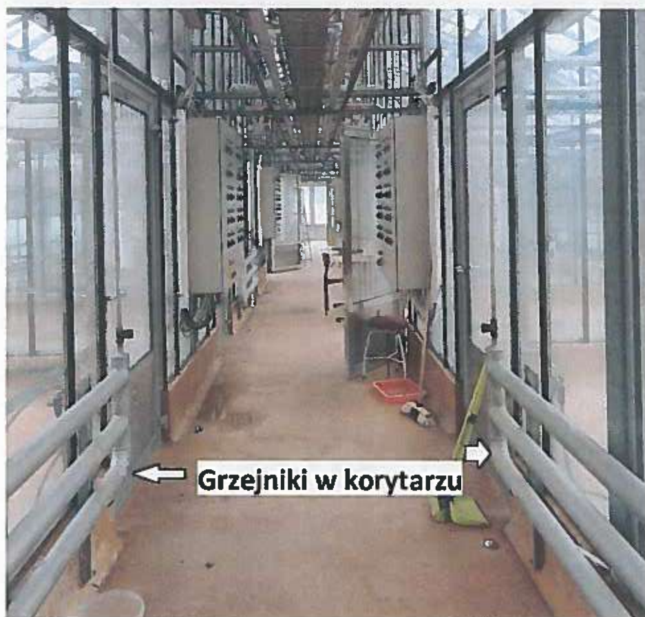
Zdjęcie 22 Instalacja CO- grzejniki w korytarzu
