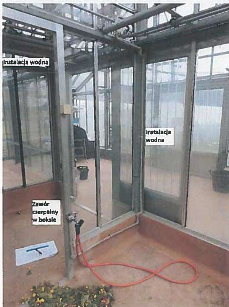
Zdjęcie 18 Instalacja wodna w boksie
