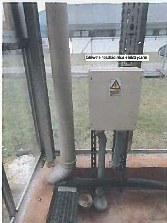
Zdjęcie 14 Główna rozdzielnica elektryczna
