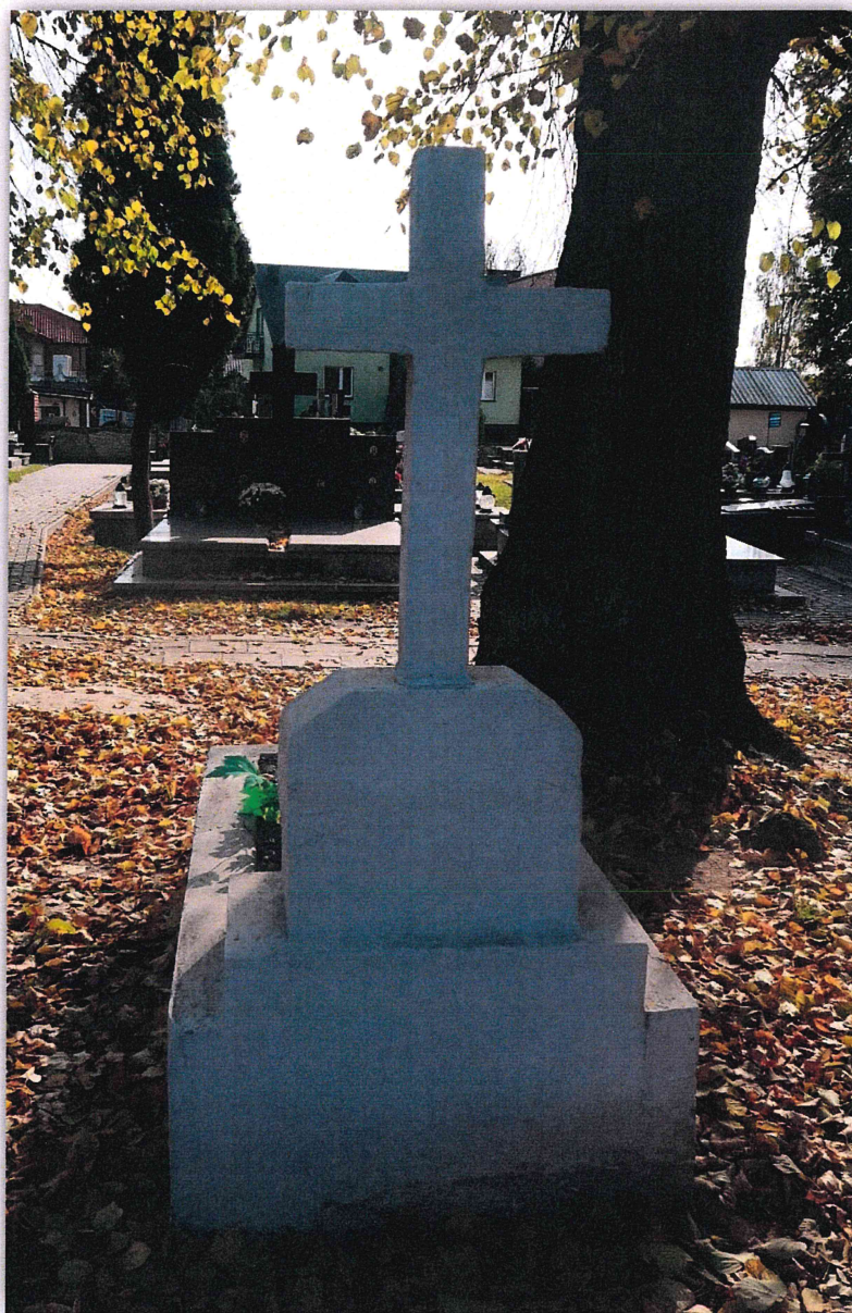
Fot. 4. Nagrobek „A”. Stan zachowania przed konserwacją. W tylnej części nagrobka widoczne złuszczenie powłoki malarskiej w przyziemiu. Październik 2021 rok.
