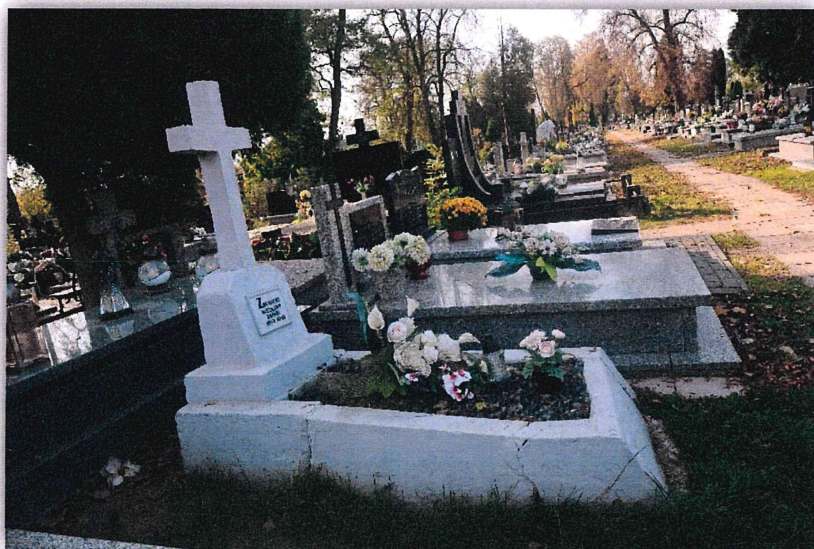
Fot. 13. Nagrobek „C”. Stan zachowania przed konserwacją. Widoczne pęknięcia boku nagrobka wraz z przesunięciem elementów. Październik 2021 rok.
