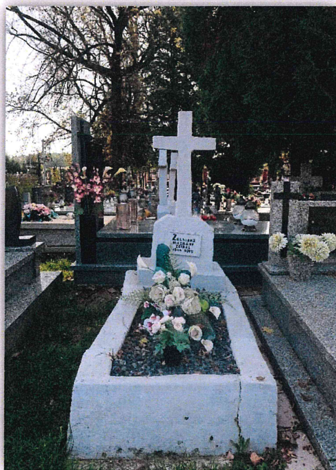
Fot. 11. Nagrobek „C”. Stan zachowania przed konserwacją. Na zdjęciu widoczne przechylenie nagrobka wraz z przemieszczeniem i pęknięciami poszczególnych elementów. Brak zachowania poziomu i pionu podstawy betonowego krzyża. Październik 2021 rok
