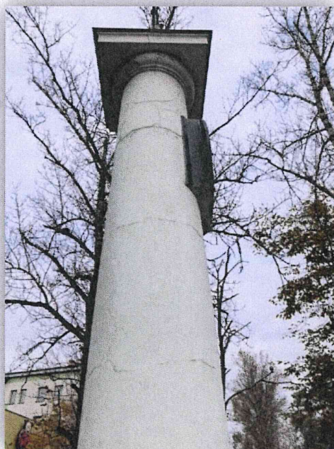
Fot. 13. Widoczne liczne spękania powierzchni kolumny. Październik 2021 rok.
