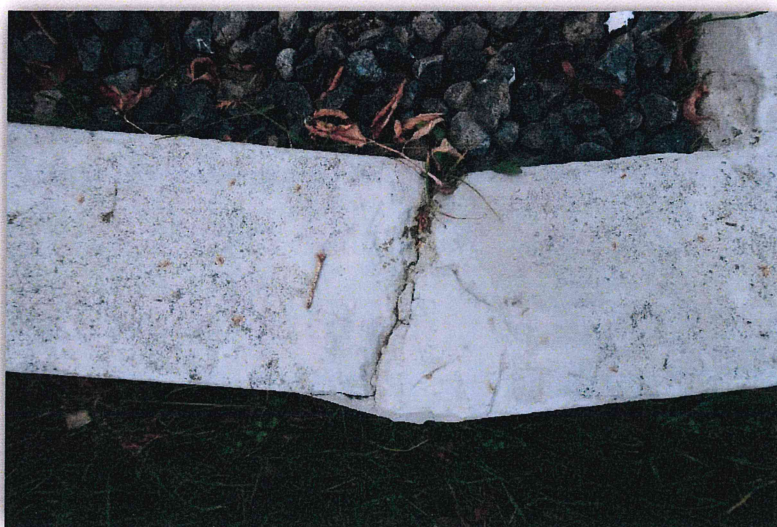
Fot. 12. Nagrobek „C”. Stan zachowania przed konserwacją. Widoczne przesunięcie bloku nagrobka. Październik 2021 rok.
