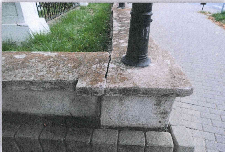
Fot. 23. Stan zachowania betonowych czap. Październik 2021 rok.
