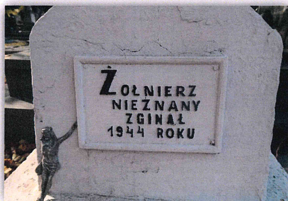
Fot. 6. Nagrobek „B”. Stan zachowania przed konserwacją. Na zdjęciu widoczna tabliczka, wykonana z blachy ocynkowanej. Została zamalowana tą samą farbą, co nagrobek. Październik 2021 rok.
