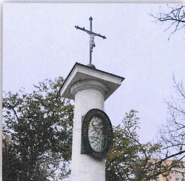
Fot. 15. Widoczne liczne spękania kolumny. Październik 2021 rok.
