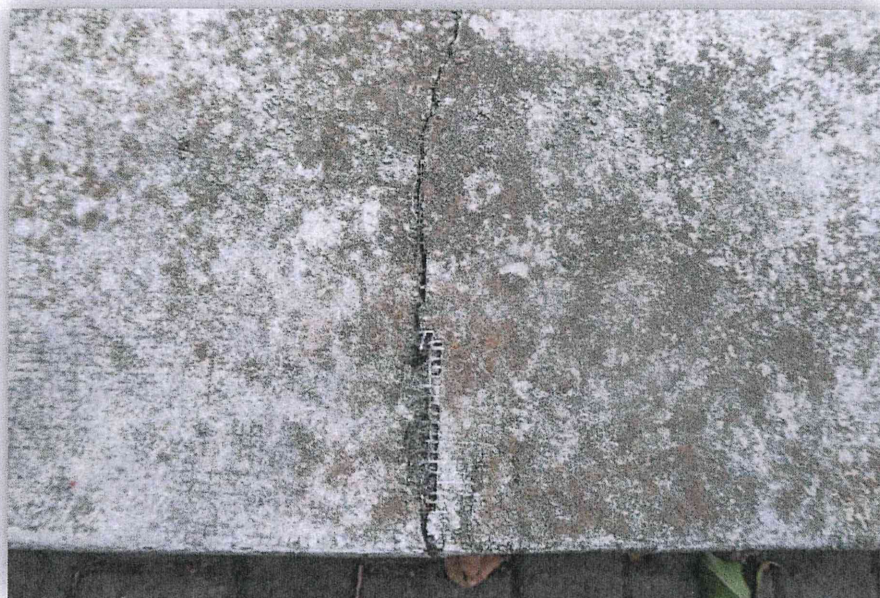
Fot. 22. Stan zachowania betonowej czapy murku zewnętrznego. Październik 2021 rok.
