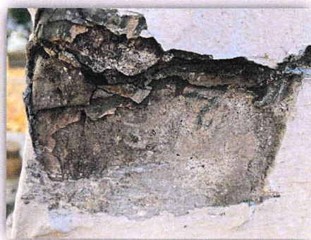
Fot. 8 Nagrobek „B”. Na zdjęciu widoczna odkrywka ukazująca wcześniejsze naprawy zaprawą na bazie cementu wraz z licznymi przemalowaniami powierzchni farbą. Październik 2021 rok.
