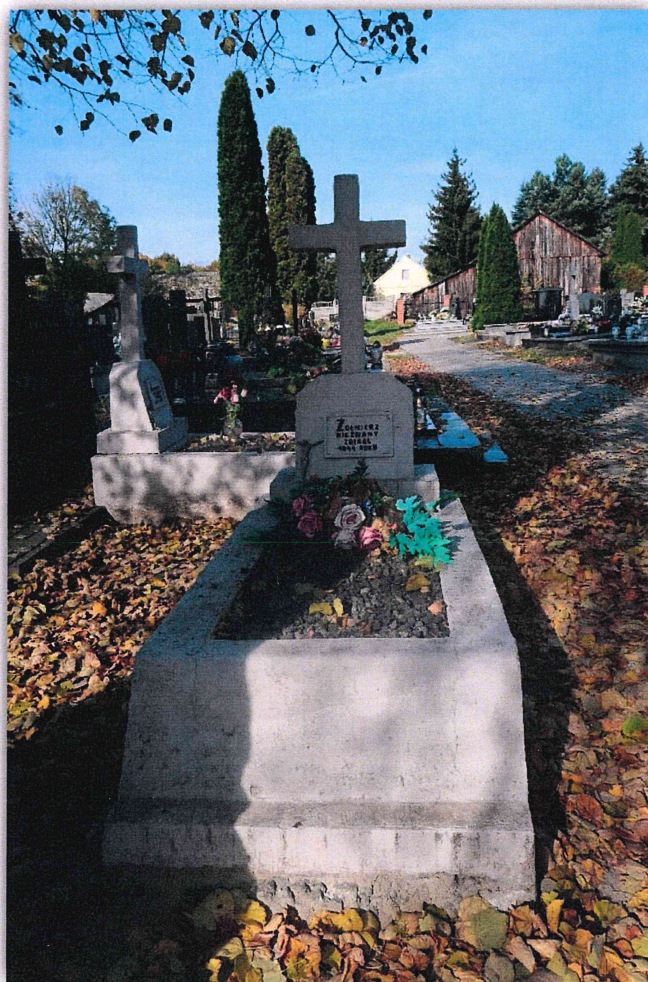
Fot. 1. Nagrobek „A”. Stan zachowania przed konserwacją. Widoczny odsłonięty fundament. Październik 2021 rok.
