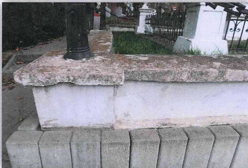
Fot. 24. Stan zachowania murku zewnętrznego. Widoczne wadliwe naprawy wykonane w 2006 roku. Październik 2021 rok.
