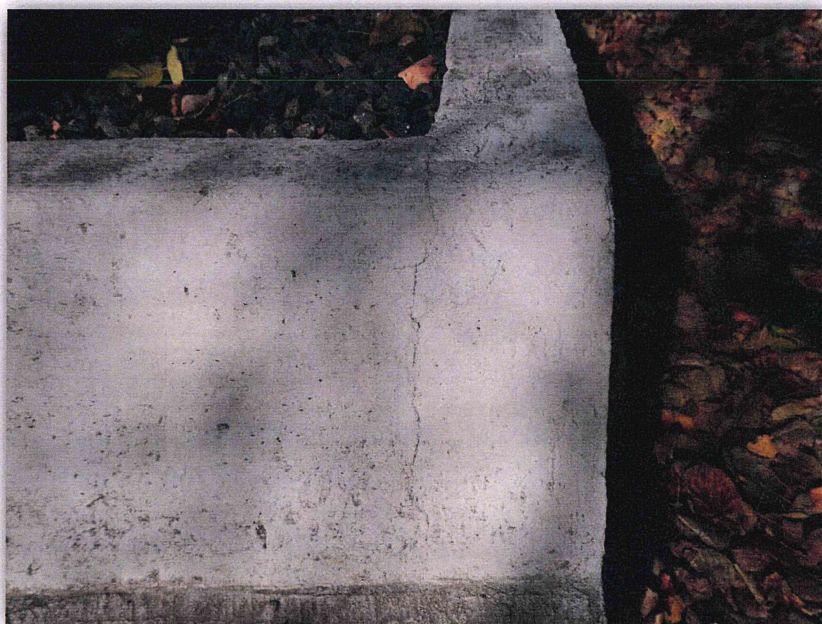
Fot. 3. Nagrobek „A”. Zbliżenie boku nagrobka z wyraźnym pęknięciem elementów łączenia bloków. Październik 2021 rok.
