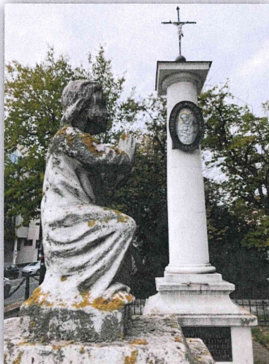
Fot. 12. Widoczny silny rozwój glonów, mchów i porostów na pełnoplastycznej figurze anioła. Październik 2021 rok.
