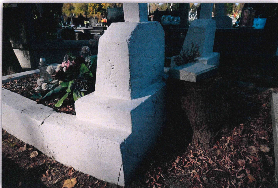
Fot. 18. Nagrobek „E”. Stan zachowania przed konserwacją. Na zdjęciu widoczne pęknięcie boku nagrobka wraz z przemieszczeniem. Liczne ubytki. Październik 2021 rok.
