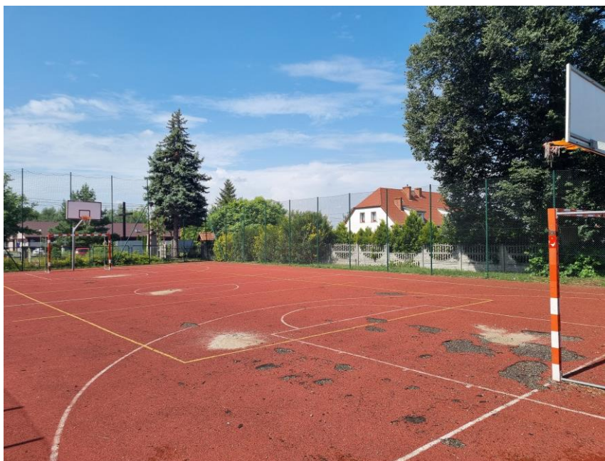
Zdj.1. Istniejące boisko szkolne o nawierzchni poliuretanowej przeznaczone do remontu.
