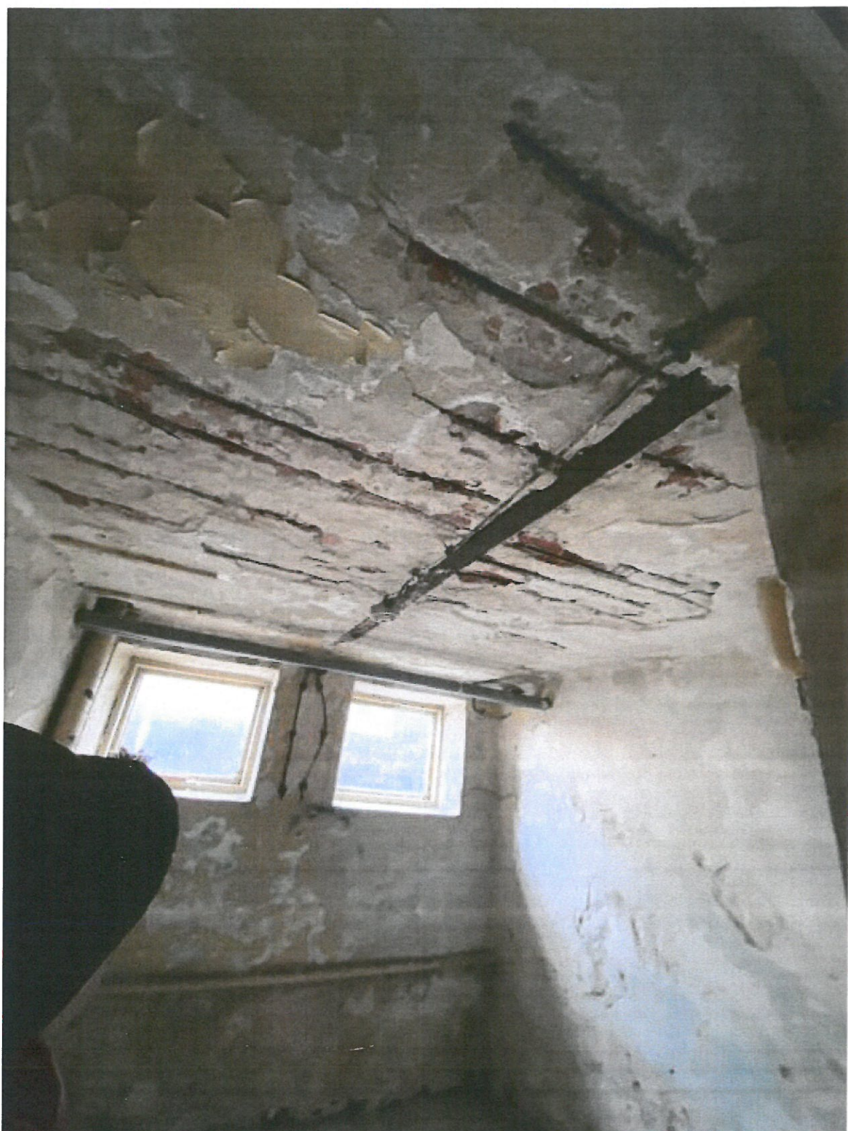
Zdjęcie 1: Strop w piwnicy, niezabezpieczone pręty zbrojeniowe i belki stalowe, tynk odspojony.
