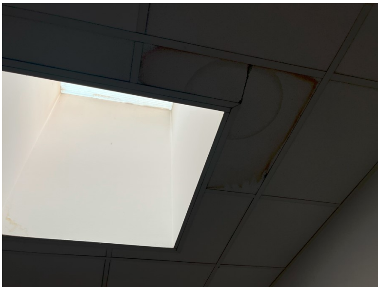
Fot. 2: Uszkodzenia sufitów spowodowane nieszczelnościami dachu
