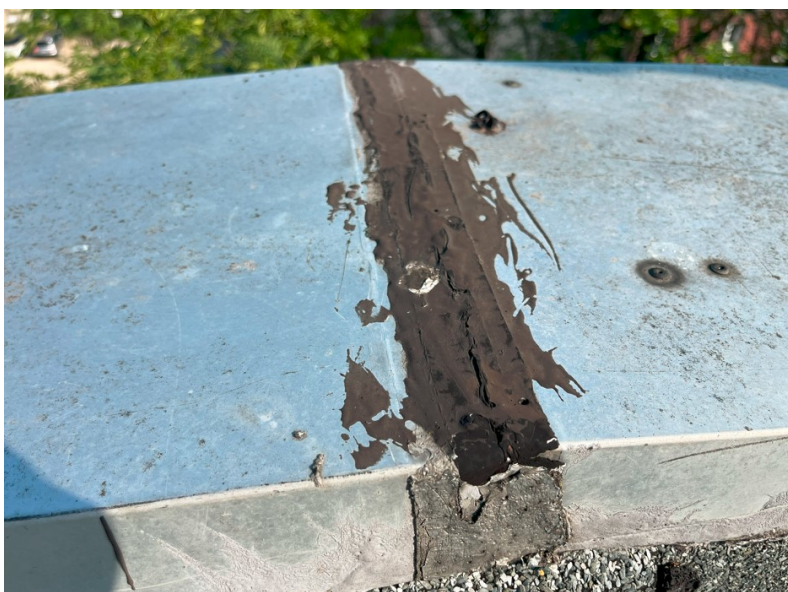
Fot. 8: Kolejny przykład nieprawidłowych połączeń obróbek blacharskich z widocznymi pęknięciami, przez które migruje woda do wewnątrz budynku.
