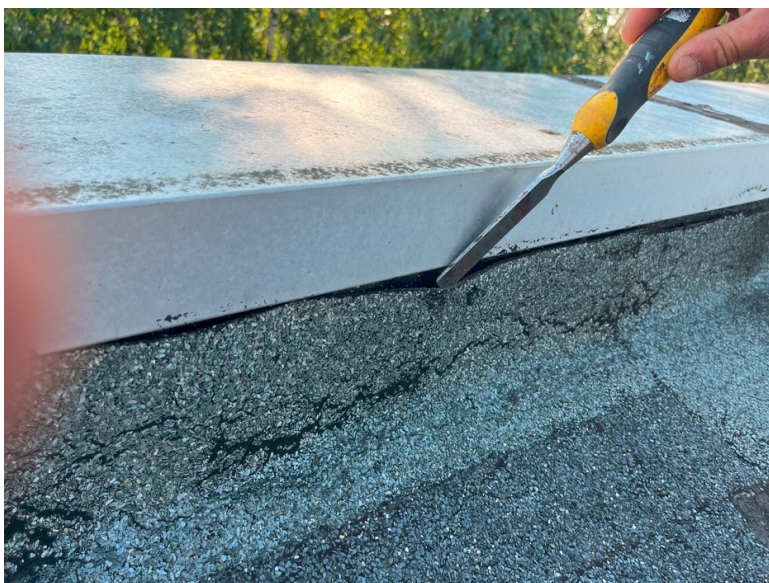
Fot. 12: Brak wywinięcia ostatniej warstwy papy pod obróbkę blacharską.
