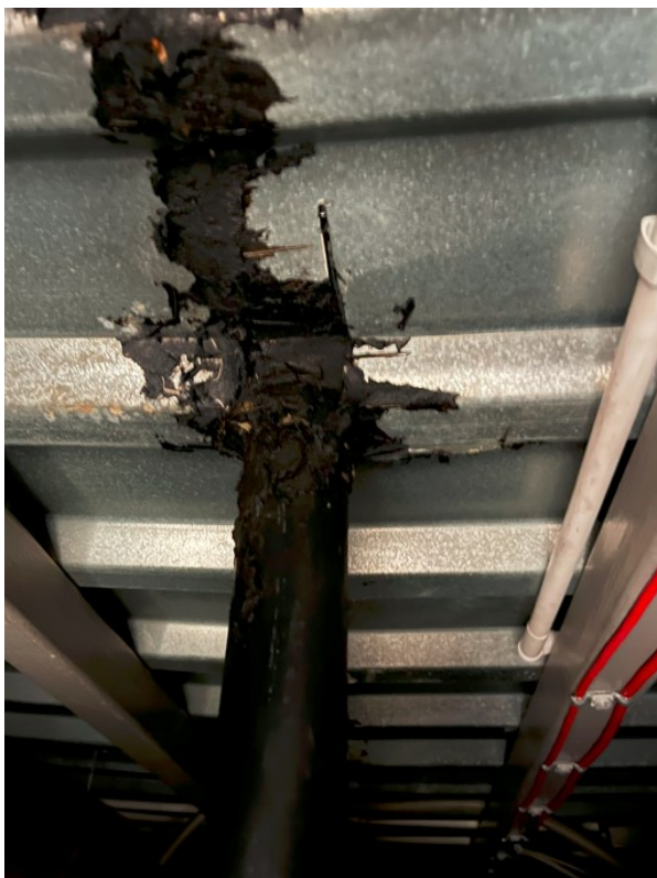
Fot. 28: Prowizoryczne uszczelnienie.
