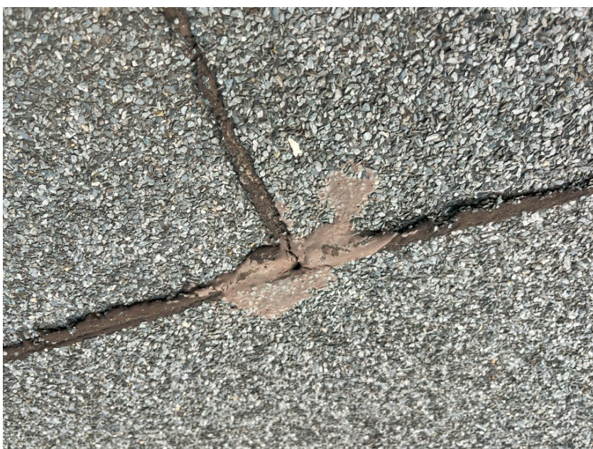
Fot. 24: Widoczne miejsca punktowych napraw na łączeniach arkuszy papy. Dokładniejszy widok połączeń papy wykazuje nieszczelności. Widoczny jest też ślad po przesunięciu się wzajemnym arkuszy papy o szerokości około 1 cm, świadczący o przesunięciu arkusza papy spowodowanego termicznym skurczem materiału.
