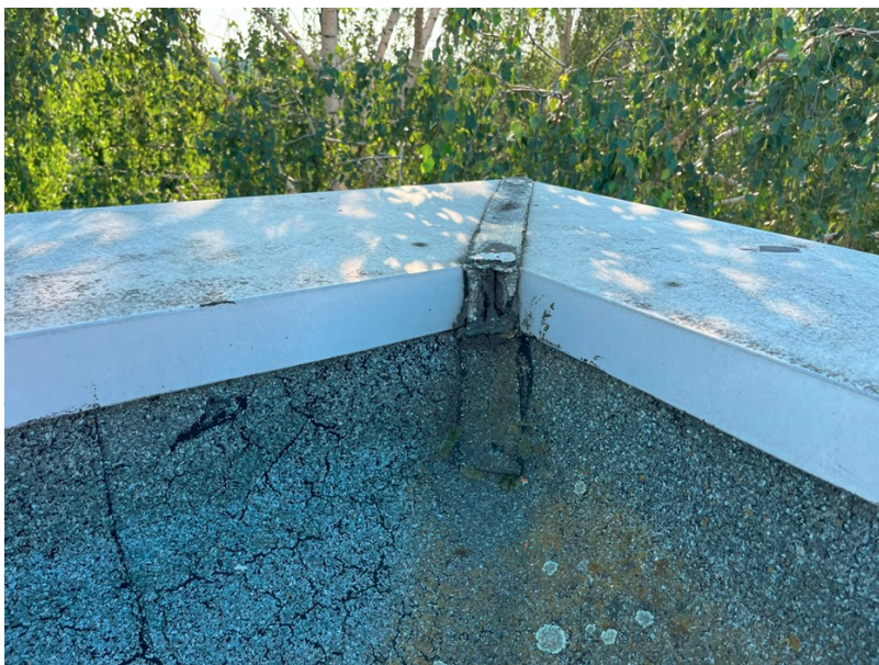
Fot. 13: Kolejne nieszczelności na połączeniu obróbek blacharskich oraz widoczne spękania siatkowe ostatniej warstwy papy.
