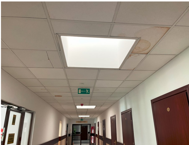
Fot. 1: Uszkodzenia sufitów spowodowane nieszczelnościami dachu
