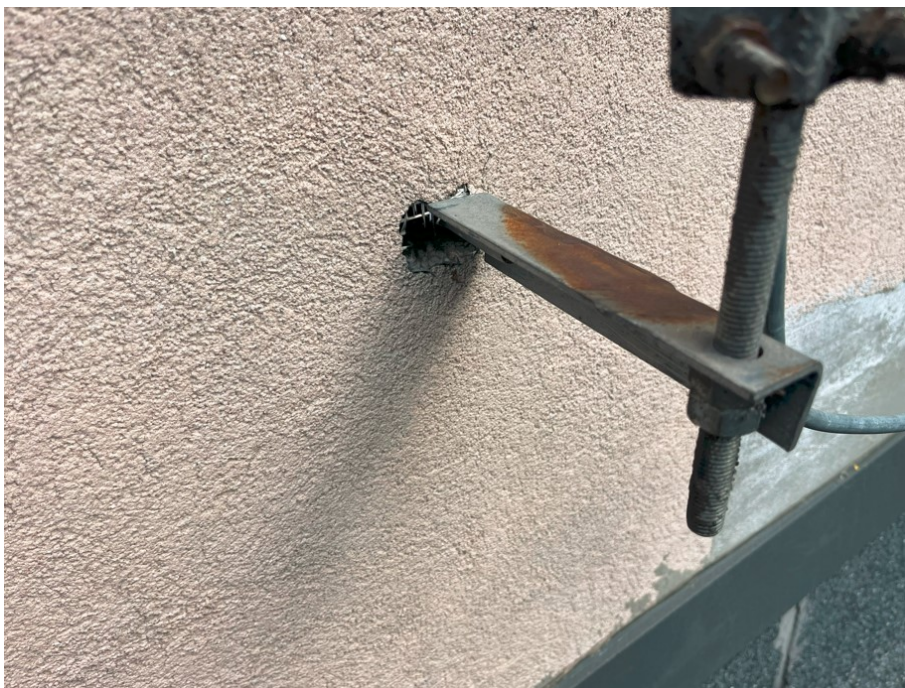
Fot. 23: Widoczny brak uszczelnienia na dolnym wsporniku instalacji odgromowej.
