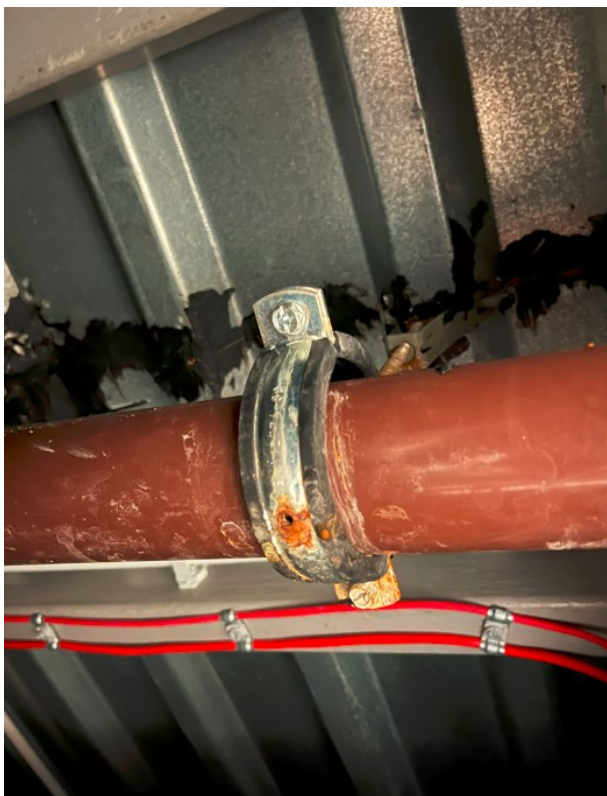
Fot. 26: Widoczne pod dachem prowizoryczne uszczelnienie nakładających się na siebie arkuszy blachy oraz rynna, która jako element prowizoryczny miała odprowadzać wodę przeciekającą z dachu.
