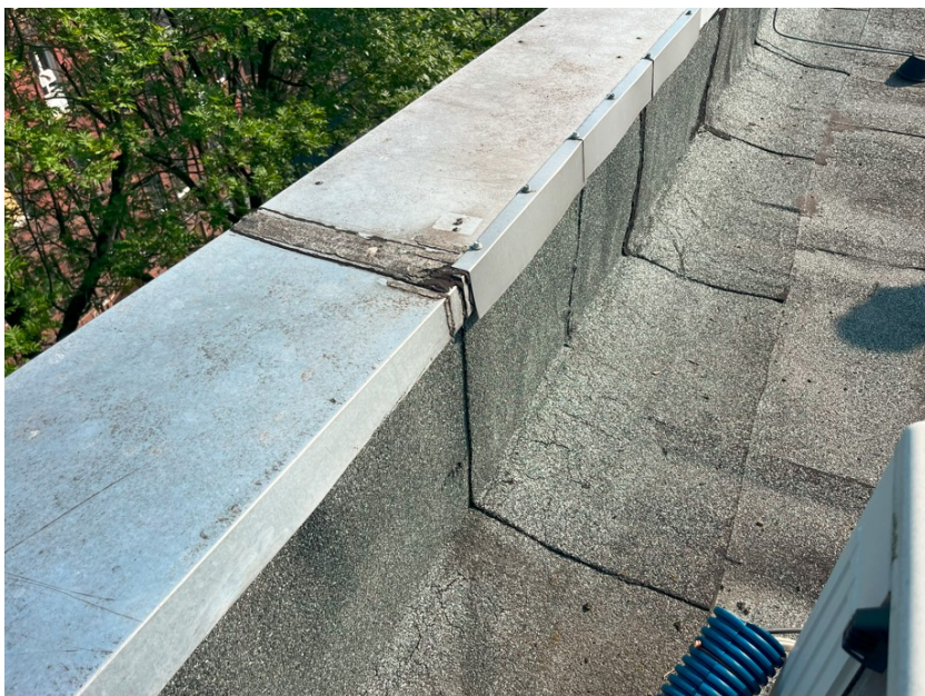
Fot. 7: Obróbki blacharskie mają połączenia płaskie, doszczelnione prowizorycznie. Widoczne są rozszczelnienia izolacji. Prawidłowo wykonane obróbki powinny mieć połączenia na rąbek i zapewniać szczelność bez dodatkowej izolacji.
