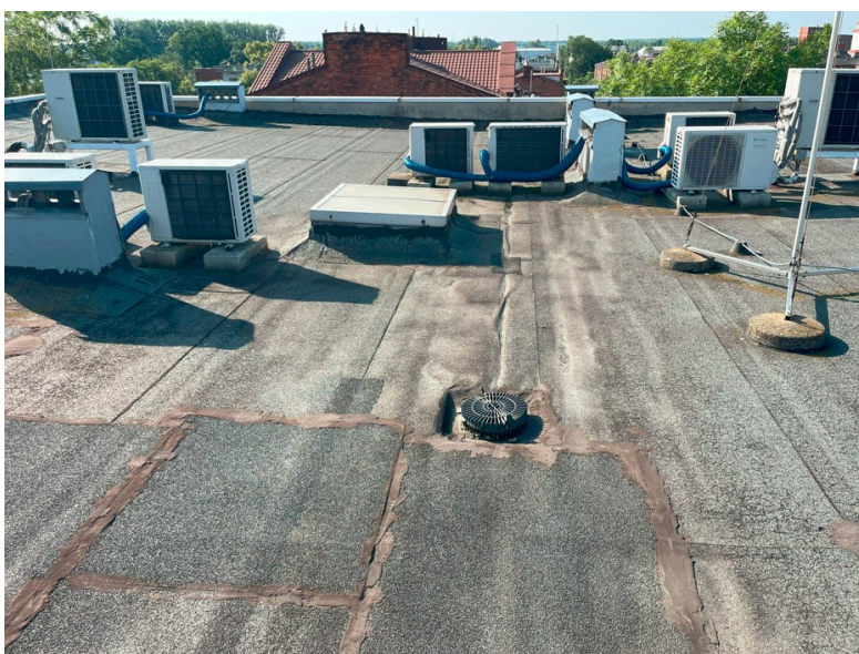
Fot. 4: Widoczne miejsca napraw oraz fałdowanie papy w najniższym punkcie poszycia, spowodowane najprawdopodobniej ruchami termicznymi dachu
