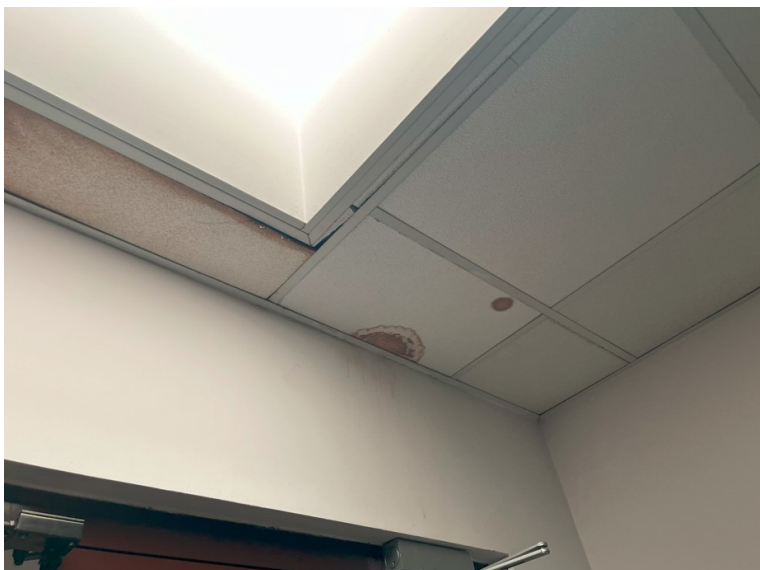
Fot. 3: Uszkodzenia sufitów spowodowane nieszczelnościami dachu
