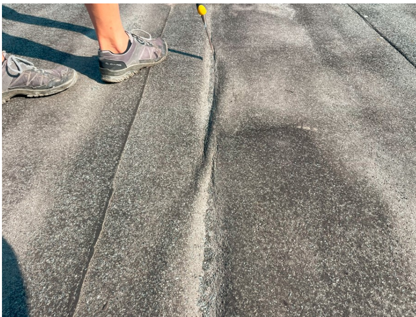
Fot. 15: Widoczne pofałdowania papy w najniższym punkcie poszycia dachowego, spowodowane ruchami termicznymi dachu. Widoczne wyoblenia to woda, która została uwięziona pomiędzy górną i dolną warstwą papy.
