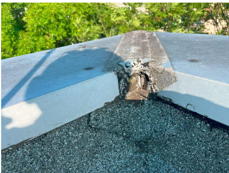
Fot. 6: Nieszczelności obróbek blacharskich.
