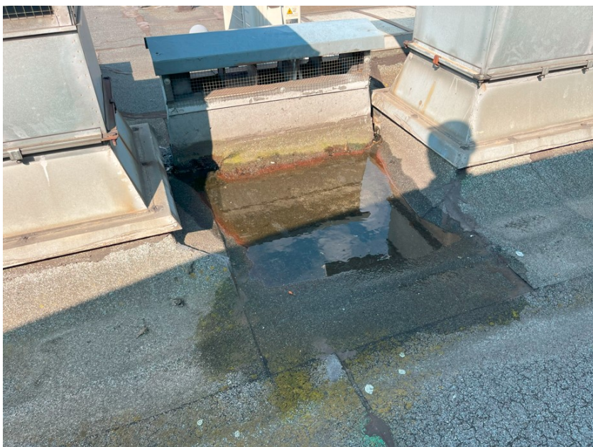
Fot. 21: Niewłaściwe ukształtowanie spadków przy kominkach wentylacyjnych, powodujące powstawanie zastoisk wody.
