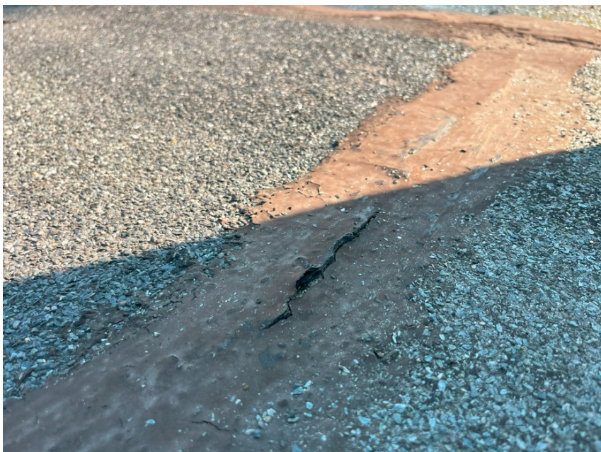
Fot. 11: Nieszczelności na łączeniach arkuszy papy, widoczne również w miejscach lokalnych napraw
