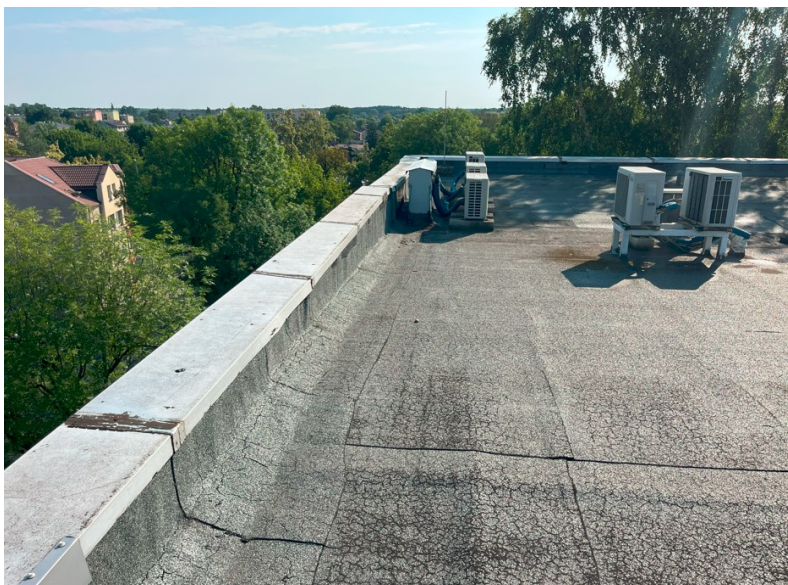
Fot. 9: Wyraźnie widoczne spękania siatkowe ostatniej warstwy papy, świadczące o jej niewłaściwej jakości.
