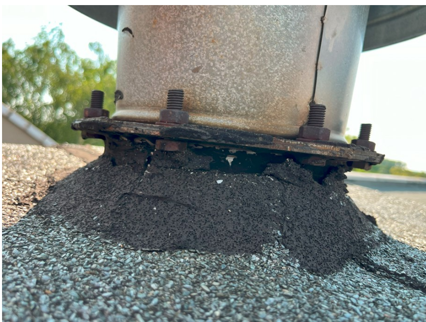
Fot. 20: Nieszczelności przy zamontowanych na dachu elementach wentylacji.
