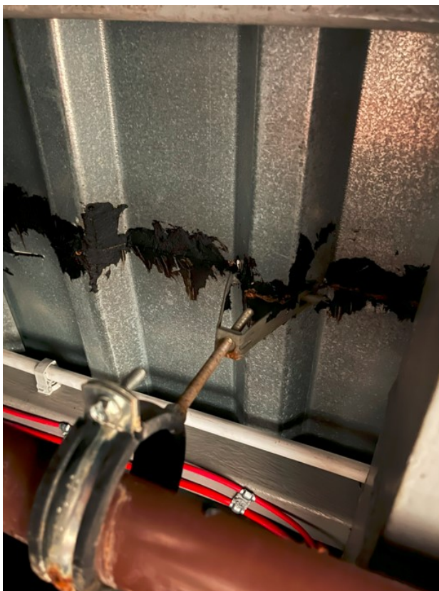
Fot. 27: Kolejny widok prowizorycznych uszczelnień nad sufitem podwieszanym.
