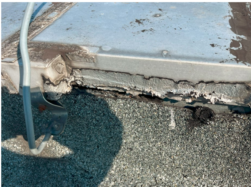
Fot. 5: Widoczne nieszczelności pomiędzy wierzchnią warstwą papy i obróbką blacharską.
