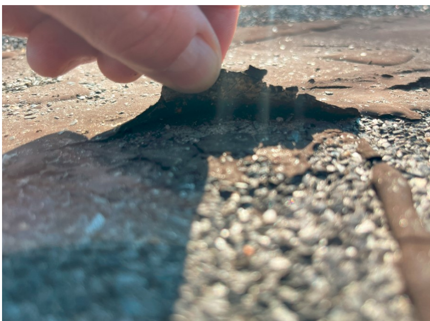
Fot. 10: Brak przylegania warstw bitumicznych, którymi dokonywano prowizorycznych napraw punktowych.
