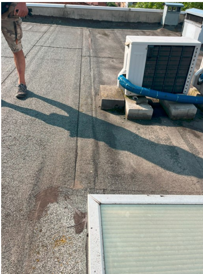
Fot. 19: Widoczne ślady napraw punktowych
