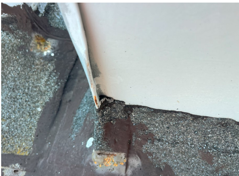
Fot. 14: Obudowy z blachy dla pionów wentylacyjnych wykonane są z blachy łączonej na rąbek, co utrudnia możliwość dogrzenia ostatniej warstwy papy i uzyskanie szczelności. W ramach remontu dachu proponuje się ich wymianę na nowe.
