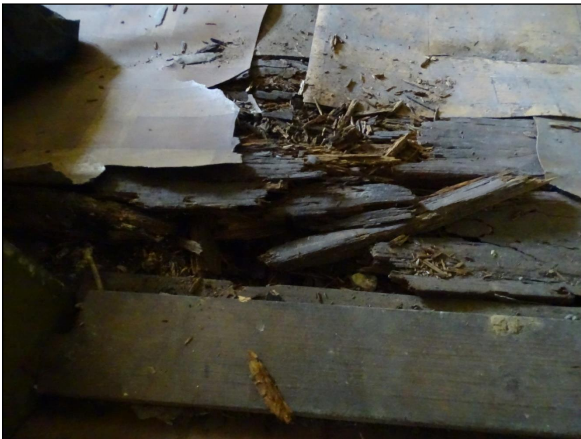
Fot.[6] Podłoga w pomieszczeniu kuchni. Widoczny brunatny rozkład drewna. Fot. autor.
