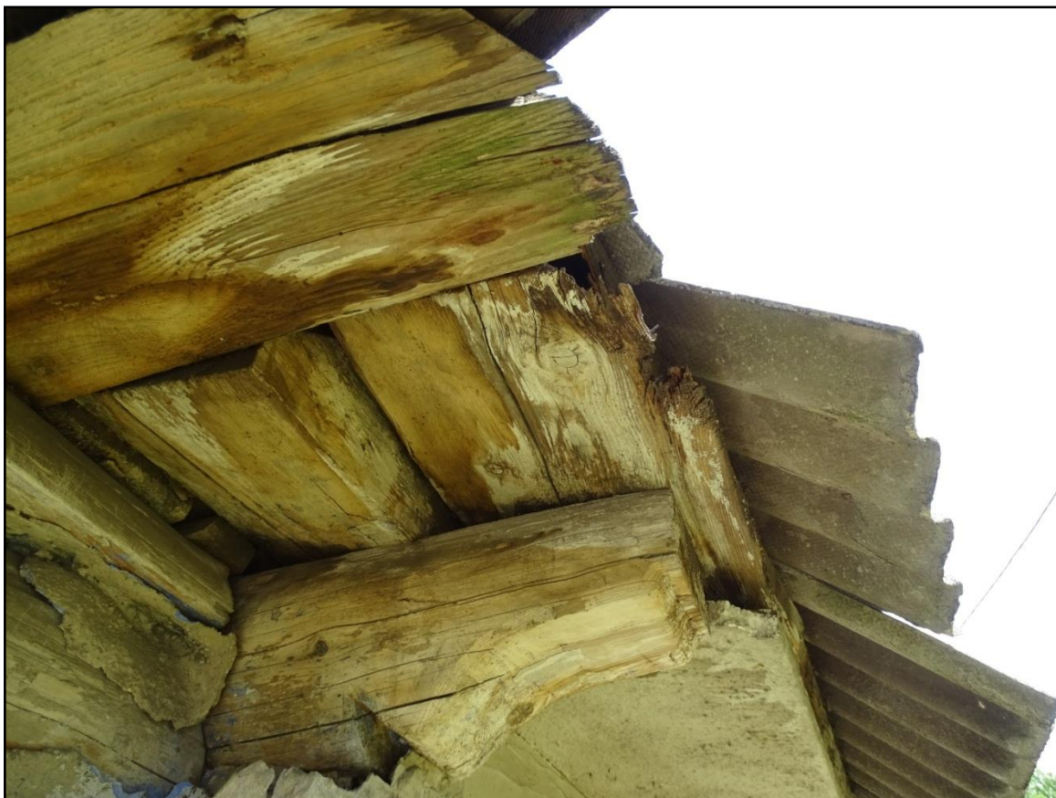
Fot.[8] Elewacja północna. Widoczny rozwój grzyba powłocznika gładkiego ( Corticium laeve ) Fot. autor.
