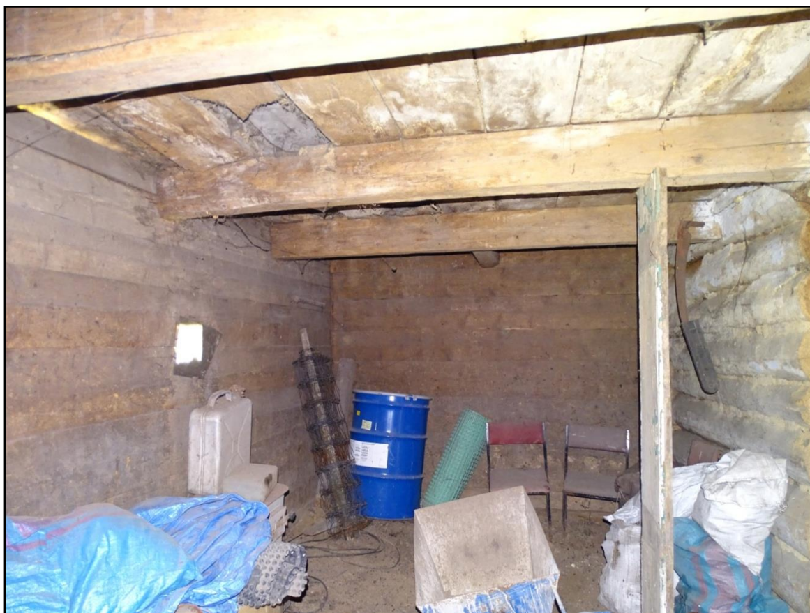
Fot.[5] Strop w pomieszczeniu gospodarczym. Widoczna zgnilizna brunatna wywołana obecnością grzyba domowego właściwego ( Serpula lacrymans ) . Fot. autor.
