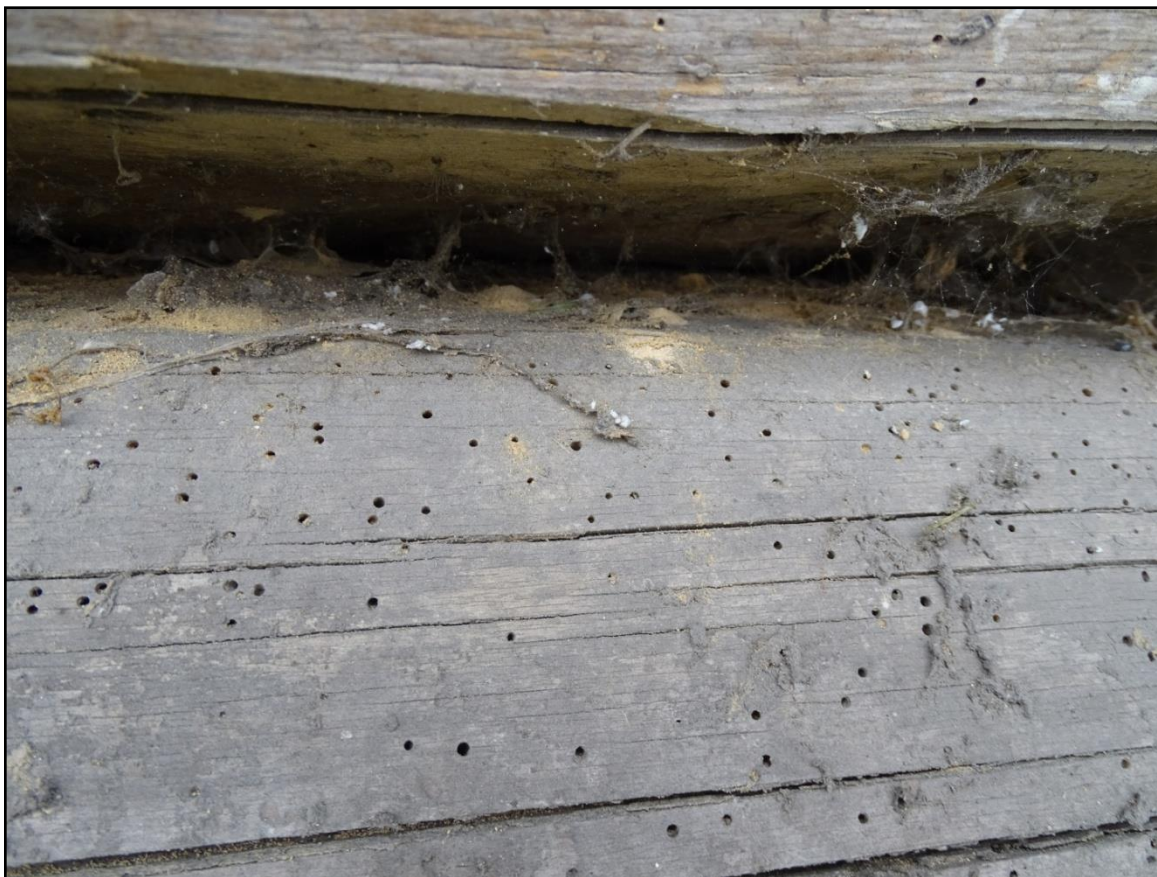
Fot.[9] Kołatek domowy ( Anobium punctatum .) - zaatakowane belki ściany północnej. Widoczny osyp mączki drzewnej świadczy o aktywnej obecności owadów. Fot. autor.
