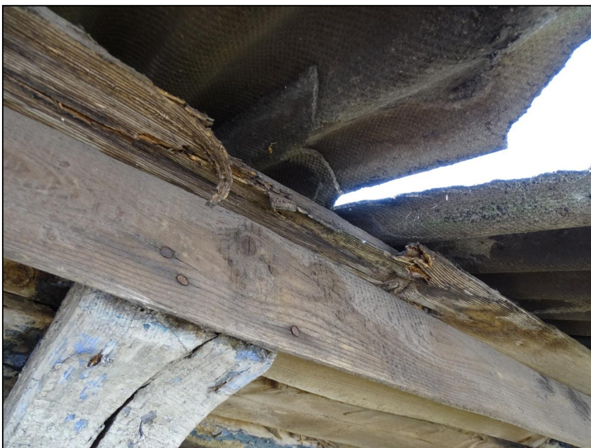
Fot.[7] Fragment okapu od strony północnej. Widoczny rozkład drewna przez grzyby wywołany zaciekami z pękniętej płyty pokrycia dachowego. Fot. autor.
