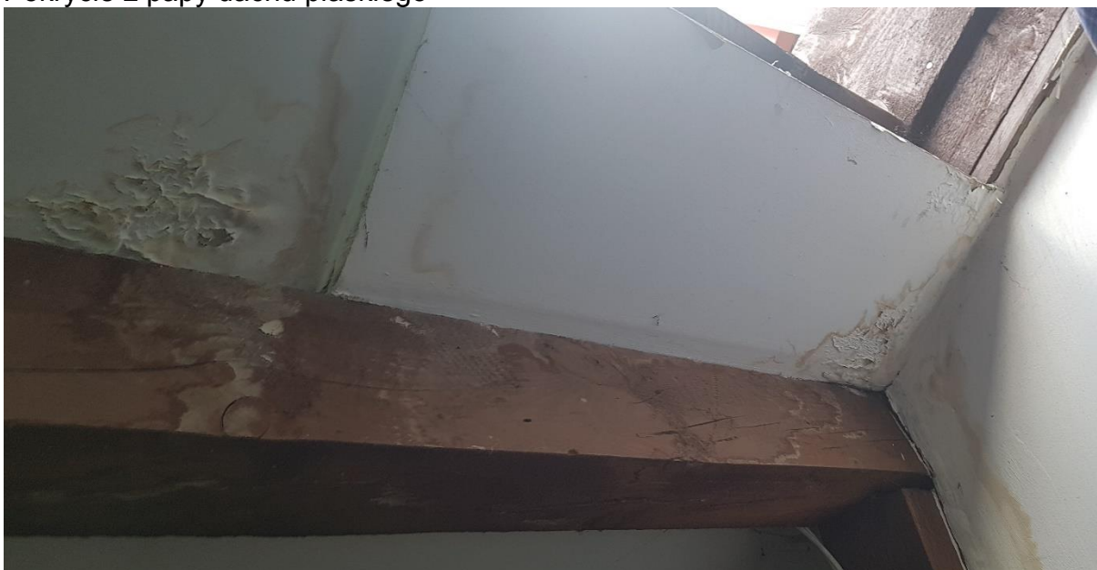
Przecieki widoczne na zabudowie dachu.
