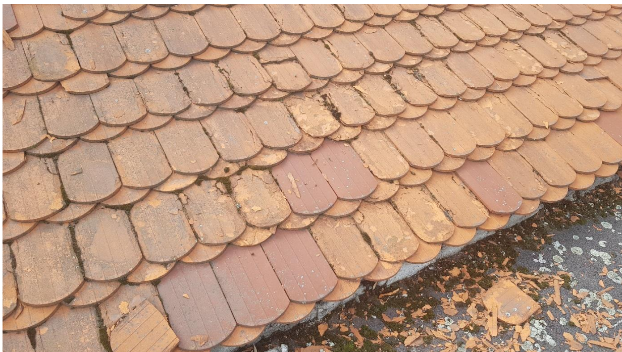
Zwietrzała dachówka połaci północnej, widoczne wymienione pojedyncze dachówki
